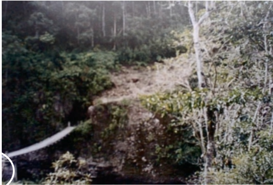
Puente colgante en la vía Santa Bárbara – La Victoria; se aprecia una base en concreto del lado del Ecuador para futura culminación.
