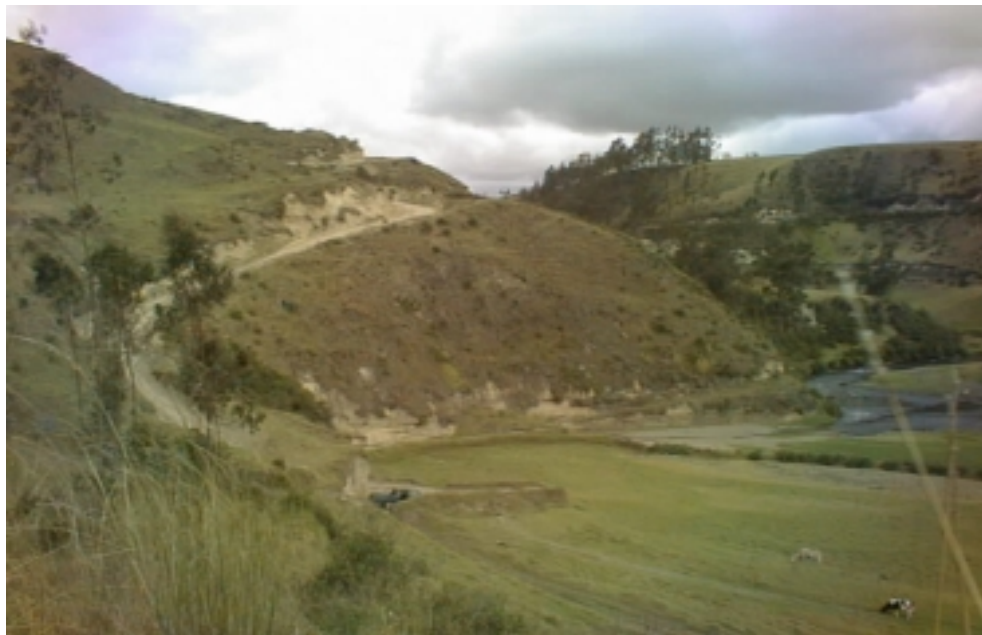
Vista lateral de la vía que conduce al sector de La Planta, en regulares condiciones, por ser muy empinada, pero de fácil acceso en vehículos de tráfico pesado.
