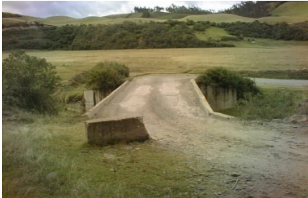
Puente en cemento que conduce al caserío Colombiano de El Carchi, utilizado únicamente por vehículos livianos.
