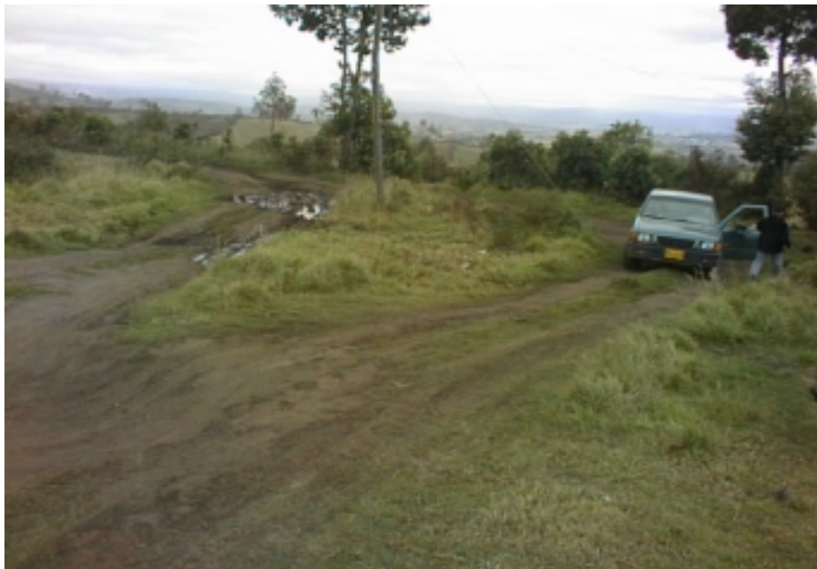
Vía Calle Larga – Santa Fe (Colombia), en regulares condiciones, sirve para el tránsito de vehículos de tráfico pesado, la vía en este tramo está paralela al límite fronterizo.
