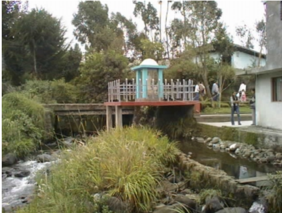
Vista lateral del puente, en donde se puede apreciar la capacidad para el tráfico de carga pesada.
