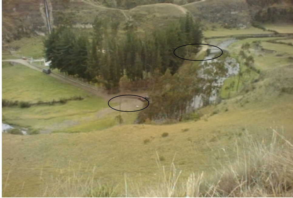
La Planta de El Carchi; se logra apreciar un camión atravesando el río, ya que el puente a la derecha no está diseñado para soportar tráfico pesado.
