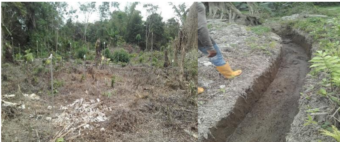
Figura N.4. Estaquillado y construcción de drenajes
