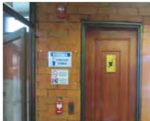
Cuarto de aseo
