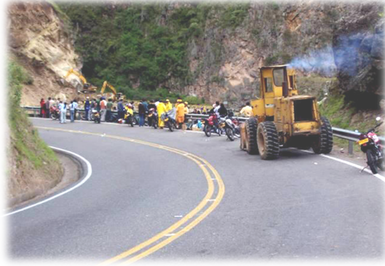
Foto 7. Vía primaria en pavimento. Pasto - Ipiiales
