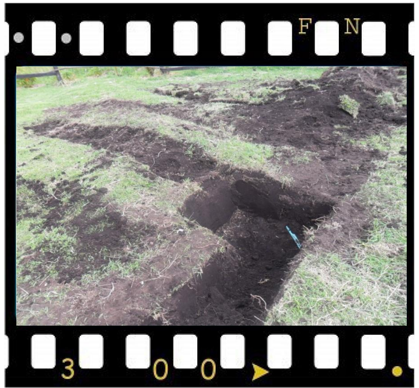
Excavación de cimientos
