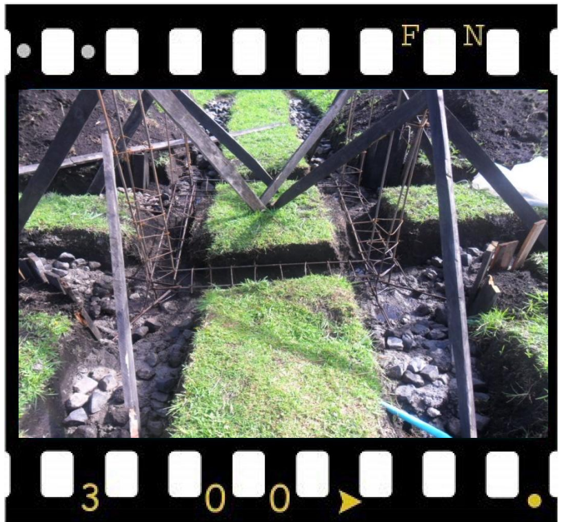
Estructura en concreto armado
