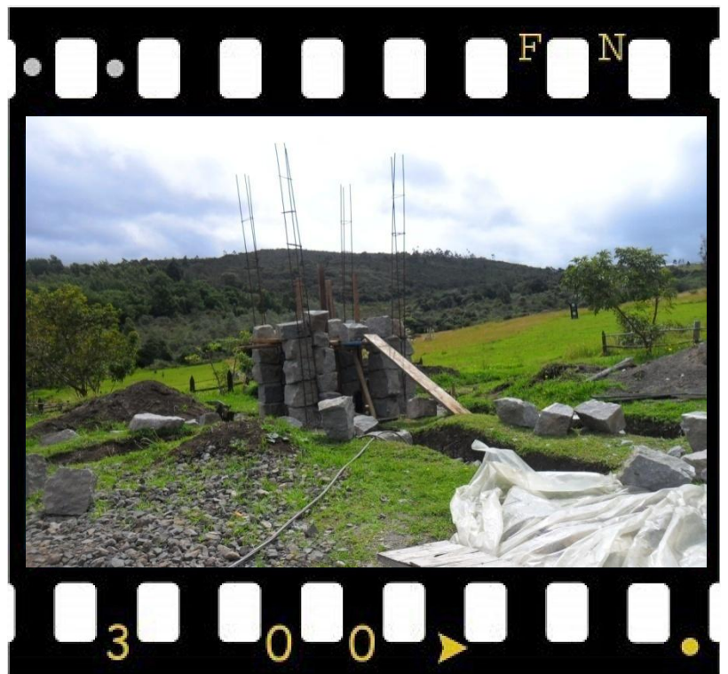
Construcción columnas en piedra
