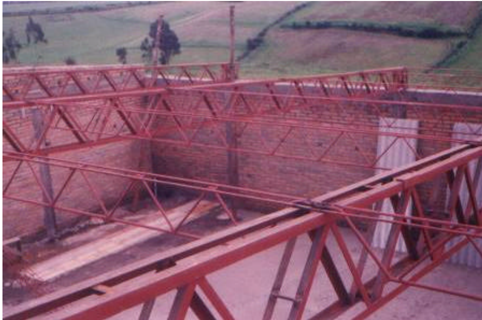
Figura 4. Procesos de construcción del Club Autopanamericano S.A.
