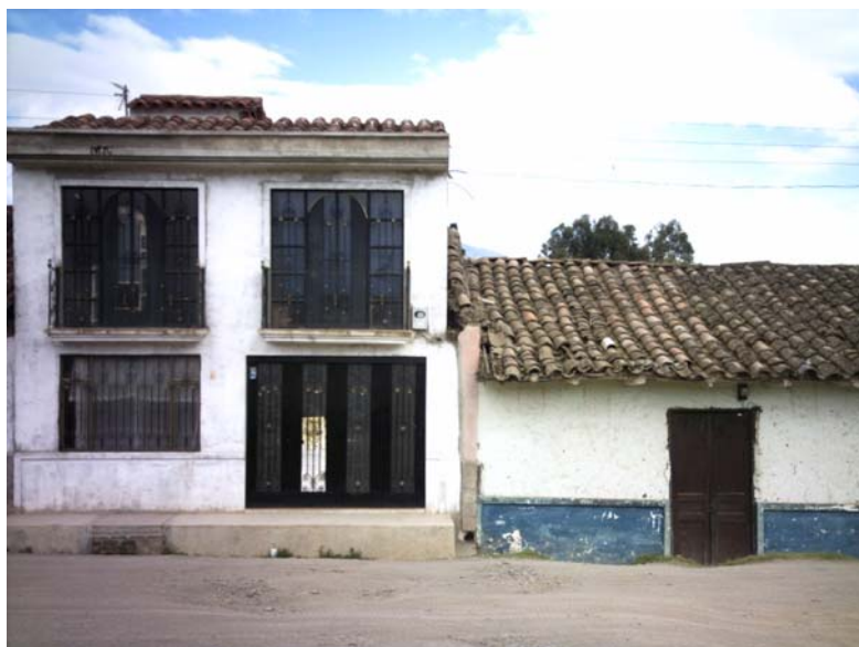
Figura 6: Vivienda, de la tapia al ladrillo.
