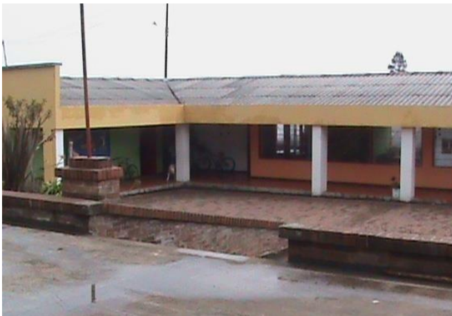
Figura. 2. Fotografía de la parte delantera de la escuela.
