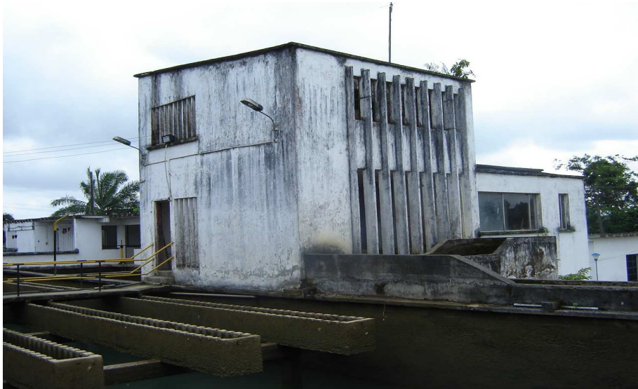
Foto 1. Infraestructura Planta de Tratamiento
