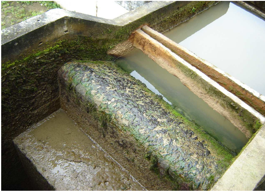
Foto 4. Estado de mantenimiento Sedimentadores
