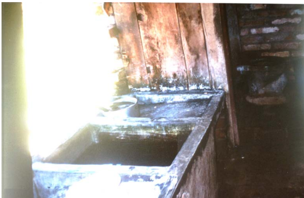
Foto 1 y 2. Cuarto de baño y pila de agua
