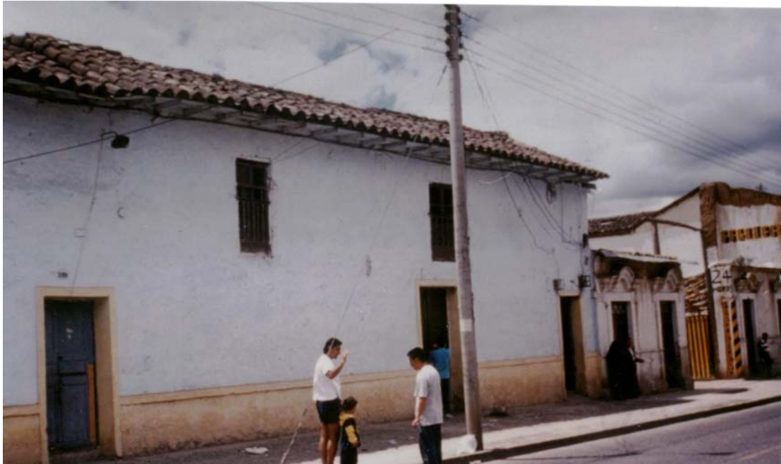
Foto 7 y 8. Panorámica exterior del inquilinato “el túnel”
