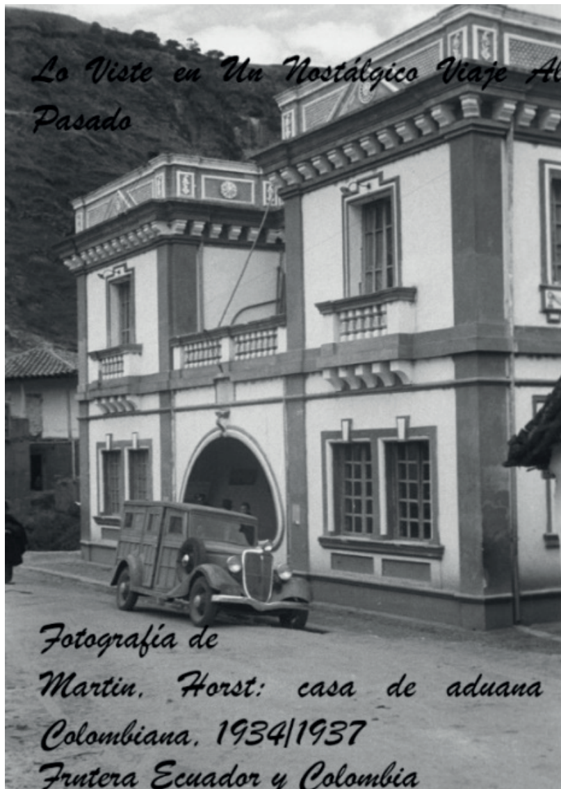
Fotografía 17. Casa de la aduana, puente de Rumichaca, frontera colombo-ecuatoriana. 1937. Foto: Martin Horst.
