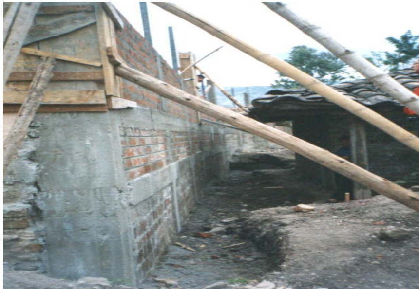
Figura 4. Fundición Muro de Cierre
