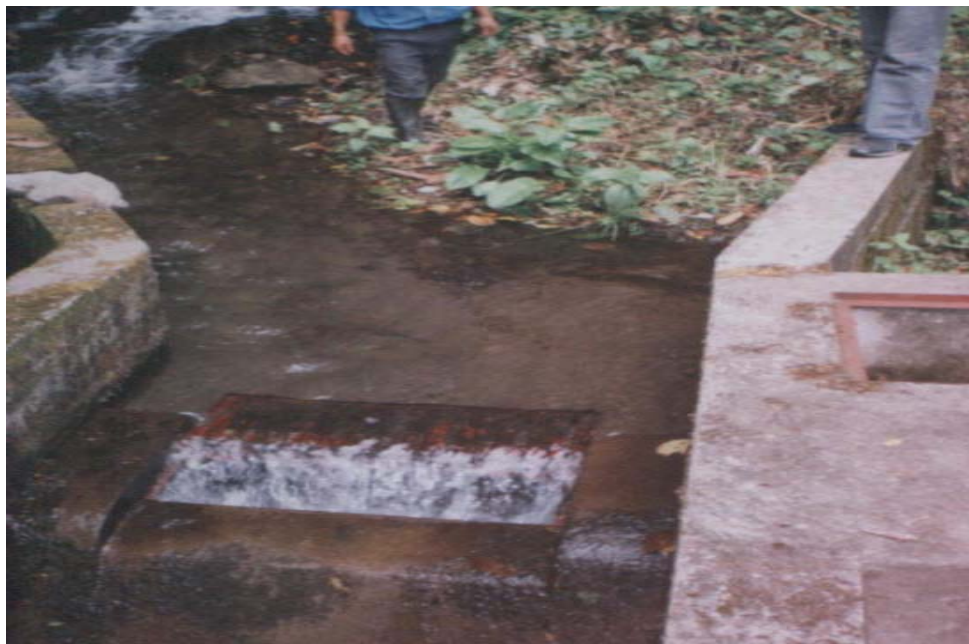
Figura 14 Visita Previa a Bocatoma
