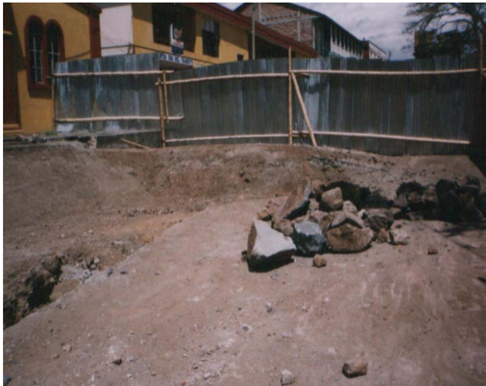
Figura 10 Excavaciones para Graderías y Tubería
