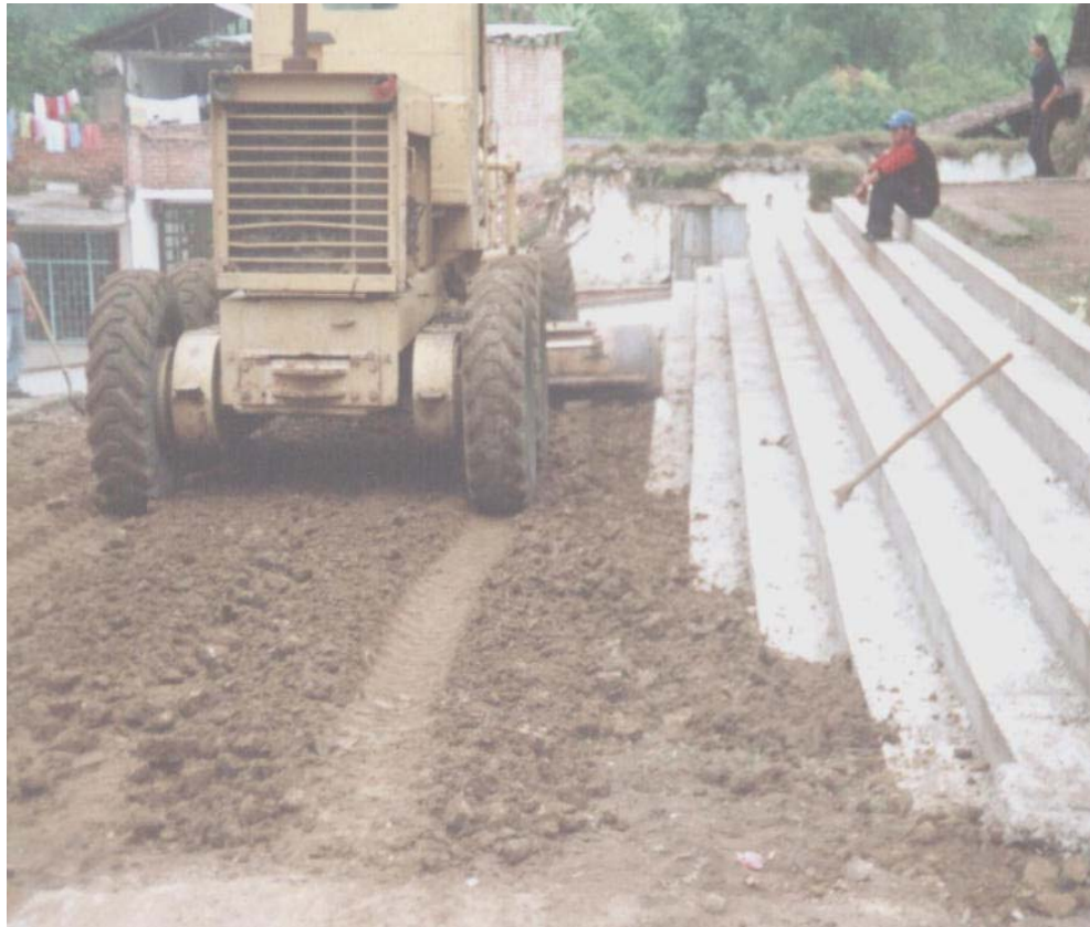
Figura 13 Relleno y Conformación de la Vía
