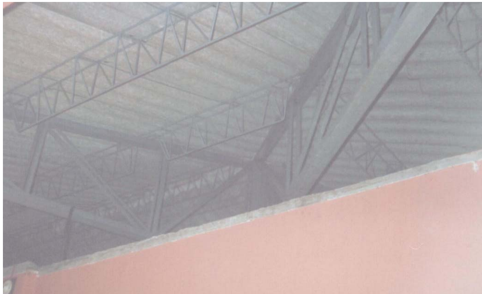
Figura 25. Instalación de Cubierta – Escuela Cariaco Bajo
