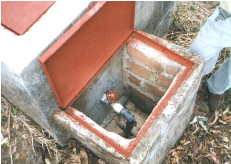
Figura 18. Instalación de Accesorios y Caja de Válvulas
