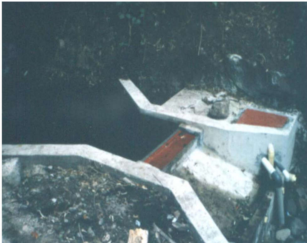
Figura 16. Bocatoma Terminada Cabecera Municipal
