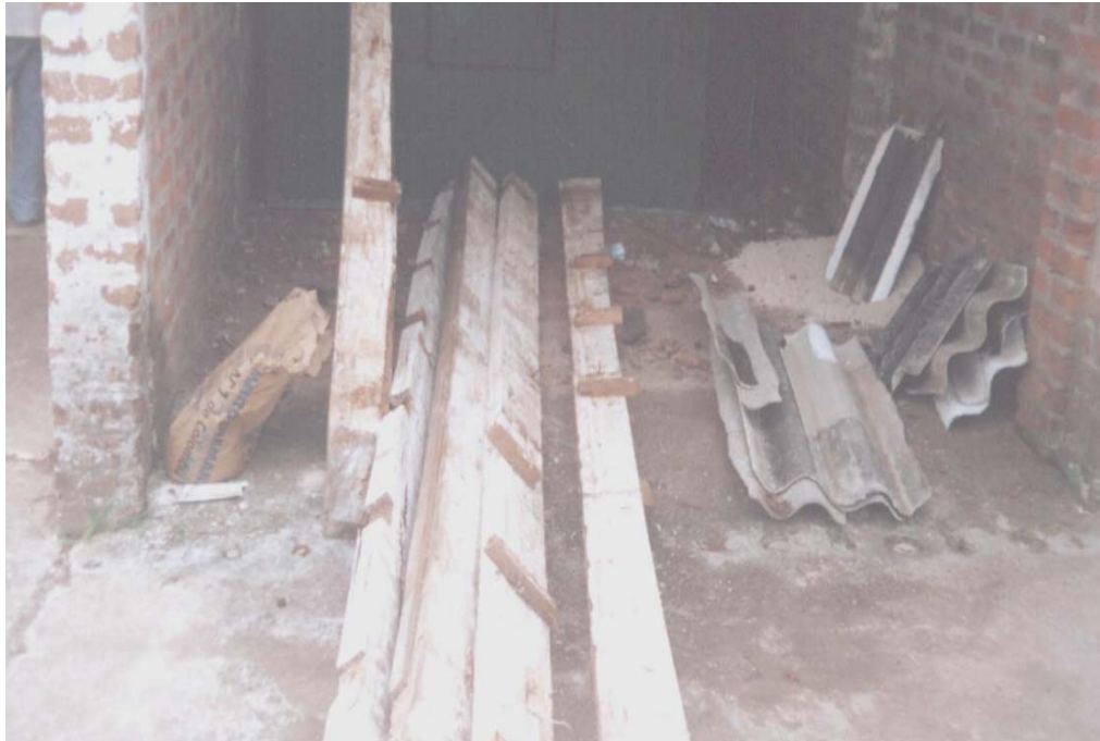
Figura 26. Desmante de Armadura de Techo en Madera
