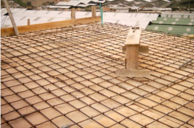
Figura 19. Vista lateral armado losa superior CAI Potrerillo
