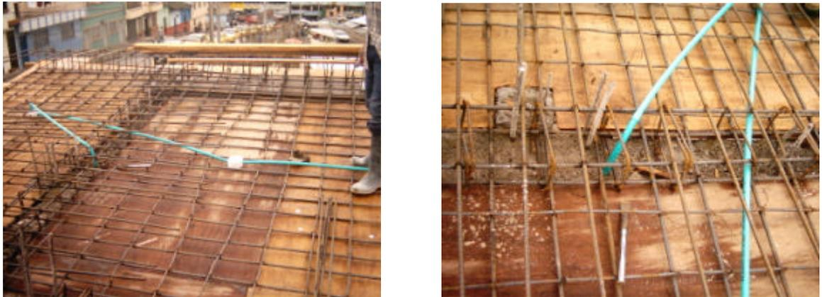
Figura 17. Fundición de losa de cubierta CAI Potrerillo
