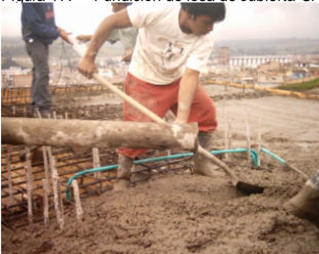
**6.5.1.3 Fundición losa superior.** Días después de la fundición de la losa de cubierta, se procedió a armar la formaleta de la losa superior, en promedio se dejó entre las dos, una separación de 0,10 m. Se armó el hierro de refuerzo de acuerdo al diseño estructural (Ver Figuras 18 y 19), y se procedió a fundir. El
