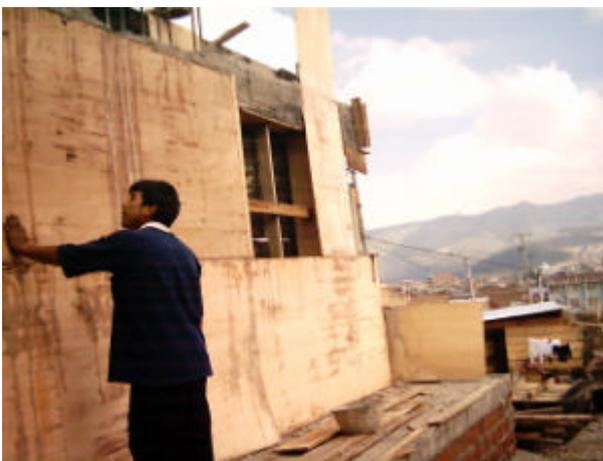
**6.5.1.2 Fundición losa de cubierta.** Posteriormente se colocó la formaleta para la fundición de la losa superior y se armó el refuerzo de acuerdo a los respectivos análisis estructurales. Se pasó la regata de las instalaciones eléctricas (Ver Figura 16). y se realizó la fundición de la losa con Concreto de 3000 psi. Para esta labor también se utilizó concreto premezclado. (Ver Figura 17).
