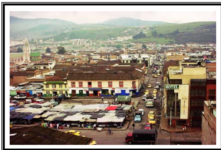
Figura 7. Deterioro de Sector Representativo de la Ciudad .Antiguo 20 de Julio.
