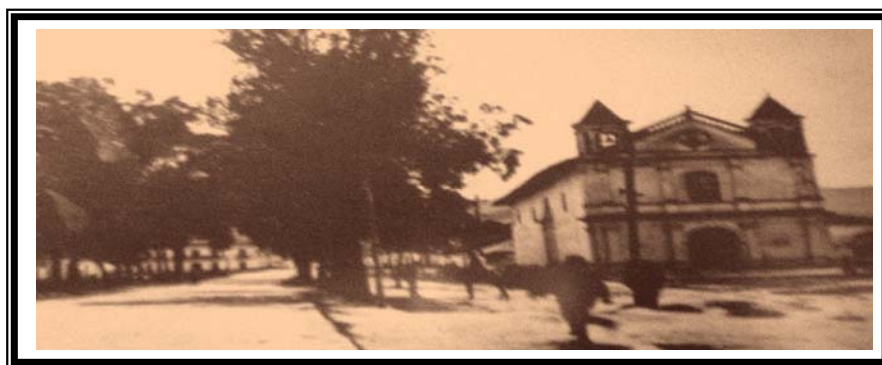
Figura 32. Capilla El Portalito hoy estación de Bomberos.
