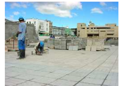
85. Obras Plaza del Carnaval. Fuente: Archivo Diario del Sur.
