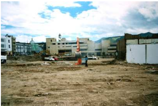
50. Demolición Sector Veinte de Julio.
