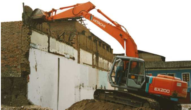
49. Demolición Sector Veinte de Julio.
