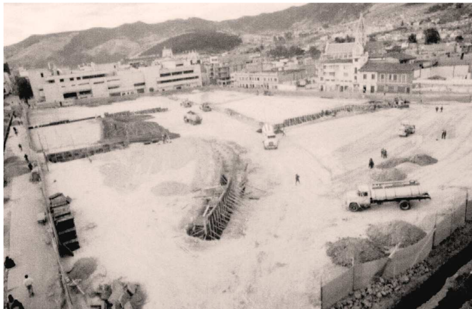
43. Plaza del Carnaval en Construcción.
