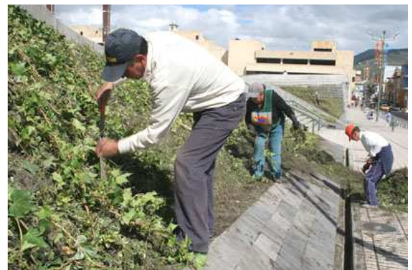
54. Obras Plaza del Carnaval. Fuente: Archivo Diario del Sur.
