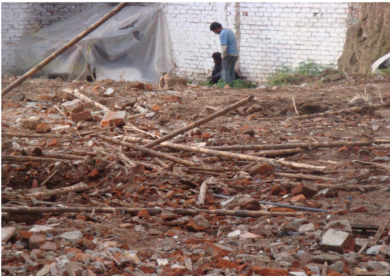
Fotografía 13. Cambuche. Demolición junto al Parque de los Periodistas. Pasto. Fuente: Esta investigación. . (c. 2013).
