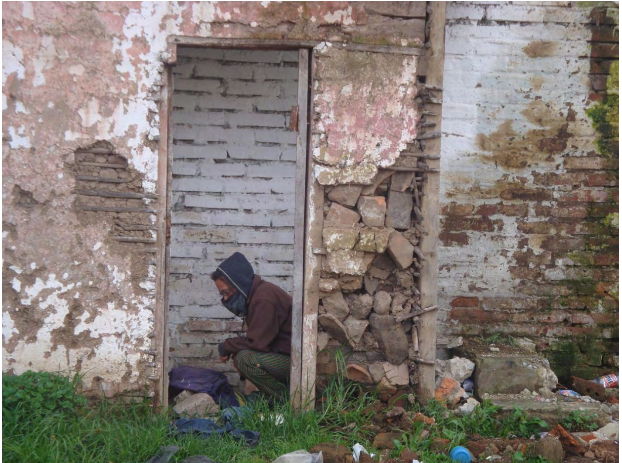
Fotografía 2. Demolición. Barrio San Jose Plan de Movilidad Vial. Pasto. Fuente: Esta investigación. (c. 2013).
