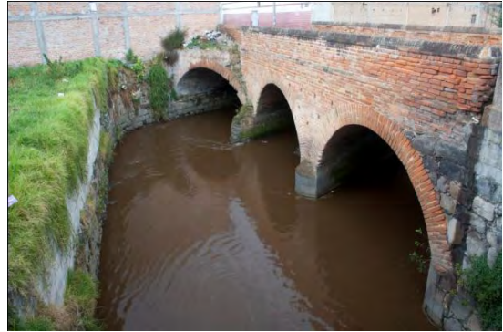
Fotografía 21. Puente viejo. Puente de la carrera 26 B. Río Blanco.
