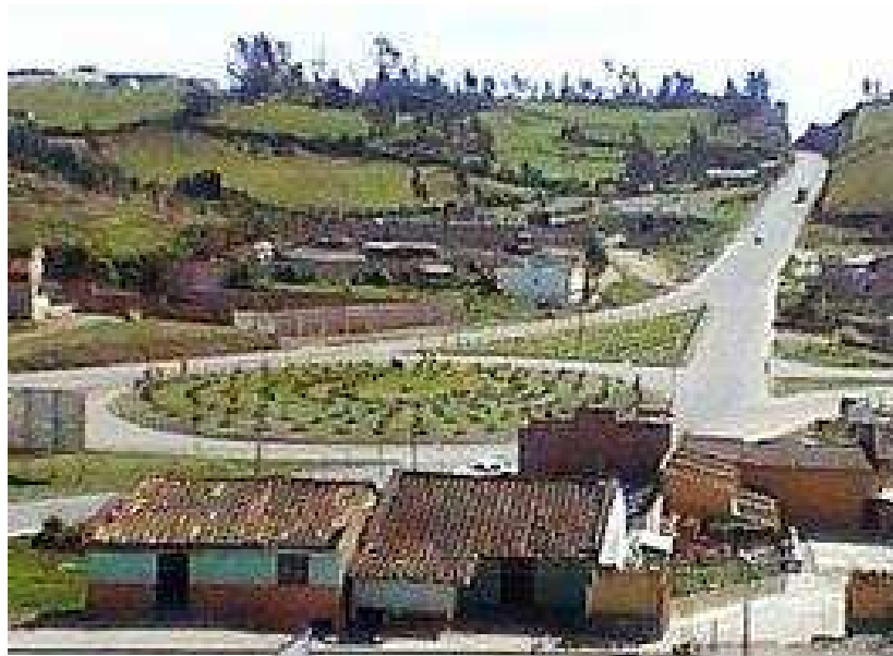
Foto 53. Glorieta Vía Perimetral Panamericana.
