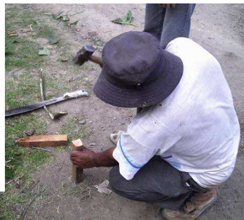
Foto 7 y 8. Localización y replanteo de ejes peatonales y vehiculares.
