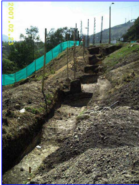
Foto 36 y 37. Excavaciones para muros de contención y comprobaciones de niveles de los mismos.
