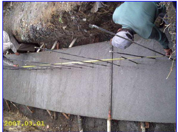
Foto 41 y 42. Fundición y comprobaciones de "zarpa".
