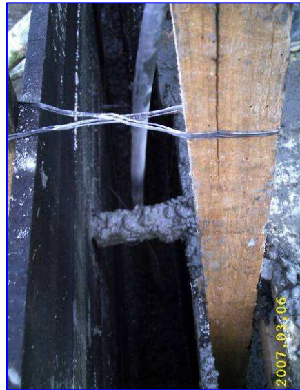
Foto 45 y 46. Fundición y vibrado del voladizo de muro de contención.
