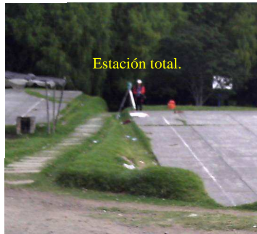
Foto 5 y 6. Labores de Replanteo y localización.
