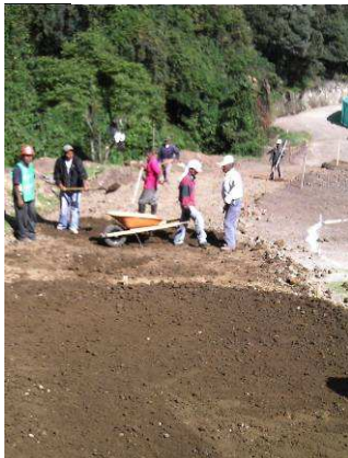
Foto 26, 27 y 28. Colocación y compactación de base en recebo compactado.
