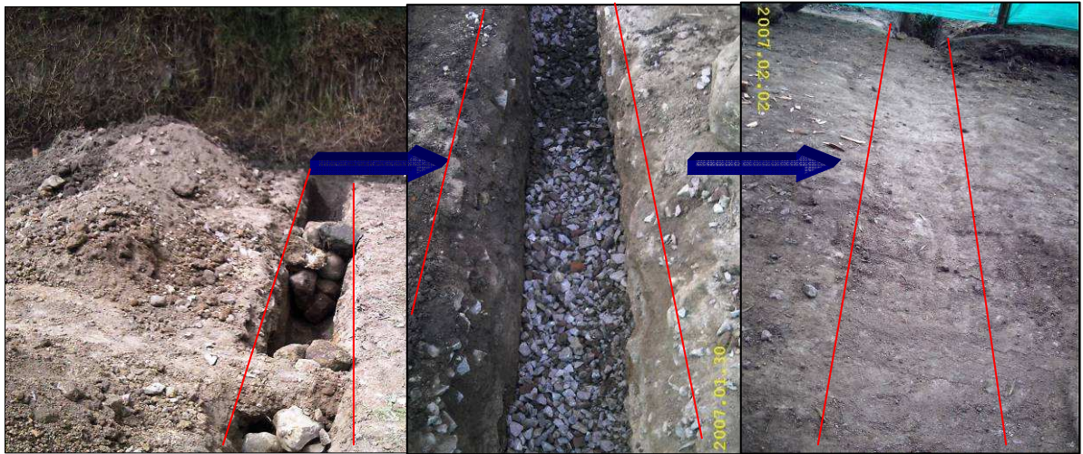
Foto 12, 13 y 14. Secuencia de construcción de drenaje.
