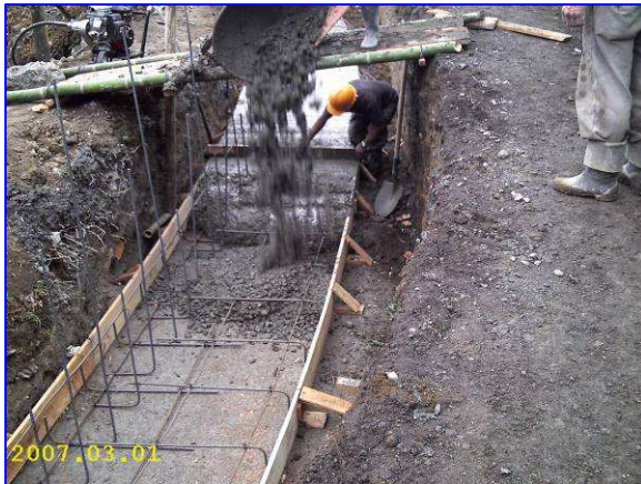
Foto 41 y 42. Fundición y comprobaciones de "zarpa".
