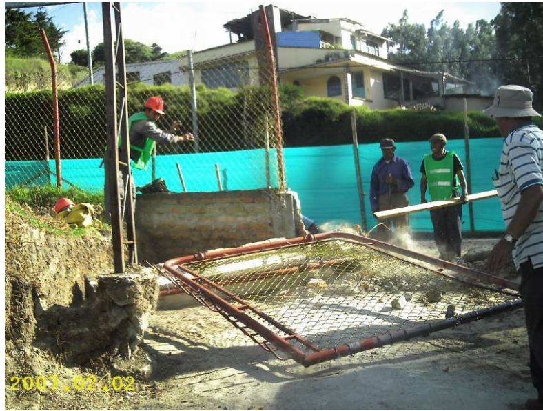
Foto 21. Demolición y desmonte de entrada vehicular (zona sur del parque).
