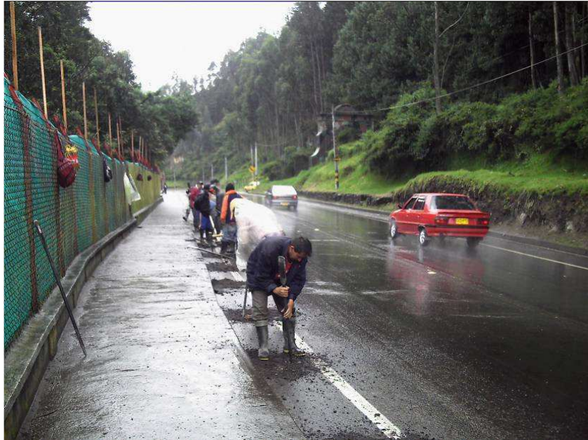
Foto 16. Labores de cerramiento provisional.
