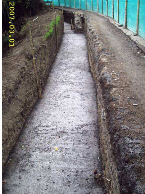
Foto 38. Base en concreto pobre para muro de contención.
