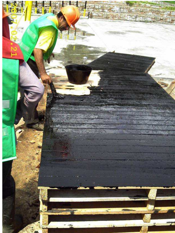
Foto 35. Engrasado de formaleta para muro de contención.
