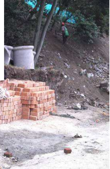
Foto 29 y 30. Excavación y materiales para un pozo de inspección.
