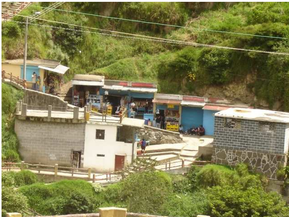
Foto 65. Construcciones aledañas al sitio donde se ubicará la estación de re-envío.
