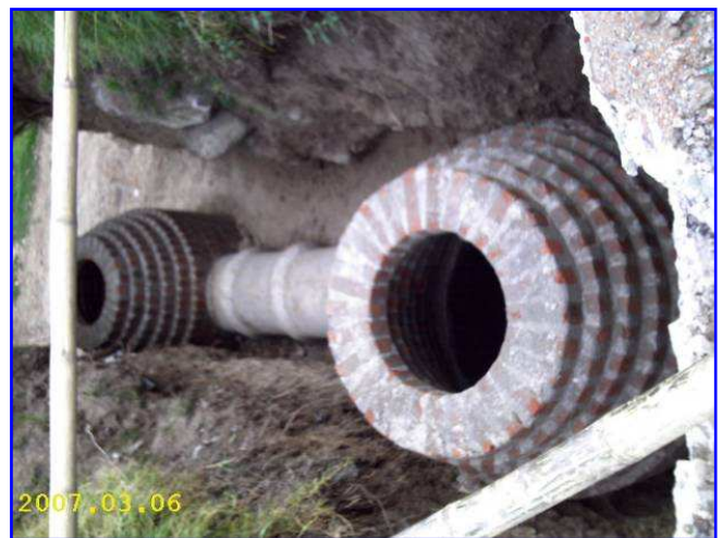
Foto 31 y 32. Fase intermedia y fase final de construcción de un pozo de inspección.
