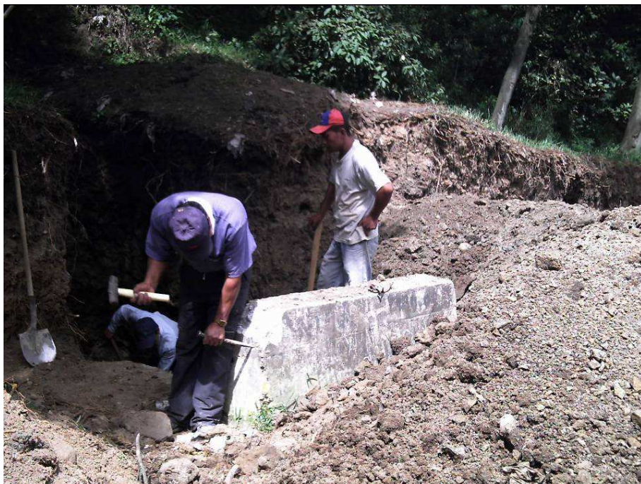
Foto 20. Demolición de cabezales.
