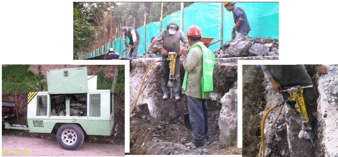
Foto 22. Demolición de andenes y muros con martillo neumático.
