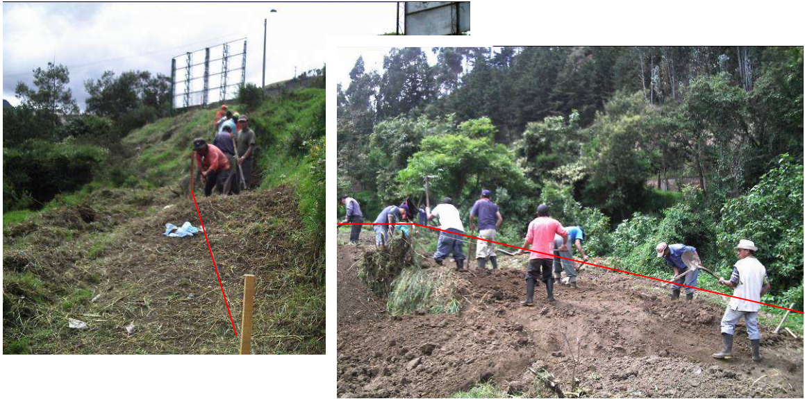
Foto 18 y 19. Descapote y limpieza del terreno.
