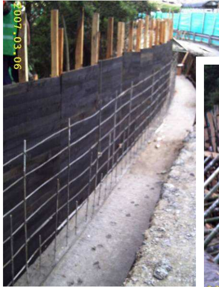
Foto 43 y 44. Encofrado del voladizo de muro de contención.
