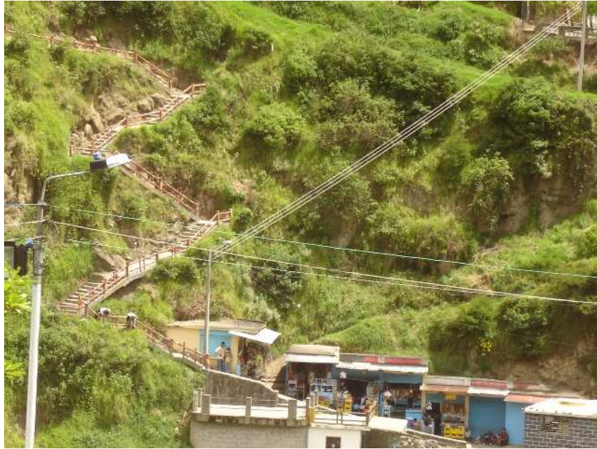
Foto 66. Cables de media y baja tensión sobre la estación de reenvío.
