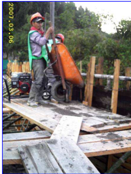
Foto 45 y 46. Fundición y vibrado del voladizo de muro de contención.
