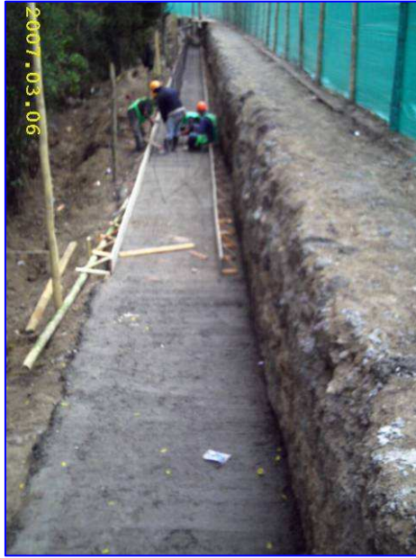
Foto 39 y 40. Encofrado y armado de acero de la base (zarpa) de muro de contención.
