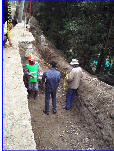
Foto 36 y 37. Excavaciones para muros de contención y comprobaciones de niveles de los mismos.
