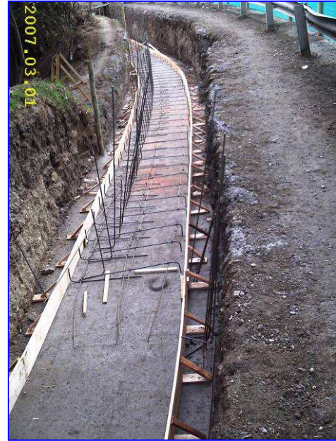
Foto 39 y 40. Encofrado y armado de acero de la base (zarpa) de muro de contención.
