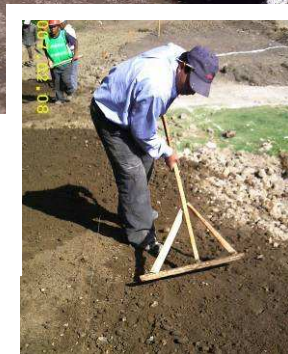
Foto 26, 27 y 28. Colocación y compactación de base en recebo compactado.
