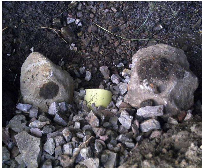
Foto 15. Parte inicial (de captación) del drenaje.
