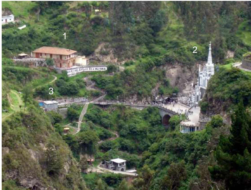
Foto 1. Panorámica de la zona del Proyecto (Las Lajas). 1. Restaurante el Santuario. 2. Santuario de Nuestra Señora de Las Lajas. 3. Estación de reenvío.
