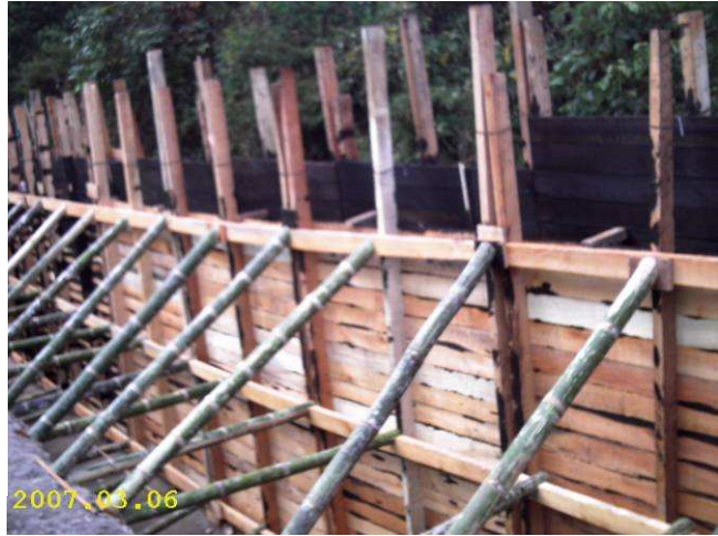
Foto 43 y 44. Encofrado del voladizo de muro de contención.
