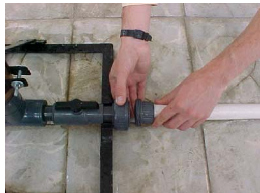
b. Tubería de alimentación - Ariete
