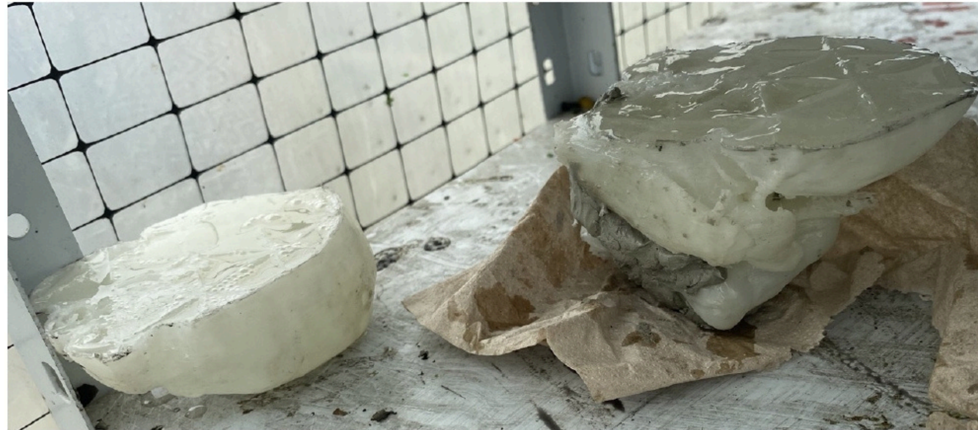
Figura: Relleno del corazón con resina epóxica.
