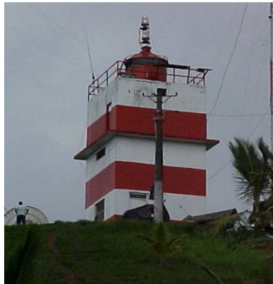
Figura 29. Edificación “El Faro” ubicada al interior de la DIMAR-CCCP en Tumaco.
