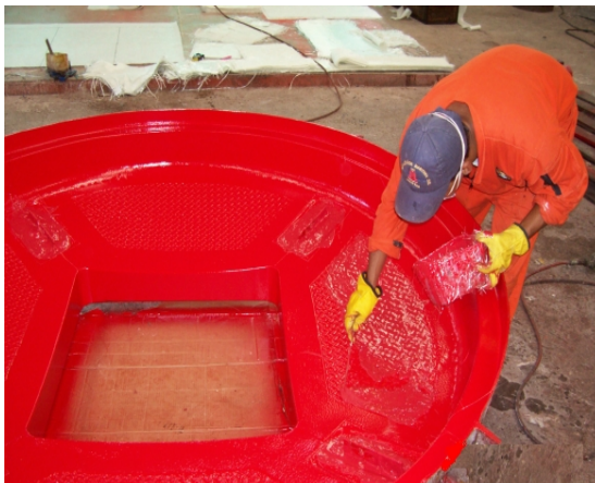
Figura 42. Aplicación de fibra de vidrio a una estructura de boya.
