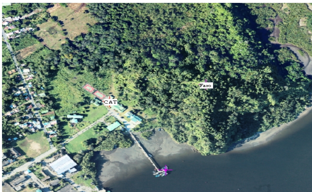
Figura 30. Instalaciones de la Dirección General Marítima en San Andrés de Tumaco donde se indica la estación receptora (CAT) y la estación repetidora (Faro).
