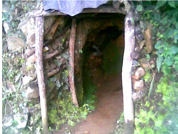
Figura 4. Túnel de extracción minera, mina La Palmera
