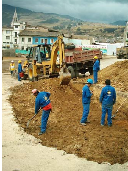
Figura 16. Excavación de la Senda
