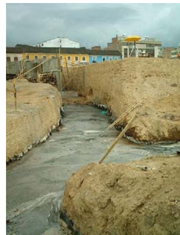
Figura 45. Estado final relleno fluido
