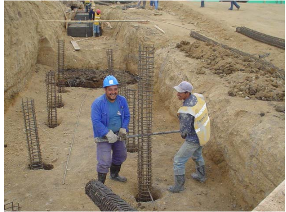
Figura 53. Instalación de canastillas
