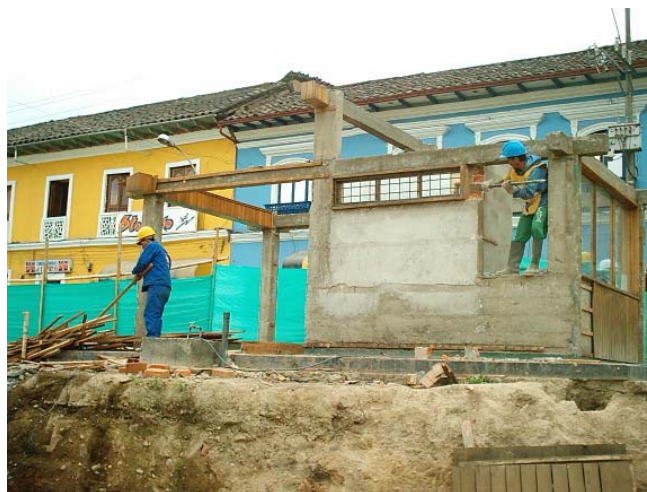
Figura 10. Demolición del CAI
