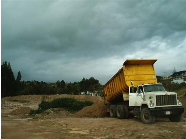
Figura 28. Descargue a escombrera
