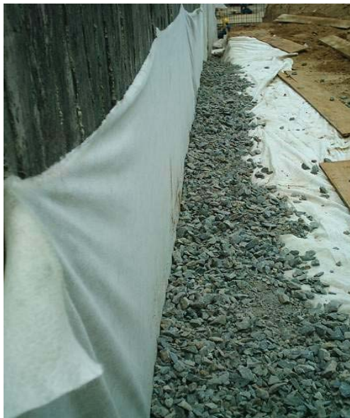
Figura 105: Filtro con geotextil y gravilla
