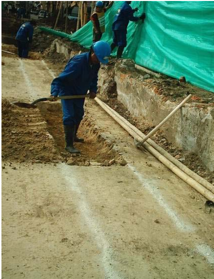
Figura 3. Demarcación para excavación
