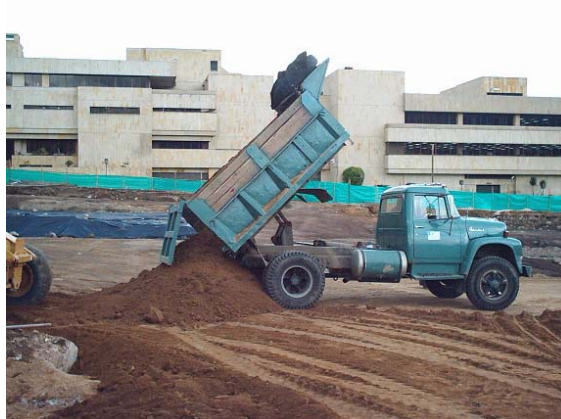
Figura 32. Descargue de material
