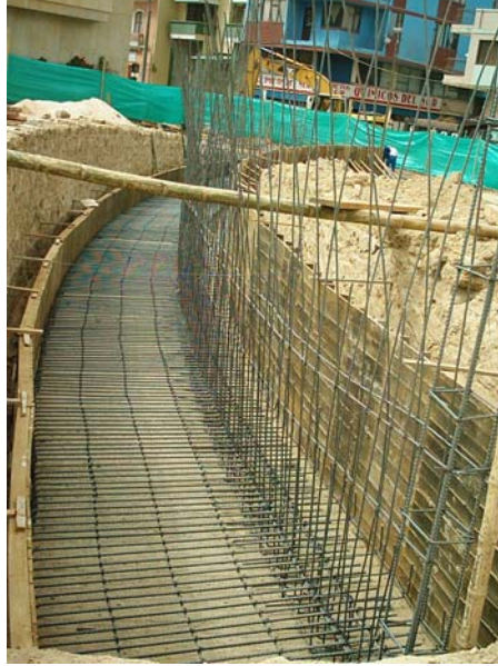
Figura 60. Amarre del refuerzo vertical
