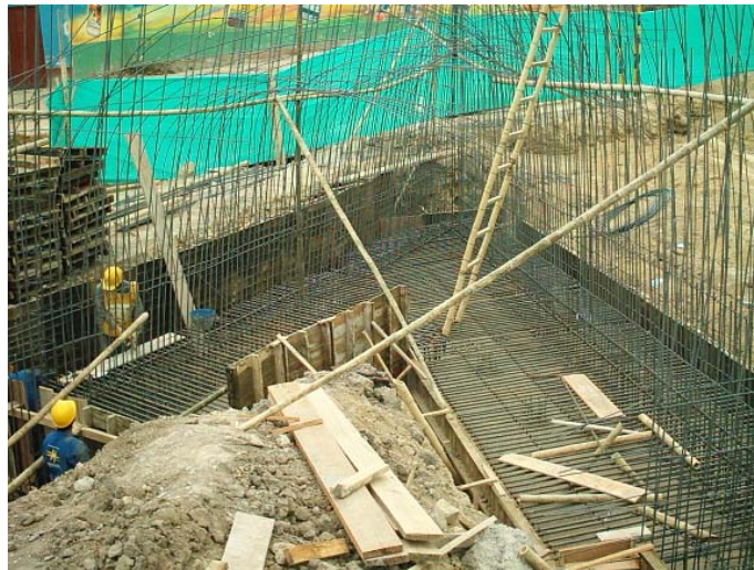
Figura 64. Refuerzo en muros
