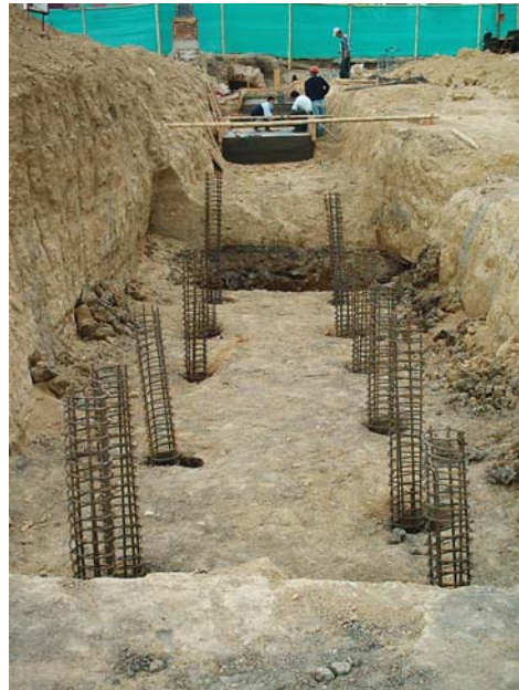
Figura 54. Canastillas para pilotes
