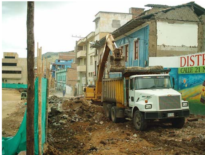
Figura 25. Desalojo de excavaciones
