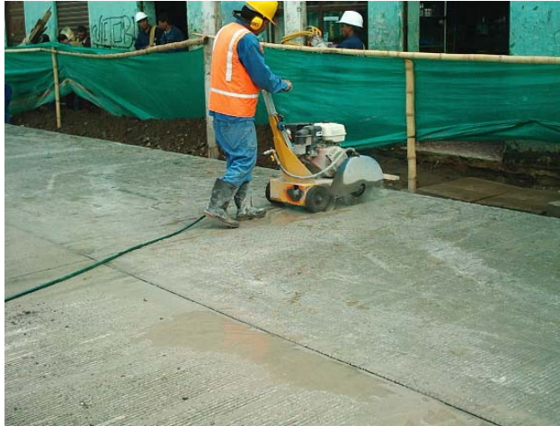
Figura 95. Corte de juntas para vías
