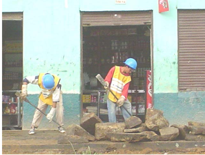
Figura 13. Retiro de piedra de andenes
