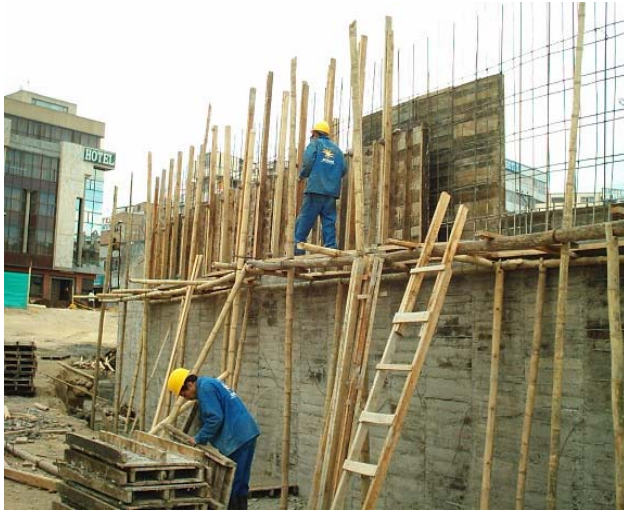
Figura 65. Formateado de muros
