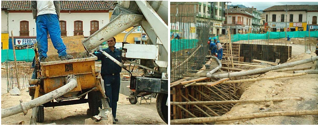
Figura 68. Fundición con motobomba
