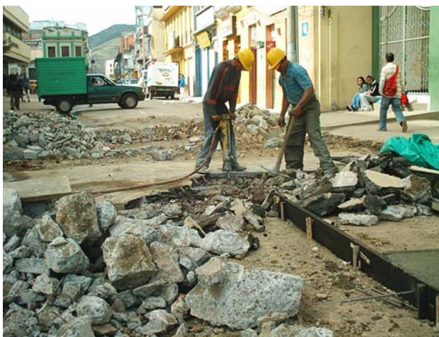
Figura 8. Demolición de pavimento
