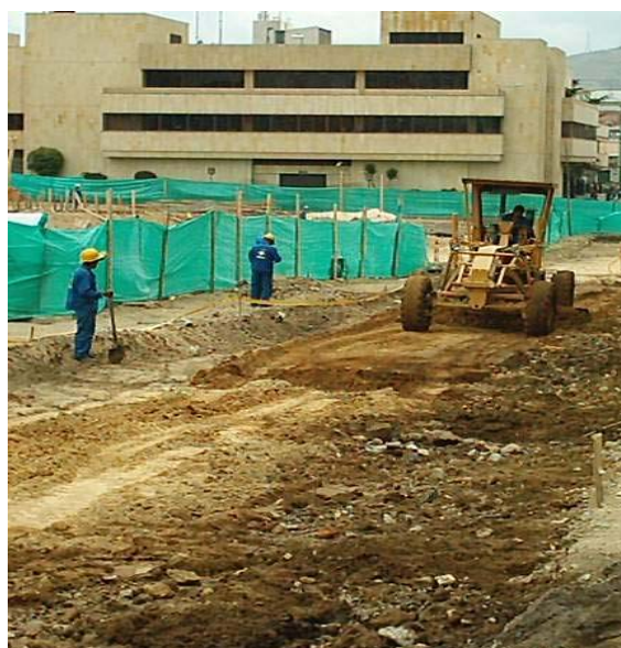
Figura 22. Cortes con Motoniveladora
