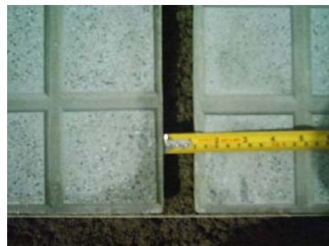
Figura 120: Dimensión de la junta
