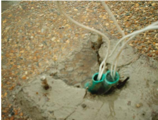
Figura 110. Sondeo de tubería eléctrica
