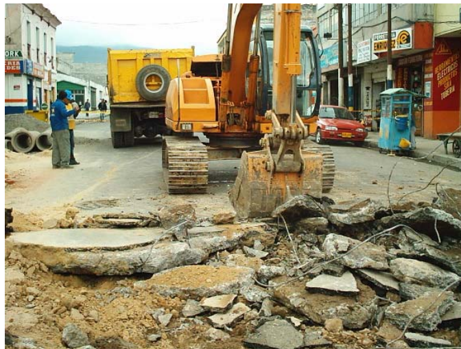
Figura 26. Desalojo de escombros
