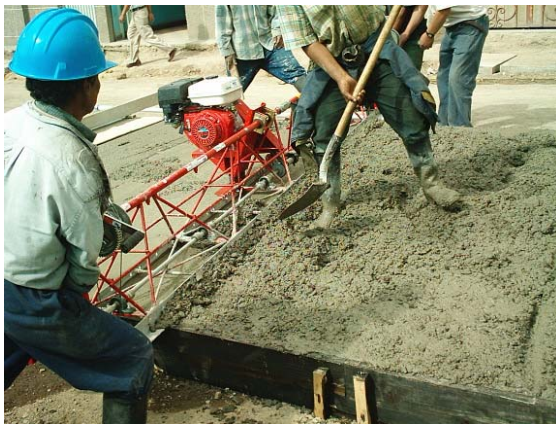
Figura 82. Regla vibratoria
