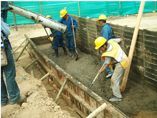
Figura 61. Colocación del concreto
