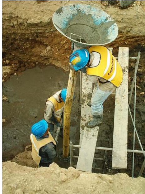
Figura 55. Fundición de pilotes
