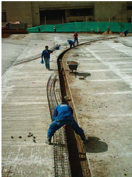
Figura 112. Canal de aguas lluvias
