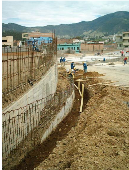
Figura 72. Espolón muro balcón
