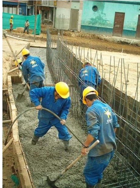
Figura 62. Vibrado del concreto
