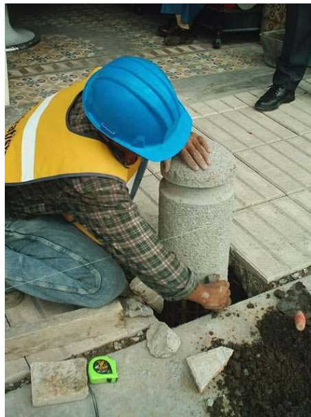
Figura 126. Instalación de bolardos
