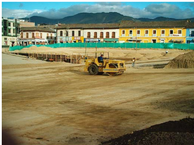
Figura 36. Compactación del relleno
