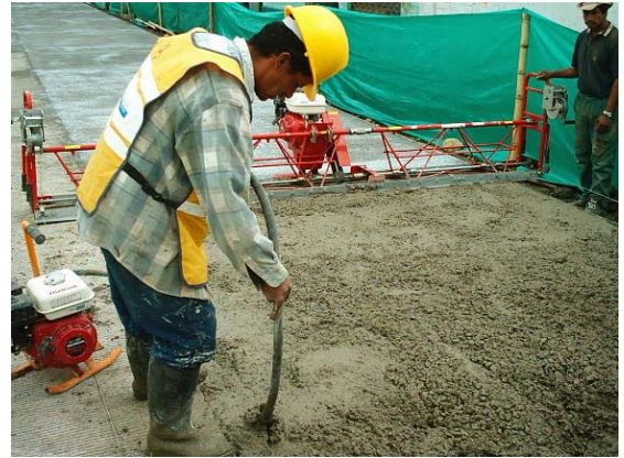
Figura 81. Vibrado del concreto
