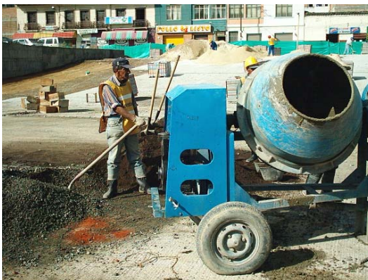
Figura 51. Mezcla de concreto “in situ”
