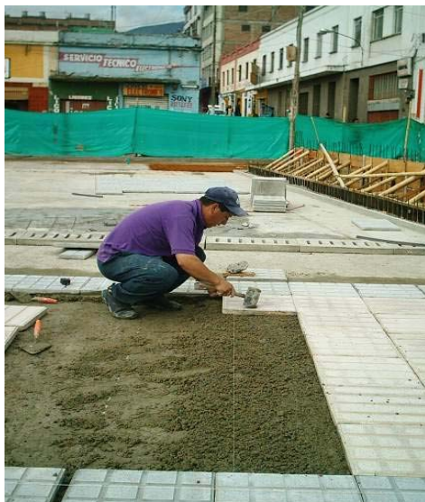
Figura 118. Fijación de la tableta
