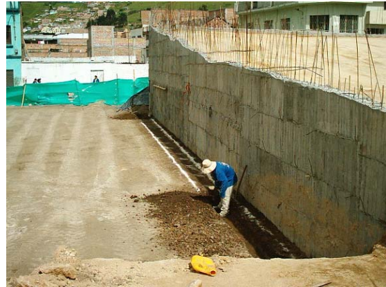
Figura 4. Demarcación para Tubería hidráulica
