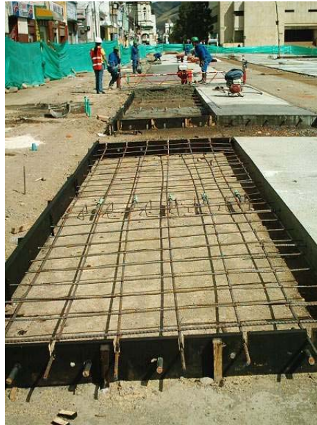
Figura 87. Reforzamiento en zona de boxcoulvert
