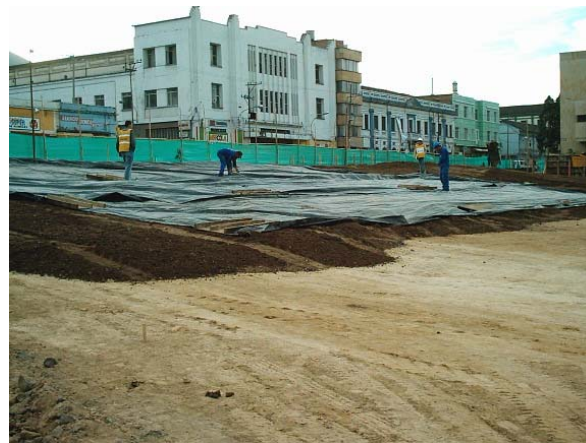
Figura 35. Material cubierto con plástico
