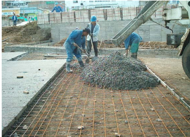
Figura 76. Fundición Placa de piso para plaza
