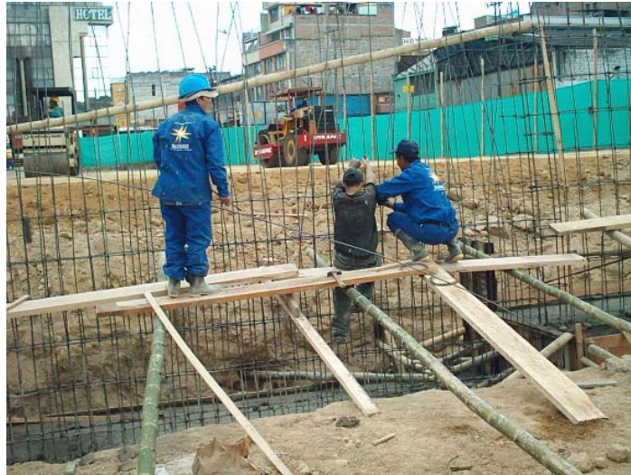
Figura 63. Instalación de refuerzo
