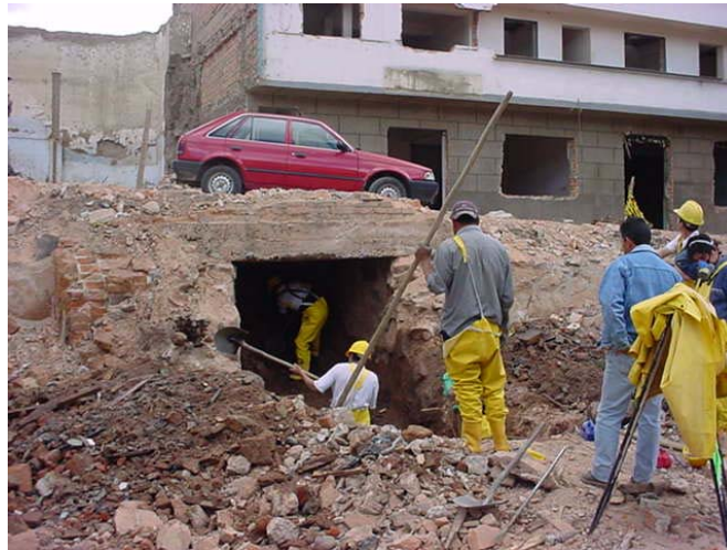
Figura 9. Demolición del Boxcoulvert
