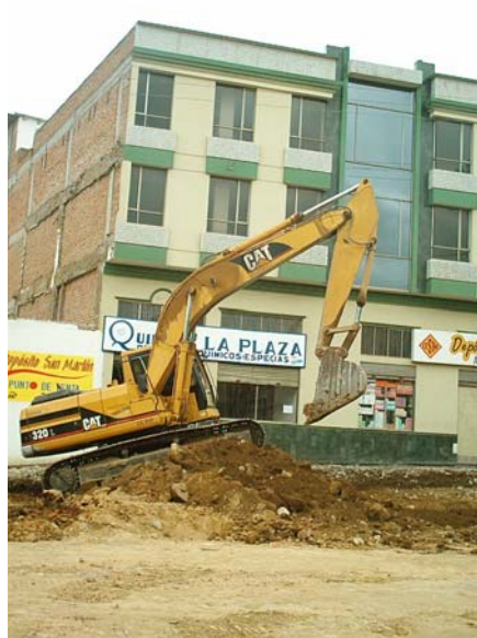
Figura 14. Retroexcavadora tipo pesado sobre orugas
