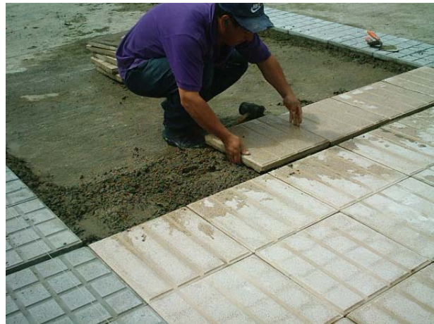
Figura 117. Colocación de la tableta
