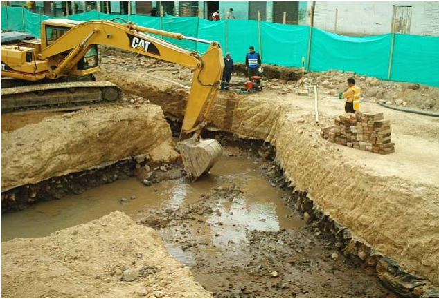
Figura 19. Excavación de material saturado
