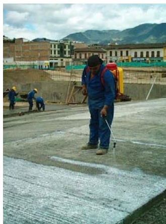
Figura 94. Curado del concreto con antisol
