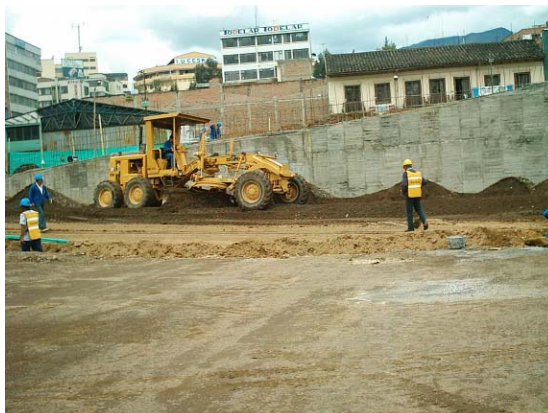
Figura 47. Extensión material para sub-base
