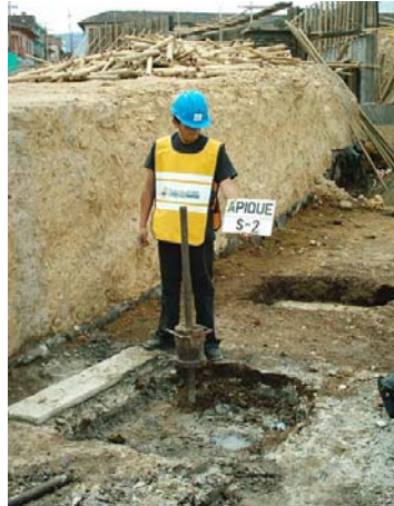
Figura 43. Apique en relleno fluido
