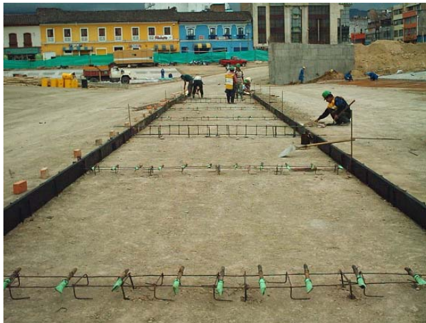
Figura 78. Ubicación de canastillas para dovelas
