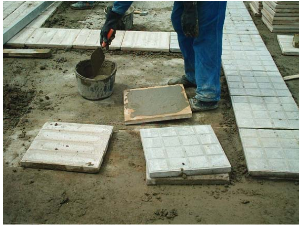
Figura 116. Humedecimiento del mortero
