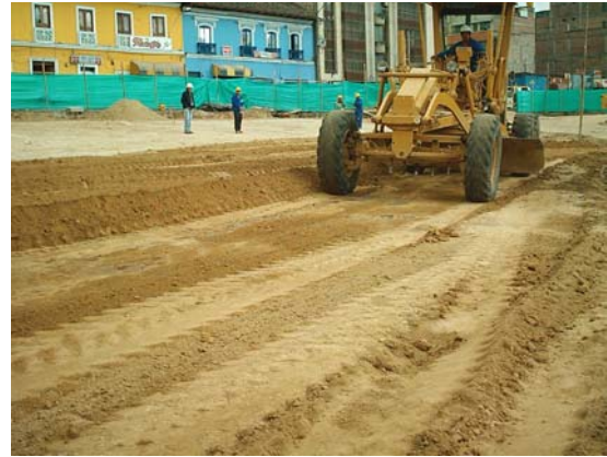
Figura 34. Nivelación del terreno
