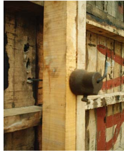
Figura 66. Aseguramiento con foncla
