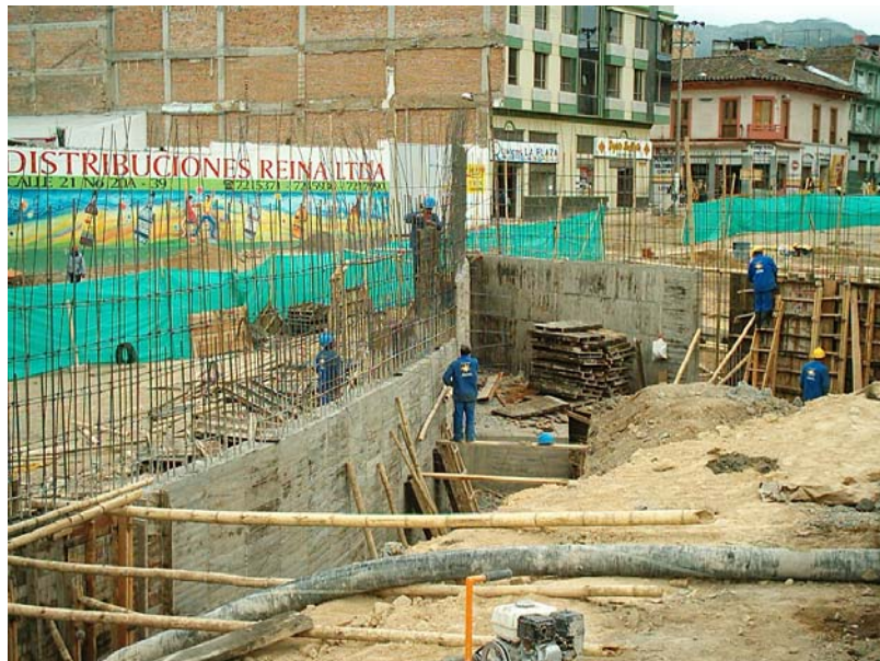
Figura 69. Fundición de muros por niveles
