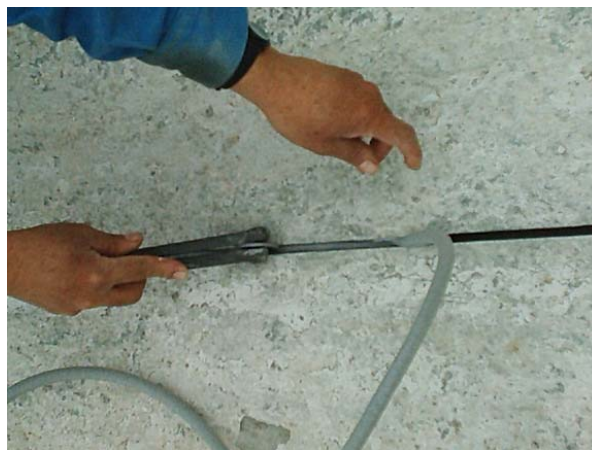
Figura 96: Instalación del cordón de polipropileno
