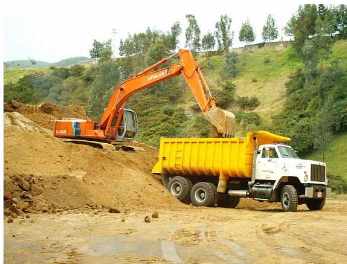
Figura 31. Cargue de material
