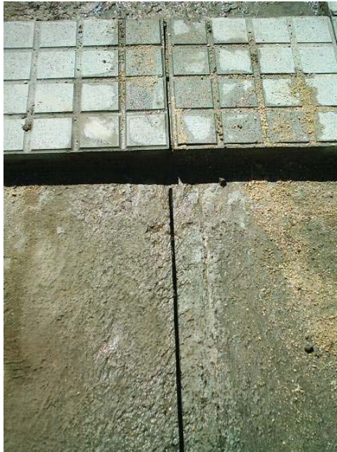
Figura 121: Junta de tableta y junta de losa
