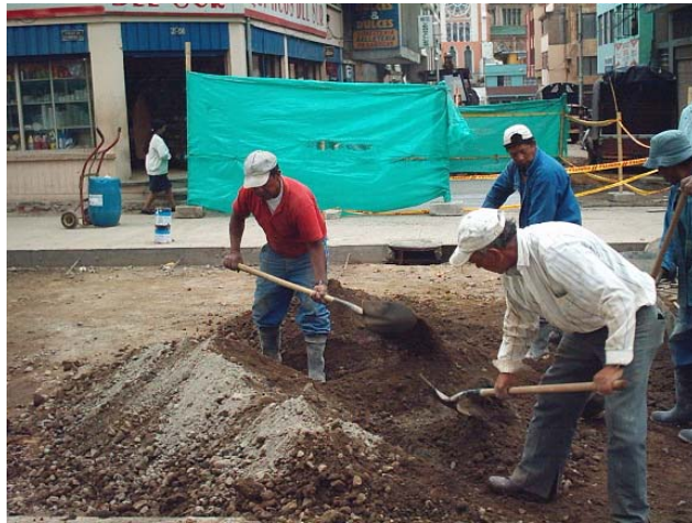
Figura 50. Relleno con suelo-cemento
