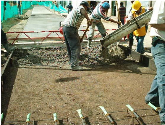
Figura 80. Colocación del concreto
