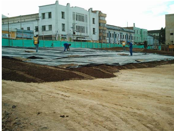
Figura 46. Material cubierto con plástico
