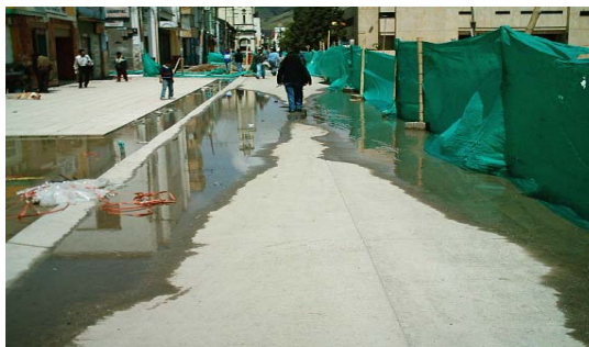
Figura 91. Empozamiento de agua en la calle 18.
