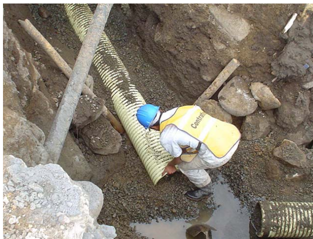
Figura 104. Colocación y Atraque de tubería
