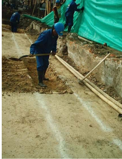
Figura 103. Demarcación para excavación
