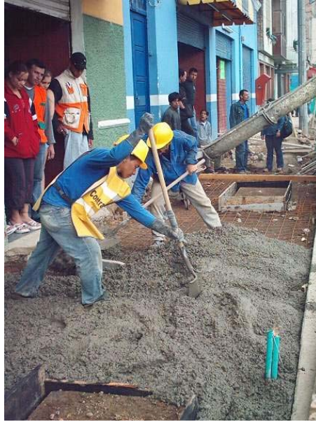
Figura 75. Concreto en andenes
