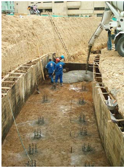
Figura 57. Fundición de solado
