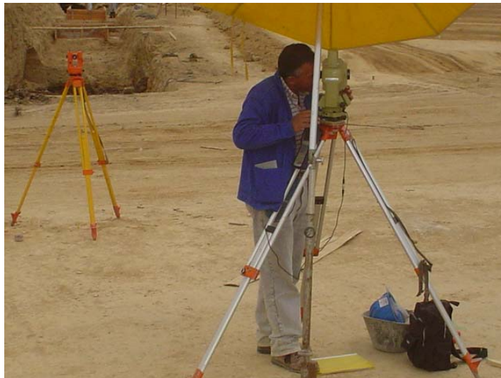
Figura 2. Localización y replanteo
