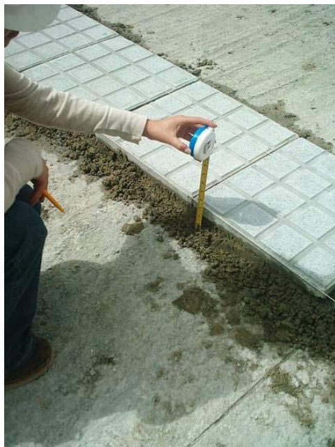
Figura 119. Espesor del mortero
