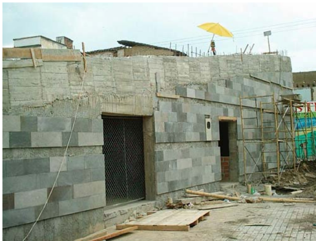
Figura 128. Enchape de muros
