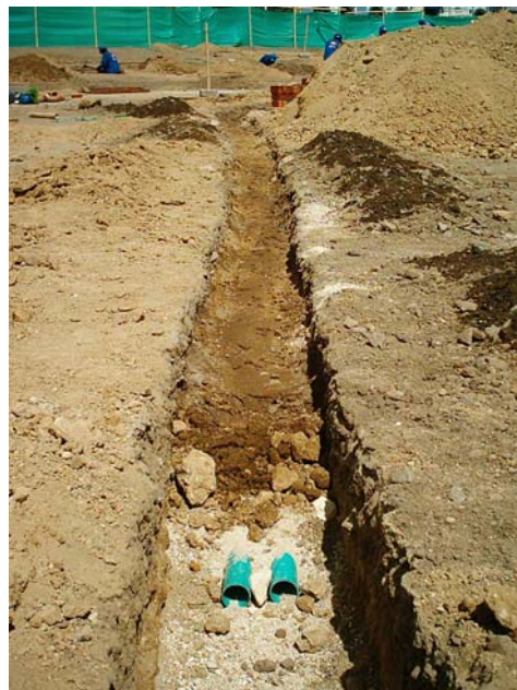
Figura 109. Relleno de zanja
