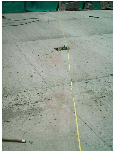
Figura 5. Demarcación de tableta
