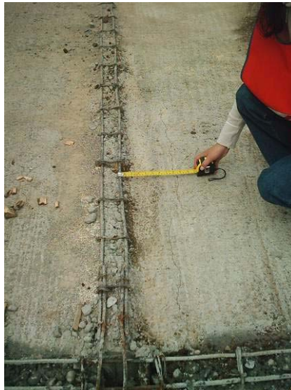
Figura 86. Viga de confinamiento en senda
