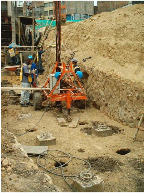
Figura 52. Perforaciones para pilotes
