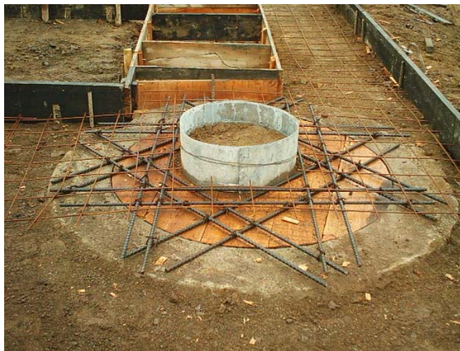
Figura 88. Reforzamiento de cámaras de inspección
