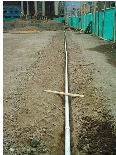
Figura107. Alineamiento de la tubería
