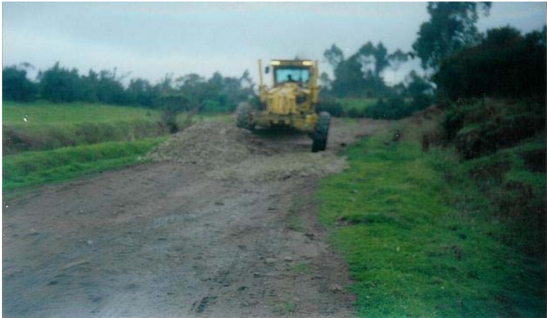
Figura 26. Tendido de material con motoniveladora
