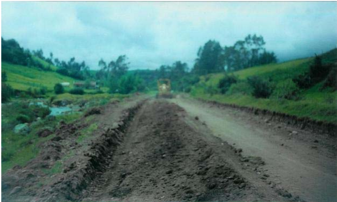
Figura 21. Construcción de cunetas
