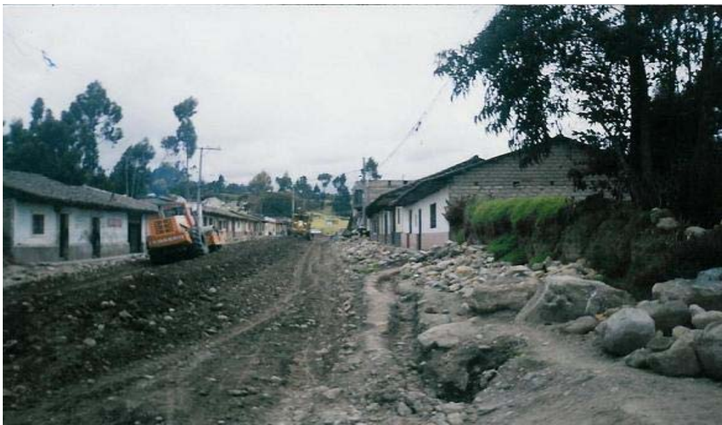
Figura 10. Tendido de material y compactacion de base
