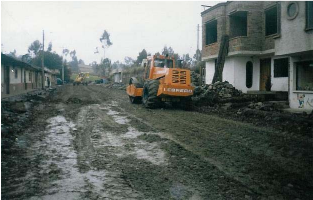
Figura 12. Material Compactado y perfilado
