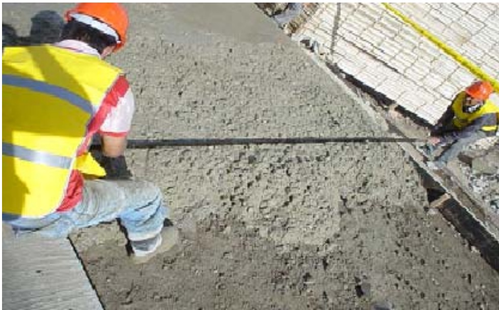
Figura 16. Colocación junta transversal
