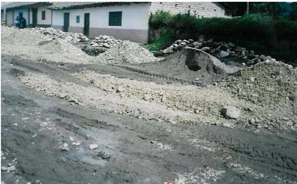
Figura 6. Tendido de material para secado
