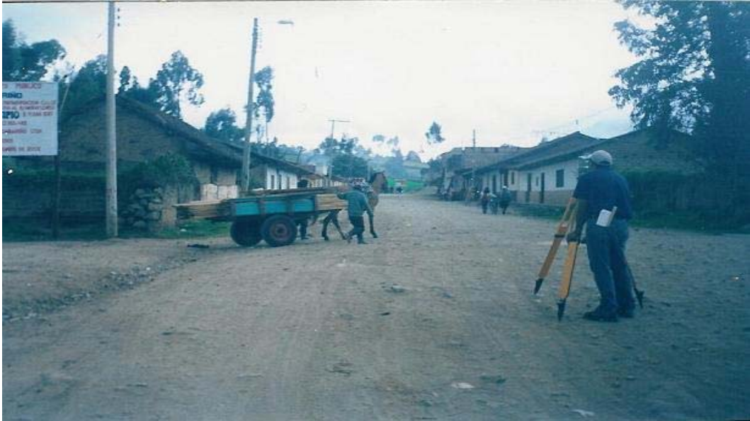
Figura 1. Localización y replanteo
