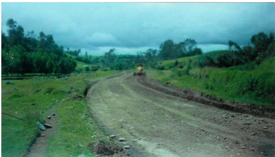
Figura 23. Acordonamiento de material
