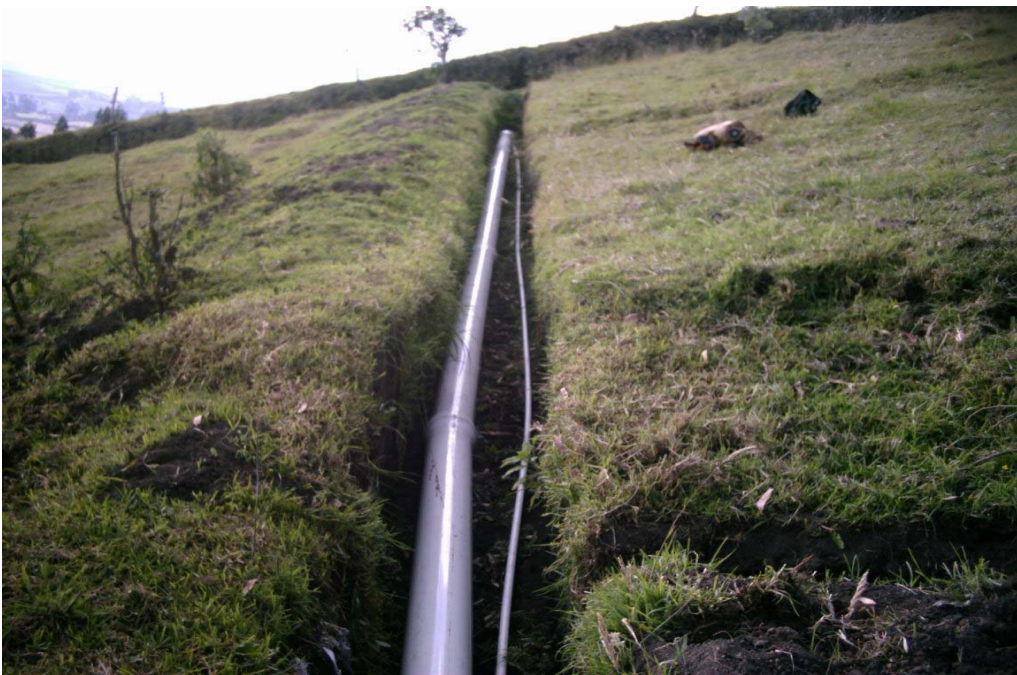
Figura 49. Tubería diámetro 8" instalada en salida de CR No 10
