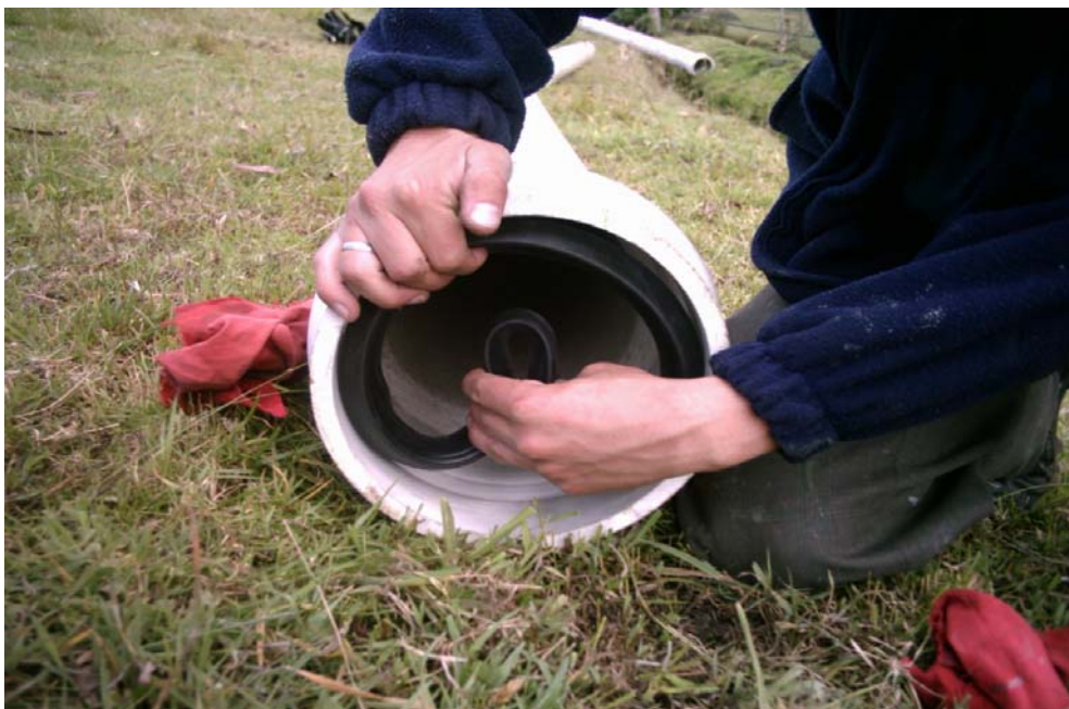
Figura 41. Colocación sello hidráulico
