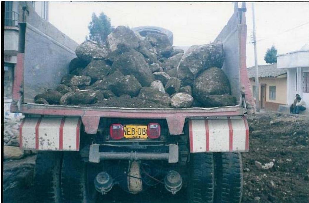
Figura 3. Desalojo de rocas durante excavación
