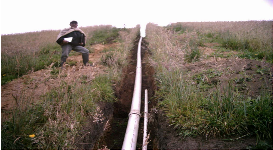
Figura 52. Tubería diámetro 4" instalada en conducción CR No 12- CR No 13
