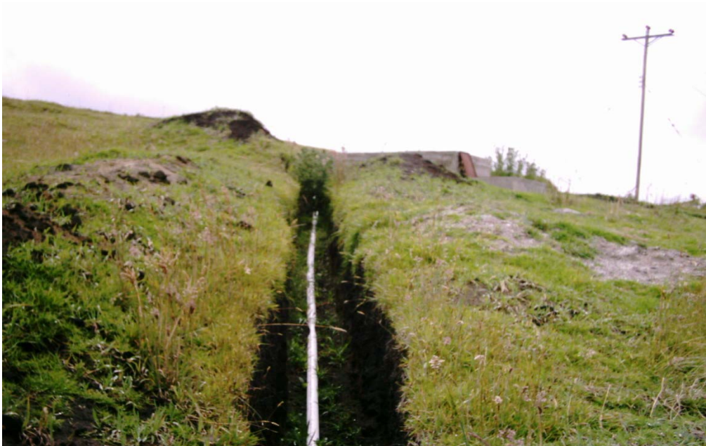
Figura 51. Tubería diámetro 6'' y 2'' instalada en conducción de CR No 9
