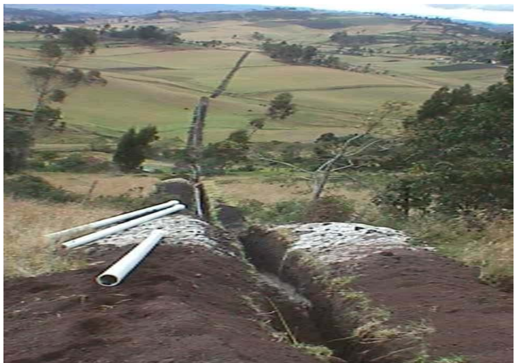
Figura 53. Tubería diámetro 4" instalada en ramal Vereda Cuaspud
