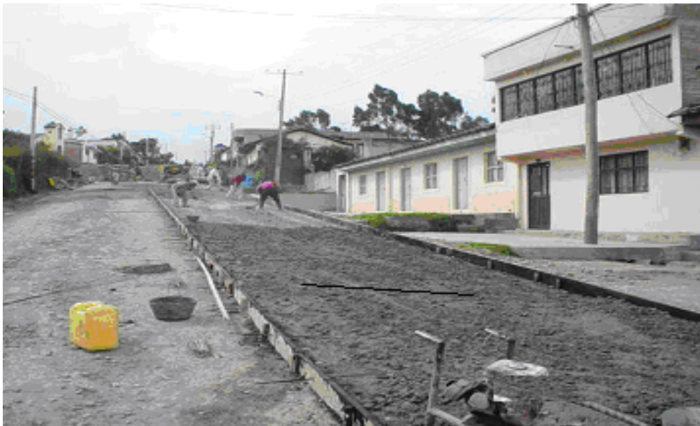
Figura 14. Colocación del concreto
