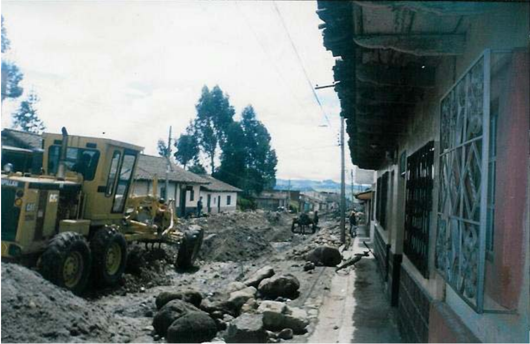
Figura 6. Tendido de material para secado
