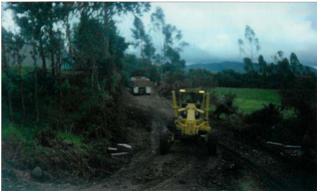
Figura 24. Acordonamiento y tendido de material
