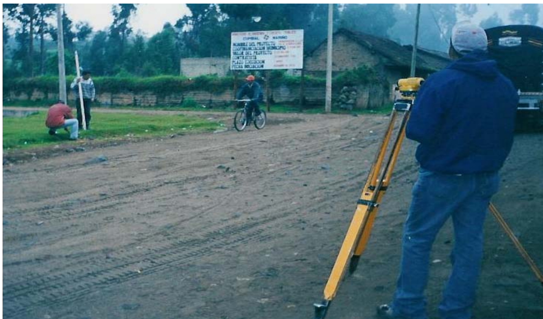
Figura 2. Localización y replanteo
