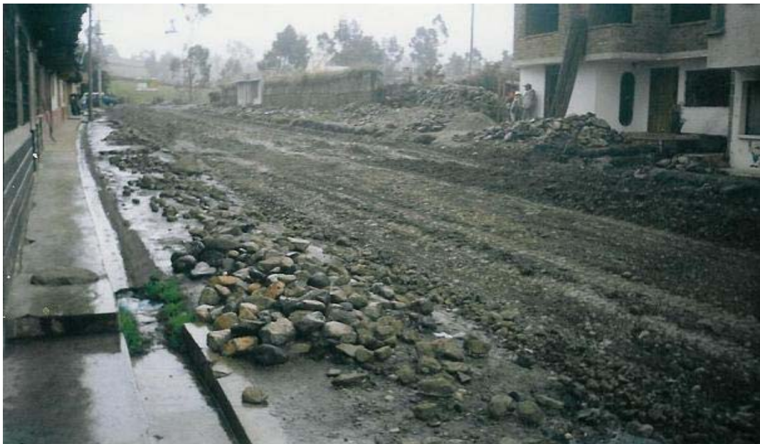
Figura 8. Material listo para compactación de base
