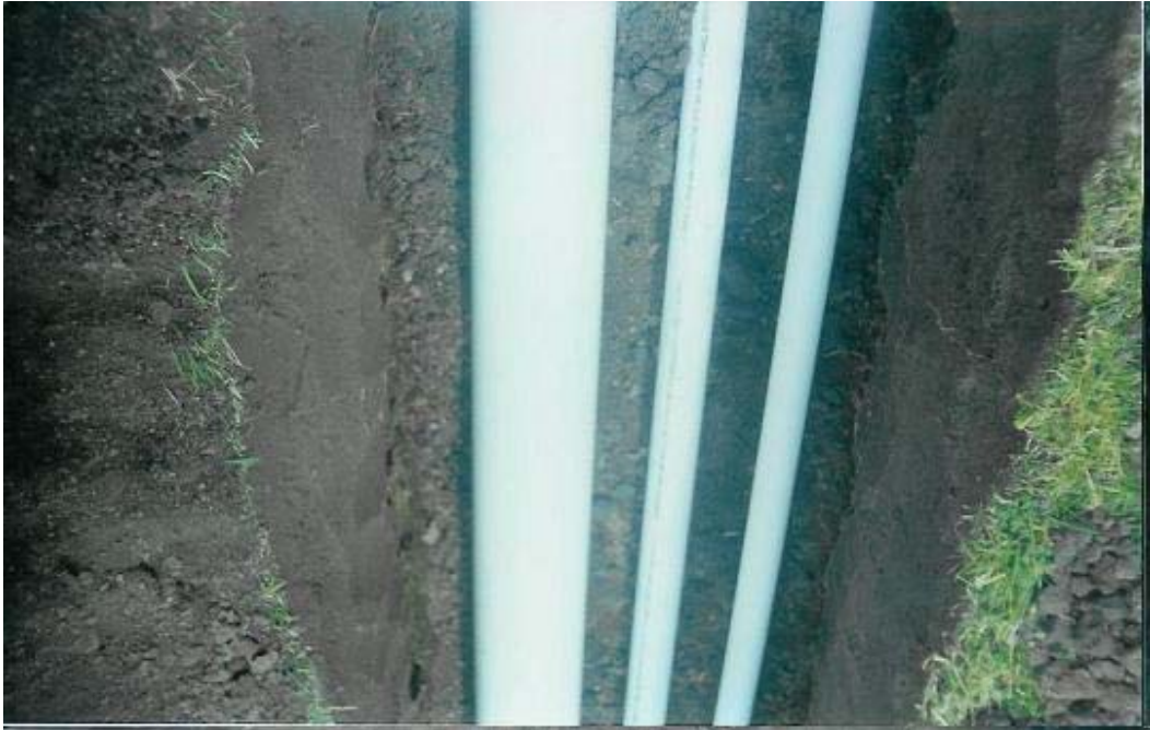
Figura 44. Tubería instalada de 10", 3 "y 2 ½" en cámara de reparto No 10
