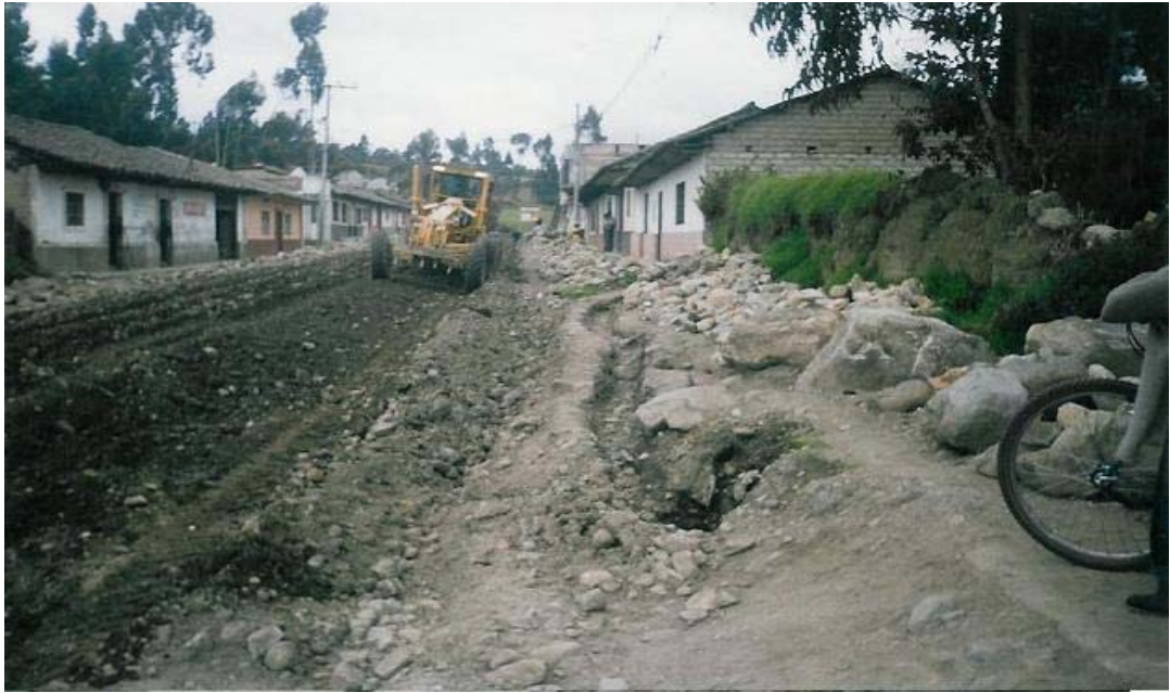
Figura 10. Tendido de material y compactacion de base
