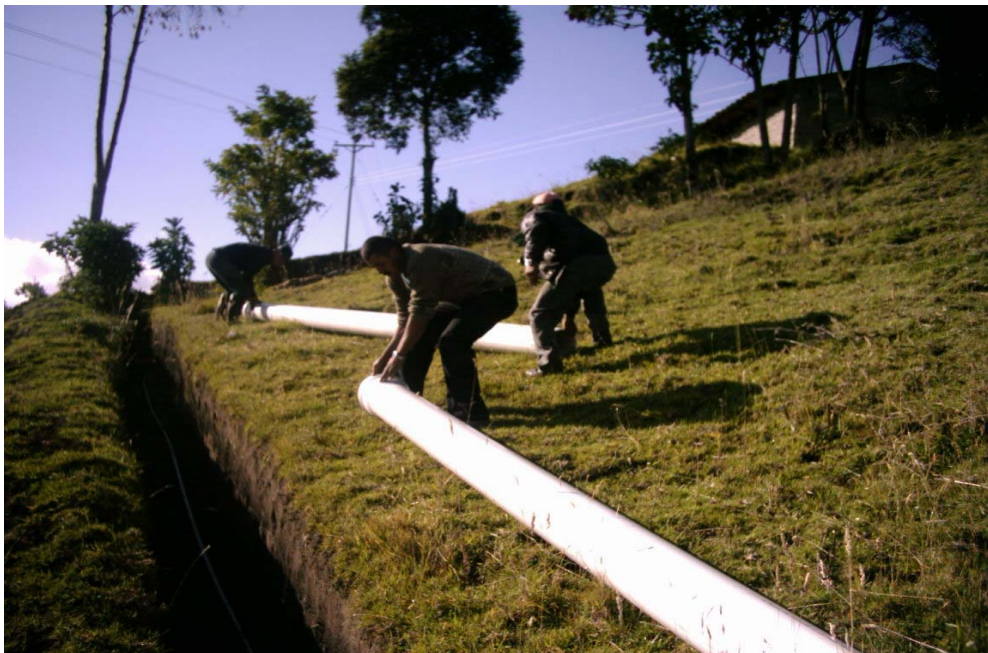
Figura 46. Tubería diámetro 8" instalada en Vereda Boyera
