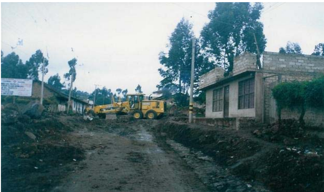
Figura 4. Nivelación de subrasante
