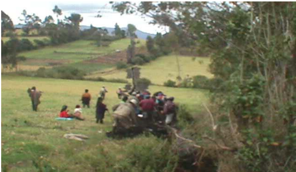
Figura 57. Trabajo de relleno
