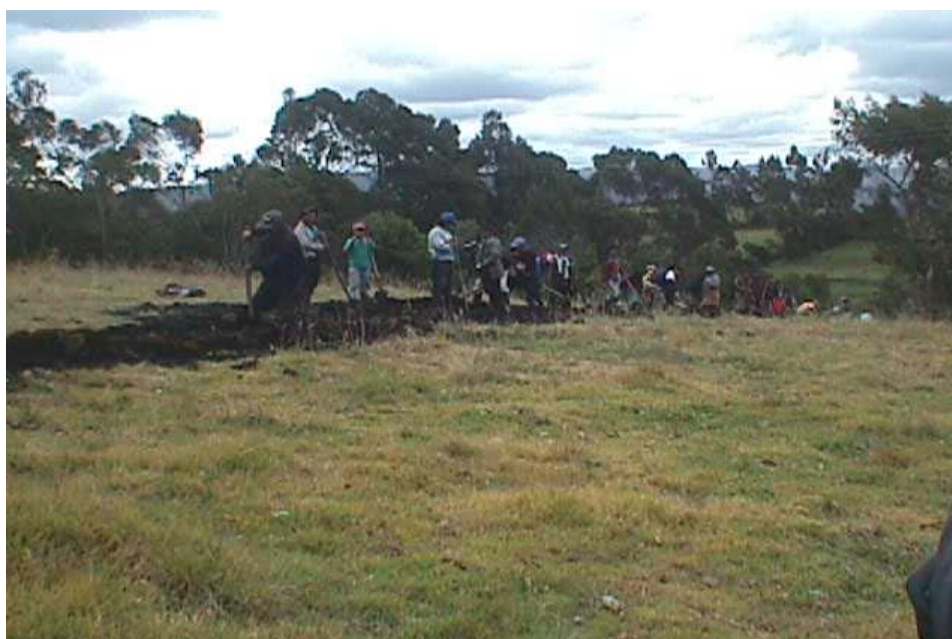
Figura 55. Trabajos de relleno
