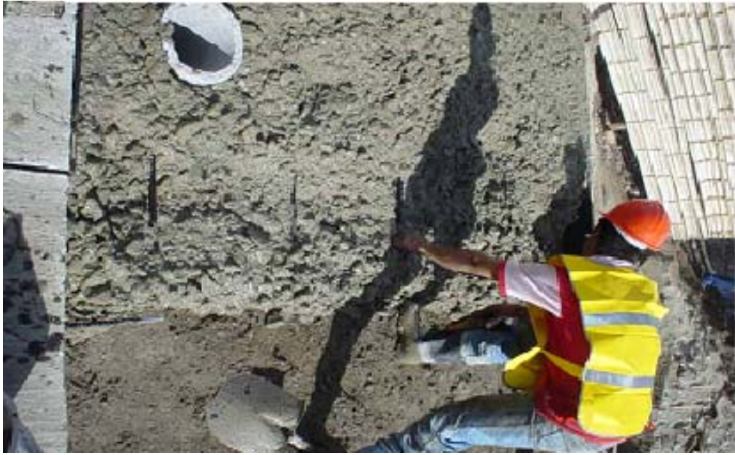
Figura 16. Colocación junta transversal
