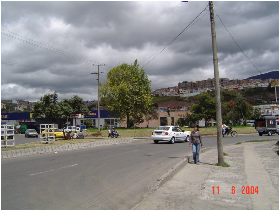
Figura 2. Estado actual de andenes y glorieta:
