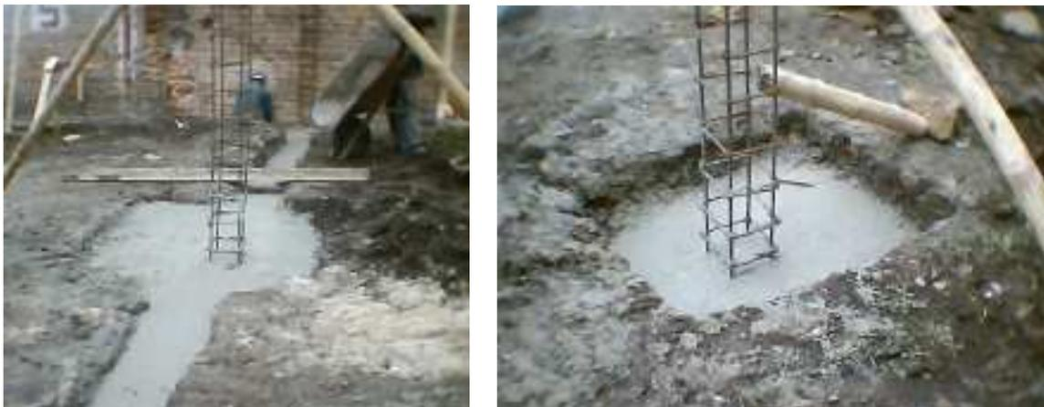
Se debe tener un especial cuidado en la preparación de la formaleta de las primeras, porque puede presentarse la formación de “barrigas” que resultan difíciles de corregir; sin querer decir con esto, que no se deba atender el encofrado de las segundas.
