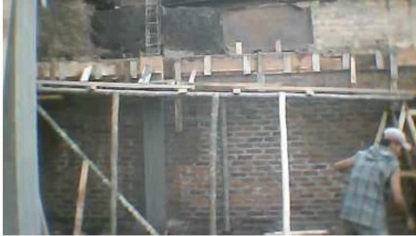
La cinta utilizada en esta construcción es de concreto reforzado con 2 barras longitudinales de 3/8 de pulgada; y refuerzo transversal de 1/4 de pulgada cada 20 cm., con altura de 10 cm.
