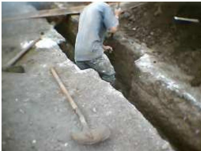
▲ **Desalojo del material sobrante.** Para el desalojo del material que sobra de la nivelación y las excavaciones, se contrato un cargador y una volqueta que hicieron este trabajo. Aunque también se hizo un desalojo de tipo manual, utilizando la volqueta y los obreros.
