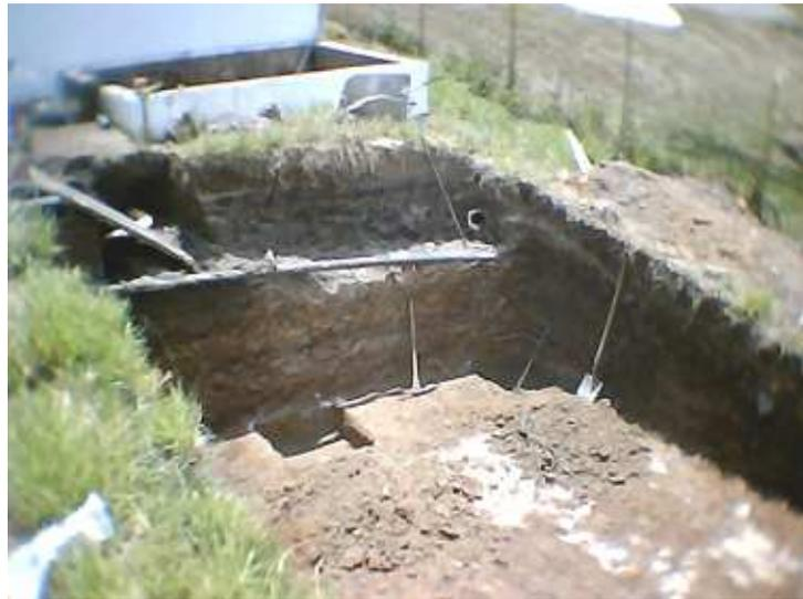
▲ **Cimentación.** La preparación de la subbase fue elaborada con material granular (Recebo), que fue transportado hasta el lugar de la obra. Con un espesor de 0.20 m.; la subbase fue conformada de manera manual utilizando una cuadrilla de obreros.
