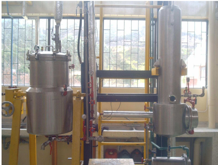
Figura 5. Unidad de Extracción de arrastre con vapor 1
