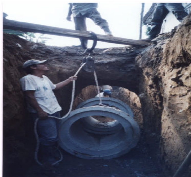
Figura 38. Instalación tubería 24"
