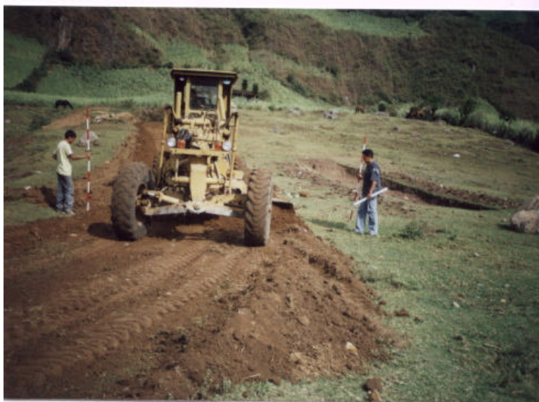
Figura 2. Apertura de vía.
