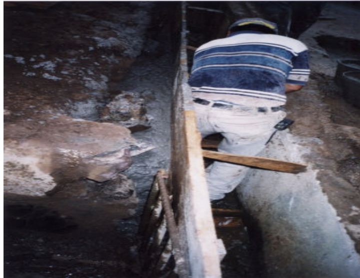
Figura 65. Fundición de la reja
