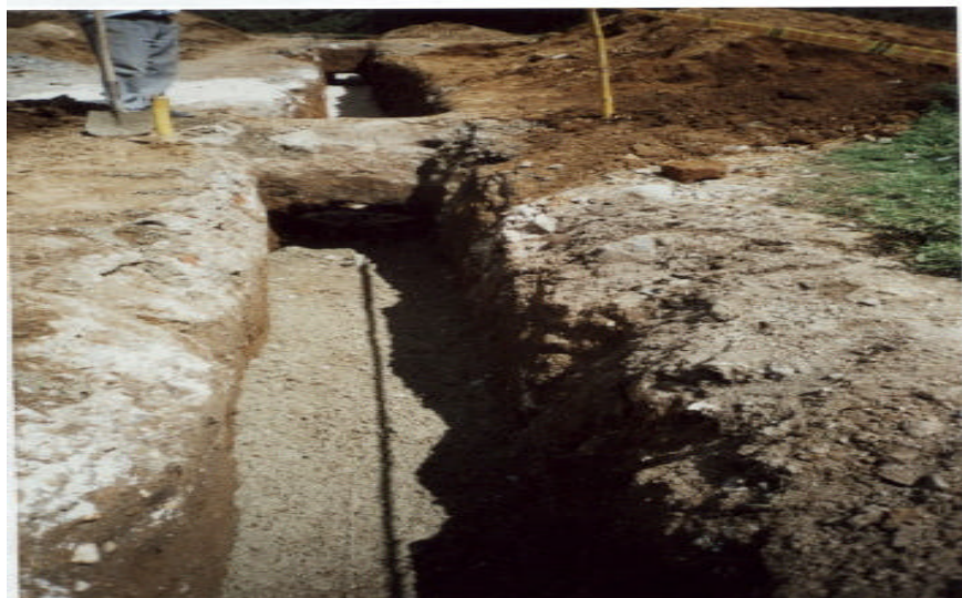
Figura 16. Compactación alcantarillado sanitario.
