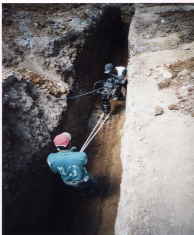
Figura 17. Relleno con material de excavación
