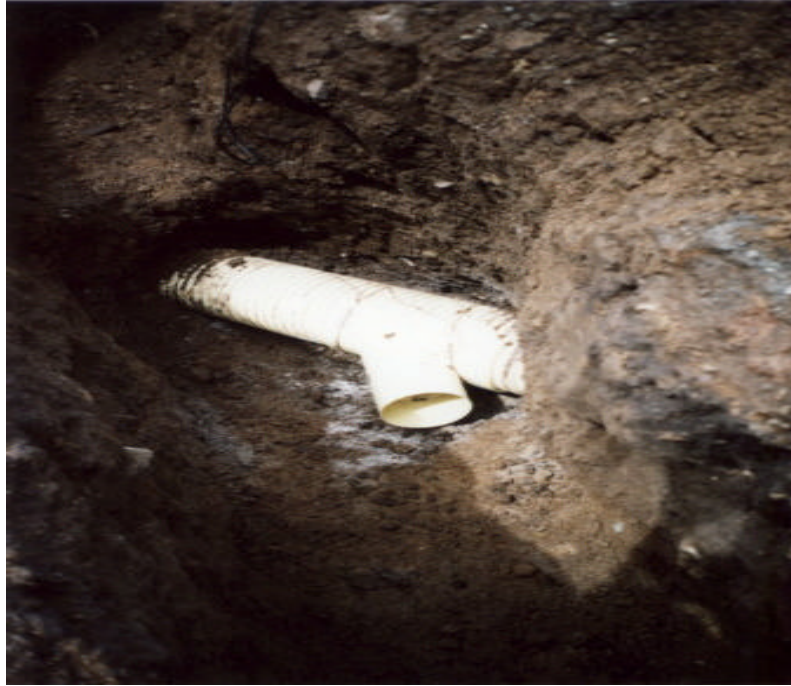
Figura 26. Instalación silla
