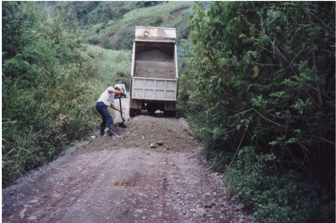
Figura 13. Extendida Preliminar de material de afirmado vía Bolívar.
