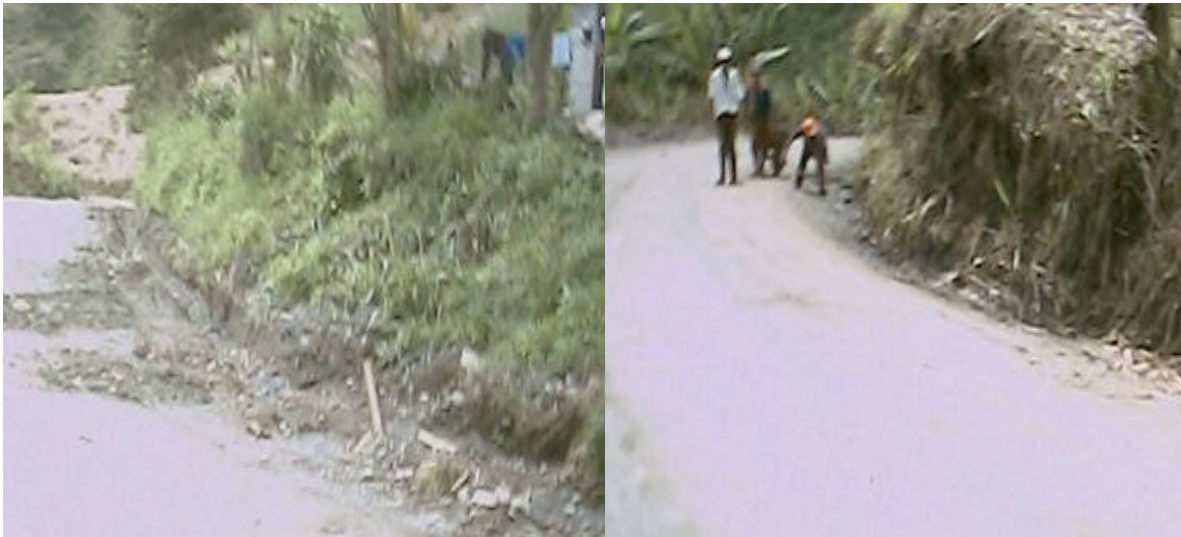
Figura 27. Limpieza manual de las cunetas, vía al Vergel.
