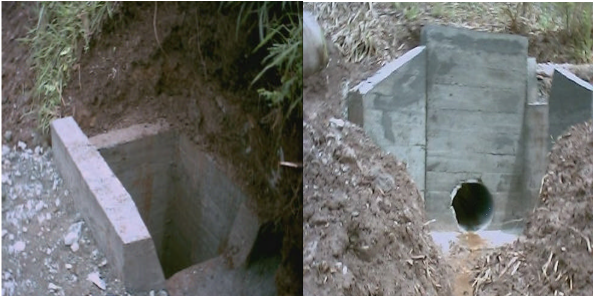
Figura 22. Caja y aletas con su muro central terminados.
