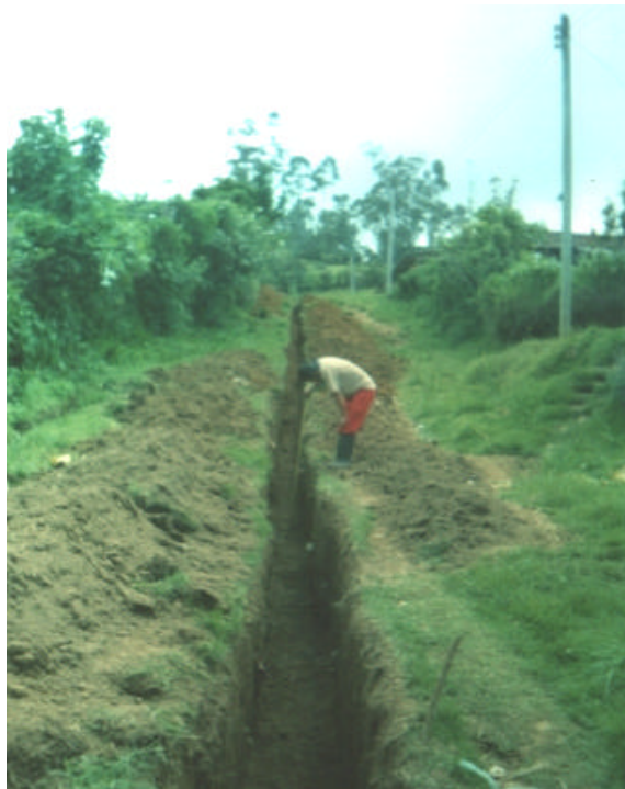
Figura 42. Chequeo de cotas batea tramo 24-12, carrera 2ªA.
