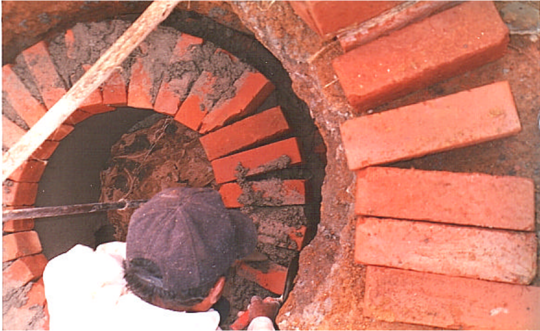
Figura 56. Pozo de inspección No 15 terminado.
