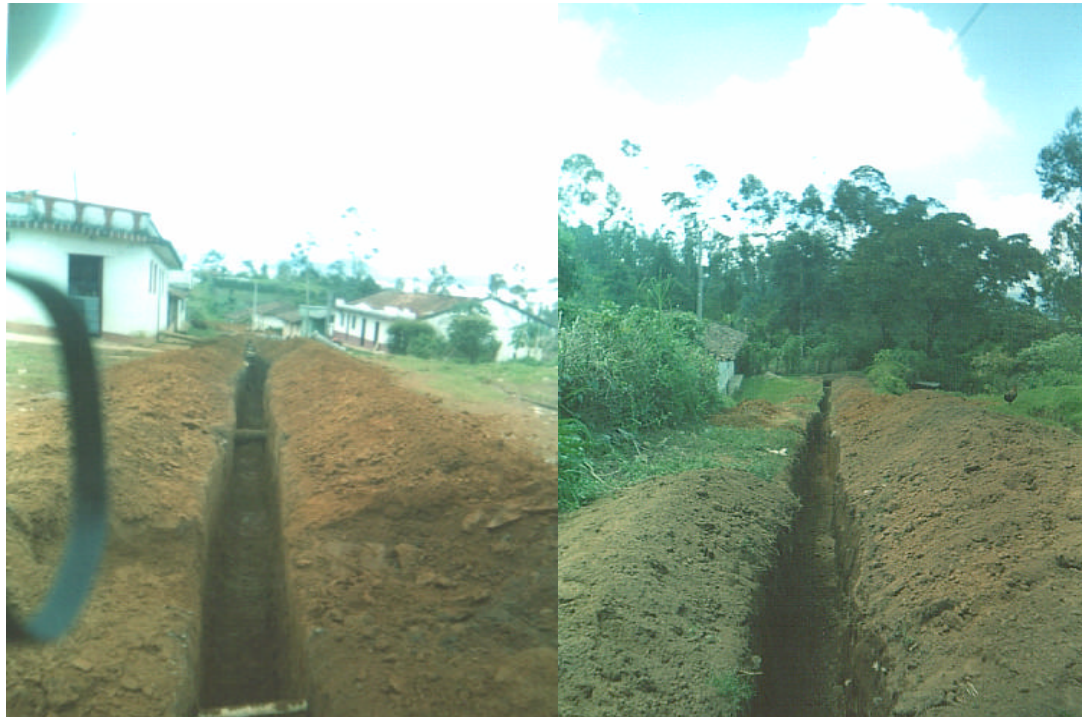
Figura 43. Zanjas en la calle 2ª y la carrera 2ªA.
