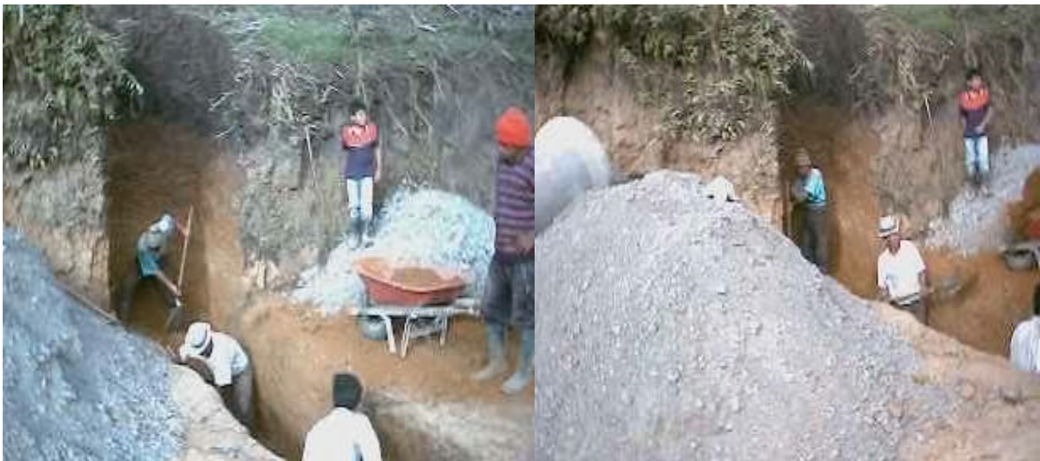
Figura 18. Excavaciones y materiales para alcantarilla vía Alto Jiménez.
