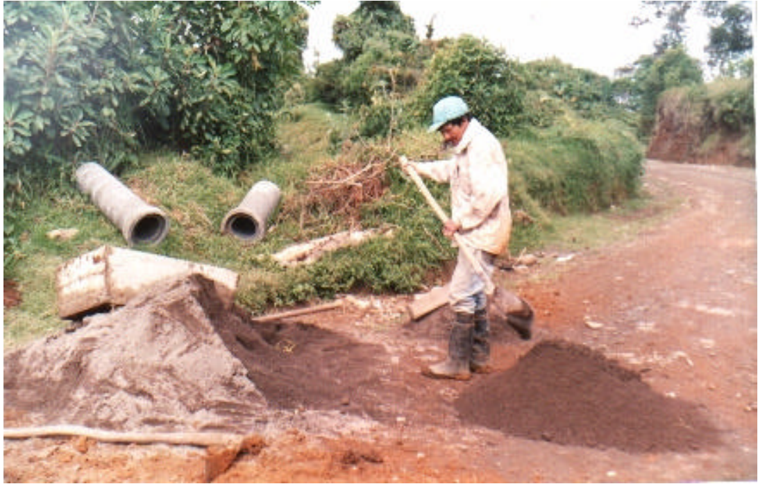
Figura 47. Pega y sellamiento de la tubería.
