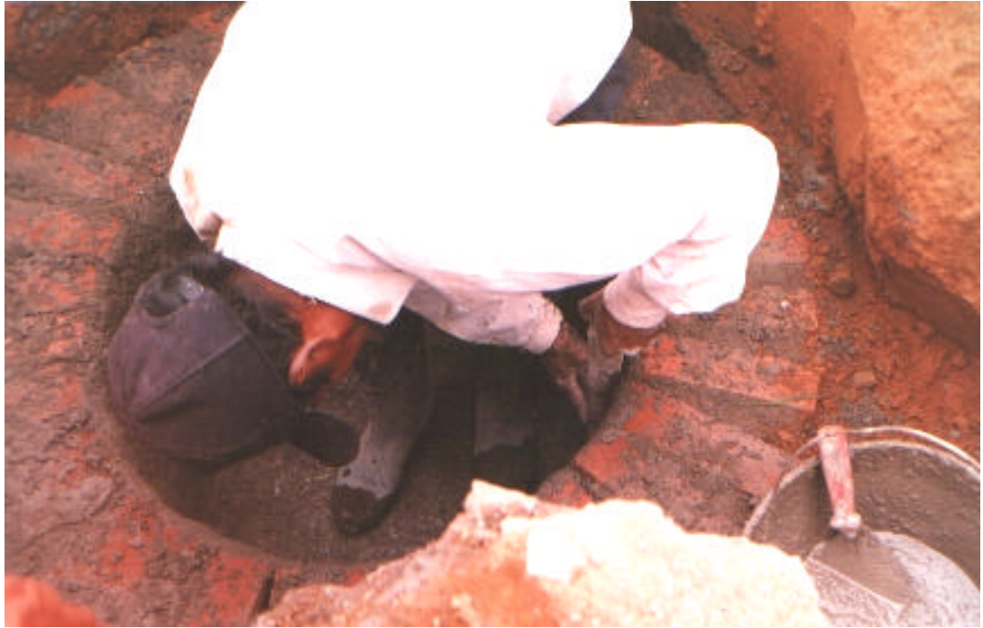
Figura 54. Pega de ladrillo tipo tizón en forma circular.
