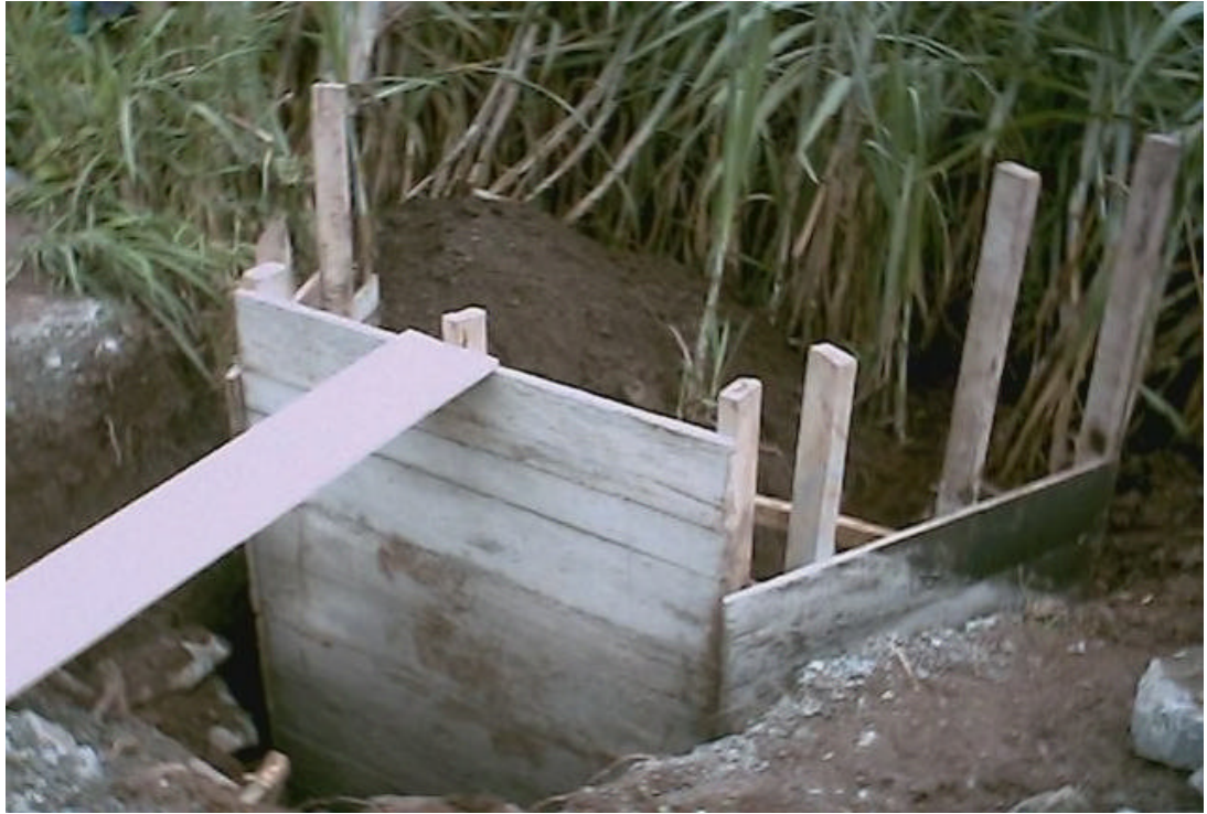
Figura 22. Caja y aletas con su muro central terminados.
