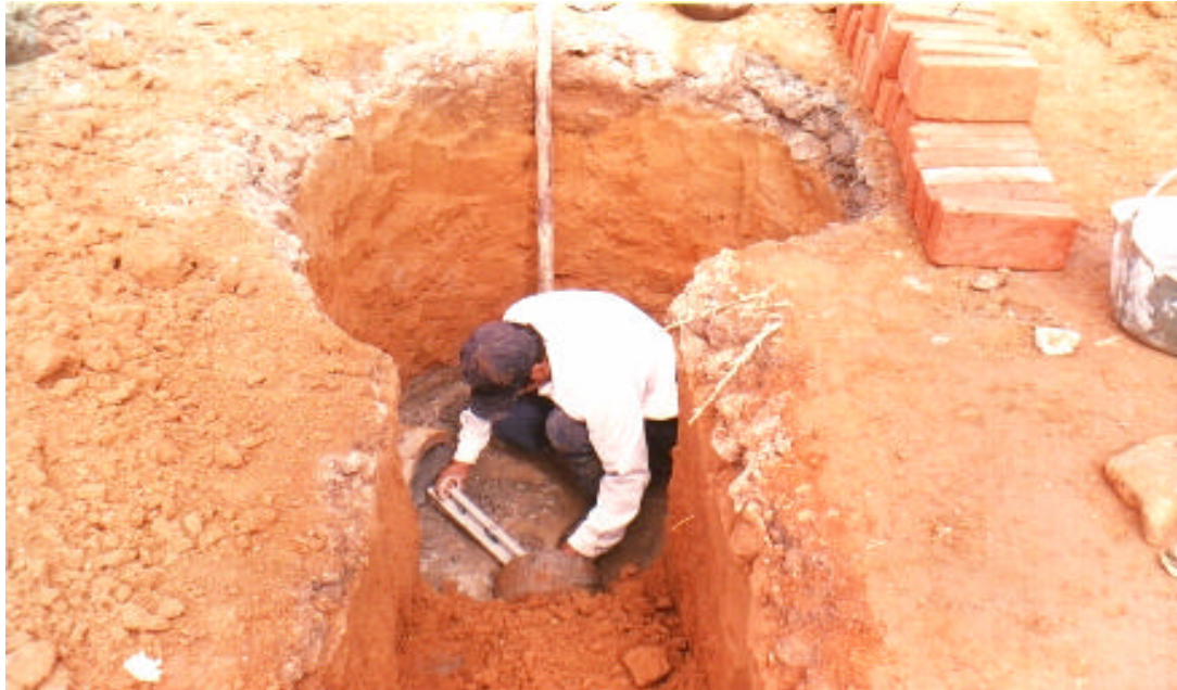
Figura 52. Solado de limpieza y verificación del desnivel cámara 35.
