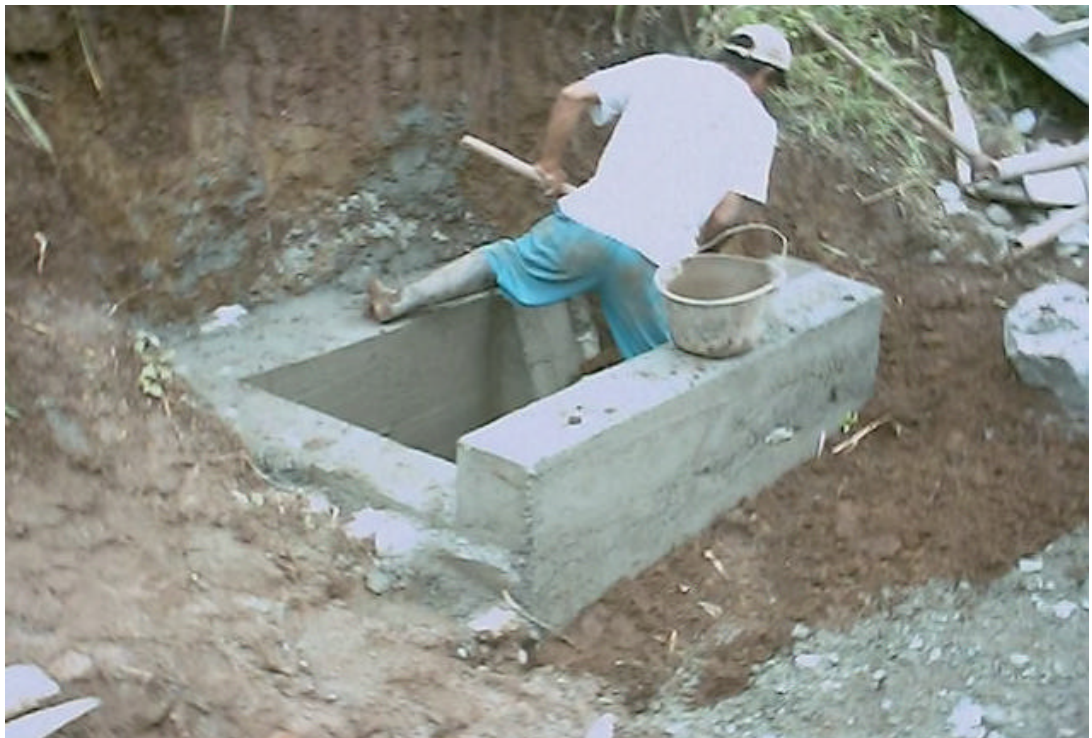
Figura 20. Relleno compactado en las paredes de la caja y colocación de recebo.
