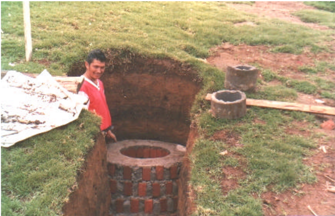
Figura 56. Pozo de inspección No 15 terminado.
