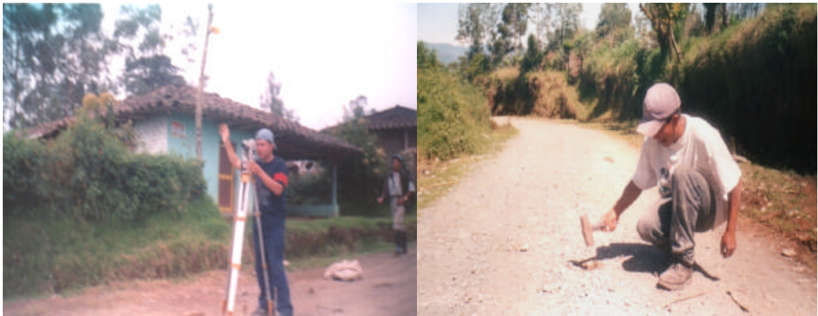
Figura 40. Labores de replanteo.
