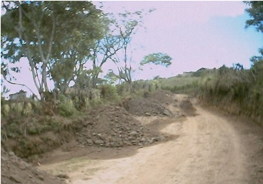
Figura 35. Acordonamiento de material sector El Vergel.
