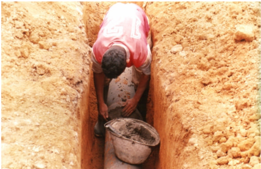
Figura 47. Pega y sellamiento de la tubería.
