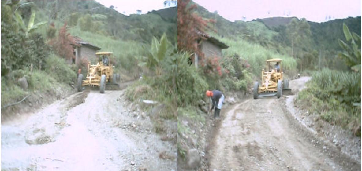
Figura 37. Material extendido uniformemente y compactado por el tráfico.
