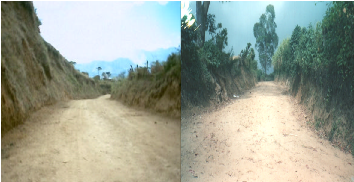
Figura 16. Tramos perfilados vía Alto Jiménez.
