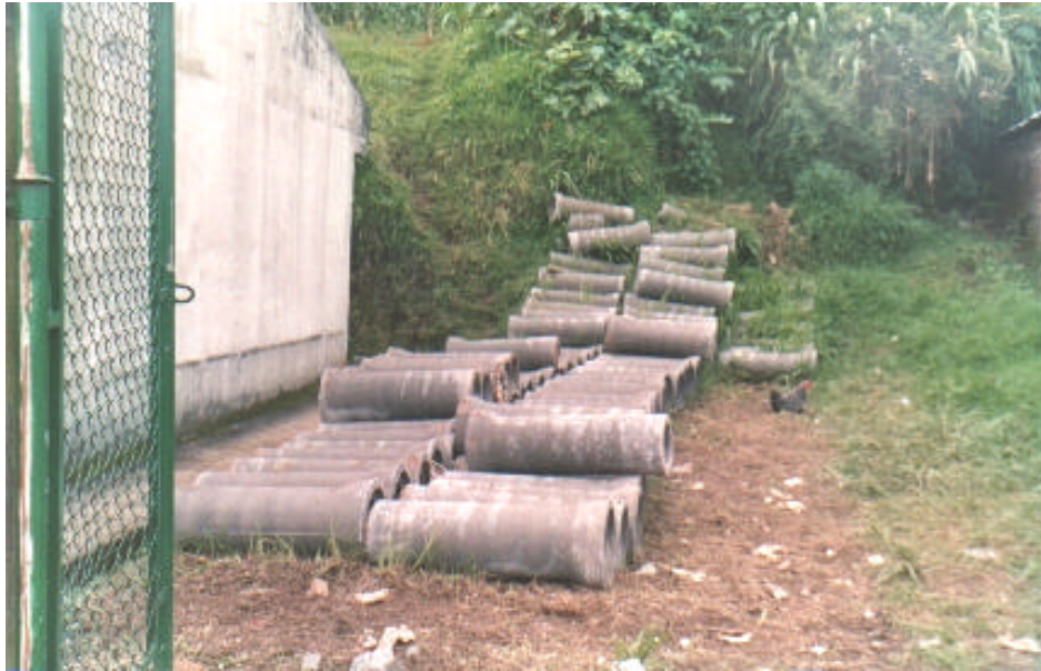
Figura 44. Almacenamiento de los tubos diámetro 8 pulg.
