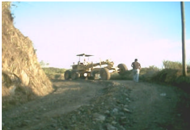
Figura 30. Motoniveladora reconformando la banca vía al Vergel.
