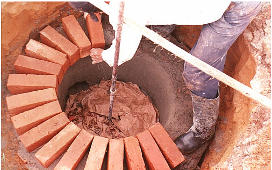
Figura 54. Pega de ladrillo tipo tizón en forma circular.
