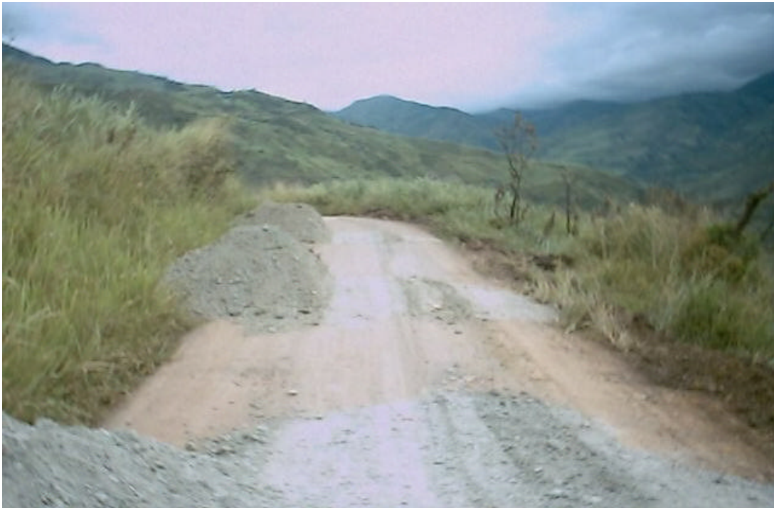
Figura 35. Acordonamiento de material sector El Vergel.
