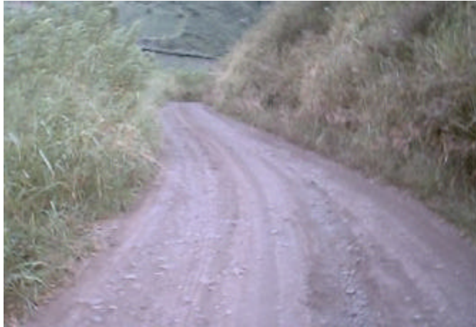
Figura 29. Perfilado de la banca vía a Bolívar.
