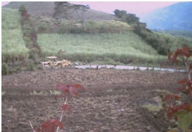
Figura 30. Motoniveladora reconformando la banca vía al Vergel.
