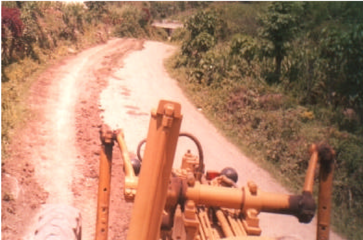
Figura 16. Tramos perfilados vía Alto Jiménez.
