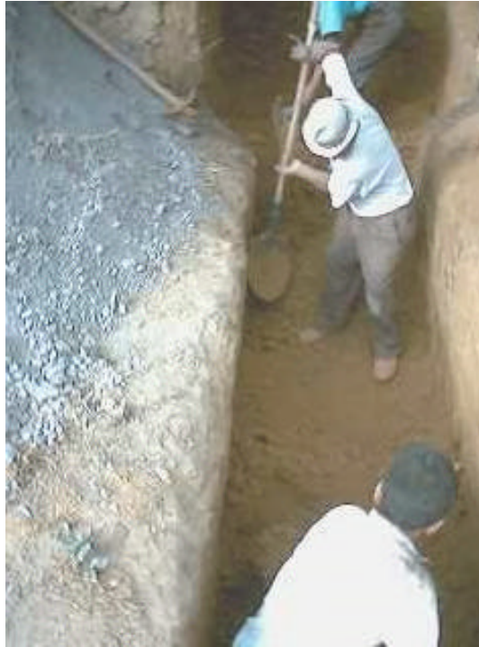
Figura 20. Relleno compactado en las paredes de la caja y colocación de recebo.
