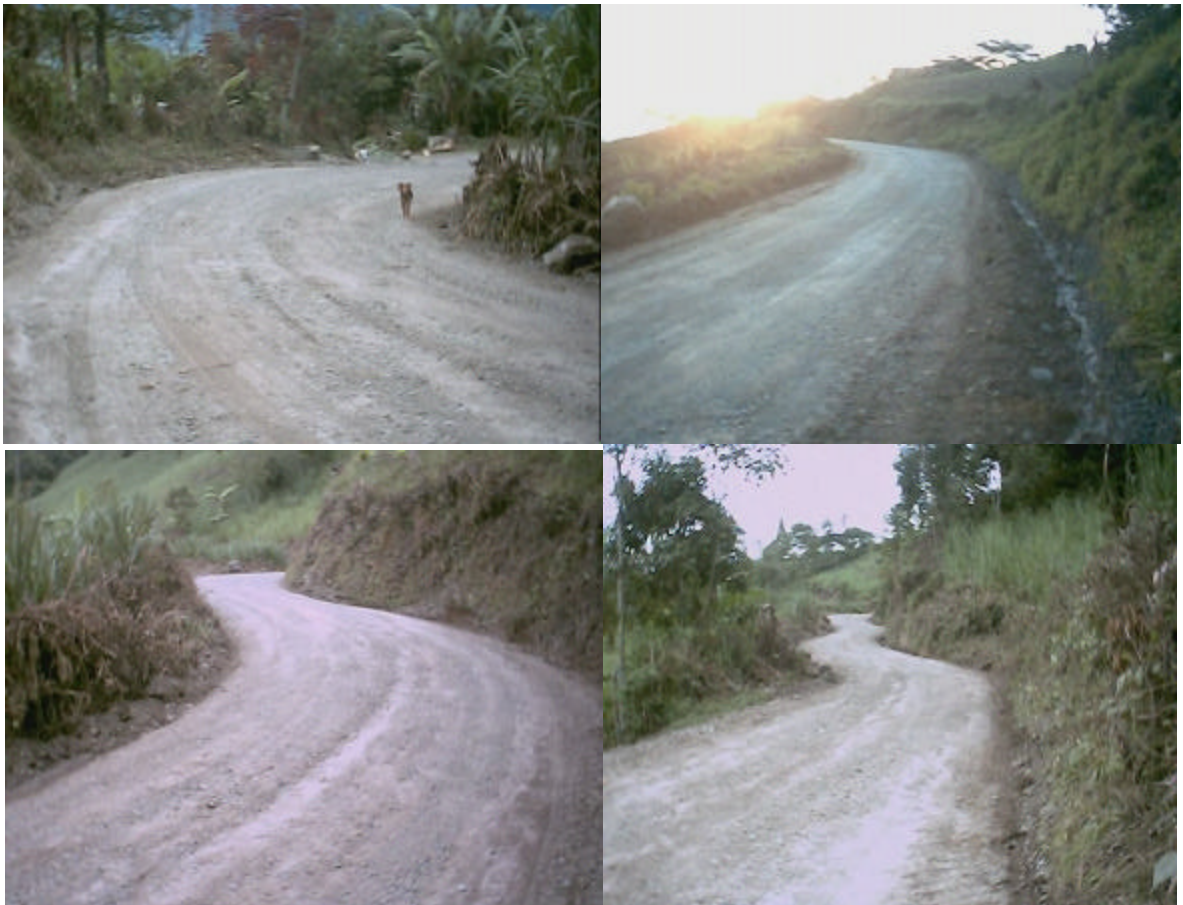
Figura 37. Material extendido uniformemente y compactado por el tráfico.
