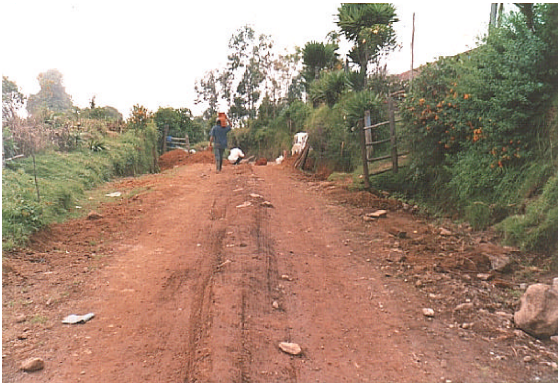
Figura 51. Chambas taponadas entre los pozos 34-35 vía principal.
