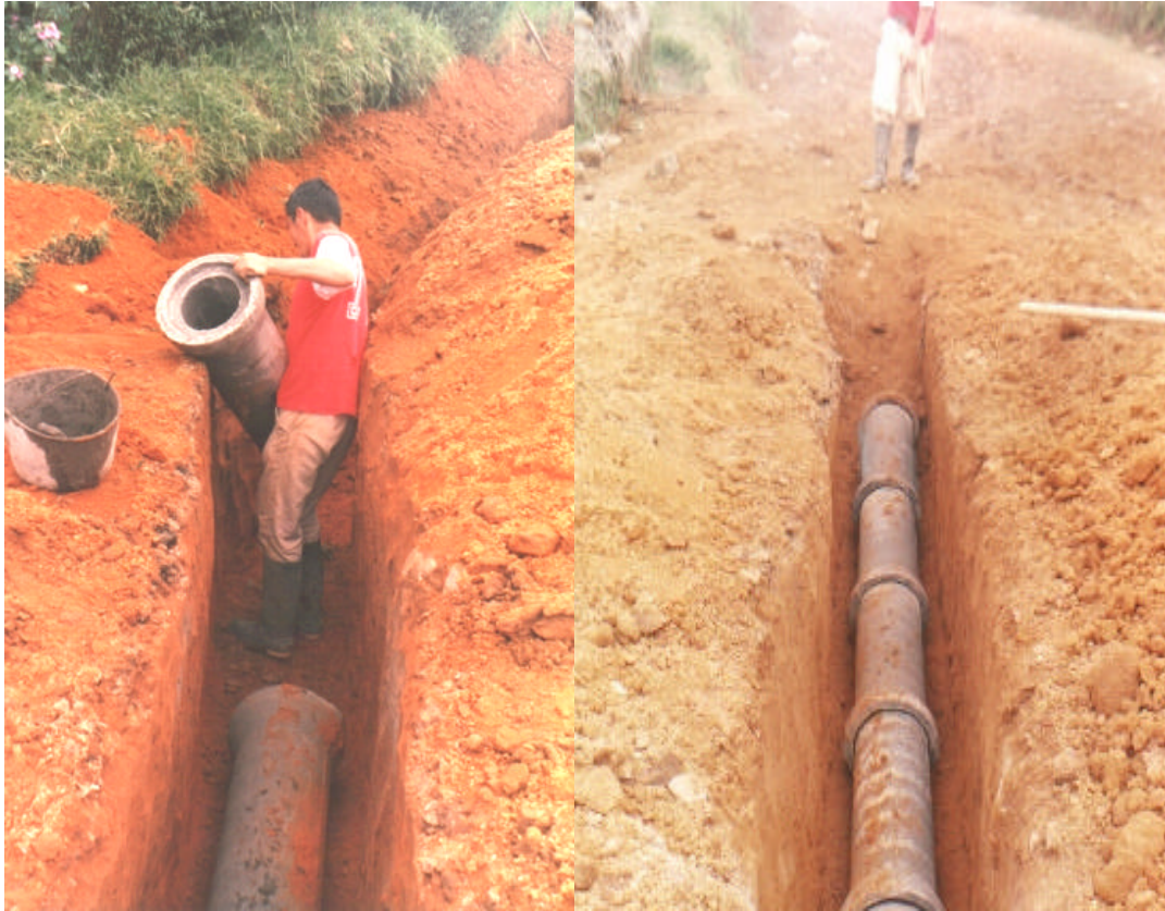
Figura 45. Bajada e instalación de la tubería diámetro 8 plg.
