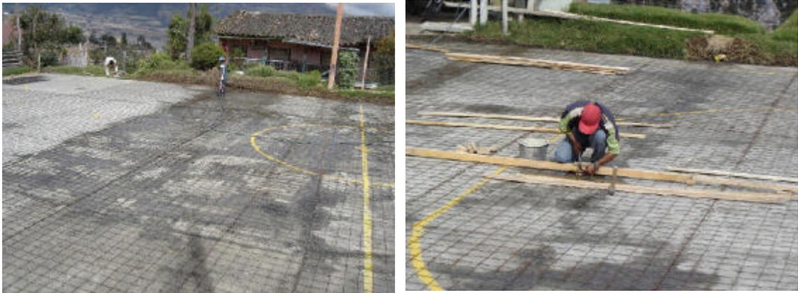
Una vez terminada la colocación de la malla electrosoldada, se procedió con la colocación de la formaleta de la cancha para la respectiva fundición. Por lo cual se la ubico en los extremos de la cancha para el espesor de la losa que es de 9 cms, como también dividiendo la cancha en 6 carriles de 3 mts de ancho y 33 mts de largo.
