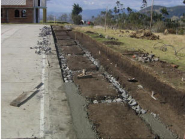
La parte interna de la gradería se recubrió con polisecc calibre 6 para proteger la mampostería de las gradas de la humedad de la tierra, posteriormente se relleno con material seleccionado el cual se lo compacto con una rana vibradora. La superficie exterior se recubrió con un pañete impermeabilizado para evitar la humedad en un futuro.
