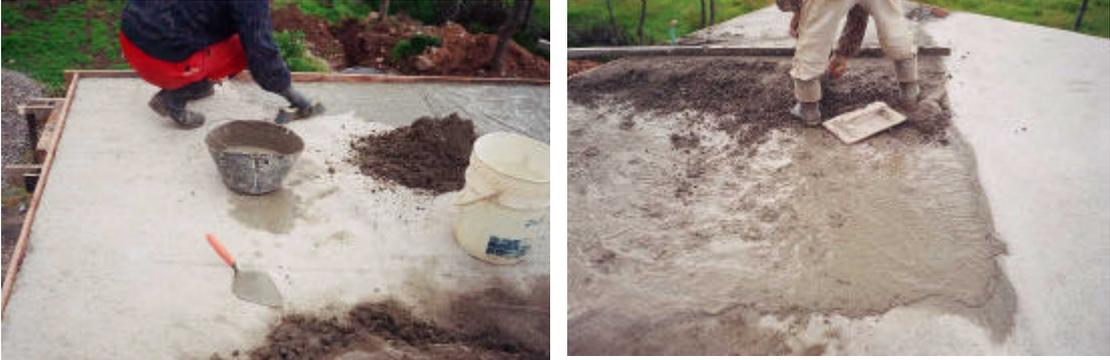
Figura 70. Detalle del bombeo Losa superior.
