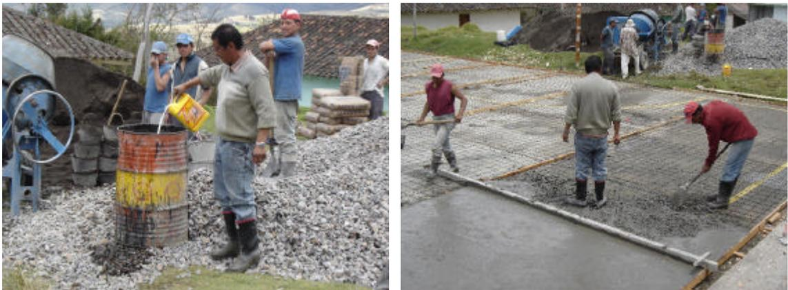
Debido a que la cancha presentaba varios desniveles en la placa existente, el espesor de la placa ya fundida varia en algunas partes, es decir en algunos paños el espesor máximo fue 15 cms y el mínimo fue 7 cms. Para los espesores mayores se compenso con la fundición de los espesores mínimos.
