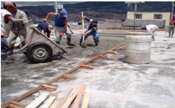
En la reparación de la cancha mixta no se colocó malla electrosoldada Calibre 5mm, por cuestiones de presupuesto así que se especificó por parte de la Interventoría hacer las juntas de dilatación a menor distancia y exactamente por encima de las antiguas juntas de dilatación de la losa existente, para evitar la fractura de la nueva placa de piso. La profundidad del corte son 3 cms.
