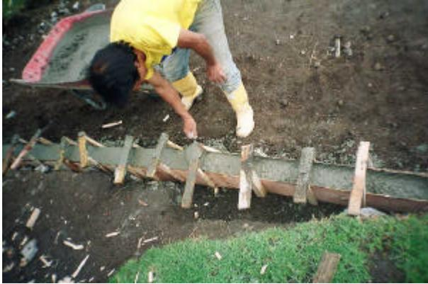
Una vez terminada de fundir la sobre placa y las cuentas se inicia con el curado del concreto para obtener una durabilidad optima, y una vida útil de placa representativa Finalizada la reparación de la losa, se comienza con la excavación manual para el muro de protección, finalizada esta labor se funde el cimiento del muro en concreto ciclópeo de 0.46 de ancho y 18 mts de largo.
