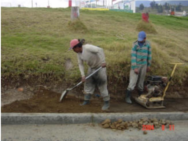
Una vez compactado la base en recebo seleccionado para los andenes se deja reposar y se inicia con él descapote y nivelación para la construcción de la cancha de voleibol. Aquí se pudo observar que la base en material común tenía una humedad considerable, así que se tomó una muestra de la base para el laboratorista de suelos y nos diga si se puede excavar más de los 18 cms especificados.
