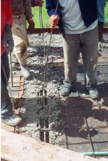
A los cuatro días después de la fundición se inicia con la impermeabilización de la parte superior de la losa con Sika 1 que es un impermeabilizante líquido. Para este proceso se preparan tres dosificaciones, una con cemento puro la segunda con mortero 1:1 y la tercera con mortero 1:3.
