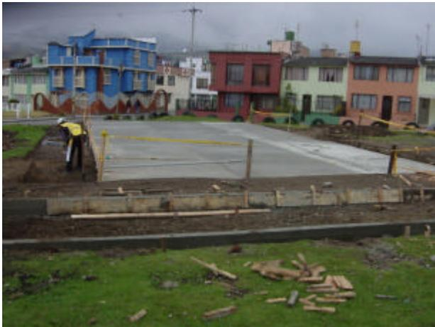
Se coloca la formaleta para la fundición del sardinel en concreto 1:2:3 de 3000 Psi para el sendero en adoquín. Se coloca dos varillas de 1/4" y un fleje de 3/8" en forma de "S" cada 20 cms.
