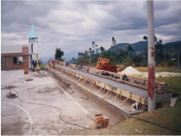
Terminado el relleno con el respectivo recubrimiento se funde una placa de concreto de 2500 Psi con una dosificación 1:2:3, la placa de concreto tiene un espesor de 10 cms. Finalizada la fundición se procede con el curado del concreto para obtener una durabilidad óptima. Por ultimo se da un acabado superficial con mortero 1:3 refinado para darle un aspecto más armonioso.
