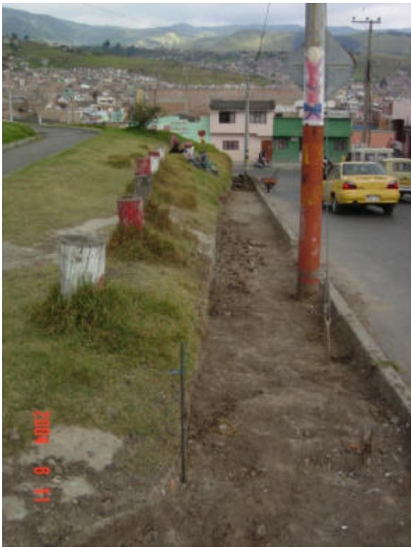
Terminada las labores de excavación como el desalojo del material sobrante, se riega el recebo previamente escogido y seleccionado el cual se humedece para su respectiva compactación, se contrata una rana vibradora y se comienza compactar el recebo seleccionado hasta obtener 10 cms de espesor, seguidamente se hace el muestreo del recebo con el fin de realizar el Proctor modificado para encontrar la humedad optima de compactación (Ver Anexo F. Proctor modificado).
