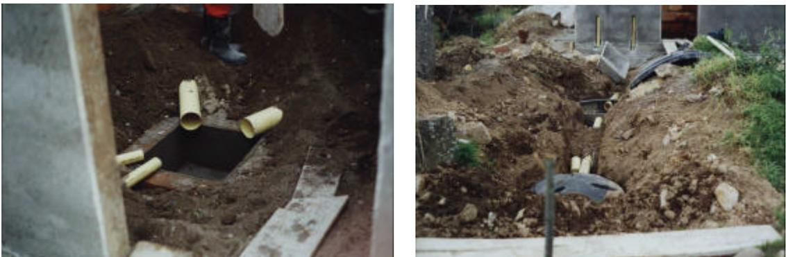
Concluida la compactación de la base y la ubicación de la tubería sanitaria pvc, se fundió la placa de piso en concreto de 3000 PSI con una dosificación de 1:2:3 con un espesor de 7 cms, el cual se nivelo correctamente.
