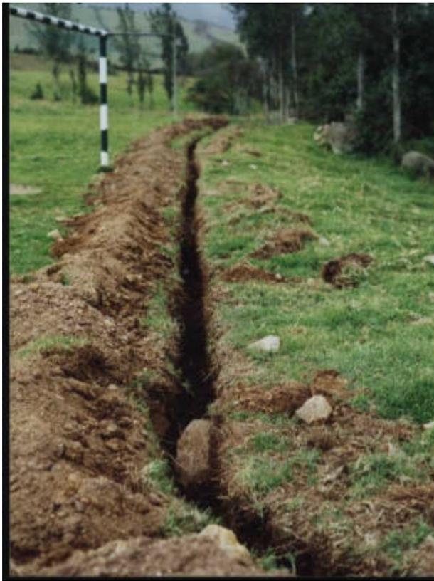
Se mejora la cimentación de la zapata excavando 20 cms mas y rellenando con material de rebebo y cemento, el cual se humedecido y se compacta con pisones de concreto. Después de la compactación de la base, se coloca varillas de diámetro ½” distribuidas en las dos direcciones amarradas cada 15 cms. A estas varillas de ½”, se amarran 4 varillas No 4 correspondientes al refuerzo de las columnas y flejes No 3 cada 15 cms.
