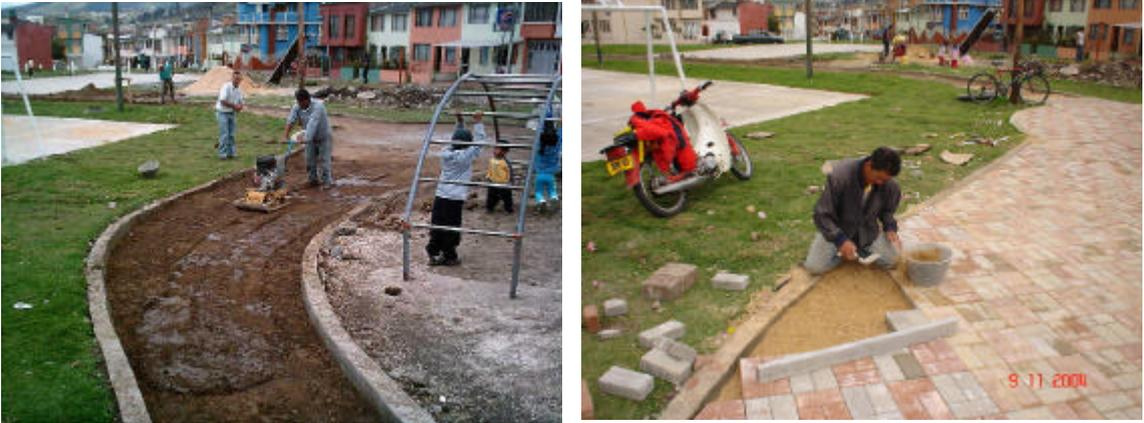
Finalizado el curado de la nueva placa de piso para la cancha mixta, se colocan las canchas multifuncionales sobre unas placas adicionales de 1 x 3 mts y de 10 cms de espesor que se fundieron en concreto 1:2:3 de 3000 Psi, como también se funde el cimiento de 0.60 x 30 mts en concreto ciclópeo con una altura de 10 cms para las gradería de la cancha mixta (Ver Anexo E. Detalle Canchas Multifuncionales).
