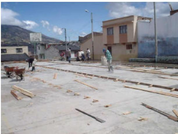
Igualmente se funde conjuntamente la viga de cimentación y la losa en concreto premezclado de 3000 Psi de Concesur. En la fundición de la placa se extiende el concreto saltando un paño, para su posterior extendido y nivelación como también su acabado final con plástico y al siguiente día se funde los paños restantes, nivelándolo asimismo para su posterior extendido y acabado final con plástico.
