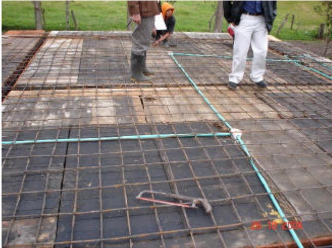
Finalizado el formateo, se coloca 4 varillas No 4 distribuidas en sus esquinas y flejes No 3 cada 15 cms para las vigas aéreas y sobre estas refuerzo 1 No 3 amarradas cada 0.15 mts formando una malla.
