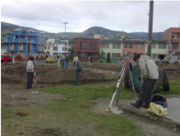
Finalizada la excavación, se nivela el terreno para la colocación y tendido del recebo previamente seleccionado, el cual se humedeció y se compactó en 2 capas de 5 cms cada una con un saltarín para obtener una mayor firmeza de la base. Posteriormente se hace el muestreo del recebo con el fin de realizar el Proctor modificado para encontrar la humedad óptima de compactación.
