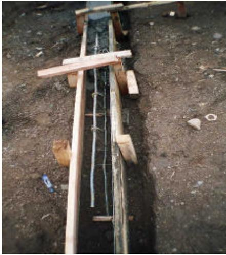
Para la reparación de la cancha existente se inicia la demolición de la placa de piso existente, se demolió todos paños de la cancha porque se encontraban en muy mal estado y una vez finalizada esta labor, se coloca la formaleta para la reparación de la cancha existente. Se divide la cancha en 12 paños de 2.5 x 15 mts y se coloca malla electrosoldada de 6 x 2.5 mts de calibre 5 mm por debajo de la formaleta transversal.
