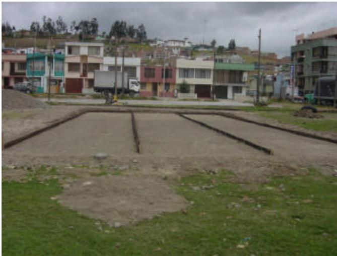
Terminada la compactación de las dos capas de recebo, se hacen dos apiques en los extremos de la cancha para realizar el ensayo de cono y arena. Una vez obtenidos los resultados el cual fueron del 96 y 97 por ciento, se autoriza al ingeniero contratista la fundición de la placa de piso de 8 cms de espesor, así que se coloca la formaleta dividiendo la cancha en tres paños para la previa fundición.
