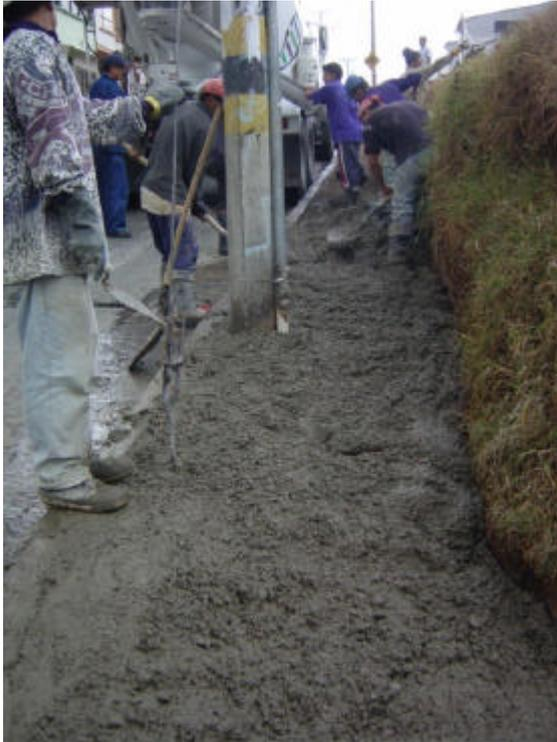
Tan pronto se termina la fundición de los paños de la placa, se espera que se endurezca el concreto y se comienza con el curado. El Curado es muy importante ya que ayuda al concreto obtenga altas resistencias, aumentando la vida útil de la obra obteniendo una durabilidad óptima.
