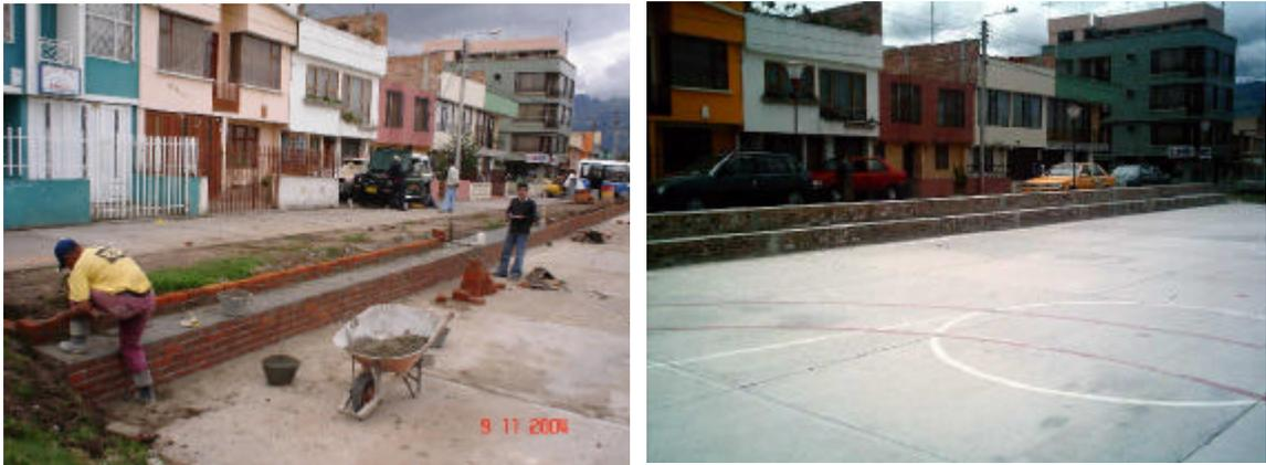
Se instalan las mallas de protección calibre 10 de a lo largo del muro de concreto ciclópeo, el cual se utilizo ángulo de 1/2" x 1/2" x 3/16" alrededor de la malla para dar un mayor firmeza estas se soldaron a los tubos de 2" tipo pesado que se anclaron al muro colocaron cada 3 metros además se utilizo pintura esmalte con previa aplicación de anticorrosivo.
