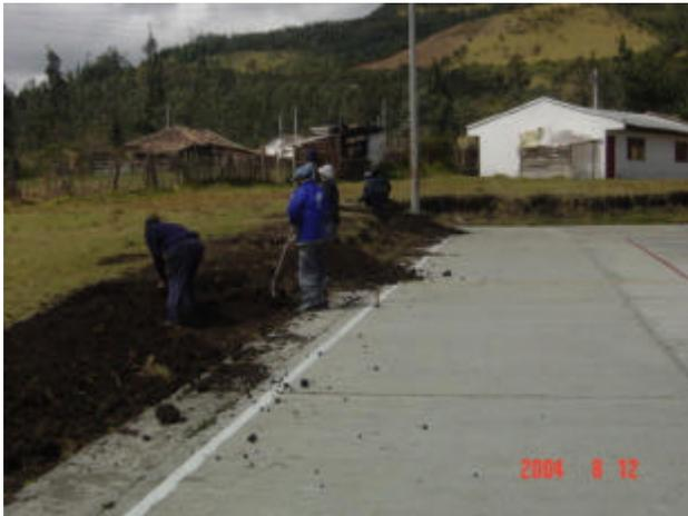
Terminada la actividad de excavación, se inicia con la cimentación de la gradería en concreto ciclópeo clase G de 30 x 30 cm, en donde se utilizó concreto simple de 2800 PSI en una proporción equivalente al 60% del volumen total, complementando con un 40% de piedra rajón. Los apoyos se hicieron en tizón y las contrahuellas en sogá.
