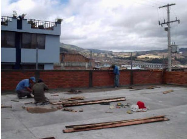
Por ultimo se coloca la formaleta para la reparación de la cancha de baloncesto en concreto premezclado de 3000 Psi de Concrecur. Se divide la cancha en cuatro paños. En la fundición de la placa se extiende el concreto saltando un paño, para su posterior extendido y nivelación como también su acabado final con plástico y al siguiente día se funde los paños restantes, nivelándolo asimismo para su posterior extendido y acabado final con plástico.
