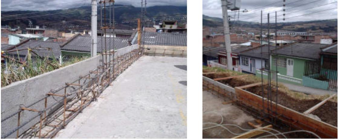
Se coloca la formaleta tanto para las vigas de cimentación como para la cancha mixta para su respectiva reparación de la losa. Para esta labor se utiliza listones de 10 y 7 cm y estacas, los listones de 10 cms irán en forma longitudinal y los de 8 cm en forma transversal, apoyados con cuadrados de madera clavados en la losa. Se dividió la cancha en cinco paños de 2.4 mts de ancho y 32 mts de largo.
