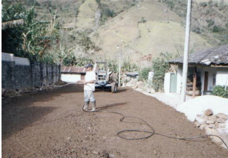
Una vez que el material de la base tuvo la humedad apropiada, se conformó y compactó con el equipo apropiado, se trabajó con un espesor de base promedio de 20 cm. El cual fue controlado con repetidas mediciones como se indica en la figura 72. Medición espesor de base
