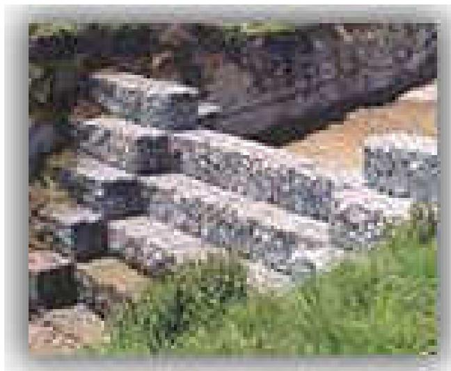
El Gavión está hecho de malla de triple torsión y escuadra tipo 8x10, formada de alambre con tres capas de galvanizado con 270 gr de Zinc, calibre 12 (2.7mm) reforzado en las aristas con alambre calibre 10 (3.4mm) y alambre de amarre calibre 13.5 (2.2mm). Todos estos elaborados con acero de bajo carbón.
