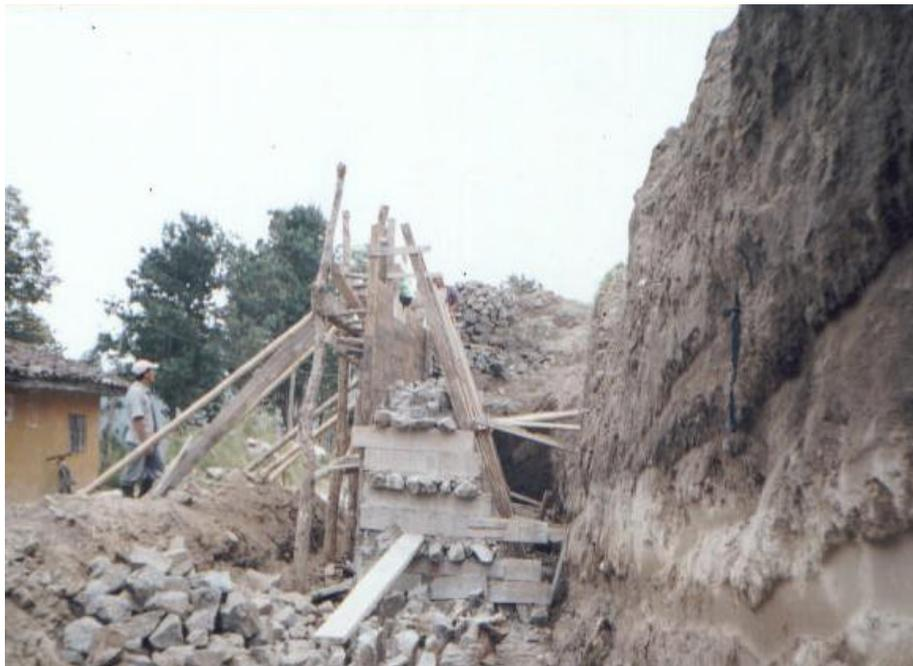
Terminada la construcción del muro hasta la corona, donde unos centímetros antes se debía anclar las varillas de hierro para la posterior fundición de columnetas, se continuaba avanzando longitudinalmente con otro tramo de 6 metros como se indica en la figura 108. Avance construcción del muro
