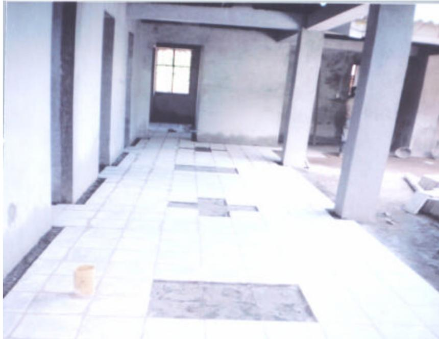
Después de haber colocado toda la cerámica en los tres bloques, se procedió a construir las Guardaescobas y a rellenar los espacios, ambos en granito para luego pulir tanto el granito como la cerámica como se indica en la Figura 16. Pulida de Pisos
