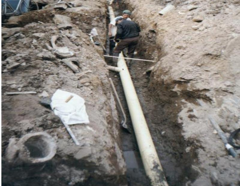
Se utilizó tubería de pvc (NOVAFOR) de diámetro 8 pulgadas para los colectores y Pvc lisa de diámetro 4 pulgadas para las acometidas domiciliarias. De igual forma se utilizó el KIT SILLA YEE 200 x 110 mm para la instalación de la acometida al colector.
