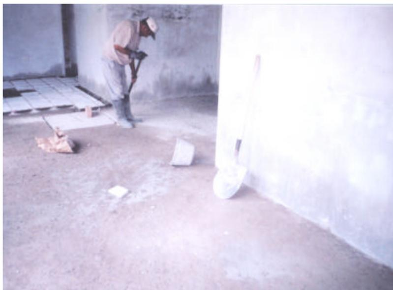
La cerámica se colocó dejando ciertos espacios en la parte céntrica en forma de figuras geométricas y en las orillas a la pared para las Guardaescobas como se indica en la Figura 15. Colocación de la cerámica, para luego rellenar estos espacios con granito
