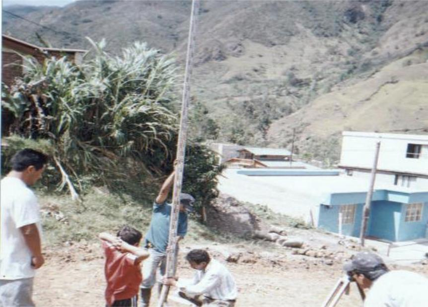
**Figura 66. Excavación para cambio tubería alcantarillado**
