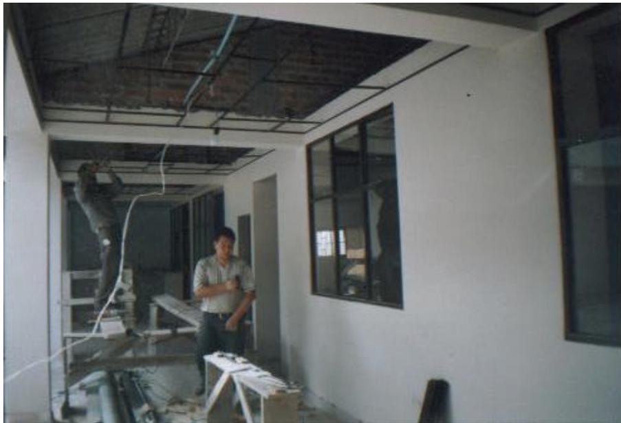
**6.1.2.11 Instalación de vidrios y pintura general.** Se colocaron vidrios lisos de espesor 4 mm, en las ventanas y vidrios esmerilados de 4 mm en las lucetas de las puertas metálicas. En cuanto a la pintura, se pintó las paredes exteriores con vinilo tipo 1, dos manos y las paredes internas con la misma pintura pero para
