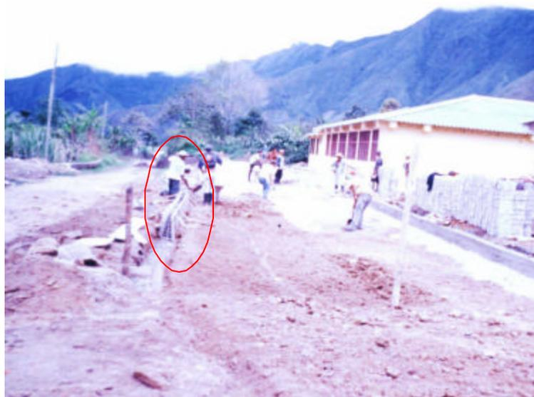
Los confinamientos transversales deben tener 150 mm de ancho, penetrar, al menos, 150 mm en la base, con juntas cada 1,5 m como máximo, y con oídos de 12 mm de diámetro cada 400 mm, protegidos con un parche de geotextil no tejido. Estos oídos se deben construir en las estructuras de drenaje como sumideros, cárcamos transversales, cámaras de inspección, etc., y en los confinamientos transversales medio de pavimentos de adoquines, en especial en pendientes
