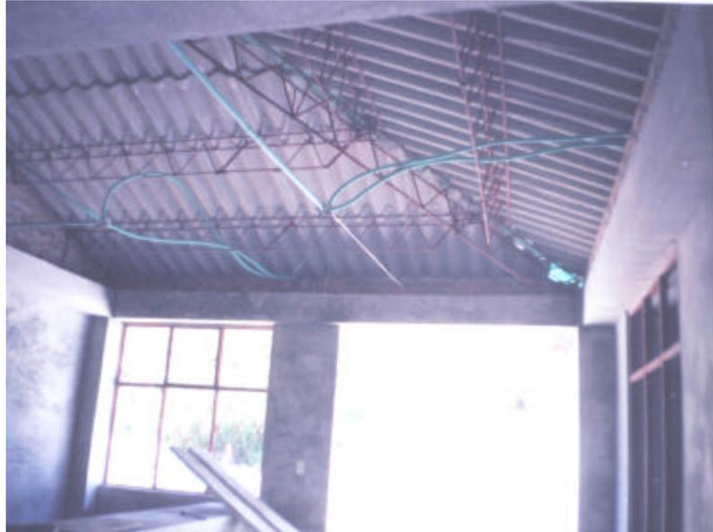
La cubierta se colocó posteriormente, la cual desde su inicio se construyó a cuatro aguas, se utilizó teja de Eternit 10 y 8 (Figura 13. Colocación tejas de eternit), caballetes en el mismo material y canal recolector de aguas lluvias en pvc
