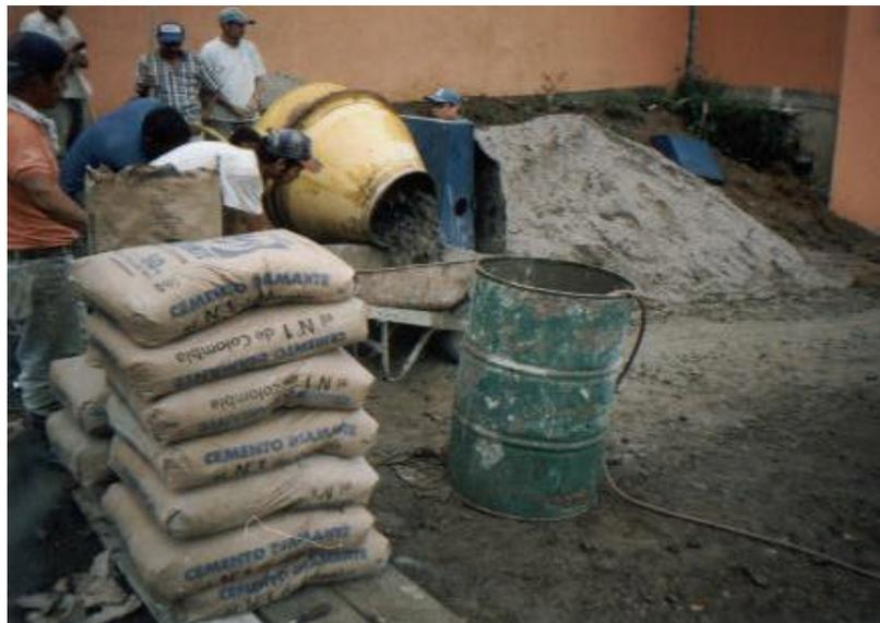
Los materiales utilizados como arena y triturado fueron de la región, de las canteras del Guabo, y el cemento de marca conquistador y diamante. La mezcla se realizó con proporciones 1:2:3, se controló el contenido de agua a emplear por medio del “slump” en donde se utilizó el cono de Abrams.
