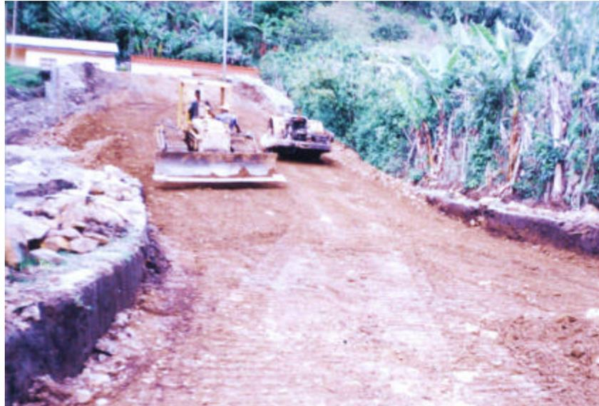
La compactación se realizó con un cilindro vibrocompactador indicado en la figura anterior, y halado por el buldózer
