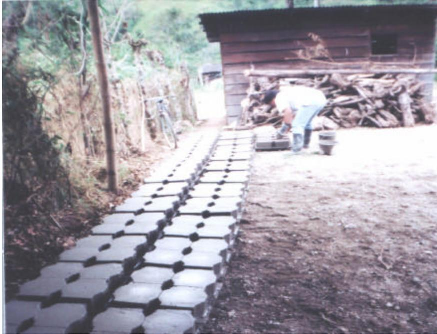
La resistencia mecánica no es el requisito más alto que deben cumplir los adoquines de concreto pues las cargas corrientes son las de llantas, que no superan 1 MPa (10 kgf/cm<sup>2</sup>). Estructuralmente las unidades trabajan casi que a compresión simple
