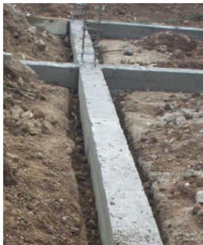
?? Se funde el concreto ciclópeo para cimentación 0.3\*0.3 concreto 1:3:4 60% y 40% Rajón en una cantidad de 10.78 mts cúbicos, se revisa constantemente las dosificaciones que estaban siendo utilizadas
