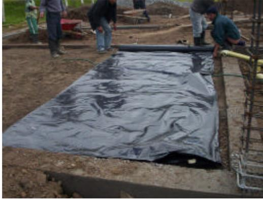
?? Fundición de zapatas en concreto 1:2:3 de 3000 P.S.I con refuerzo especificado en planos estructurales facilitados por la secretaria de obras, la labor de la interventoría en este ítem fue fundamental ya que antes de autorizar la fundición, se reviso en todas las zapatas sus medidas como así también la distribución de sus refuerzos; las dimensiones y el numero de unidades se detallan a continuación.
