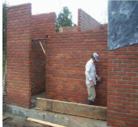
?? Una vez levantados los muros hasta una altura de 3 metros que es la altura que debían tener las columnas se comenzaron a fundir estas.
