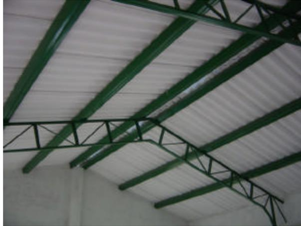
?? Al tener instalada toda la estructura metálica se procedió a la colocación de la cubierta, en este proceso se tuvo inconvenientes por el suministro de materiales lo cual retraso la obra una semana.
