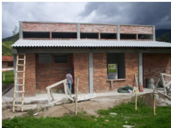
?? Ya teniendo una cubierta para proteger el interior del salón se continua con la terminación de los acabados como son pisos, baños y colocación de puertas y ventanas.
