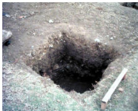
**Figura 3. Excavación para vigas de cimentación.**
