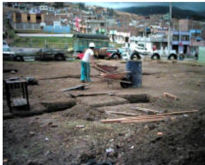
?? Base en recebo compactado en una cantidad de 40 mts cúbicos, esta compactación se trabajo con vibrocompactador operado por un obrero.
