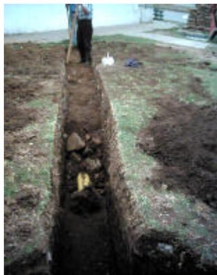
**Figura 2. Excavación para zapatas**
