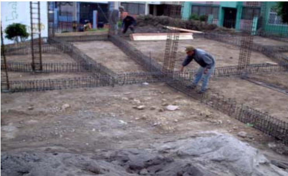
**Figura 35. Armado de la formaleta de soporte de las vigas de cimentación, curado de piso para su respectiva fundición y ubicación de los bajantes de aguas lluvias; tubería PVC DE 3 pulgadas.**
