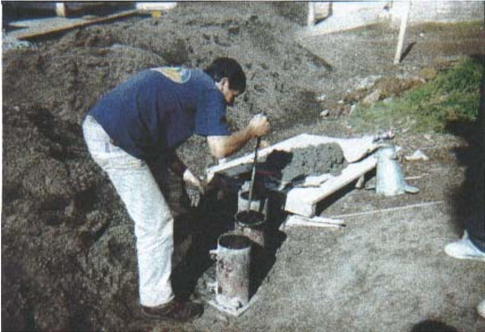
**Figura 14. Colocación de pasadores en junta transversal**
