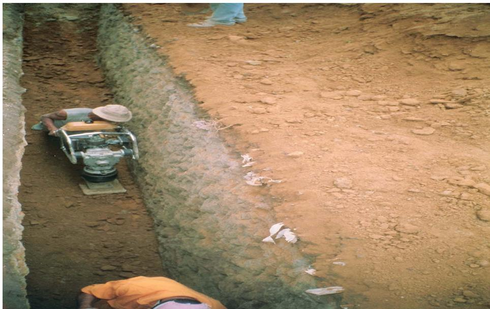
**Figura 5. Construcción y revestimiento de pozos de Inspección donde se conecta la tubería de 8 y 10 pulgadas**
