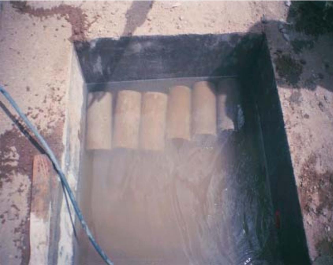
**Figura 31. Formaleteado y fundición de pedestales y zapatas de 1x1x0.30 m**
