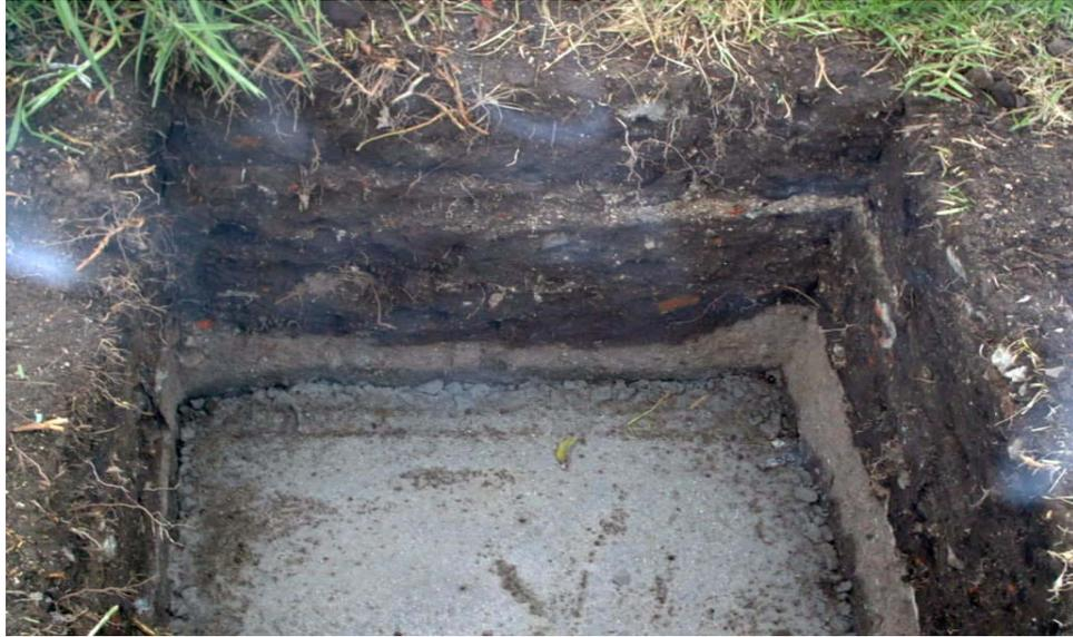
**Figura 26. Armado de la formaleta de soporte de las columnas**
