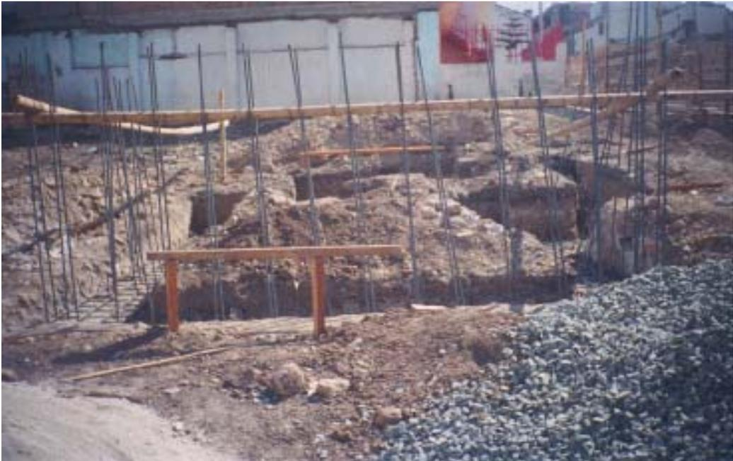
**Figura 49. Armado de hierros para la fundición de los muros en concreto reforzado a la vista 3000 PSI e=20 Cm.**
