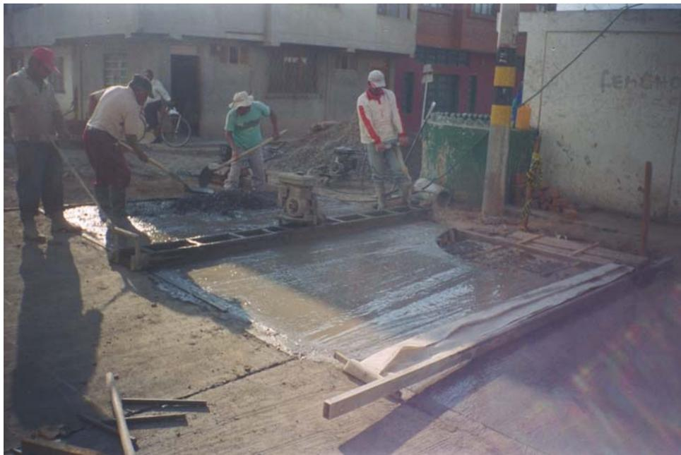
**Figura 16. Acodalamiento para enrasar la superficie del pavimento y pasado de la lona para terminado.**
