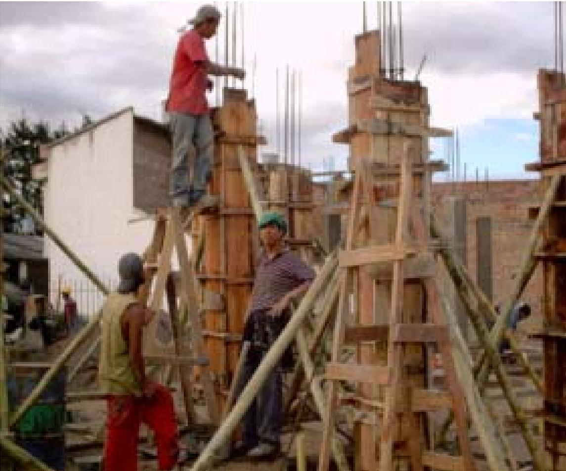
**Figura 38. Fundición de las columnas y varillado, para una distribución homogénea de la mezcla.**
