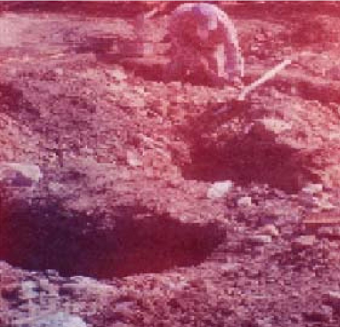
**Figura 47. solado de zapatas y vigas de amarre (concreto de 2000 PSI), con el fin de proteger el concreto de agentes externos.**
