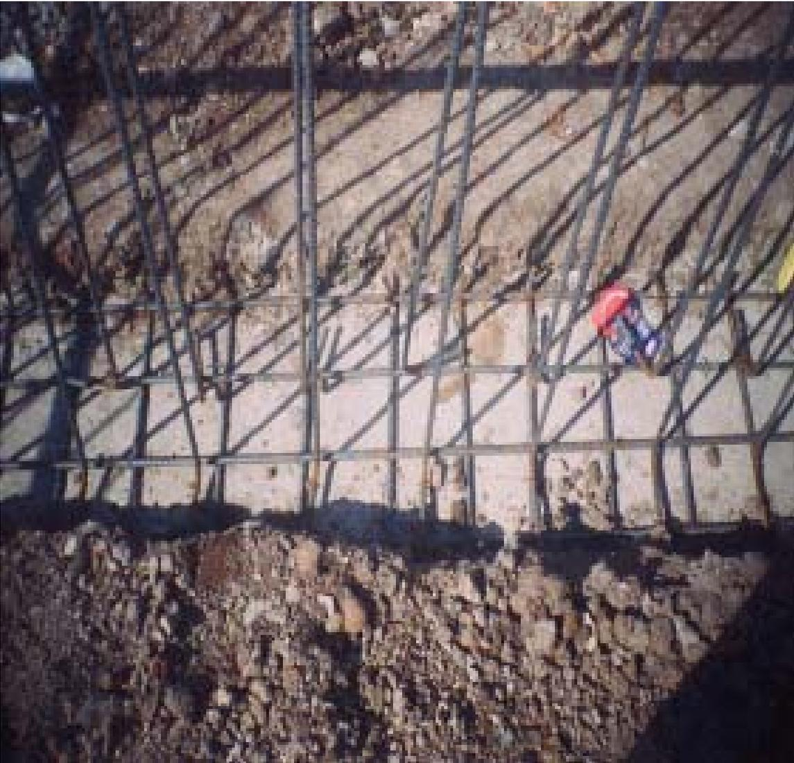
**Figura 48. Corte, figuración, amarre y colocación del refuerzo, varillas de  $\frac{1}{2}$ ,  $\frac{5}{8}$  y  $\frac{3}{8}$  de pulgada y alambre negro No. 18 para el amarre; según las indicaciones que contienen los planos estructurales.**
