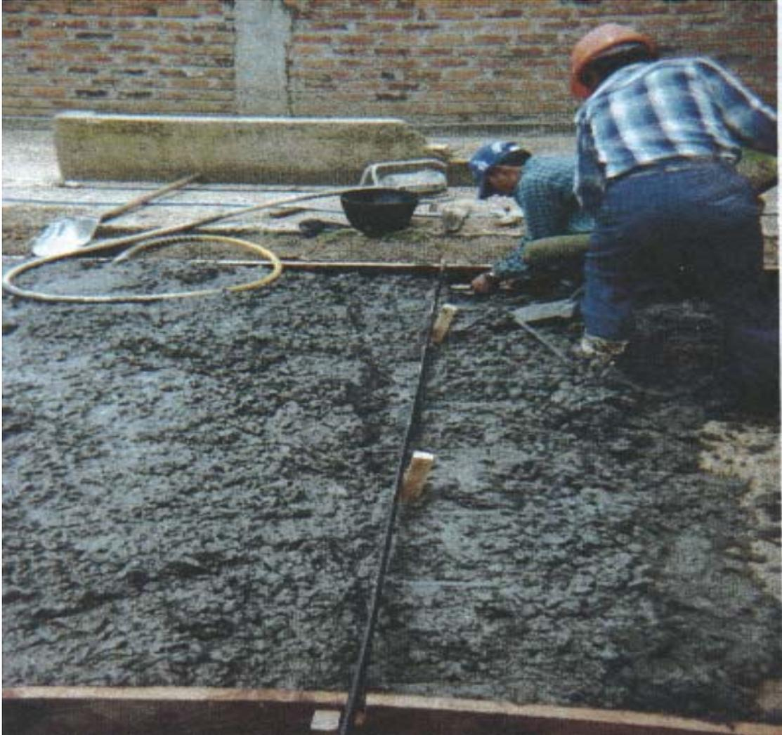
**Figura 15. Utilización de vibrador de aguja y regla vibratoria en la fundición del pavimento para su respectiva distribución y compactación**
