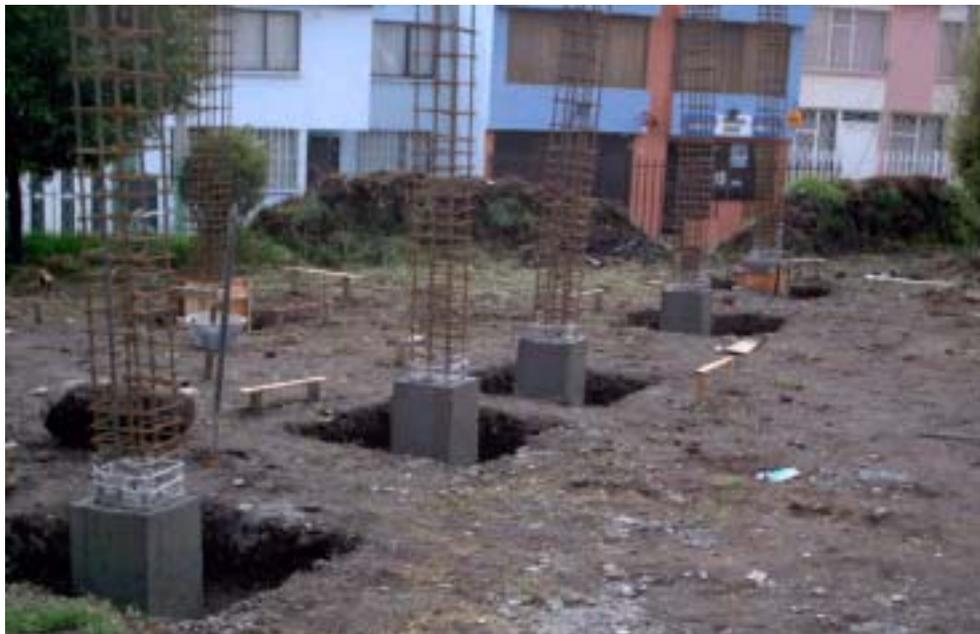
**Figura 33. Relleno y nivelado de zapatas y pedestales con material seleccionado y apisonado con pisón de mano en capas de aproximadamente 15 cm.**
