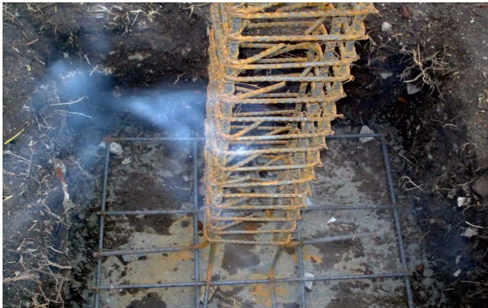
**Figura 27. Armado de columnas de 0.30 x 0.30 m, llevan 2 varillas de  $\frac{1}{2}$ , 4 de  $\frac{5}{8}$  distribuidas en sus esquinas y flejes  $\frac{3}{8}$  de pulgada distribuidos según despiece de planos estructurales.**
