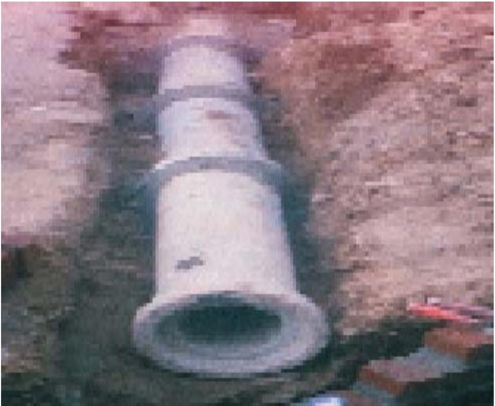
**Figura 4. Relleno de las zanjas del alcantarillado pluvial; con material seleccionado y compactado con saltarín y pisón de mano en capas de 0.15 m. Aproximadamente, para lograr una compactación uniforme.**
