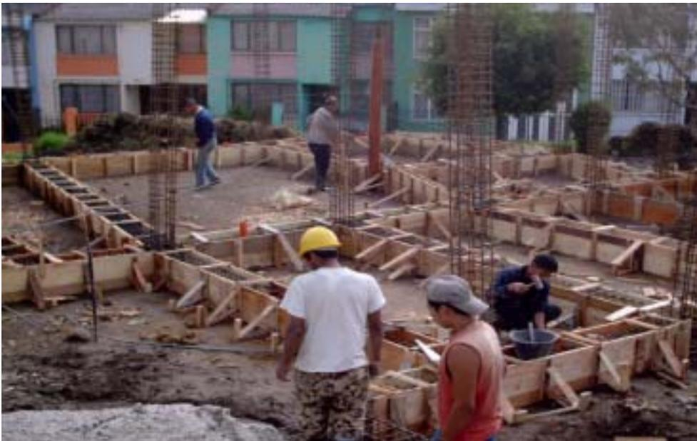
Figura 36. Fundición de las Vigas de cimentación concreto 1:2:3.
