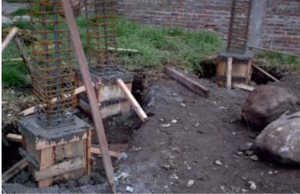
**Figura 32. Pedestales y zapatas fundidas concreto 1:2:3**
