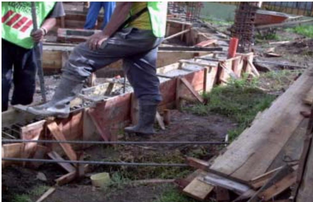
**Figura 37. Armado y entibado de las formaletas de soporte para la fundición de columnas de 0.30x0.30 m.**
