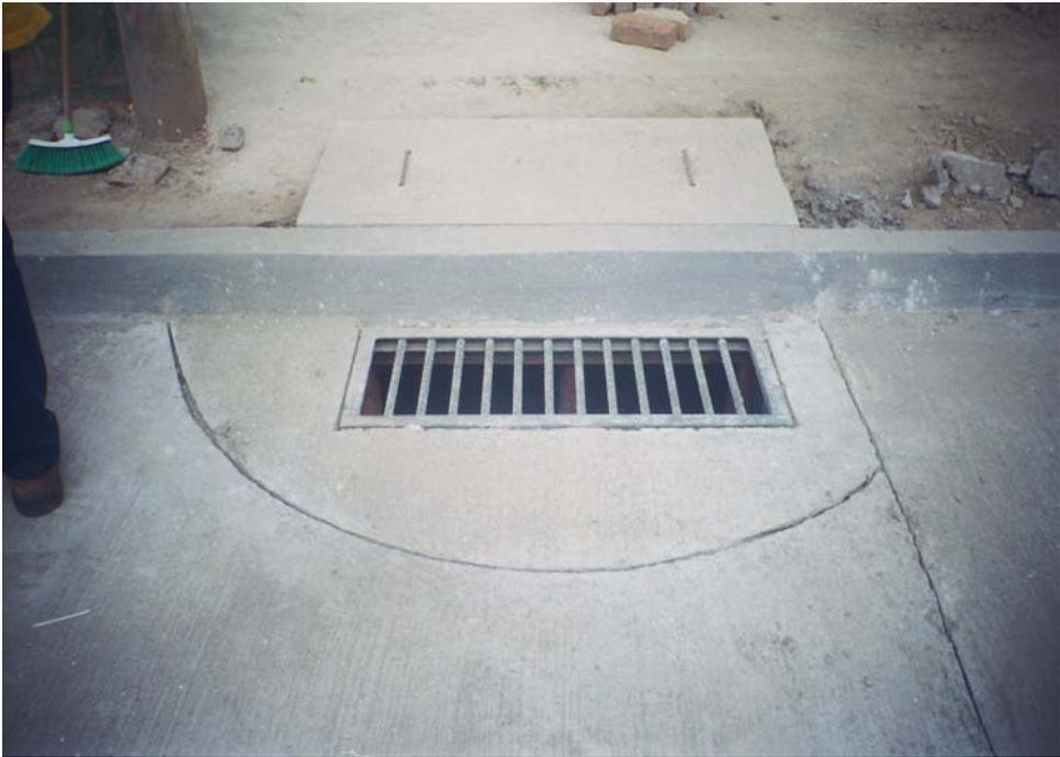
**Figura 23. Limpieza, relleno con arena y perfilado con asfalto liquido de las juntas**
