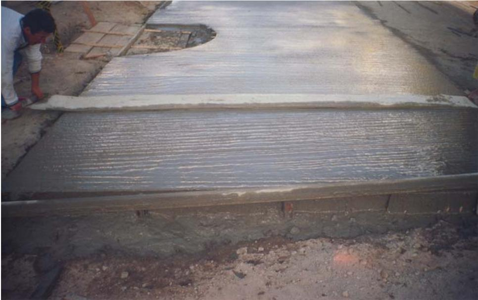
**Figura 17. Rizado final del pavimento**
