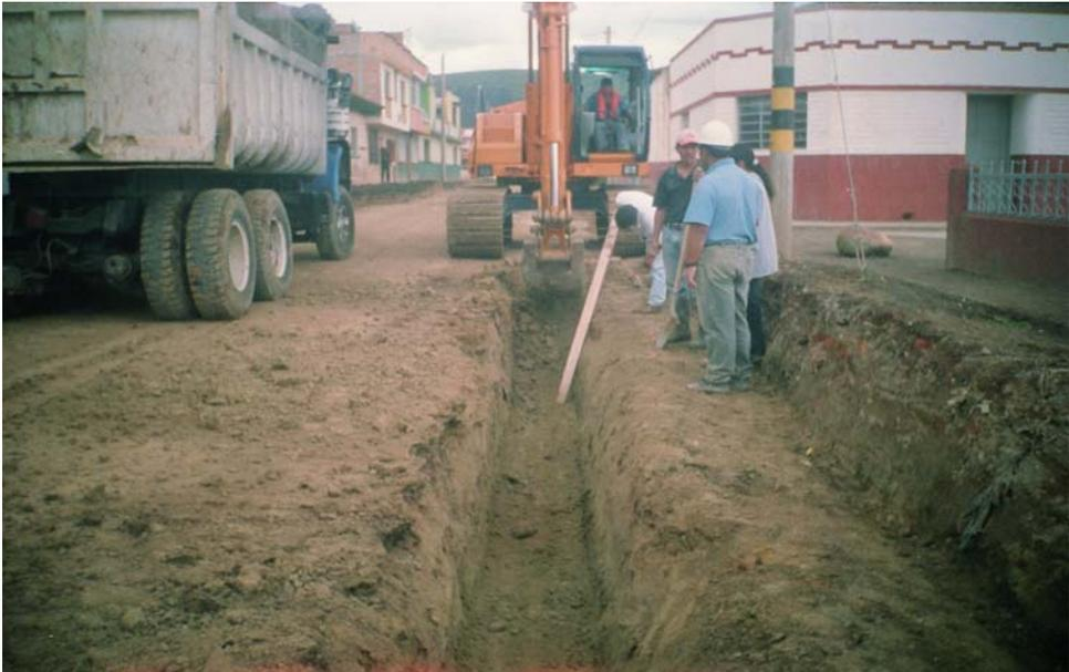
**Figura 3. Colocación del alcantarillado pluvial tubería de 10 pulgadas y 8 pulgadas para la conexión de sumideros**
