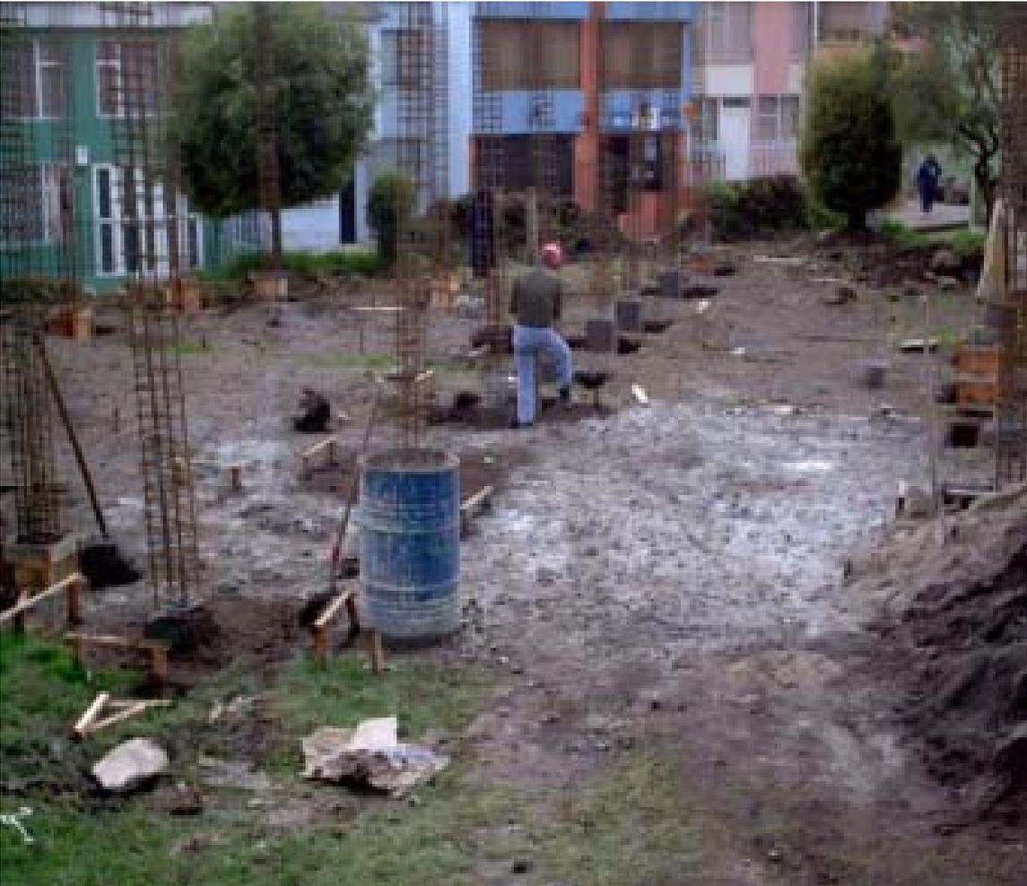
**Figura 34. Armado de las vigas de cimentación de 0.30x0.30, de 0.30x0.35 y de 0.30x0.42 m, llevan 4 varillas de 5/8 de pulgada, distribuidas en sus esquinas y flejes de 3/8 de pulgada.**
