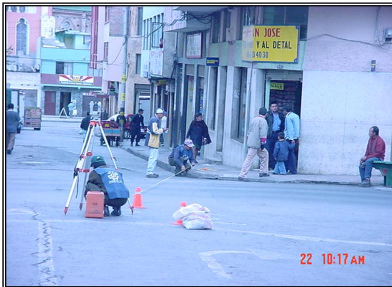
Figura 7. Personal Empopasto realizando levantamiento de redes de acueducto y alcantarillado ( calle19 con carrera 21)
