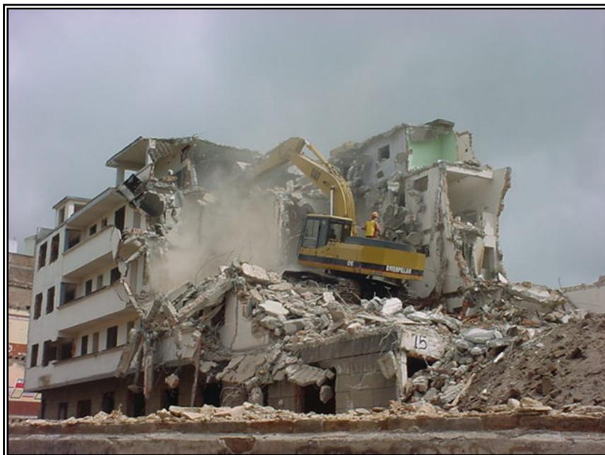
Figura 45. Demolición por colapso
