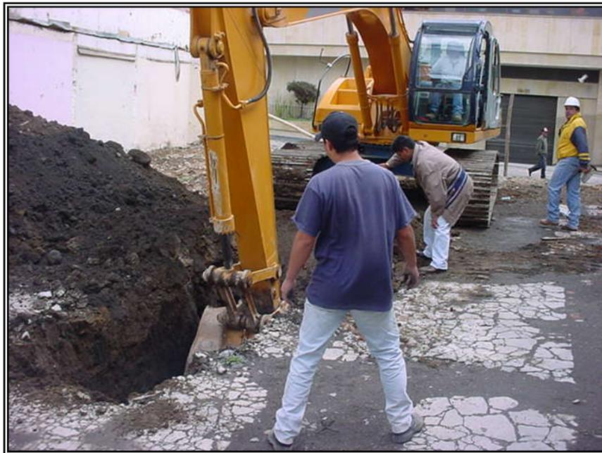
Figura 62. Utilización de maquinaria para realización de apiques
