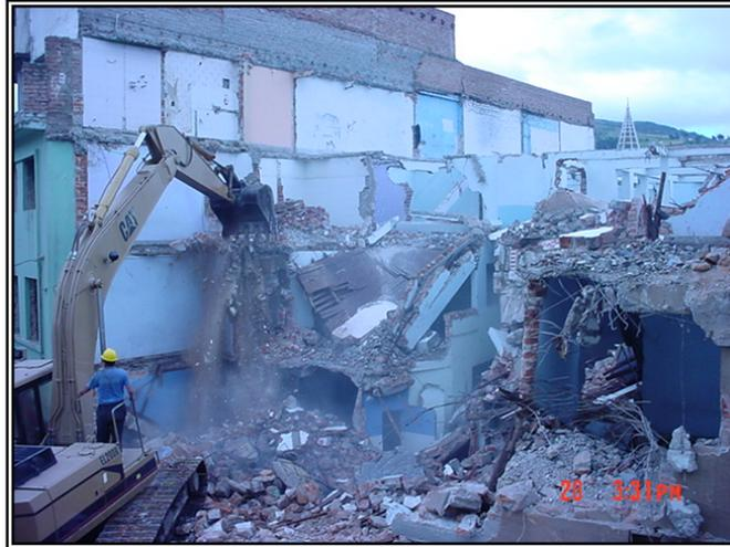
Figura 36. Derribo de muros con retroexcavadora
