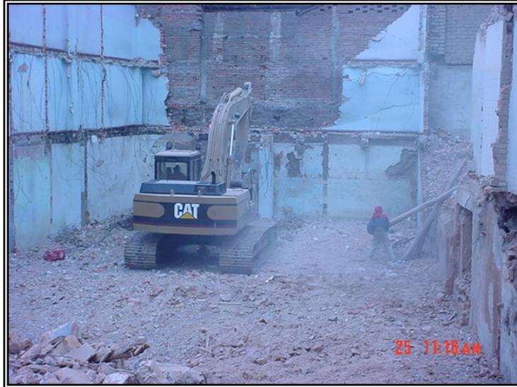
Figura 32. Demolición con retroexcavadora
