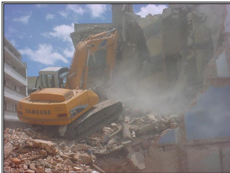
Figuras 37 y 38. Demolición con retroexcavadora:
