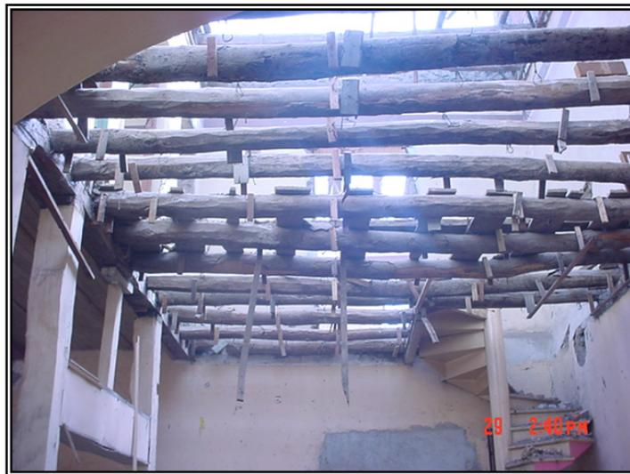
Figura 22. Demolición elemento a elemento (Casa Bravo, sector 20 de julio)
