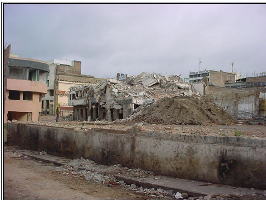
Figura 47. Pisos 3, 4 y 5 demolidos
