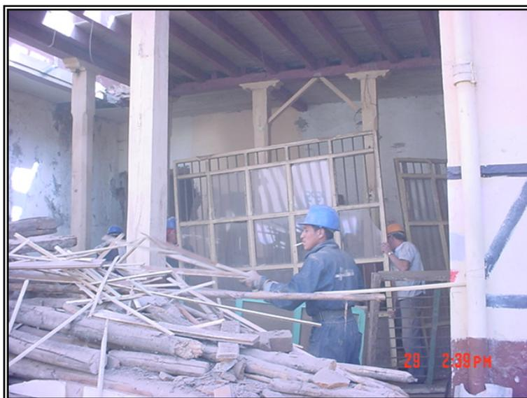
Figura 31. Materiales recuperables en el proceso de demolición
