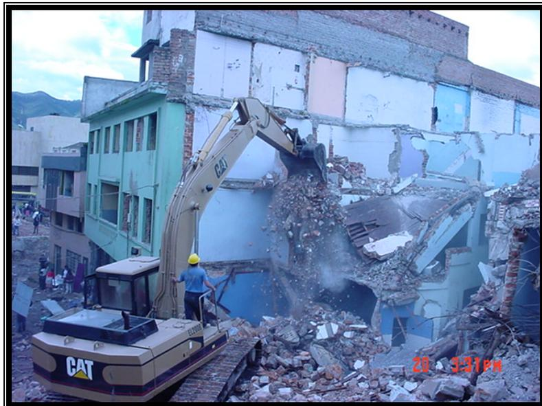
Figura 20. Demolición de edificaciones sector 20 de julio
