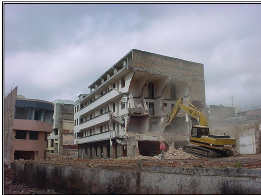
Figura 43. Demolición pisos 1, 2 y 3
