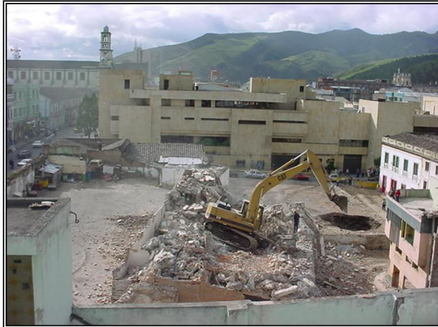
Figura 52. Demolición primer piso
