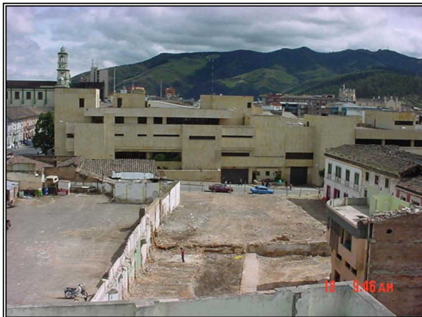
Figura 53: Superficie demolida y libre de escombros
