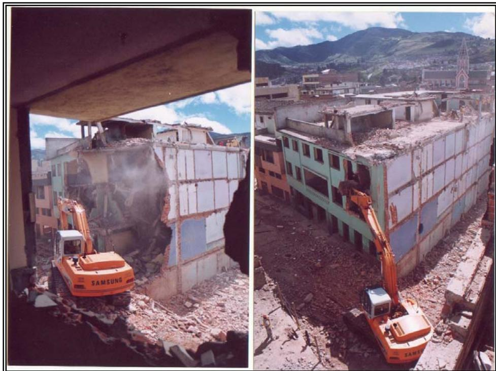
Figura 23 y 24. Demolición con retroexcavadora (Hotel Palermo, sector 20 de julio)
