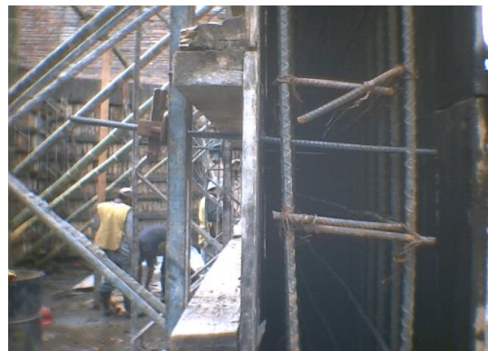
Figura 46. Fijación de la formaleta mediante las chapolas
