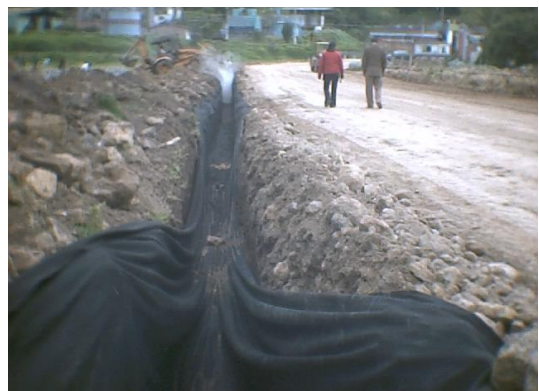
Figura 118. Colocación del geotextil sobre las zanjas del filtro
