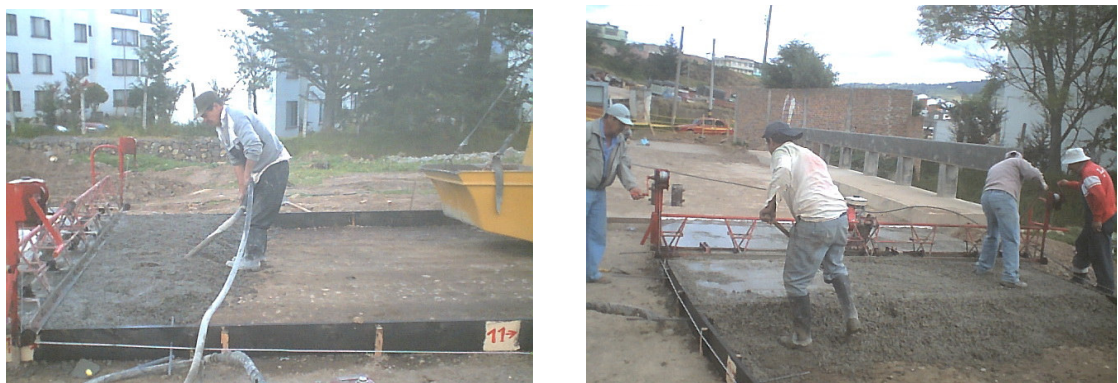
Figura 147. Compactación o vibrado del concreto
