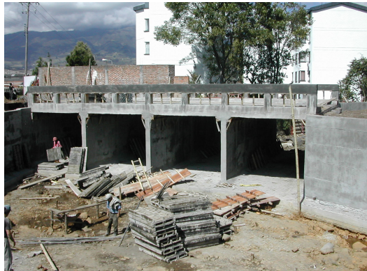
Figura 83. Estructura del box culvert completamente desencofrada
