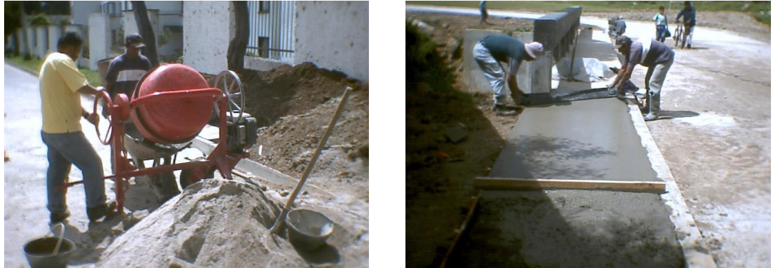
Figura 185. Fundición de la placa para andenes
