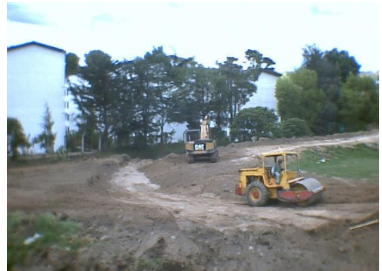
Figura 91. Conformación del relleno para el canal de desvío del río Pasto
