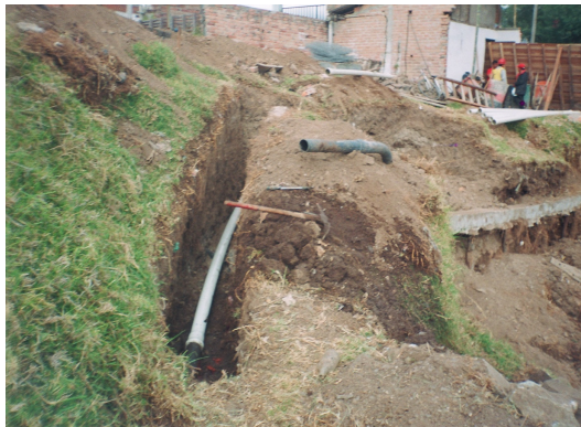
Figura 97. Desvío y excavación – tubería PVC 4"
