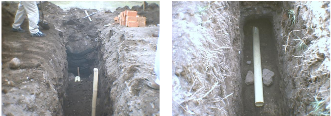
Figura 121. Excavación e instalación de la tubería de 6"
