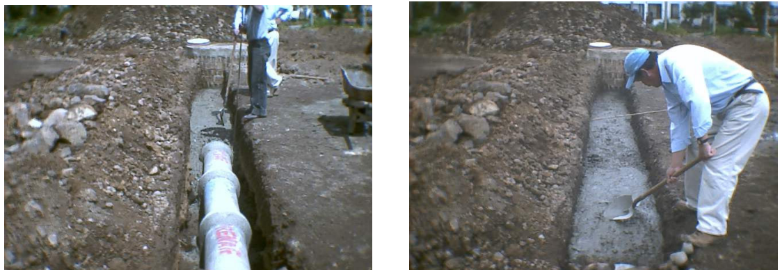
Figura 175. Concreto de protección sobre tubería de sumidero
