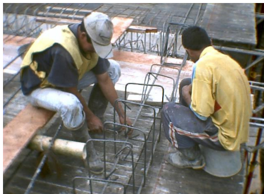
Figura 64. Construcción de la viga T1 y colocación refuerzo para postes de la baranda
