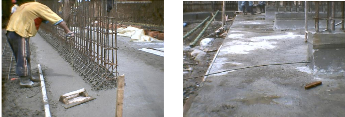
Figura 42. Control del espesor y terminado de la placa de cimentación
