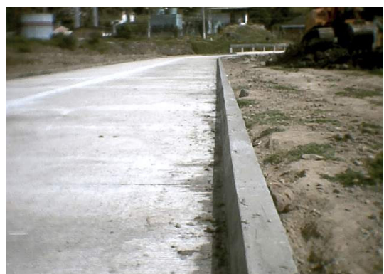
Figura 169. Estructura de sardineles completamente terminados
