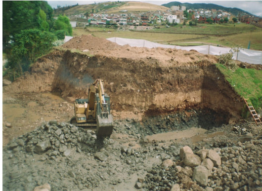
Figura 14. Excavación a máquina material conglomerado bajo agua
