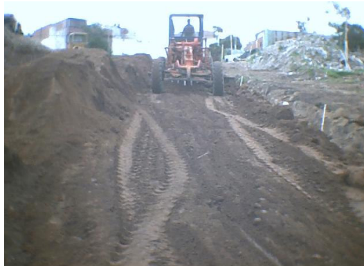
Figura 128. Extensión del material de relleno
