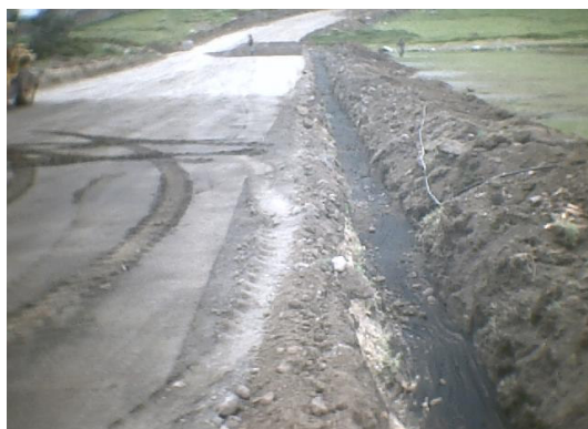
Figura 120. Sellado del filtro con relleno compactado
