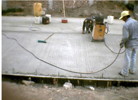
Figura 154. Demarcación de la línea de corte
