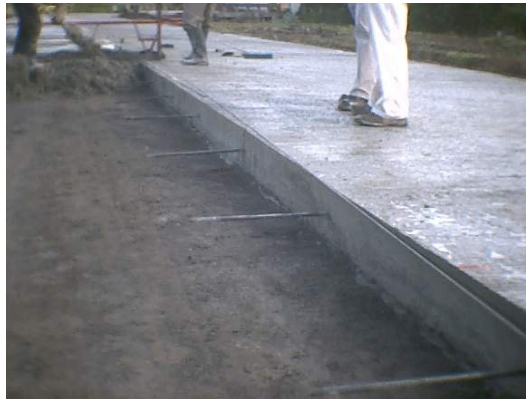
Figura 144. Barras de anclaje para las juntas longitudinales
