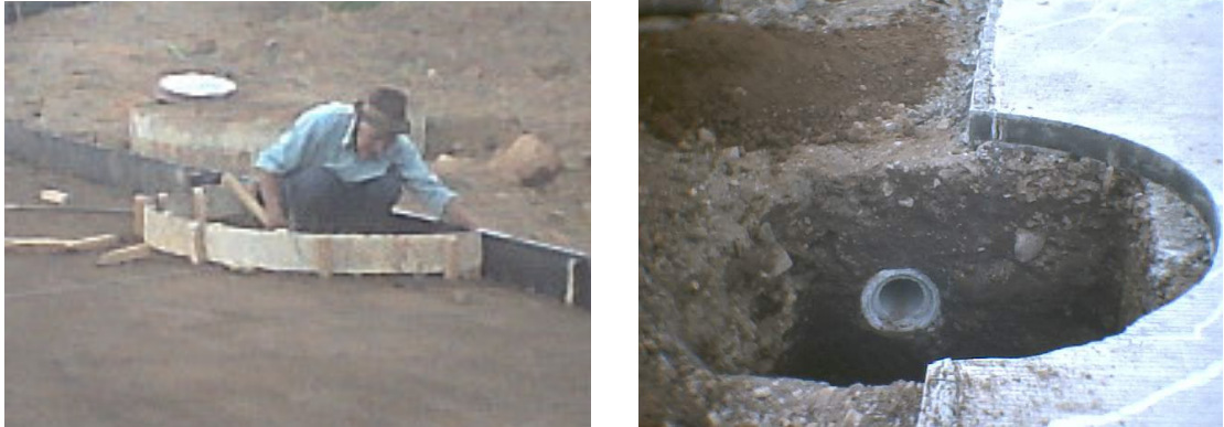
Figura 177. Ubicación de ejes y excavación para sumideros
