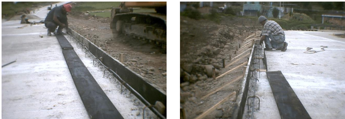
Figura 166. Colocación del refuerzo de 3/8" y el montaje de la formaleta
