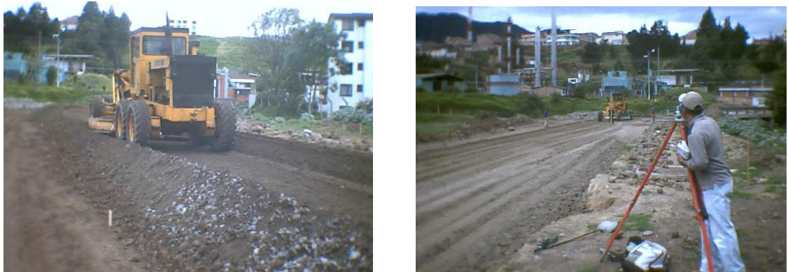
Figura 136. Control de cotas en la conformación de la base
