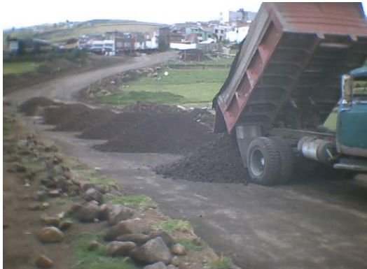
Figura 134. Suministro de material para base
