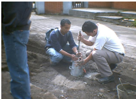
Figura 73. Prueba de asentamiento o Slump
