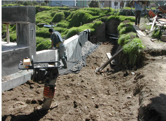
Figura 88. Compactación del material y conformación del relleno - zona de entrada
