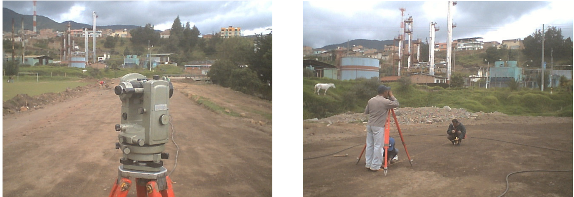
Figura 140. Replanteamiento del eje sobre la rasante
