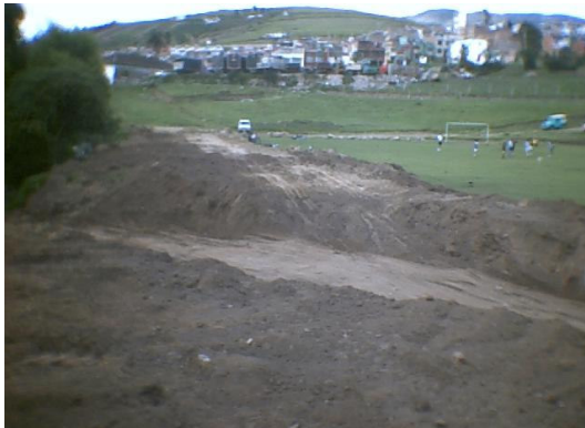
Figura 91. Conformación del relleno para el canal de desvío del río Pasto
