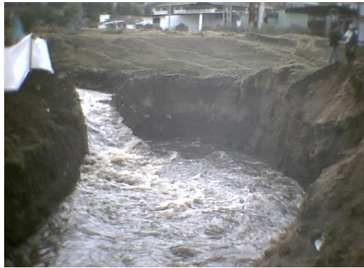
Figura 91. Conformación del relleno para el canal de desvío del río Pasto
