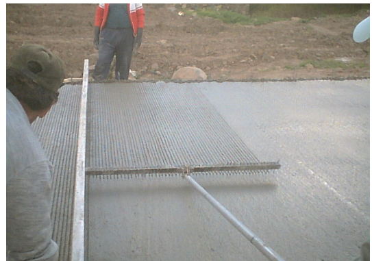
Figura 149. Microtexturizado y Macrottexturizado de la superficie
