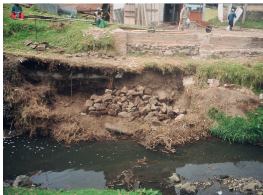
Figura 12. Excavación a mano y rescate de rajón existente
