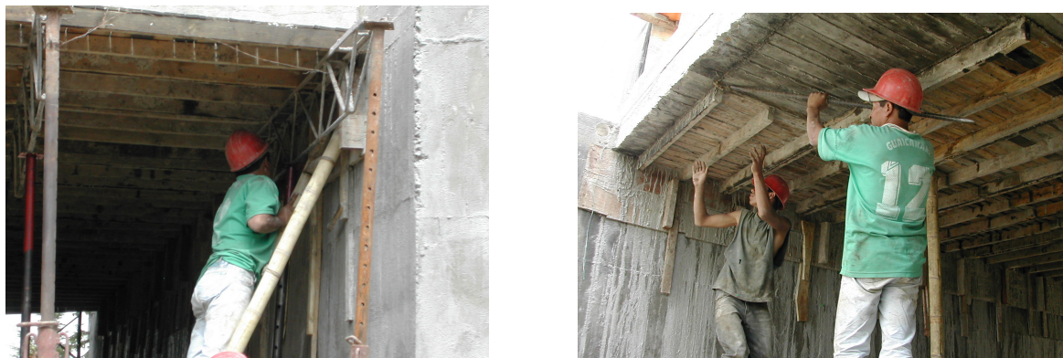
Figura 79. Remoción de formaleta y obra falsa – placa superior
