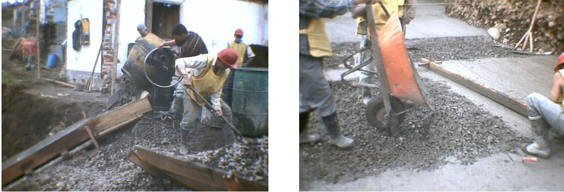
Figura 24. Transporte y colocación del concreto de nivelación
