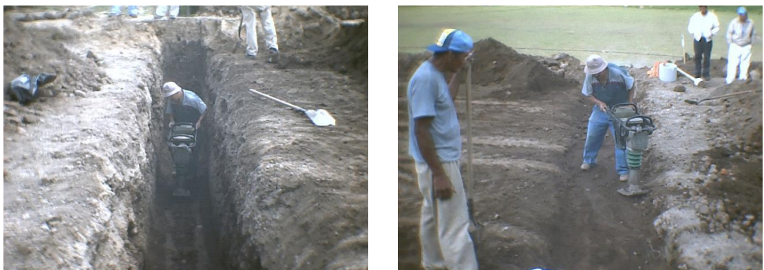
Figura 122. Conformación de relleno sobre tubería de 6"
