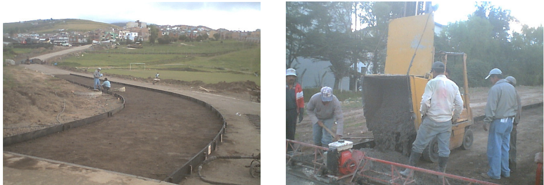
Figura 146. Transporte y colocación del concreto
