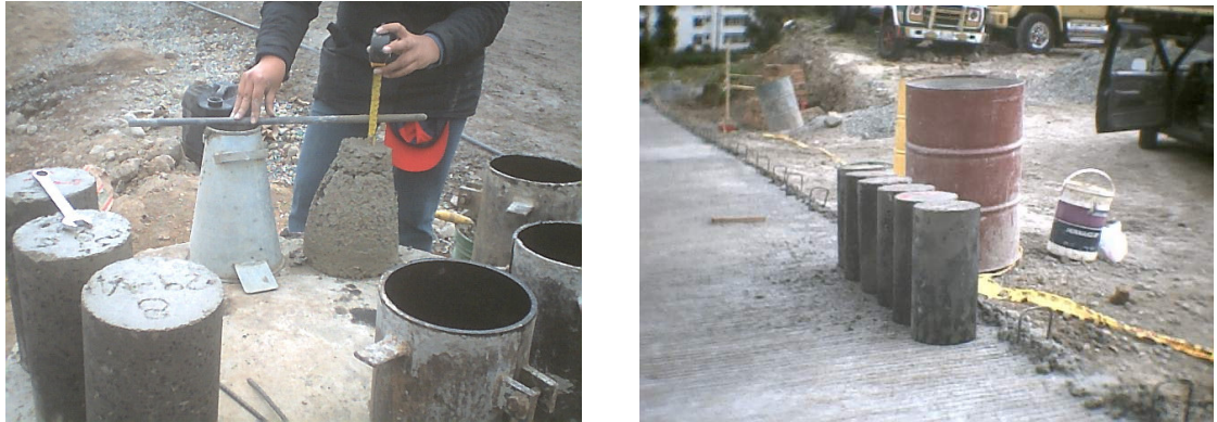
Figura 162. Prueba de asentamiento y elaboración de cilindros
