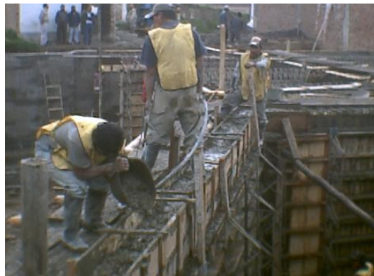
Figura 49. Fundición de las pantallas extremas (zonas de salida)
