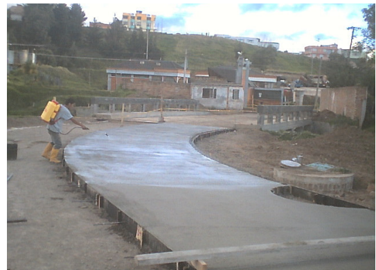
Figura 150. Curado del concreto con empleo de Antisol blanco
