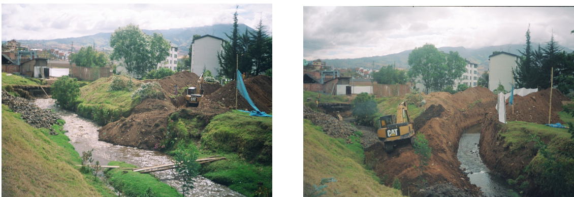
Figura 10. Culminación del canal y desviación del río Pasto
