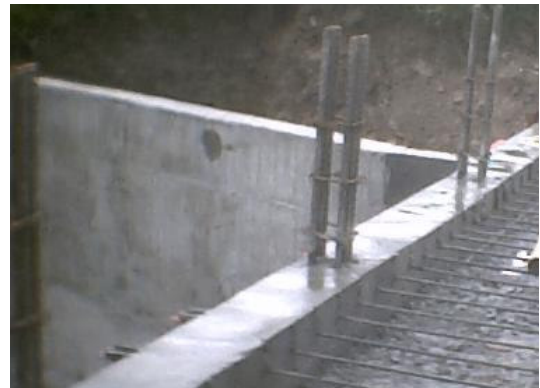
Figura 64. Construcción de la viga T1 y colocación refuerzo para postes de la baranda
