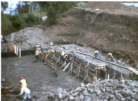
Figura 19. Conformación del gavión en el cuerpo del box y aletas
