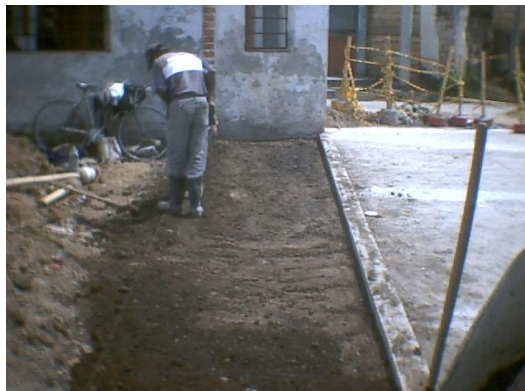
Figura 184. Relleno compactado para andenes
