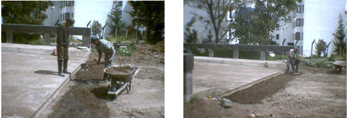
Figura 138. Compactación en las zonas adjuntas a obras de arte
