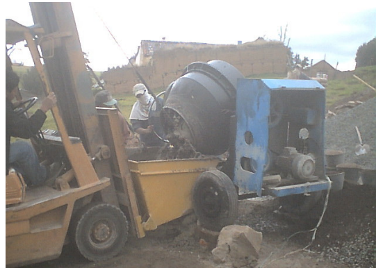
Figura 145. Dosificación y producción del concreto en obra
