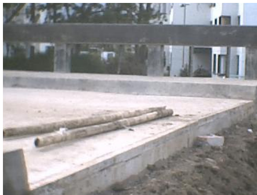
Figura 72. Angulo instalado – junta de expansión sencilla
