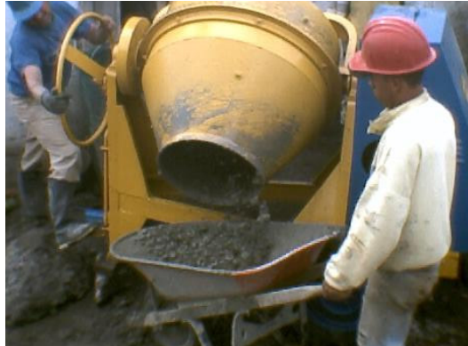
Figura 61. Producción del concreto para superestructura.
