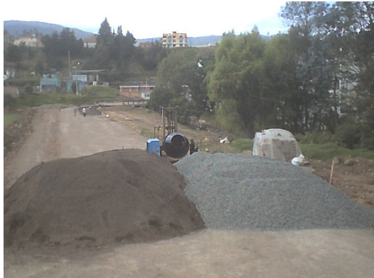
Figura 141. Materiales para la elaboración de concreto
