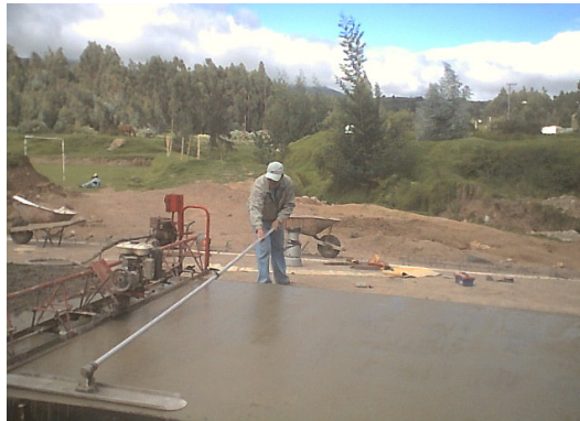
Figura 148. Acabado manual con llana
