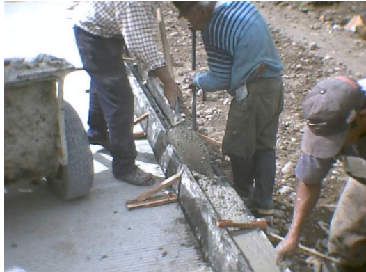
Figura 167. Vaciado del concreto para sardineles
