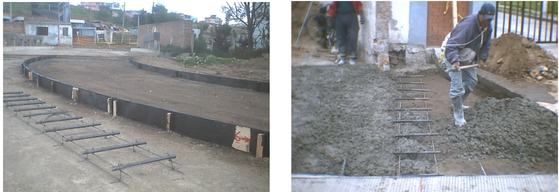
Figura 143. Canastilla de soporte para los pasadores de transferencia
