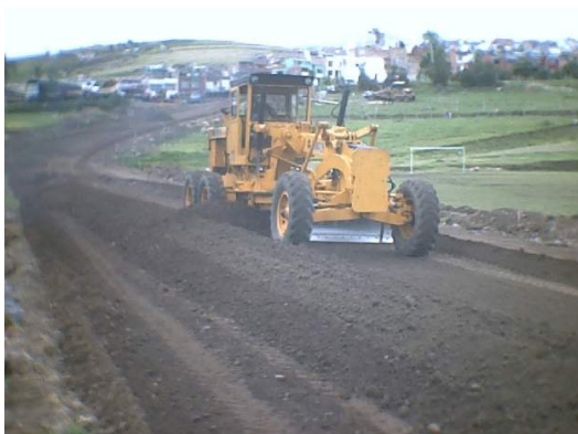
Figura 135. Extensión y mezcla del material para base
