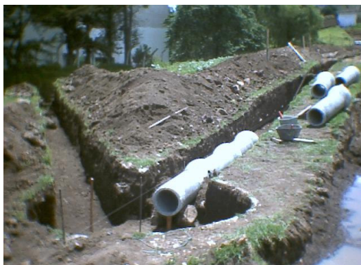
Figura 110. Instalación de tubería de 10" y 16"
