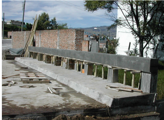
Figura 82. Acabado para superficie de barandas con llana metálica
