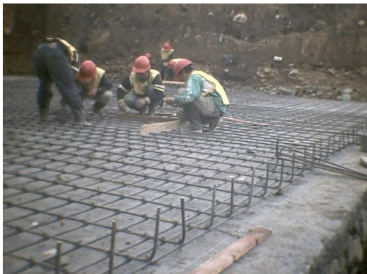
Figura 27. Armado del acero para placa de cimentación
