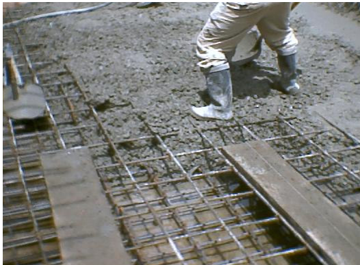
Figura 62. Fundición de la placa superior y terminado
