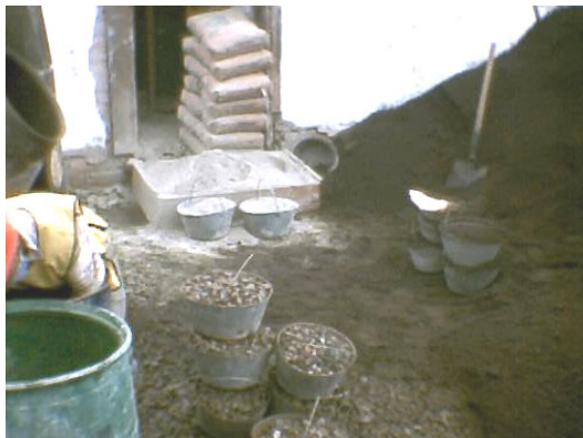
Figura 23. Materiales empleados para el concreto de 2500 psi
