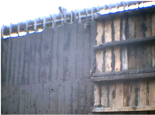
Figura 54. Junta proyectada en la parte superior de las pantallas intermedias y extremas.
