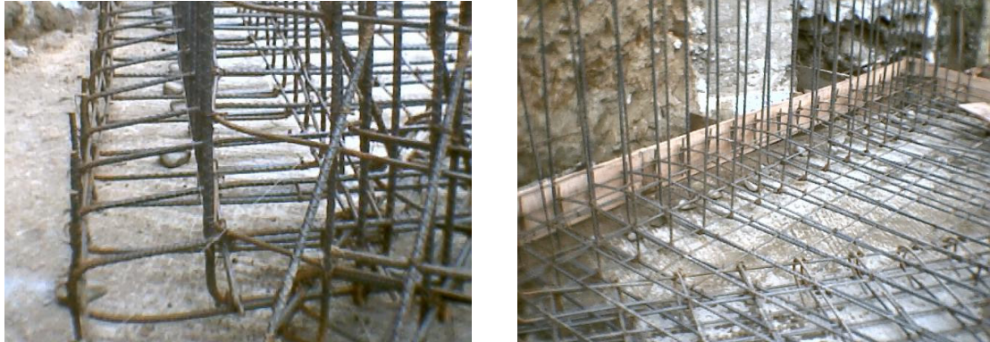
Figura 36. Armado del acero para aleta de acompañamiento tipo II
