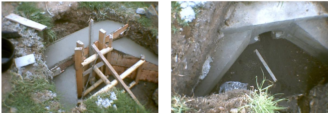
Figura 183. Construcción de cabezales de entrega
