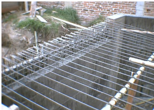
Figura 60. Detalle refuerzo tipo A y armado del refuerzo para la placa superior.
