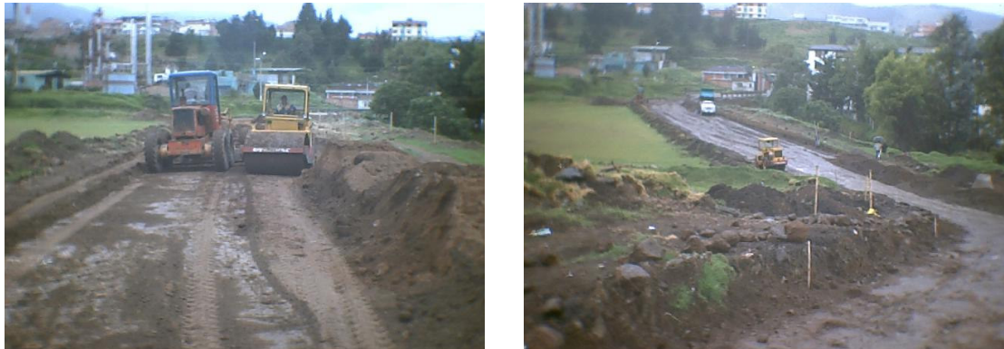
Figura 130. Sellado provisional del material
