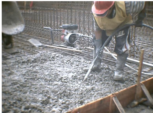
Figura 41. Vibrado del concreto para placa de cimentación
