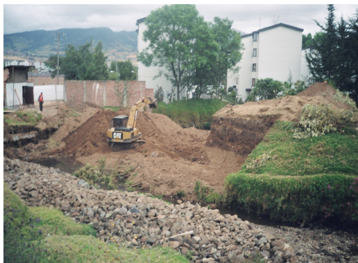
Figuran 13. Excavación a máquina material conglomerado (cuerpo box)
