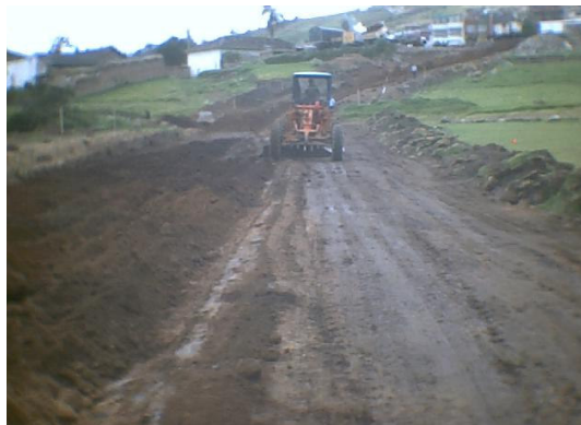
Figura 131. Escarificación o mejoramiento de la subrasante
