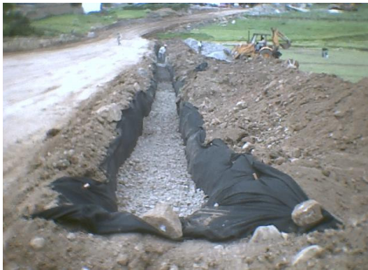
Figura 119. Colocación del material filtrante
