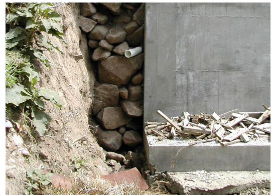
Figura 87. Sitios de evacuación final para tubería PVC corrugada (zona de entrada y salida).
