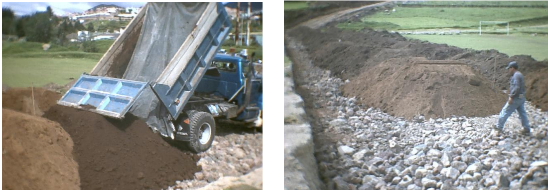
Figura 127. Disposición del material para el terraplén en caballetes
