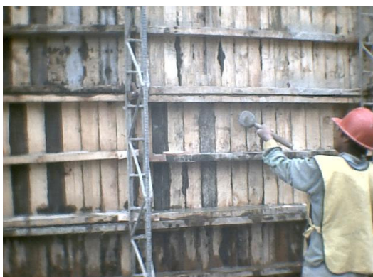
Figura 51. Martillado de la formaleta
