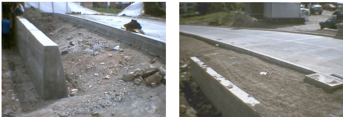
Figura 190. Muro de contención terminado y conformación del relleno
