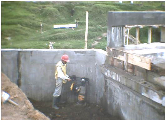
Figura 89. Compactación del material y conformación del relleno - zona de salida
