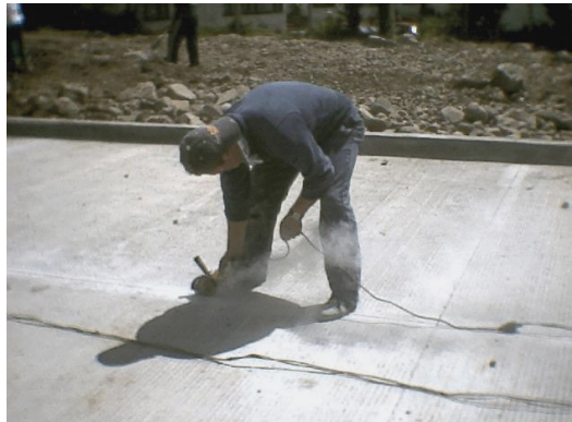
Figura 157. Remoción de lodo dentro sobre la junta
