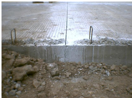
Figura 156. Corte elaborado de una junta transversal
