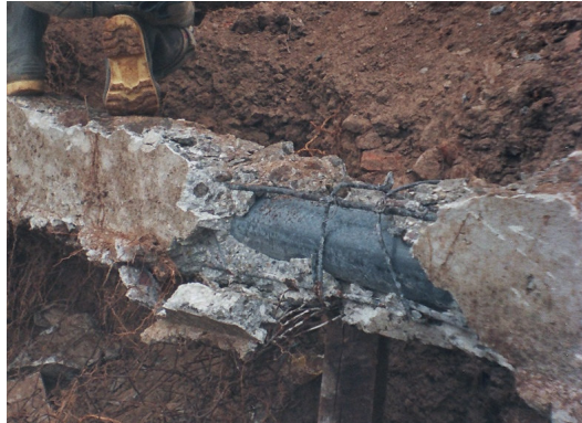
Figura 96. Demolición de la estructura – tubería existente.
