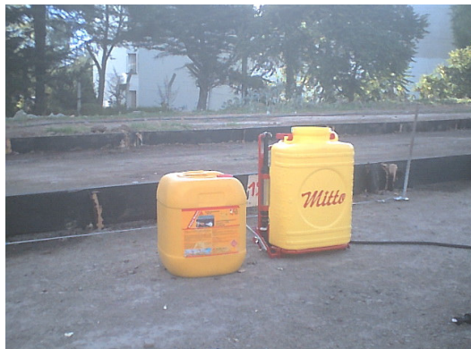
Figura 150. Curado del concreto con empleo de Antisol blanco
