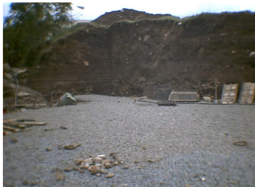
Figura 21. Superficie terminada y nivelada del gavión
