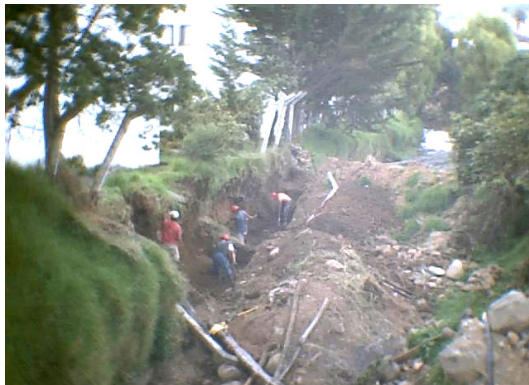
Figura 93. Excavación a mano y perfilado - talud Pucalpa II
