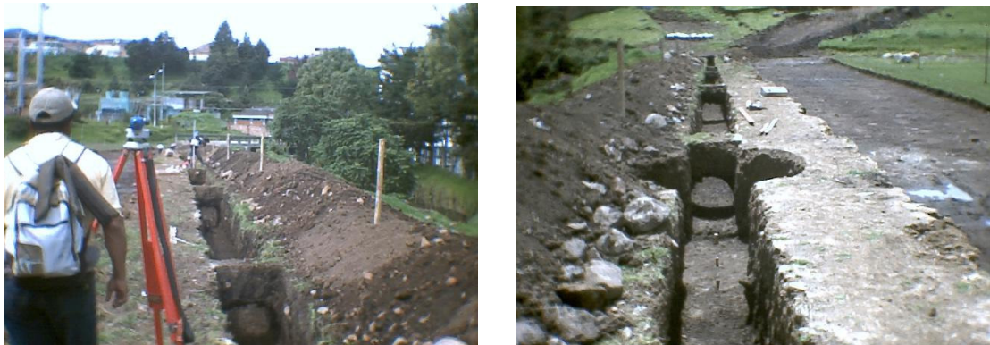
Figura 106. Excavación en conglomerado para alcantarillado pluvial
