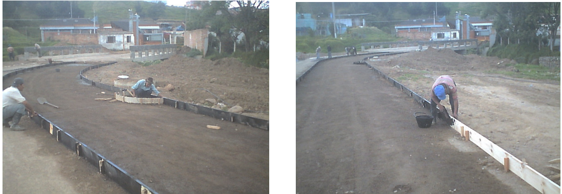
Figura 142. Colocación de la formaleta e imprimación de aceite
