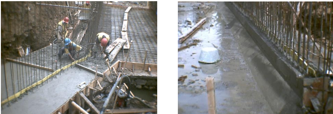
Figura 43. Colocación de cinta PVC A – 15
