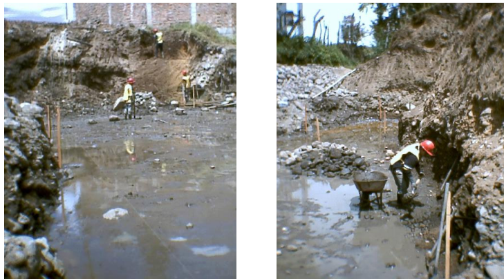
Figura 16. Nivelación de la superficie y perfilado a mano
