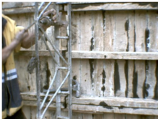
Figura 46. Fijación de la formaleta mediante las chapolas
