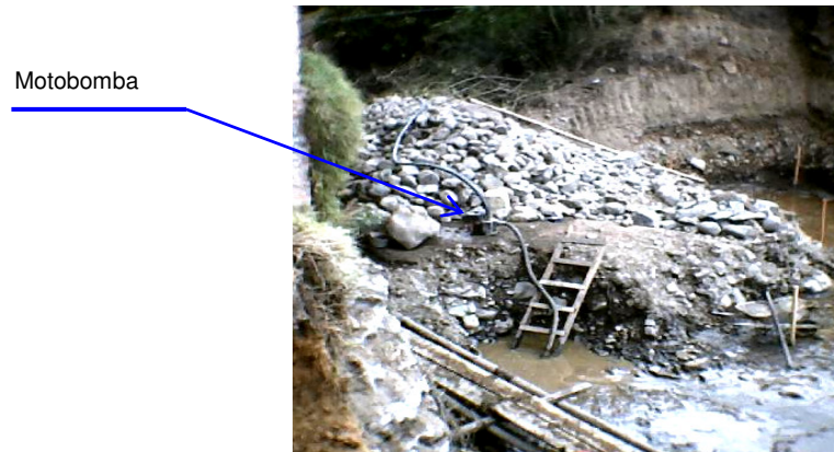
Figura 17. Desalojo permanente de agua con motobomba
