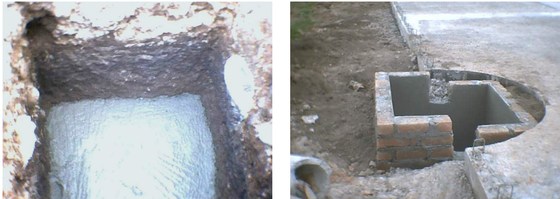
Figura 178. Solado en concreto y alzada de muros en mampostería
