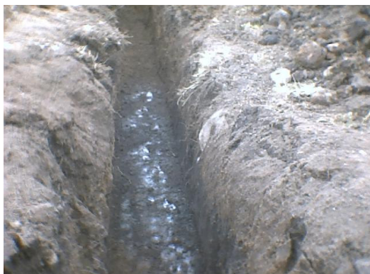
Figura 118. Colocación del geotextil sobre las zanjas del filtro
