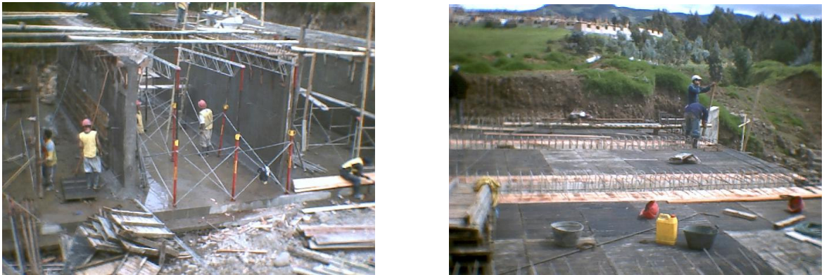
Figura 57. Armado de formaleta y obra falsa para la placa superior
