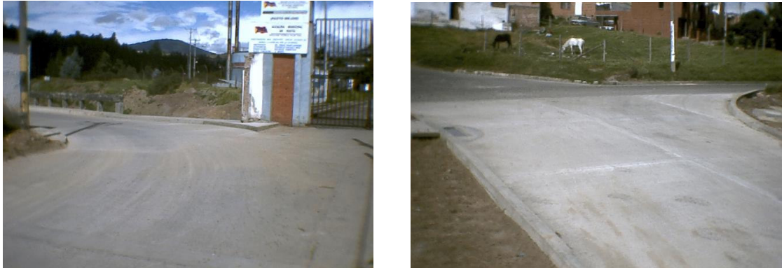
Figura 191. Zonas de acceso y salida de la nueva vía
