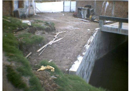
Figura 88. Compactación del material y conformación del relleno - zona de entrada
