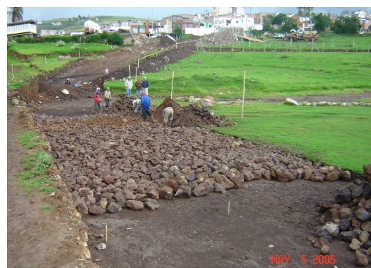
Figura 125. Corte adicional, compactación del suelo y pedraplén de conformación
