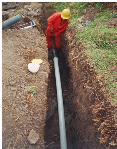
Figura 98. Instalación y acople de accesorios para tubería PCV 4"
