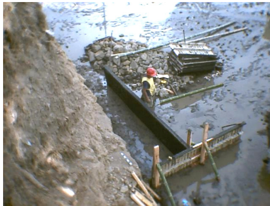
Figura 18. Colocación de la formaleta para gavión
