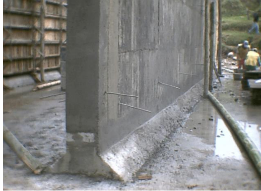
Figura 53. Junta proyectada en la parte inferior de las pantallas
