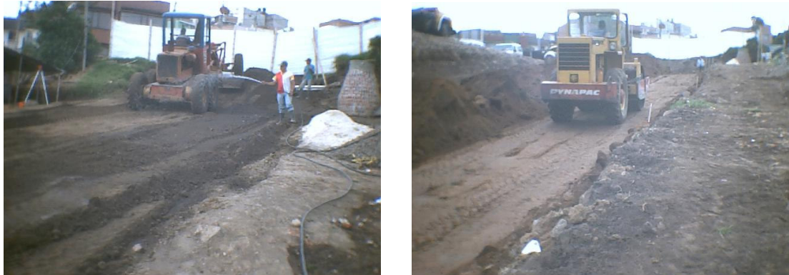
Figura 129. Control de la humedad y compactación del material
