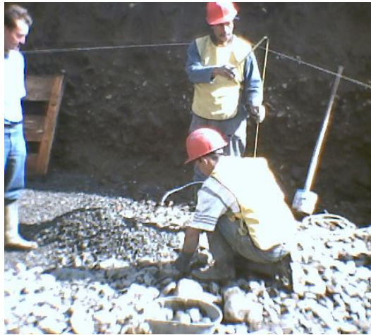
Figura 20. Nivelación de la superficie con triturado de 3/4" – 1½"
