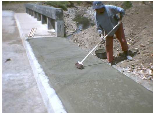
Figura 186. Texturización y terminado final de andenes
