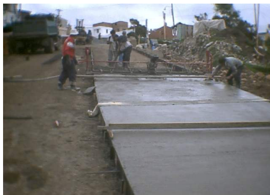
Figura 149. Microtexturizado y Macrottexturizado de la superficie
