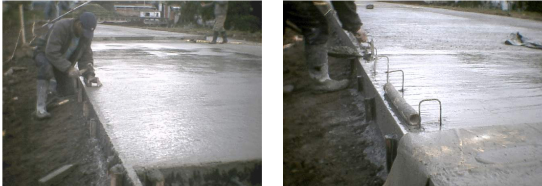
Figura 165. Colocación de los flejes
