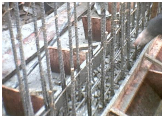
Figura 47. Fundición de acartelamientos inferiores
