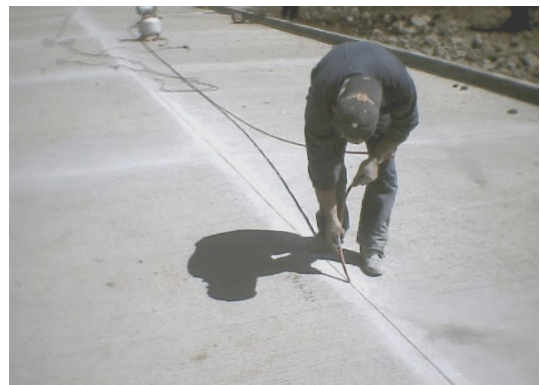
Figura 158. Operaciones de barrido y soplado sobre la junta
