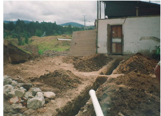
Figura 98. Instalación y acople de accesorios para tubería PCV 4"
