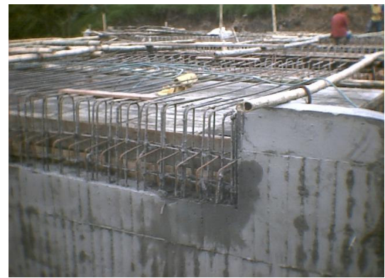
Figura 54. Junta proyectada en la parte superior de las pantallas intermedias y extremas.
