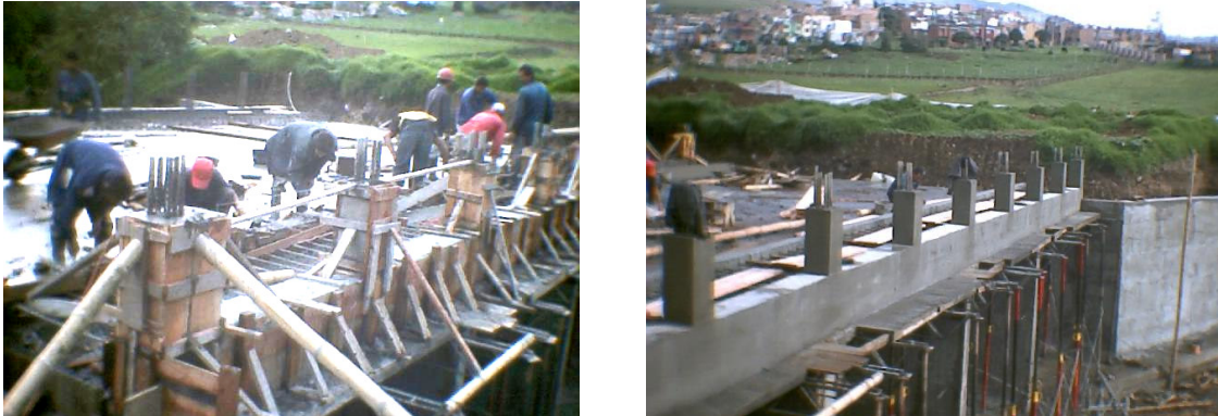
Figura 65. Fundición de los postes y desencofrado
