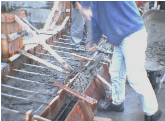
Figura 68. Construcción de los bordillos y desencofrado
