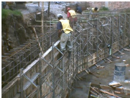
Figura 45. Armado de formaleta para pantallas
