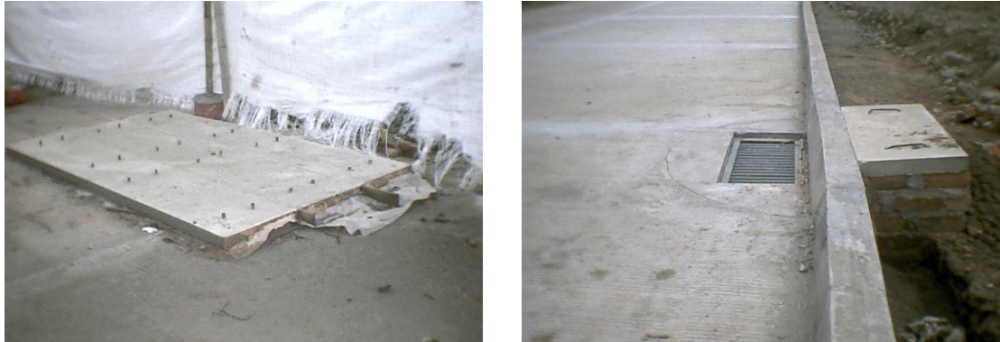
Figura 181. Tapas prefabricadas y sumideros terminados
