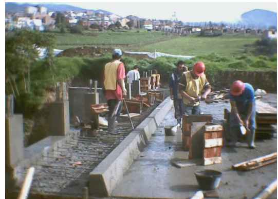
Figura 68. Construcción de los bordillos y desencofrado
