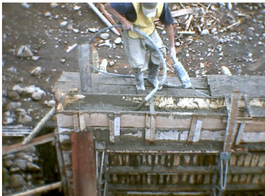
Figura 50. Vibrado del concreto dentro de la formaleta
