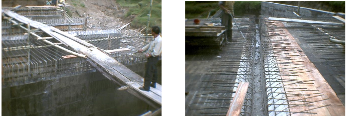
Figura 77. Curado del concreto de pantallas
