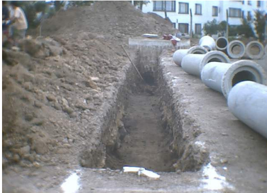
Figura 171. Excavación manual para tubería de sumideros
