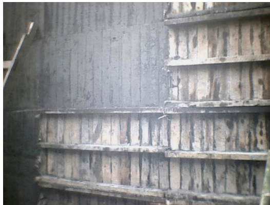
Figura 78. Remoción de formaleta para muros
