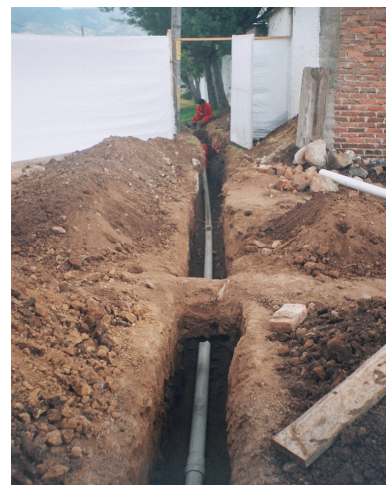
Figura 98. Instalación y acople de accesorios para tubería PCV 4"
