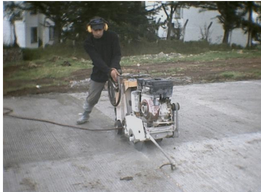
Figura 155. Aserrado de las juntas transversales y longitudinales
