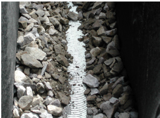
Figura 87. Sitios de evacuación final para tubería PVC corrugada (zona de entrada y salida).
