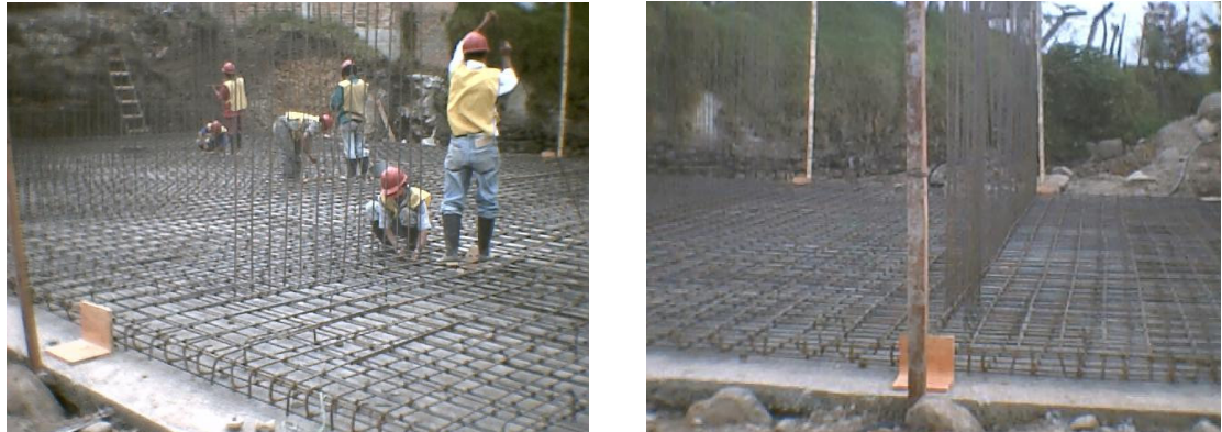
Figura 30. Armado del acero para pantallas
