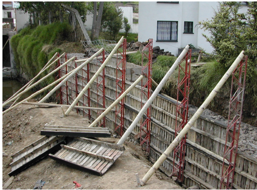
Figura 94. Colocación de formaleta y construcción de los módulos – sector Pucalpa II
