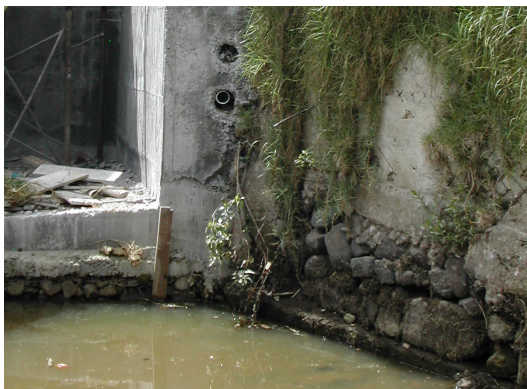
Figura 87. Sitios de evacuación final para tubería PVC corrugada (zona de entrada y salida).
