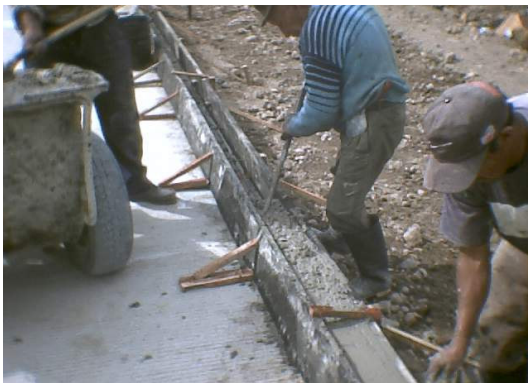
Figura 168. Operaciones de vibrado (sardinel)
