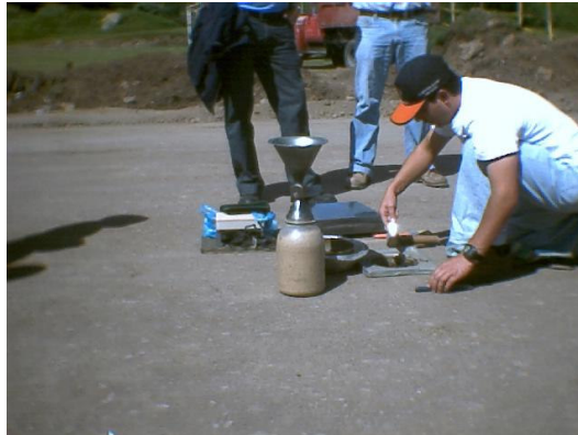
Figura 133. Toma de densidad en la capa subrasante
