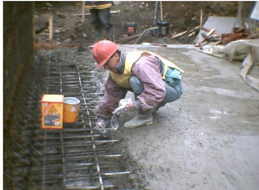
Figura 56. Aplicación de adhesivo epóxico Sikadur – 32 Primer
