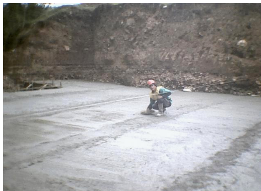
Figura 25. Acabado del solado de nivelación
