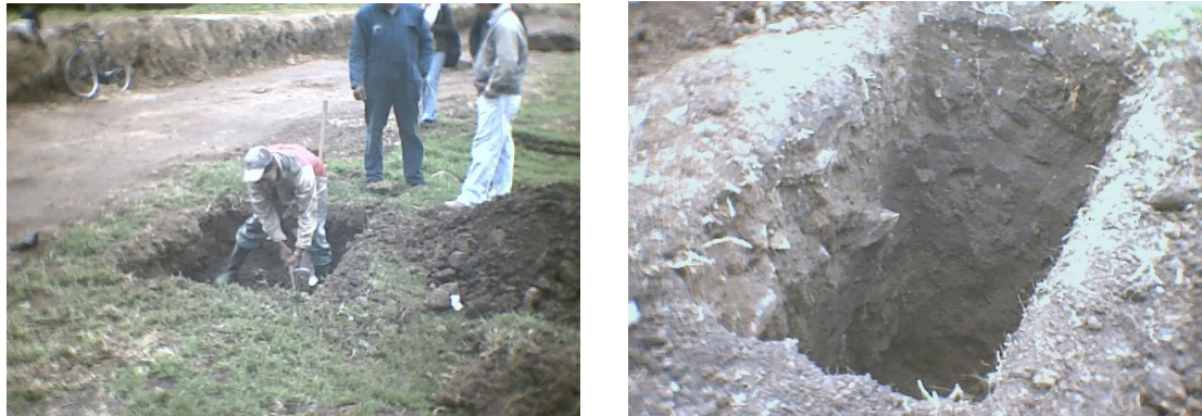
Figura 123. Realización de apiques
