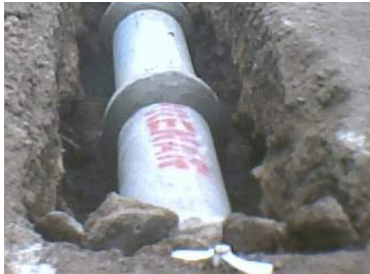
Figura 173. Sellado provisional en un extremo de la tubería
