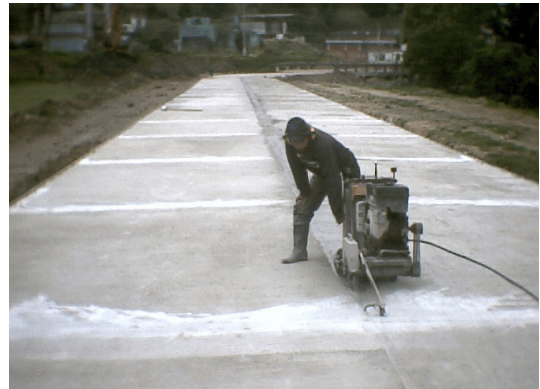
Figura 155. Aserrado de las juntas transversales y longitudinales
