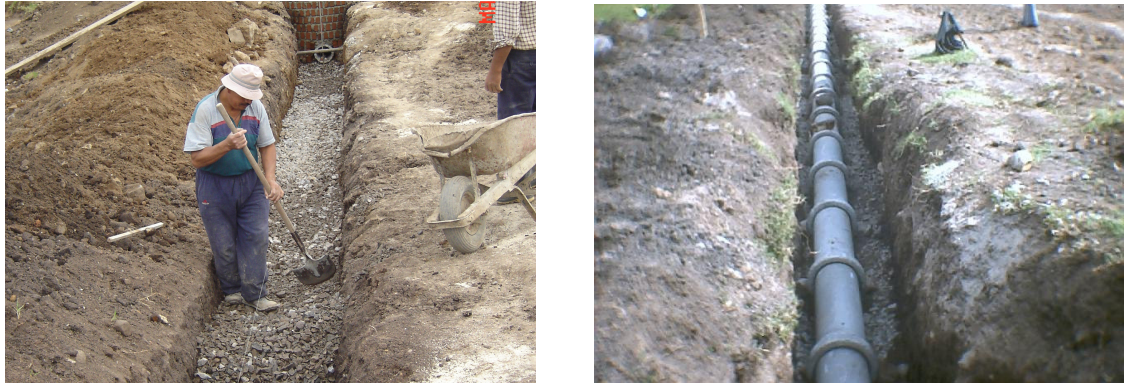
Figura 112. Filtro en grava para tubería de 10"
