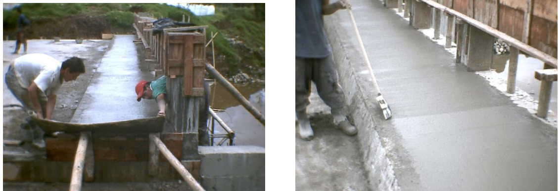
Figura 70. Acabado y texturización de la superficie de andenes
