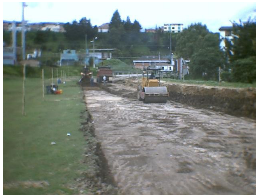
Figura 125. Corte adicional, compactación del suelo y pedraplén de conformación
