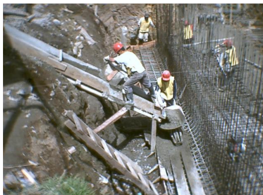
Figura 39. Canal para el transporte del concreto.
