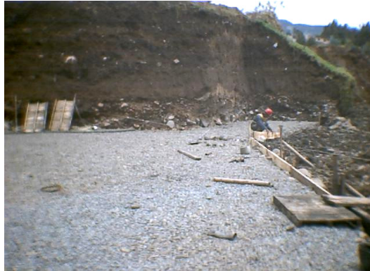
Figura 22. Colocación de la formaleta para el solado de nivelación
