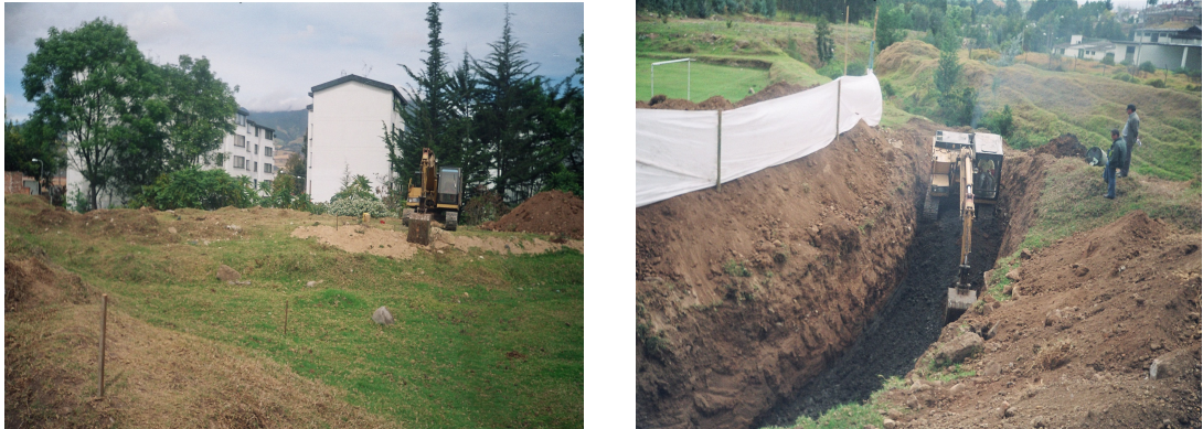
Figura 9. Trazado y construcción del canal de desvío
