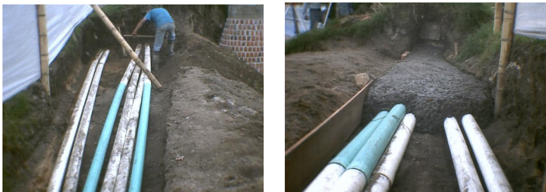
Figura 105. Protección de redes de teléfono encontradas
