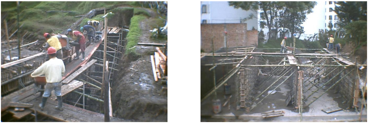
Figura 48. Fundición de pantallas extremas (zonas de entrada) e intermedias.
