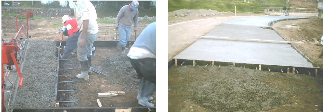
Figura 151. Colocación de formaleta y pasadores en junta de fin de jornada
