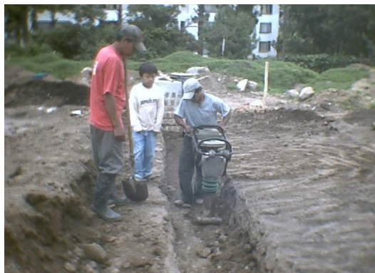
Figura 174. Relleno compactado sobre tubería de sumideros
