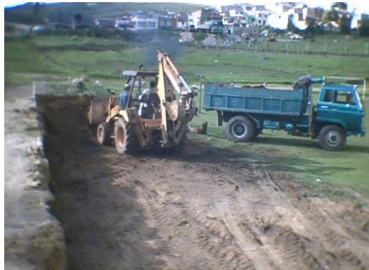
Figura 103. Excavación a maquina – zona baja de la vía
