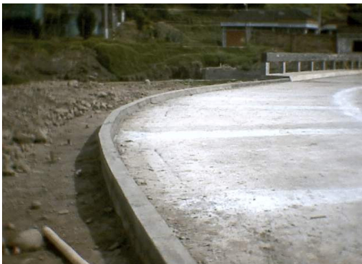
Figura 169. Estructura de sardineles completamente terminados
