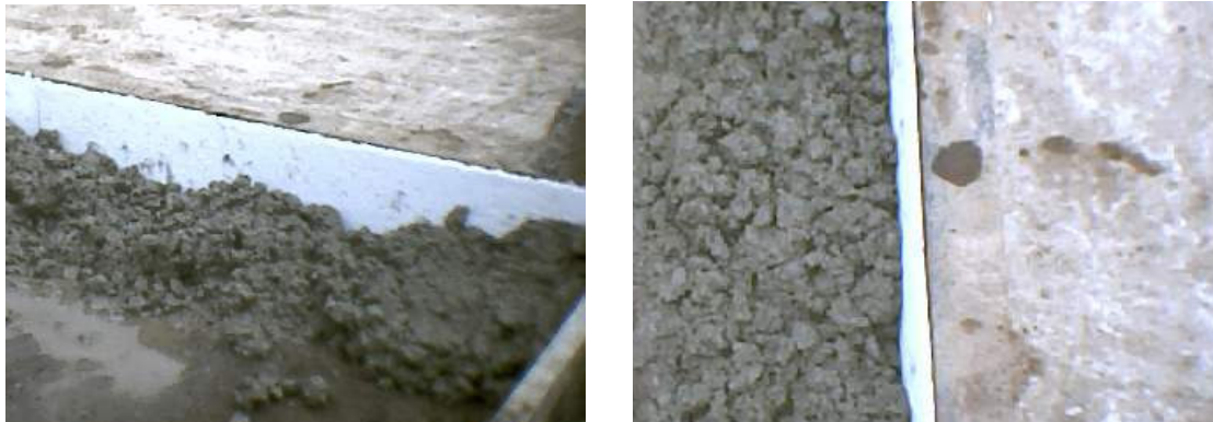
Figura 153. Junta de expansión placa box – pavimento
