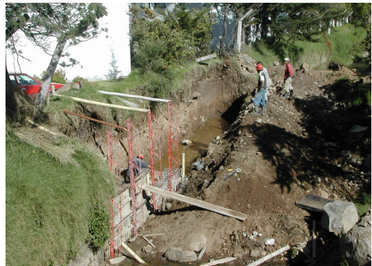
Figura 93. Excavación a mano y perfilado - talud Pucalpa II
