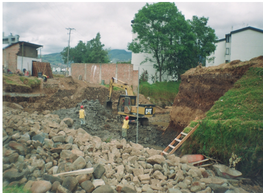
Figura 15. Control del nivel definitivo de excavación
