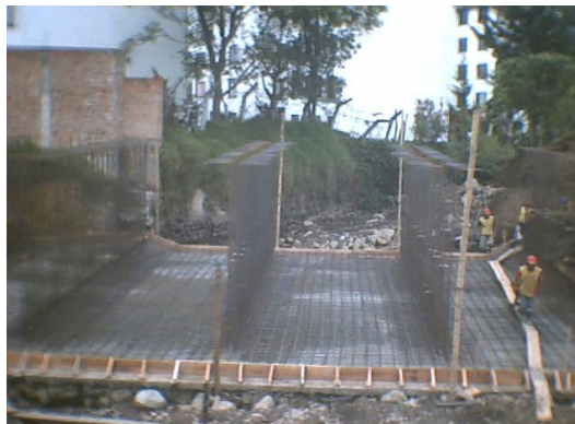
Figura 37. Colocación de la formaleta placa de piso
