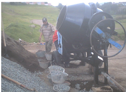
Figura 145. Dosificación y producción del concreto en obra
