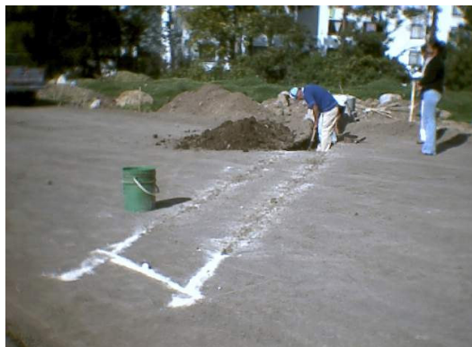
Figura 170. Ubicación y demarcación de área de excavación
