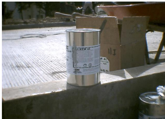
Figura 160. Material para el sello de juntas en frío (vulkem 45)
