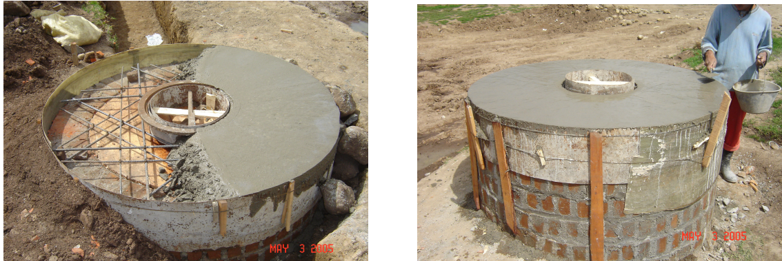
Figura 116. Construcción pozos de inspección
