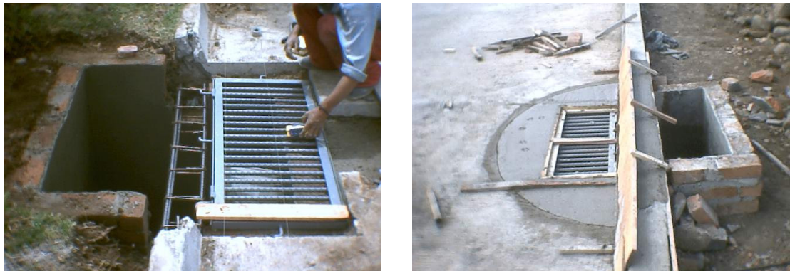
Figura 180. Estructura de sardinel, rejilla metálica y fundición en concreto
