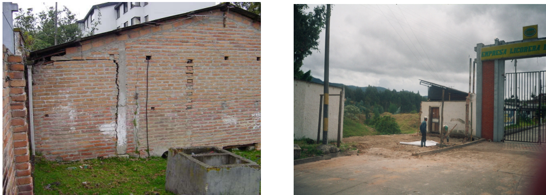
Figura 8. Demolición de la estructura existente
