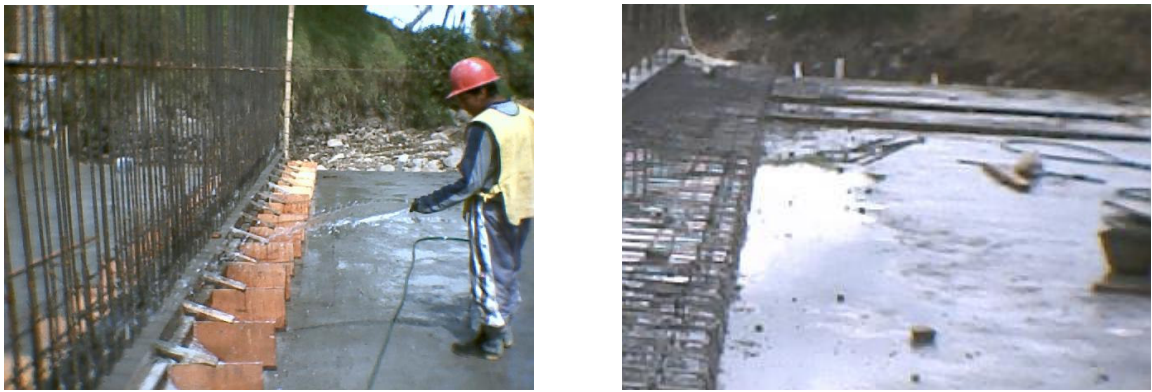
Figura 76. Curado del concreto de cimentación y placa superior
