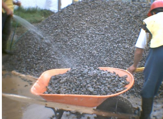
Figura 38. Limpieza de los agregados
