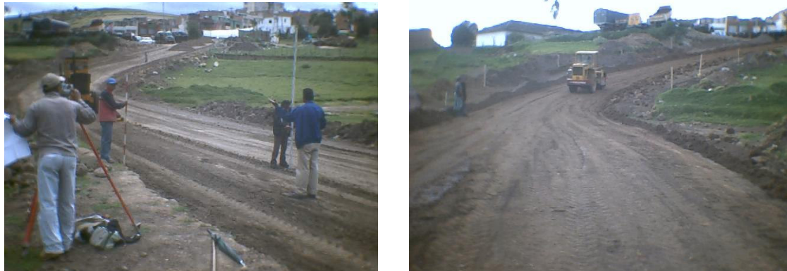
Figura 132. Cereo de la subrasante y culminación del terraplén
