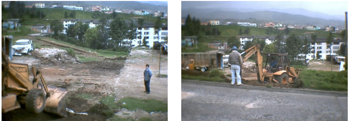
Figura 104. Excavación a maquina – zona alta de la vía
