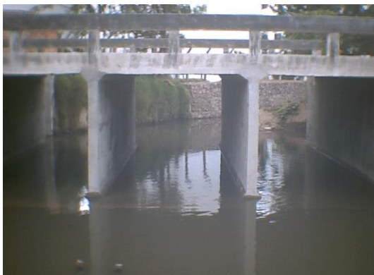
Figura 101. Disposición y entrega final de la obra
