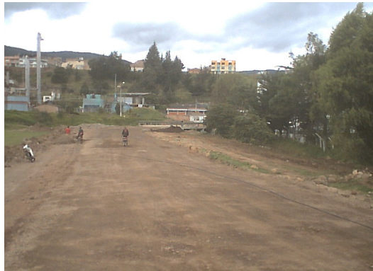
Figura 139. Base completamente conformada
