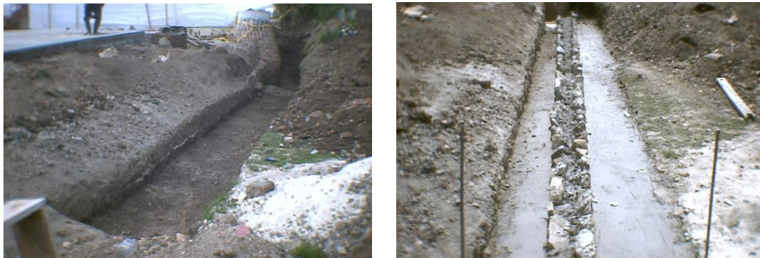
Figura 188. Excavaciones y fundición de la zarpa para muros
