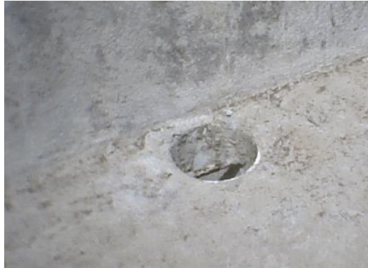
Figura 84. Drenes para la placa superior del box
