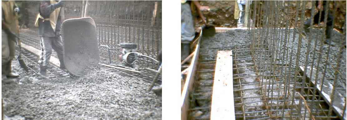
Figura 40. Colocación del concreto - placa de cimentación y zarpas de aletas
