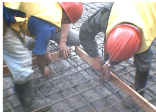
Figura 27. Armado del acero para placa de cimentación
