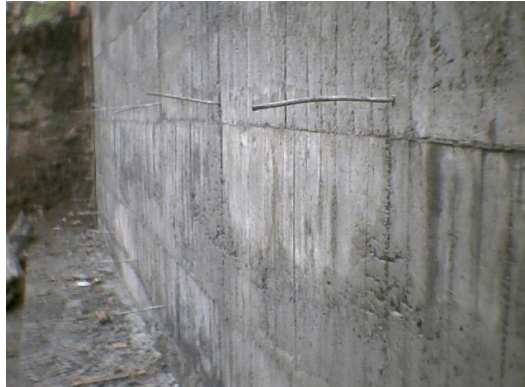
Figura 80. Acabado para superficies de estribos y aletas
