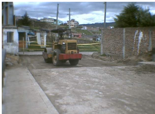
Figura 137. Compactación de la base
