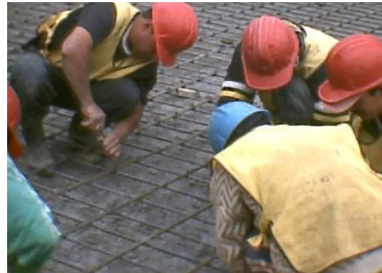
Figura 60. Detalle refuerzo tipo A y armado del refuerzo para la placa superior.
