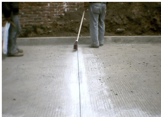
Figura 158. Operaciones de barrido y soplado sobre la junta
