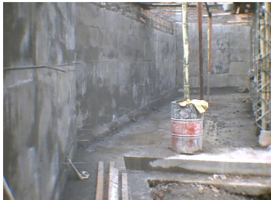
Figura 81. Acabado para superficies de muros y placas expuestas a la vista
