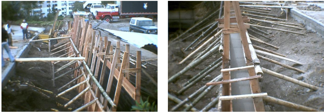
Figura 189. Colocación de la formaleta y fundición del muro
