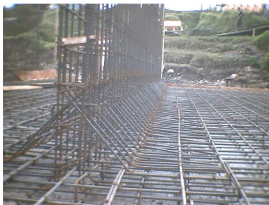
Figura 31. Armado del acero para acartelamientos
