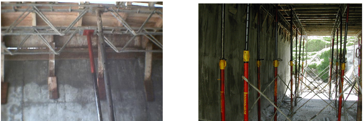
Figura 58. Obra falsa (Cerchas, bastones, tijeras largas y cortas)
