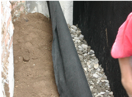
Figura 85. Construcción del filtro con geotextil y grava
