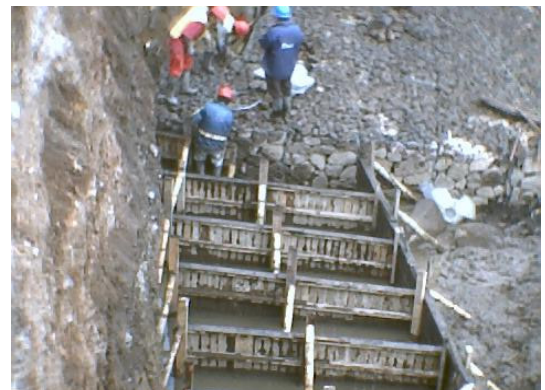
Figura 19. Conformación del gavión en el cuerpo del box y aletas
