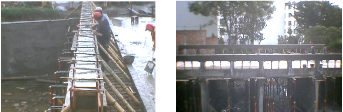
Figura 66. Construcción de la viga área y desencofrado final de la baranda
