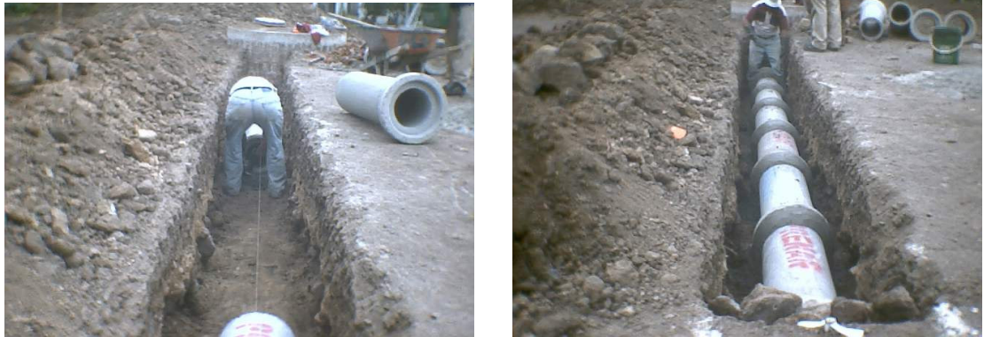
Figura 172. Instalación de la tubería para sumideros
