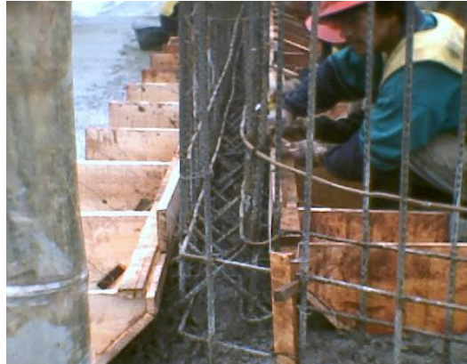
Figura 44. Colocación de la formaleta para acartelamientos
