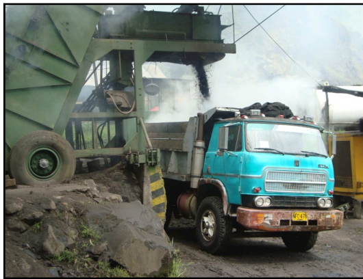
Figura 16. Descarga de la mezcla asfáltica sobre la volqueta
