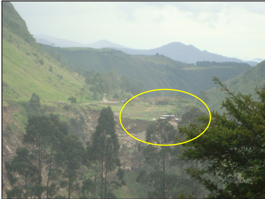
Figura 7 . Ubicación de la planta de producción de mezcla asfáltica en caliente
