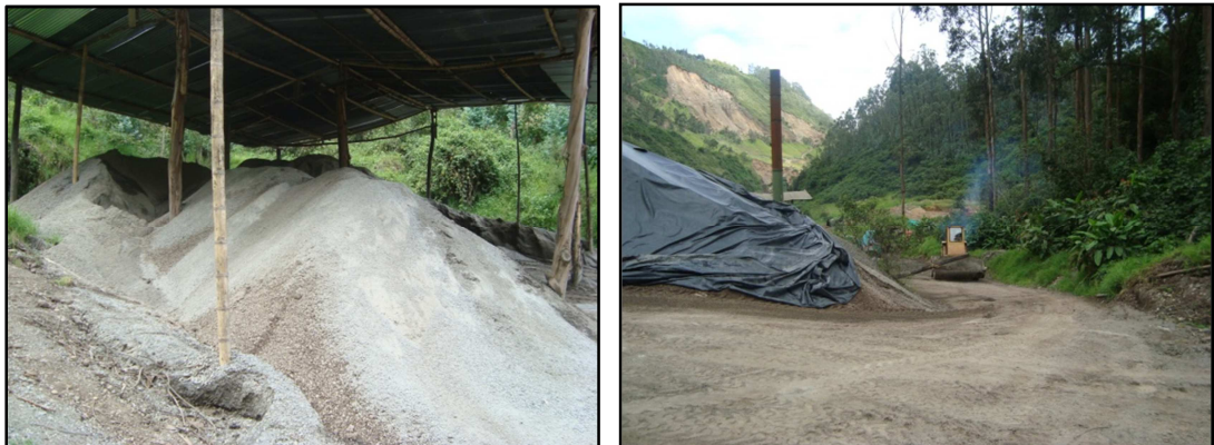
Figura 8. Acopio y transporte de materiales pétreos
