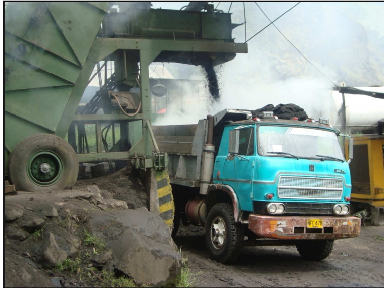
Figura 4. Vertimiento de la mezcla asfáltica a la volqueta
