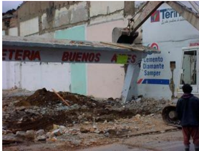
Figura 15. Demolición muros predio 185-023
