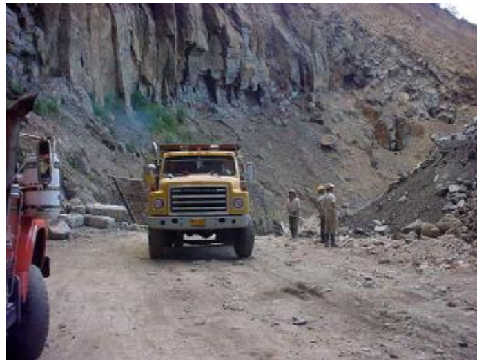
Figura 8. Desalojo de escombros predio 185-011-012-027-029-030
