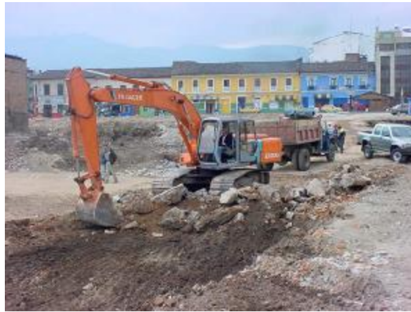
Figura 24. Demolición vía en pavimento asfáltico
