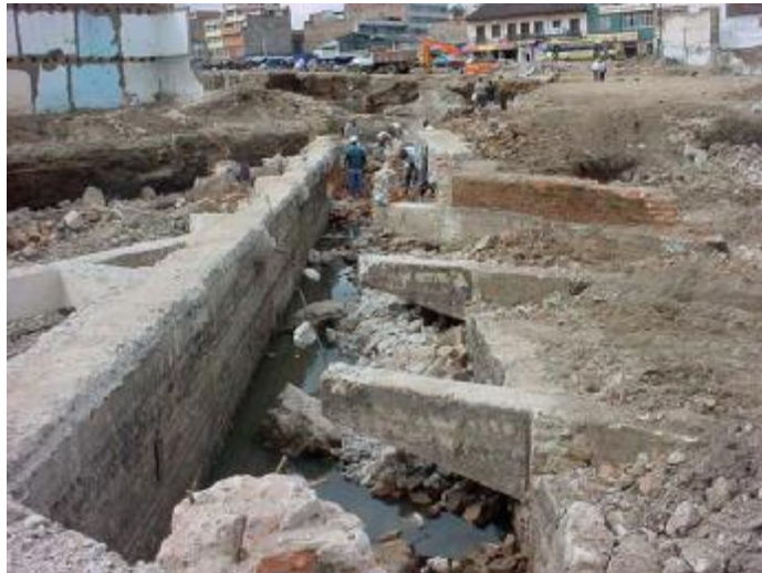
Figura 25. Demolición muros en mampostería y concreto hidráulico
