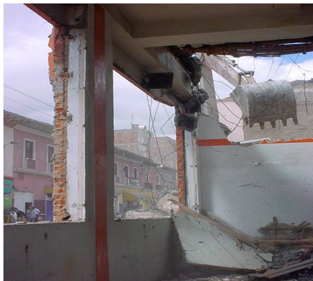
Figura 3. Demolición losas de entrepiso 185-025-032
