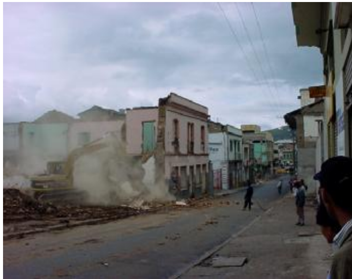
Figura.11 Demolición muros frontales predio 185-023
