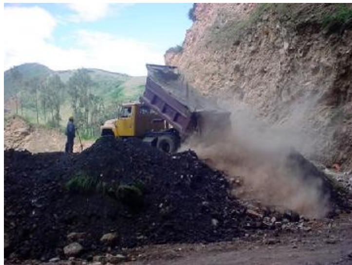
Figura 16. Desalojo de escombros a la escombrera Toro Alto
