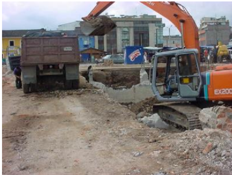
Figura 23. Demolición muro de contención en concreto reforzado
