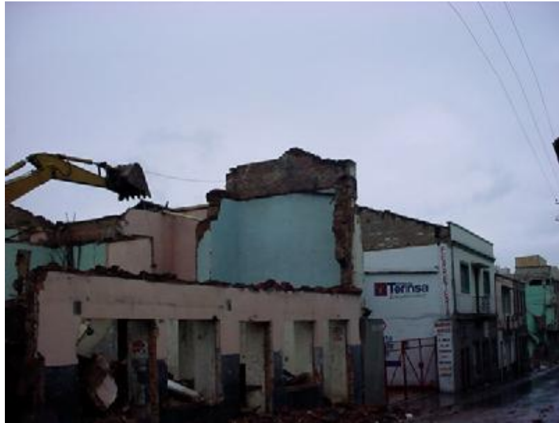
Figura 12. Demolición muros medianeros entre los predios 0185-022 y 023
