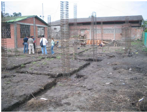
Figura 1. Localización de la Obra
