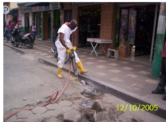
Figura 81. Demolición de concreto
