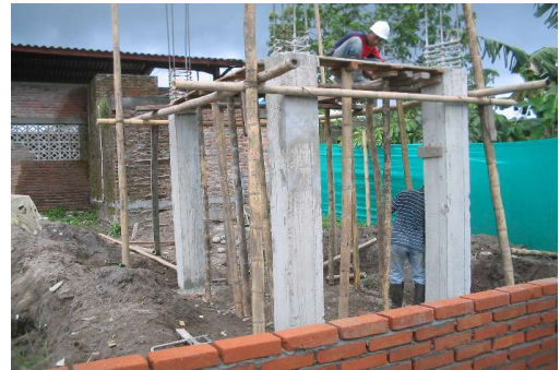
Figura 55. Conformación de columnas 1er nivel
