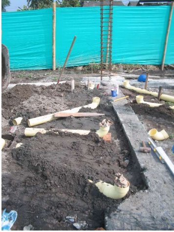
Figura 42. Instalación de las tuberías
