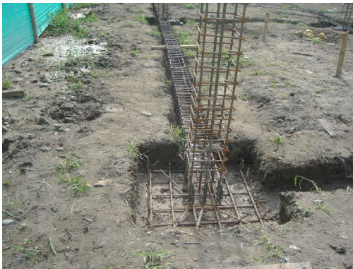
Figura 17. Refuerzo de zapata
