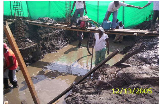
Figura 44. Extracción de agua mediante bomba
