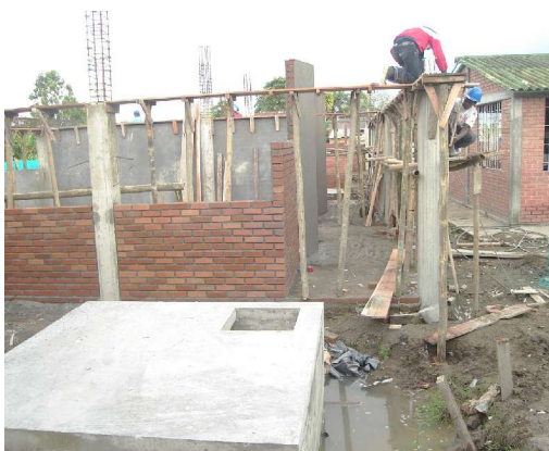
Figura 34. Encofrado de la viga
