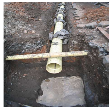
Figura 83. Reposición de tubería
