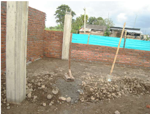
Figura 20. Relleno y apisonamiento de la base
