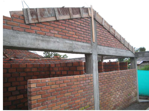
Figura 37. Encofrado de la cinta de culata
