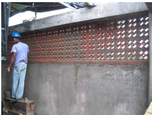
Figura 29. Pega de caldos de arcilla
