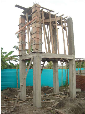
Figura 56. Conformación de columnas 2do nivel
