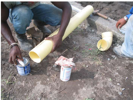
Figura 41. Unión de las tuberías
