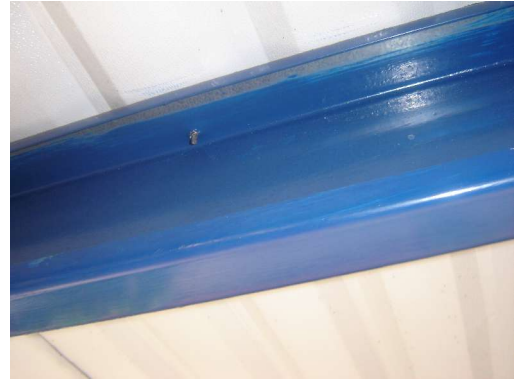
Figura 70. Unión teja correa mediante pernos
