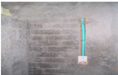
Figura 61. Regata de instalación eléctrica
