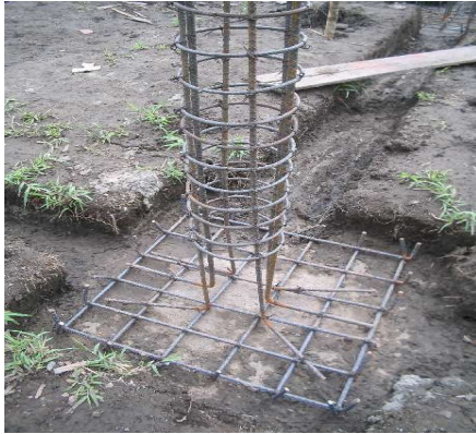
Figura 19. Anclaje de Malla Columna.
