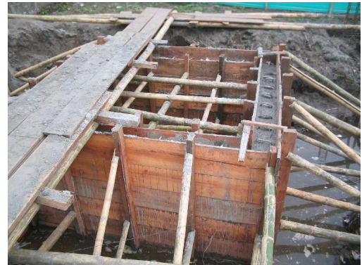
Figura 50. Fundición de las paredes del tanque
