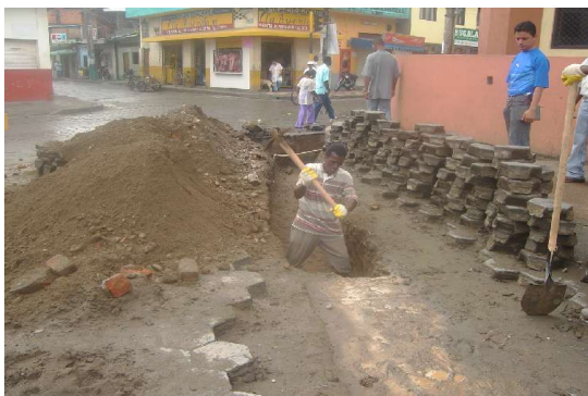
Figura 82. Excavación de zanja
