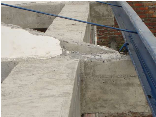
Figura 68. Correa debidamente soldada a secciones de varilla previamente incrustadas.
