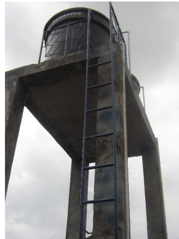
Figura 57. Consolidación final de la estructura
