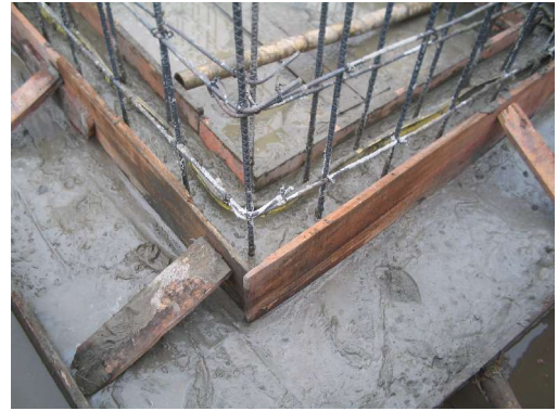
Figura 48. Fundición de base tanque
