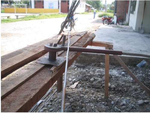
14. Figurado mediante mandril.
