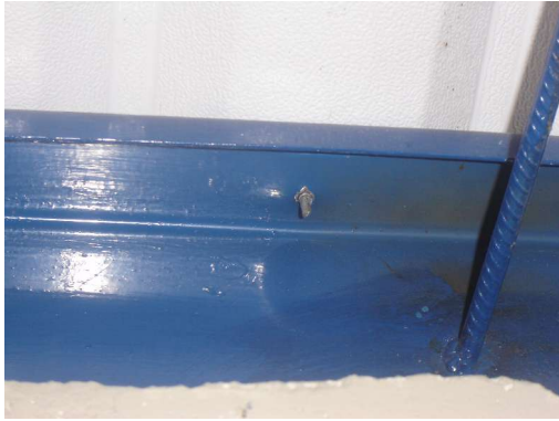
Figura 69. Anclaje correa tirante
