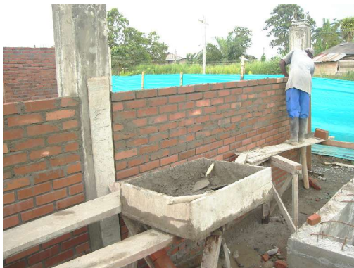
Figura 31. Mortero en parihuela utilizado para pega de ladrillos.
