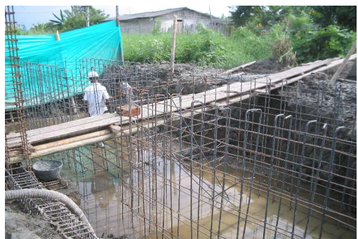
Figura 46. Instalación de las mallas
