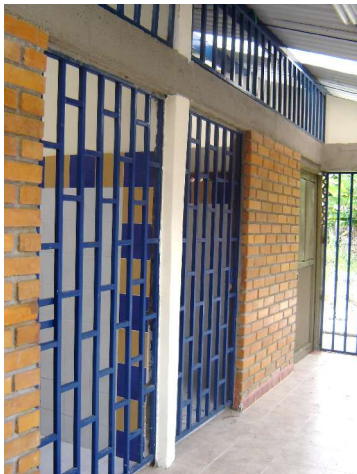
Figura 75. Puertas de los baños.
