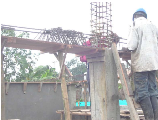
Figura 32. Colocación del refuerzo transversal
