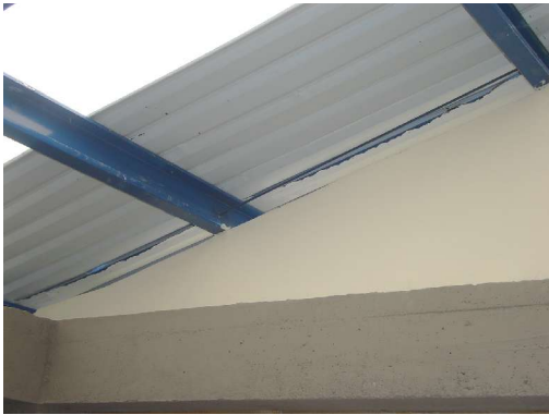
Figura 71. Instalación de tejas
