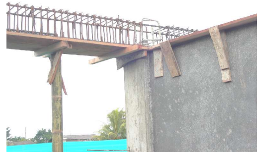
Fig. 33 Formaleta usada durante el fraguado
