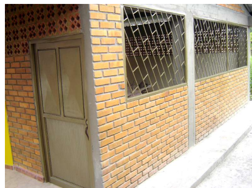
Figura 74. Puertas y ventanas en hierro
