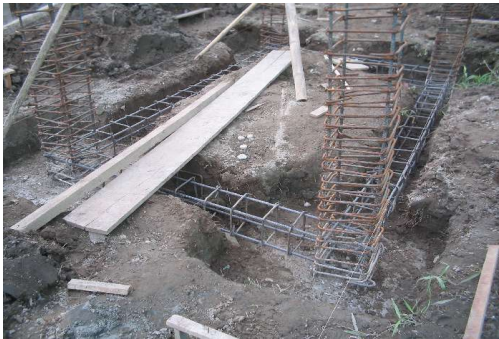
Figura 54. Cimiento del tanque elevado
