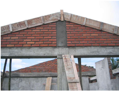
Figura 36. Encofrado de la cinta de culata
