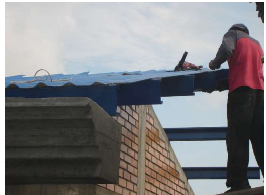
Figura 72. Fijado de tejas mediante pernos
