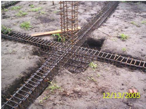
Figura 18. Refuerzo de la viga de cimentación.
