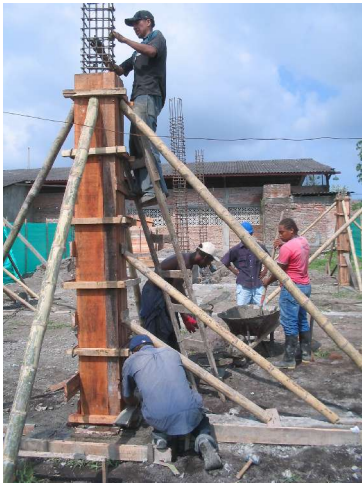
Figura 27. Vertimiento del concreto
