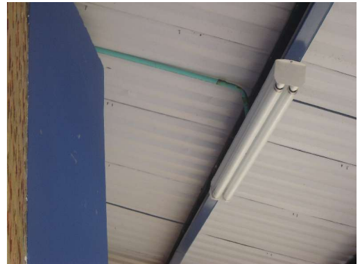
Fig. 60 Instalación de un punto eléctrico
