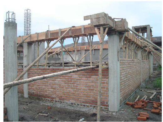
Figura 13. Formaleta de viga aérea.
