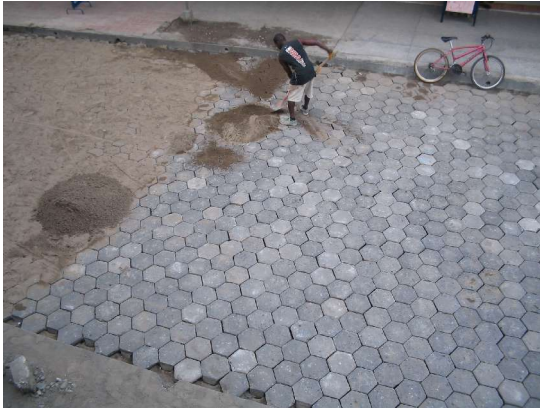
Figura 84. Relleno de material compactante
