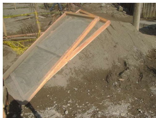
Figura 9. Separación de agregados.
