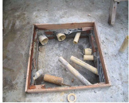
Figura 39. Caja de inspección
