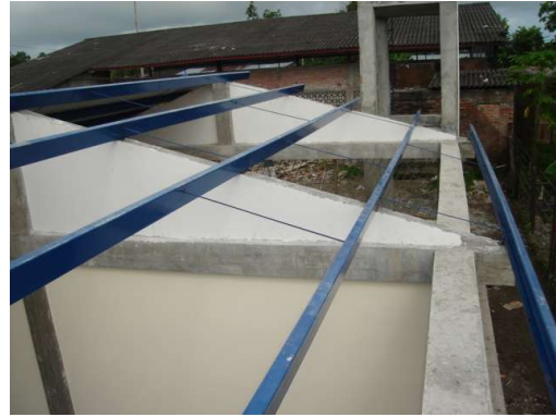
Figura 67. Tirantes y correas apoyadas en la culata
