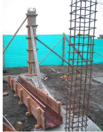
Figura 23. Refuerzo Transversal
