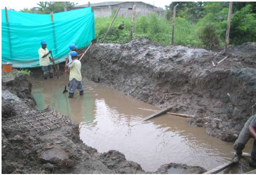
Figura 43. Excavación para tanques de tratamiento
