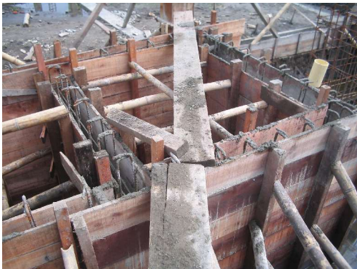
Figura 49. Acceso para el vertido del concreto
