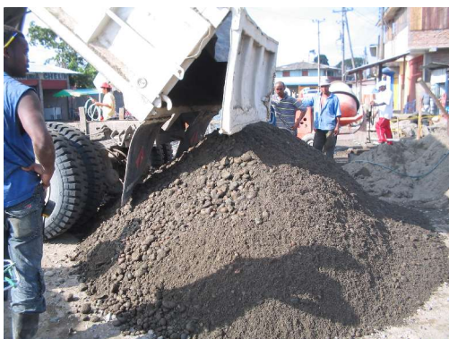
Figura 8. Suministro de material del río.
