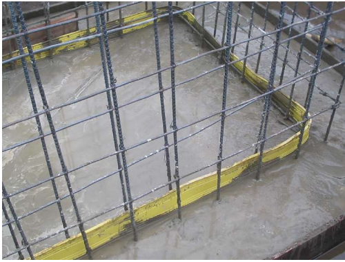
Figura 47. Instalación de cinta PVC
