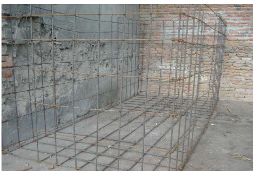
Figura 45. Elaboración de la malla pre-instalada
