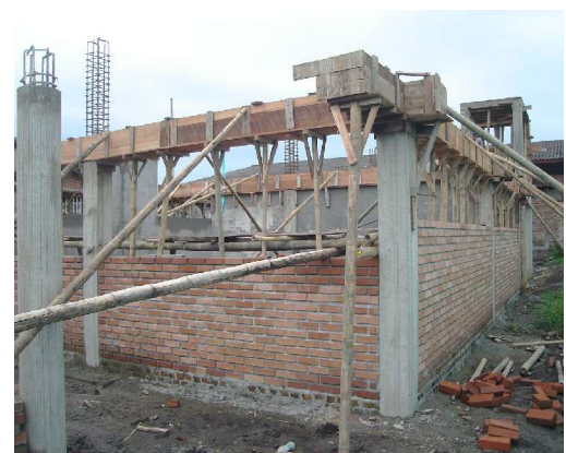
Figura 35. Reforzamiento de la formaleta
