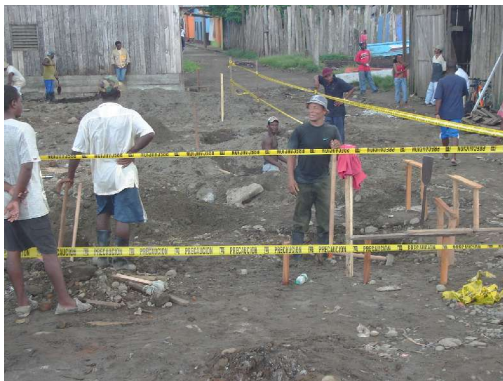
Figura 5. Localización y Replanteo
