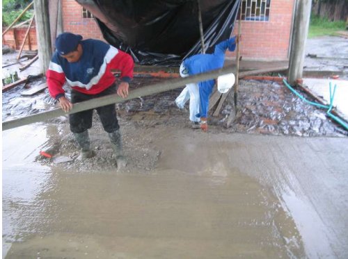
Figura 21. Conformación de la losa de contrapiso.
