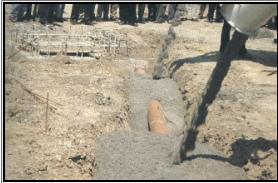
Figura 4. Relleno de una zanja después de la instalación de una tubería
