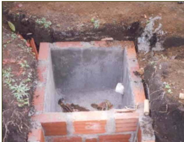
Figura 23. Elaboración cajas de inspección
