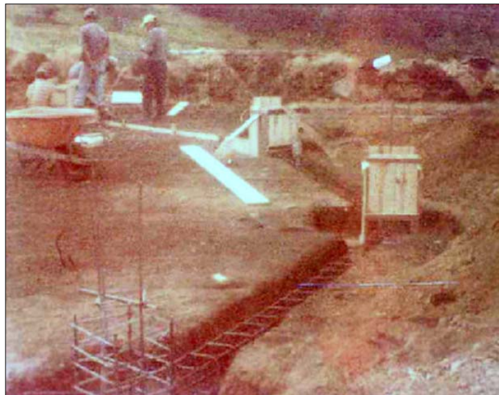
Figura 26. Sistema de cimentación maloca
