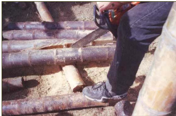
Figura 8. Detalle corte y unión de la guadua
