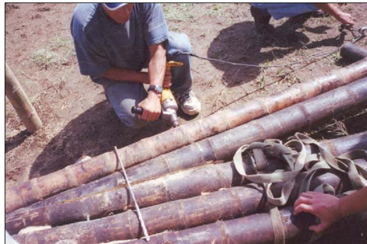
Figura 10. Perforación y refuerzo en las uniones
