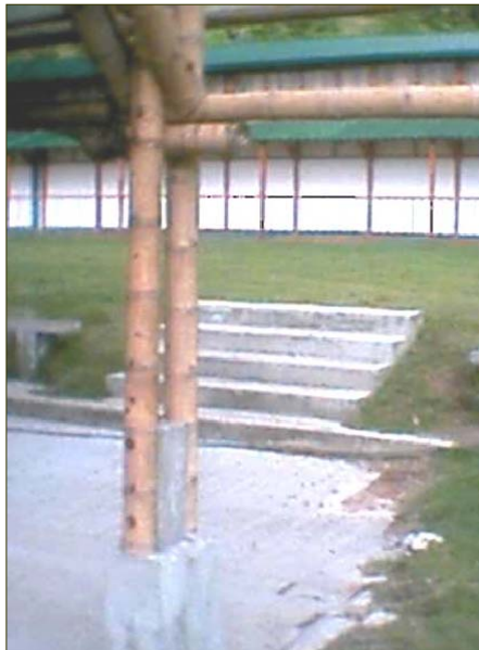
Figura 33. Unión columna en guadua-cimiento
