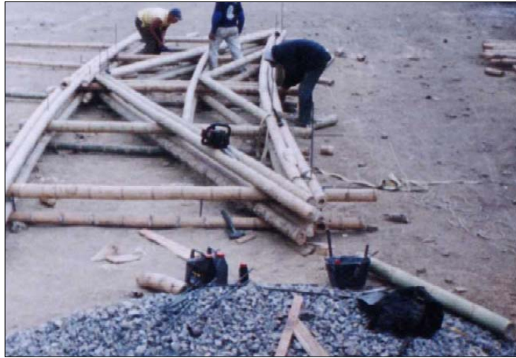
Figura 7. Proceso para armar los arcos
