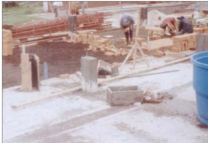
Figura 31. Construcción piso en ladrillo adoquinado
