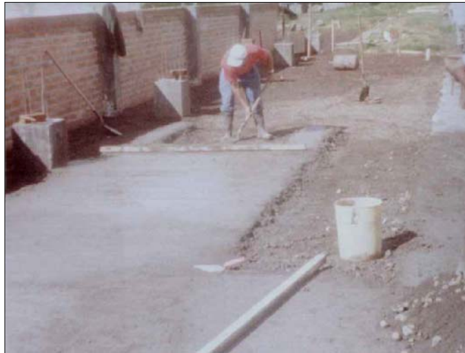
Figura 34. Ejecución loseta de contrapiso
