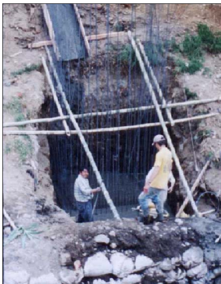
Figura 2. Excavación para estribos
