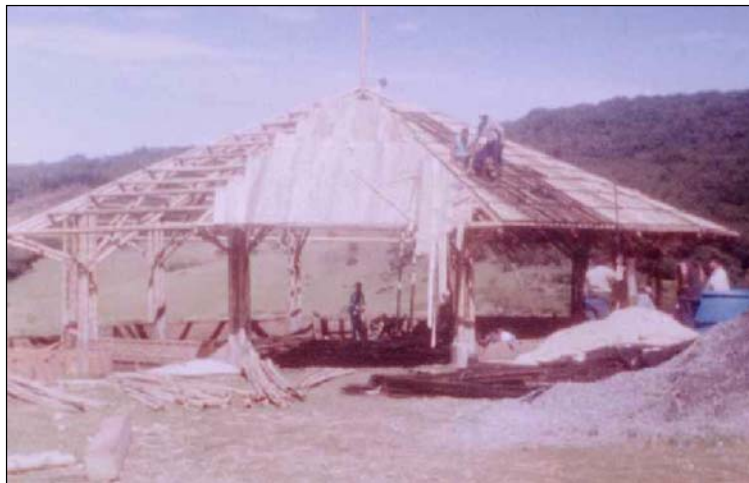
Figura 27. Composición de cubierta y sus conexiones
