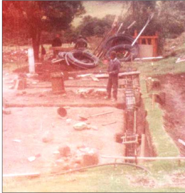
Figura 20. Sistema de cimentación restaurante campesino
