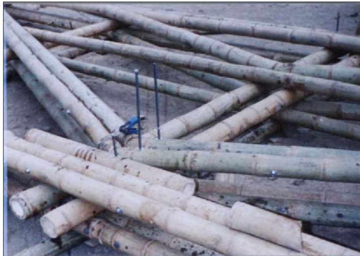
Figura 16. Armado de arcos exteriores y colocación de pernos
