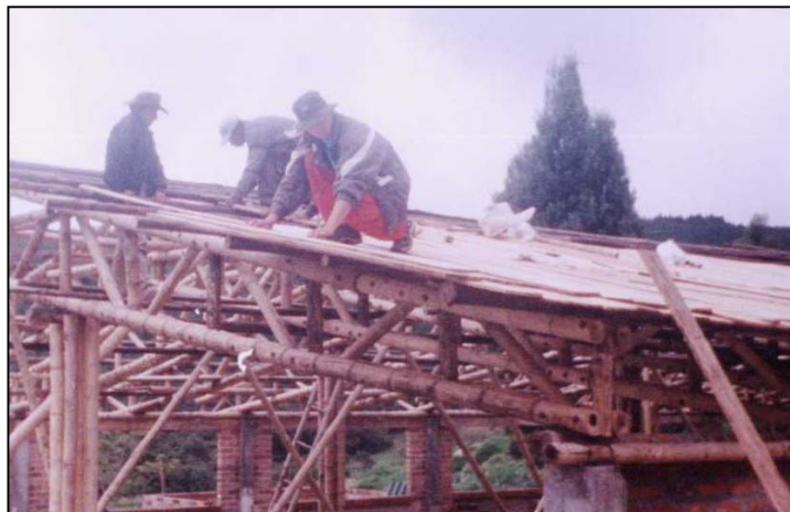
Figura 24. Montaje cubierta Restáurate Campesino
