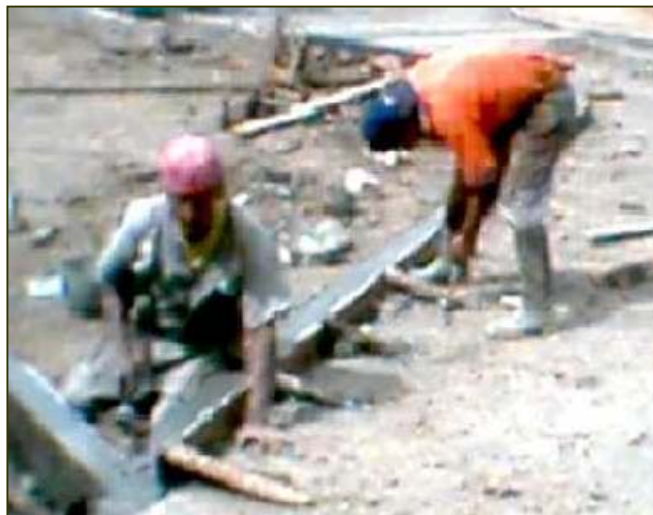
Figura 3. Detalle construcción de andenes
