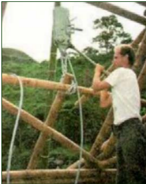
Figura 18. Izaje de cerchas puente peatonal Toledo
