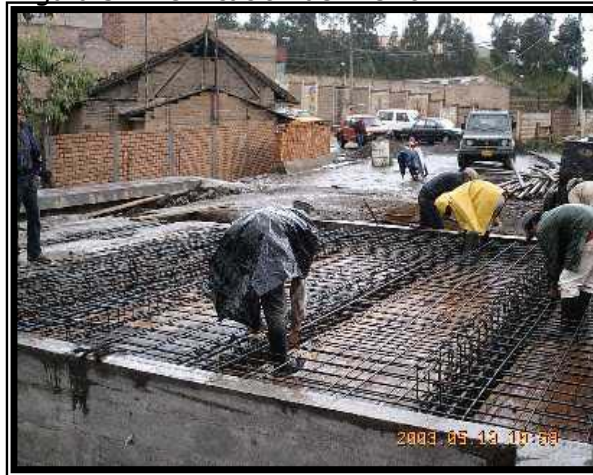
Figura 32. Verificación del hierro
