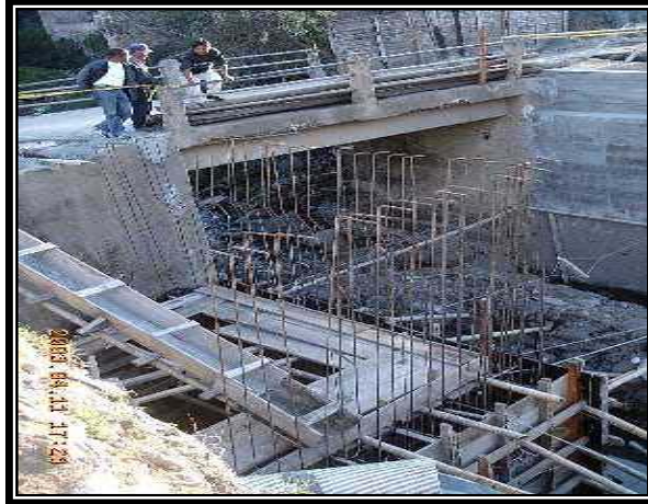
Figura 25. Formaleta de estribo
