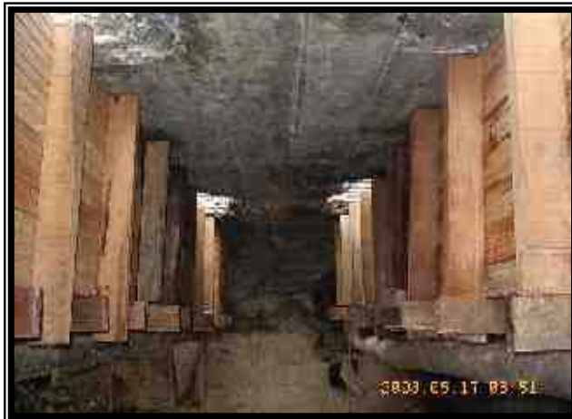
Figura 12. Colocación de formaleta
