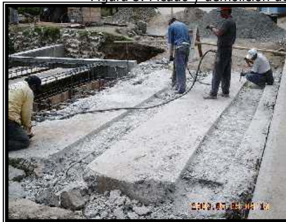
Figura 3. Picado y demolición del tablero
