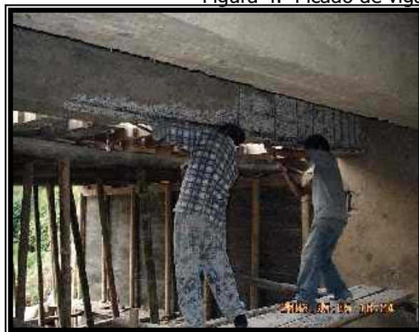
Figura 4. Picado de vigas.
