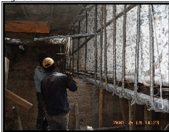
Figura 10. Corte y doblado de hierro
