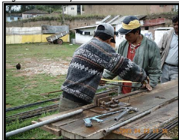
Figura 10. Corte y doblado de hierro
