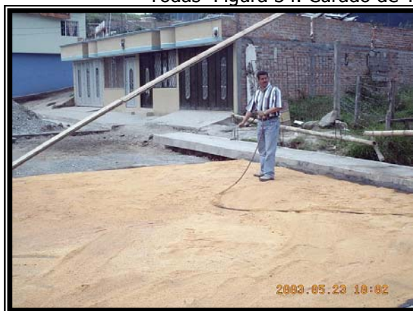
Todas Figura 34. Curado de Tablero
