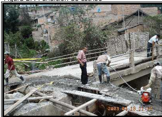
Figura 28. Terminación de estribo
