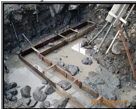
Figura 22. Construcción de cimiento del estribo
