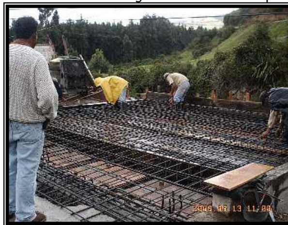
Figura 31. Armado de parrilla
