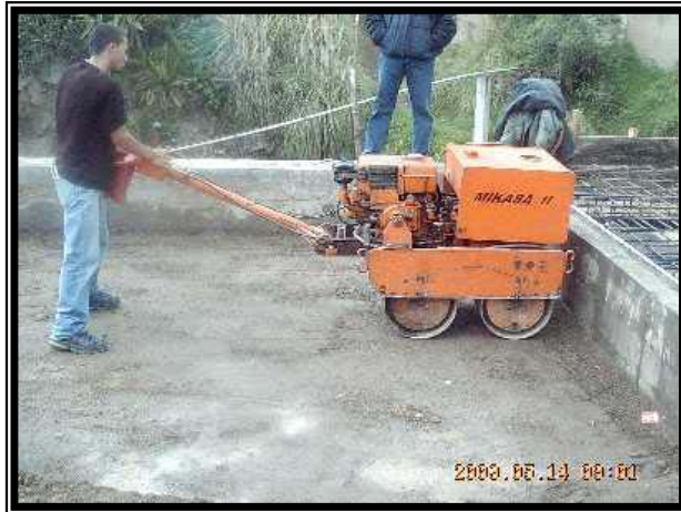
Figura 18. Compactación de relleno con saltarín
