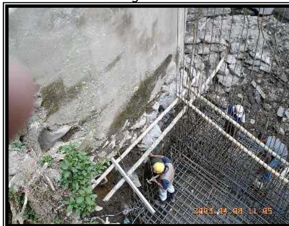
Figura 24. Armado de refuerzo
