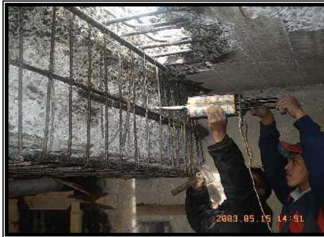
Figura 7. Aplicación de pegante
