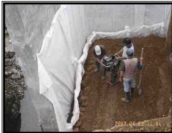
Figura 19. Compactación de relleno con rodillo
