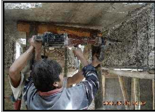
Figura 5. Perforación de orificios
