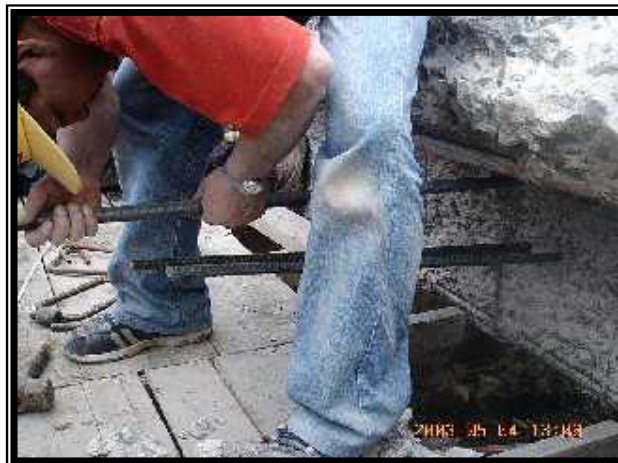
Figura 8. Colocación de anclajes y conectores
