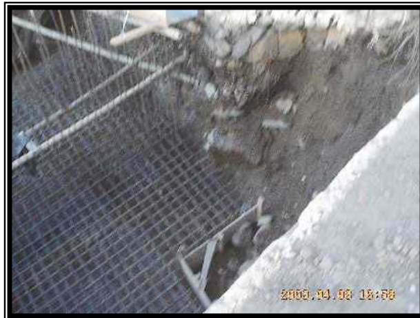
Figura 23. Construcción de parrilla.
