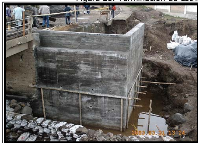
Figura 28. Terminación de estribo
