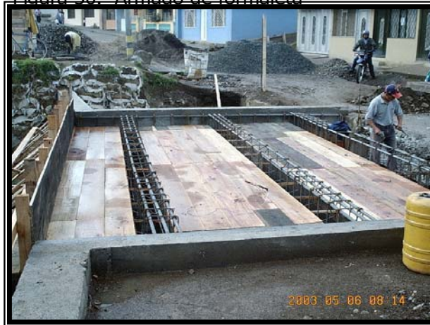
Figura 30. Armado de formaleta
