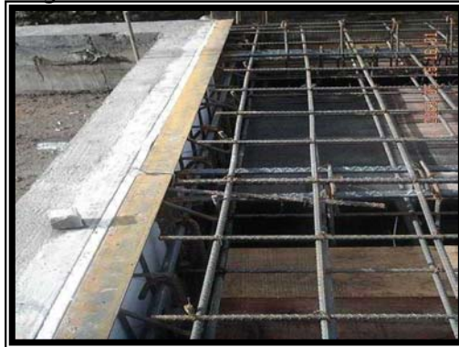
Figura 36. Junta de dilatación
