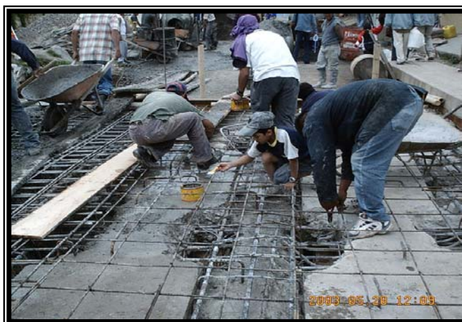
Figura 11. Aplicación de sikadur 32
