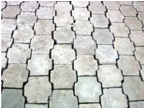
Figura 34. Patrón de colocación de adoquín
