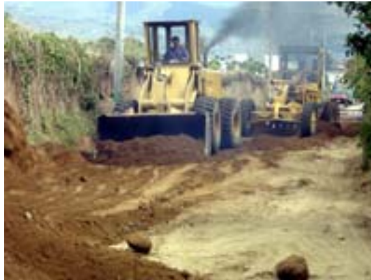
Figura 41. Conformación de la sub-rasante
