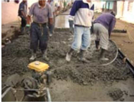
Figura 12. Fundición de placa en concreto rígido
