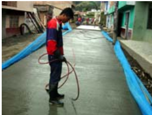
Figura 14. Curado del concreto
