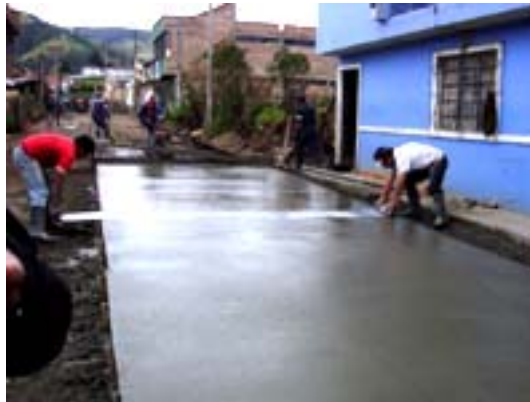
Figura 14. Curado del concreto
