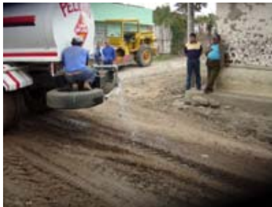
Figura 32. Riego de la base con el carro tanque irrigador
