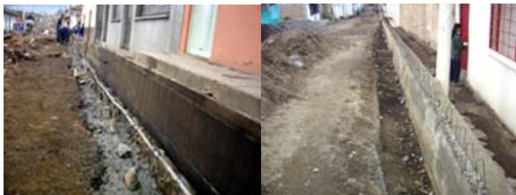
Figura 46. Cimentación de los sardineles en concreto ciclópeo
