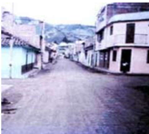
Figura 10. Calle caliente sin pavimentar
