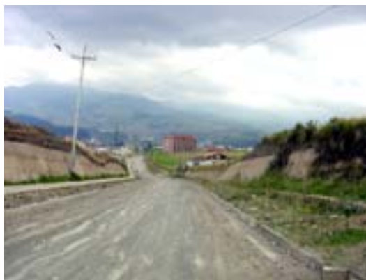
Figura 17. Estado inicial de la vía
