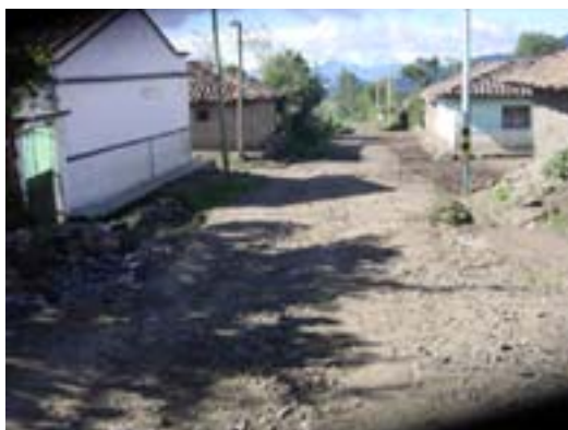
Figura 30. Vía antes de adoquinar
