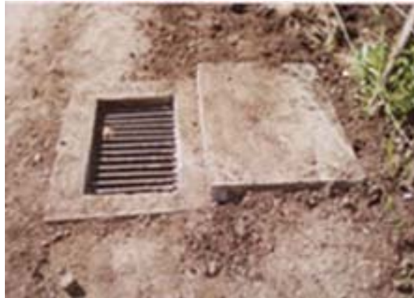
Figura 6. Sumidero construido según modificación
