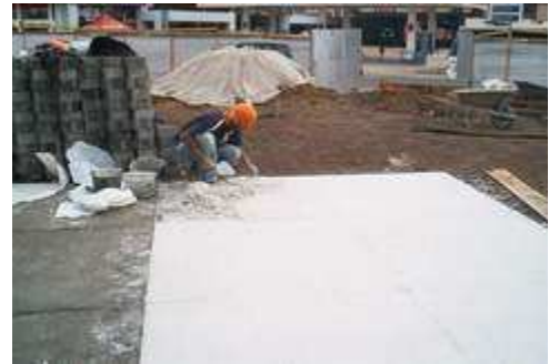
Figura 31. Acabado de granito con pulidora eléctrica de piedras gruesas
