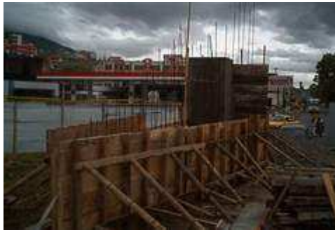
Figura 38. Abusardado de muros de pedestal
