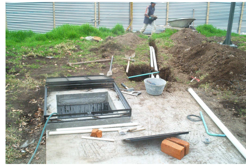
Figura 109. Instalación ductos en PVC 2" (2 unidades).
