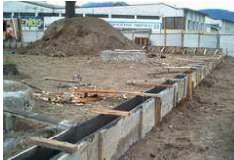
Figura 78. Fundición sardinel h=0,25m
