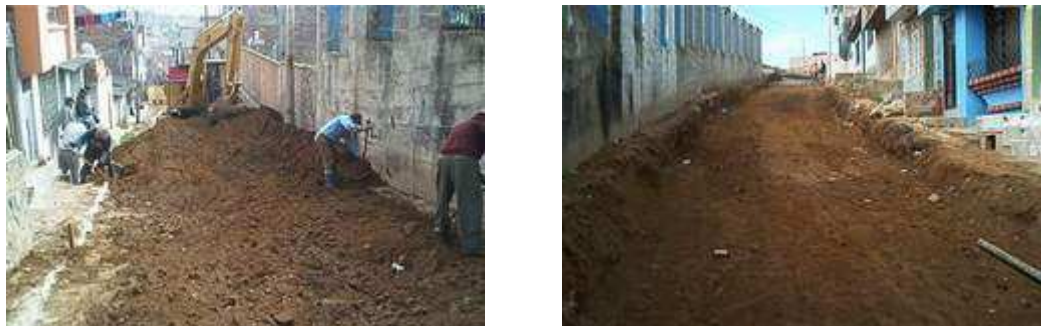
Figura 134. Excavación a máquina y Adecuación de la sub-rasante.
