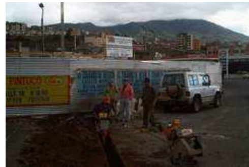
Figura 110. Excavación, relleno y compactación zanja.
