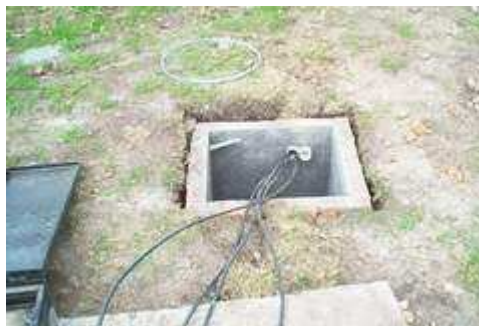
Figura 98. caja de 0,40m x 0,40m x 0,40m.
