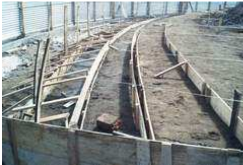
Figura 43. Formaleta para escalinatas
