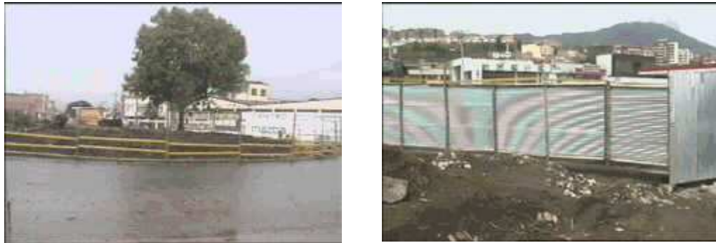
Figura 8. Cerramiento en guadua y lámina de zinc
