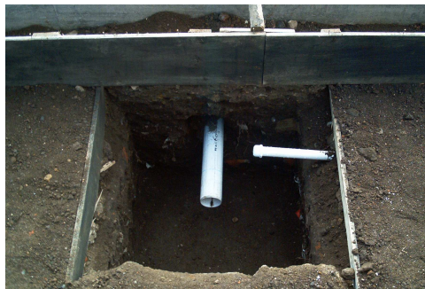
Figura 64. Instalación tubos PVC para succión de la moto-bomba y llenado de la fuente
