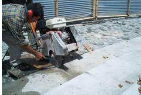
Figura 91. Corte de juntas de dilatación para escalinatas.
