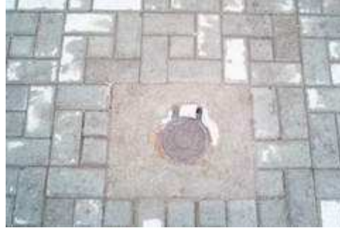
Figura 94. Reposición de tapas de válvulas.
