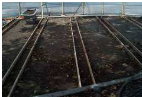
Figura 39. Formaleta para franjas plazoleta e=0.08m
