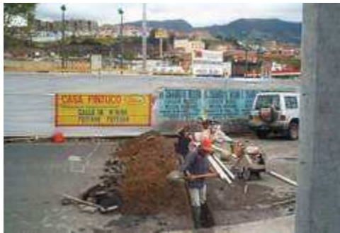
Figura 110. Excavación, relleno y compactación zanja.
