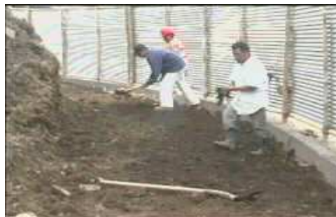
Figura 13. Excavación manual y adecuación de la sub-rasante
