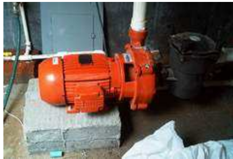
Figura 106. Instalación moto-bomba.
