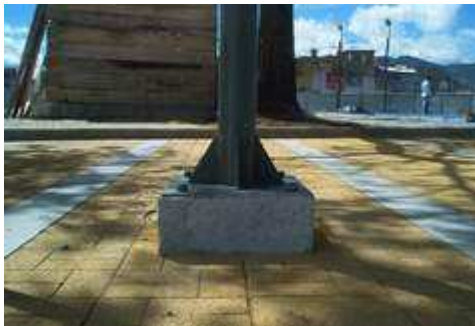
Figura 58. Pedestal en concreto para poste metálico
