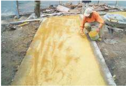
Figura 42. Estampado del concreto con plantillas metálicas
