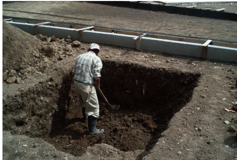
Figura 20 Excavación cuarto de maquinas
