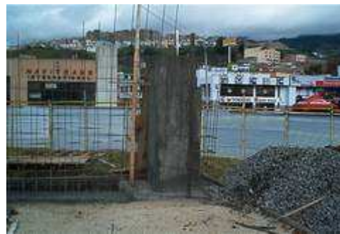
Figura 85. Columna de 0,85m x 0,85m (apoyo mástil de iluminación)
