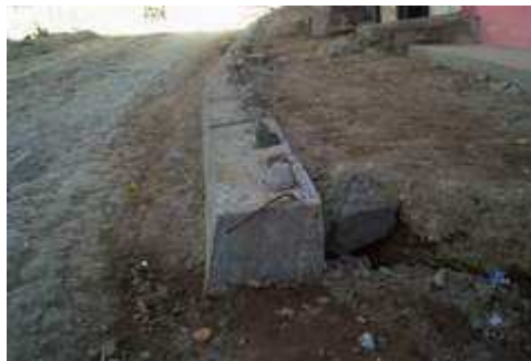
Figura 138. Muro de contención en concreto ciclópeo y varillas de anclaje.
