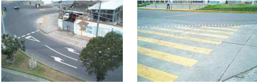
Figura 131. Pintura señalización de tránsito.
