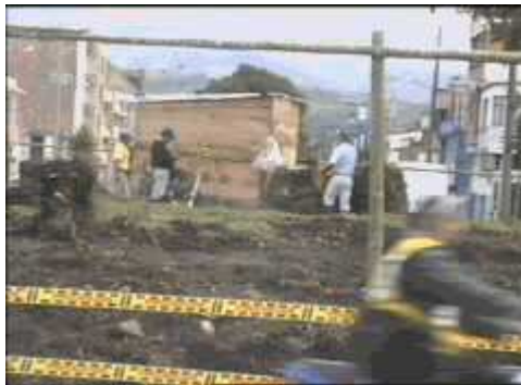
Figura 22. Localización y replanteo.
