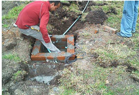
Figura 119. Instalación cable de cobre N° 10 AWG.
