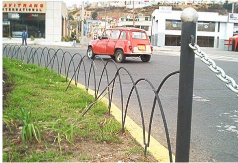
Figura 121. Serpentina en varilla de ½” corrugada, anclada en concreto y pintada.
