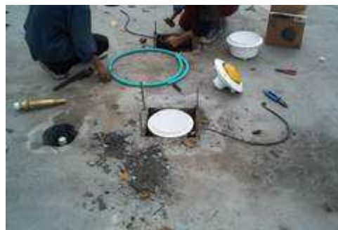
Figura 114. Instalación cable de cobre N° 2 THW.
