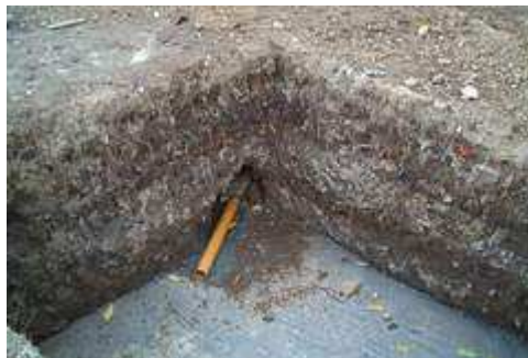
Figura 65. Instalación tubo de desagüe de la fuente
