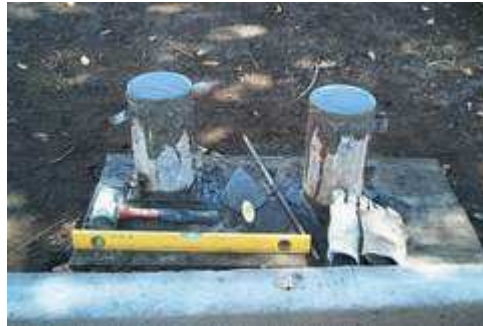
Figura 45. Toma de cilindros de concreto de 2500psi para escalinatas
