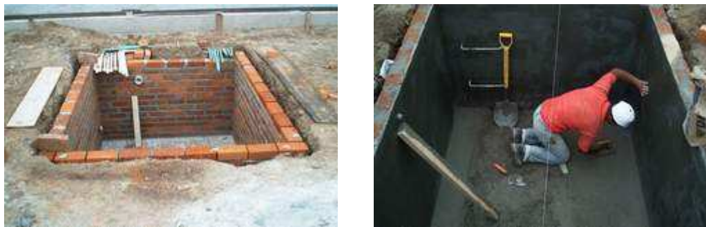
Figura. 69. Fundición losa para cuarto de máquinas
