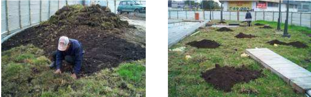
Figura 72. Instalación cespedón con tierra negra.
