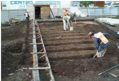
Figura 17. Excavación para tendido de ductos eléctricos e hidráulicos de la fuente
