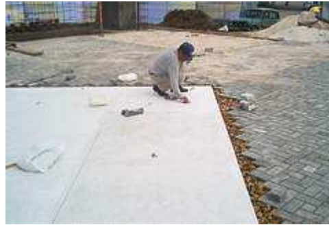
Figura 33. Remate de granito con cera para piso de color blanco.
