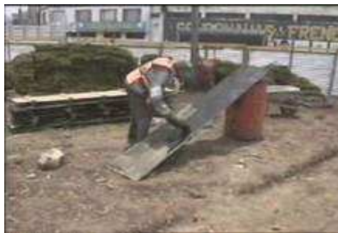
Figura 46. Aplicación de aceite quemado como desmoldante para formaleta de sardinel h=0,45m.
