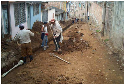
Figura 135. Excavación a mano material conglomerado
