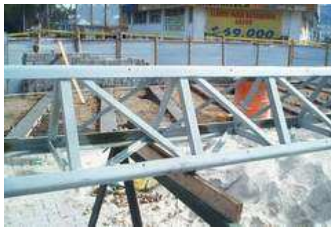
Figura 53. Instalación de módulos en acero inoxidable para mástil de iluminación.
