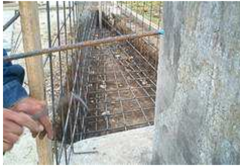
Figura 37. Formaleta para muros de pedestal
