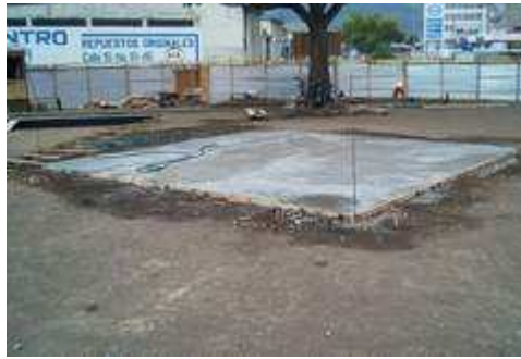
Figura 80. Placa 3000psi e=0,08m, base para granito pulido
