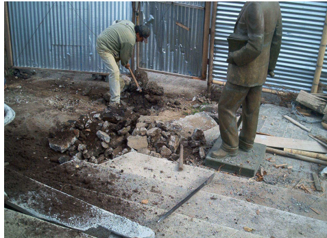
Figura 12. Demolición manual de andenes
