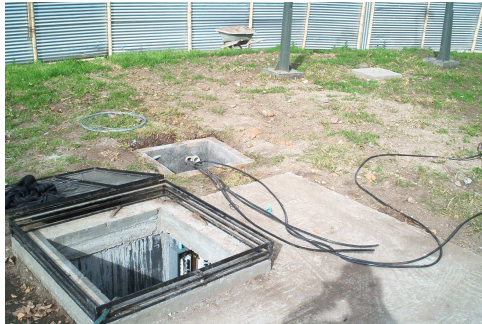
Figura 115. Instalación cable de cobre N° 1/0 THW.
