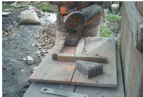
Figura 75. Corte de piezas de adoquín.
