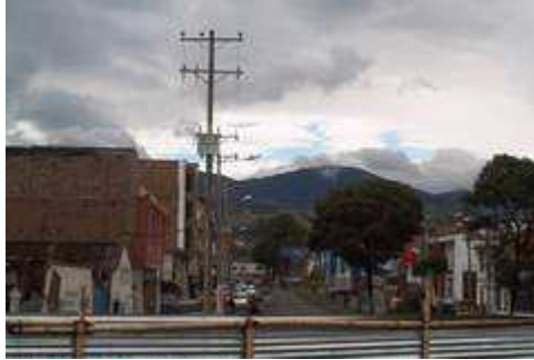
Figura 105. Instalación transformador de 30kva.
