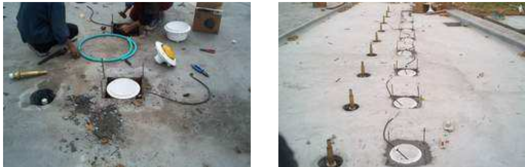
Figura 101. Instalación reflectores acuáticos.
