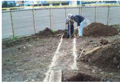
Figura 19. Excavación para tubo de desagüe de la fuente
