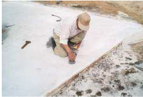
Figura 33. Remate de granito con cera para piso de color blanco.
