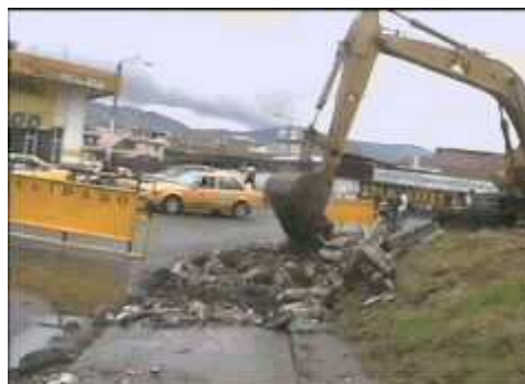
Figura 11. Demolición de andenes a máquina y señalización preventiva
