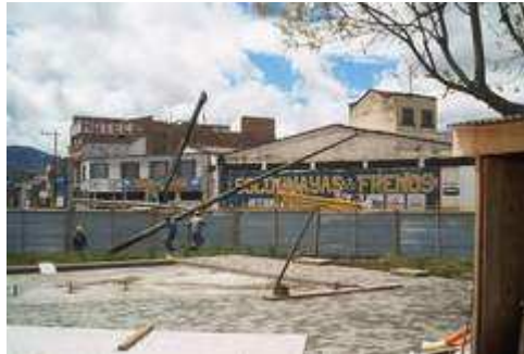
Figura 96. Retiro de poste interno ubicado en la Glorieta Julián Bucheli
