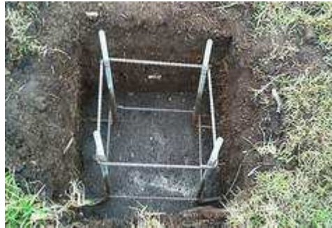
Figura 58. Pedestal en concreto para poste metálico
