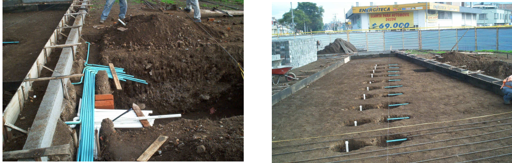
Figura 64. Instalación tubos PVC para succión de la moto-bomba y llenado de la fuente
