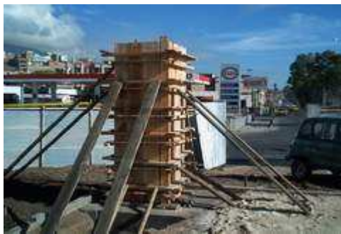
Figura 85. Columna de 0,85m x 0,85m (apoyo mástil de iluminación)
