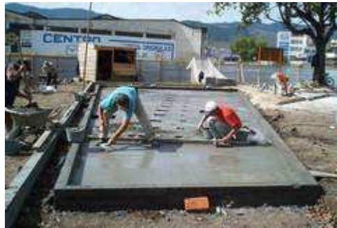
Figura 88. Repello y afinado para fuente.
