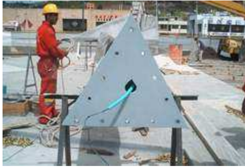
Figura 55. Pernos de anclaje para fijar placa base de ½"
