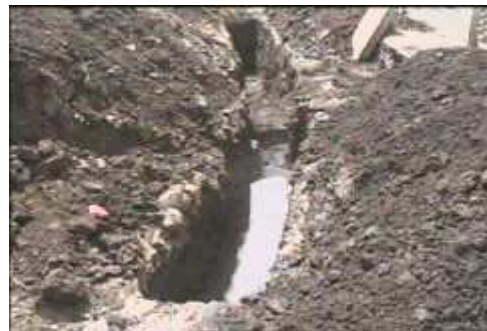
Figura 14. Excavación zanja para acometida hidráulica
