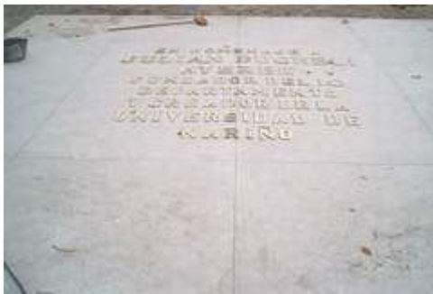
Figura 104. Suministro e instalación de letras en bronce.
