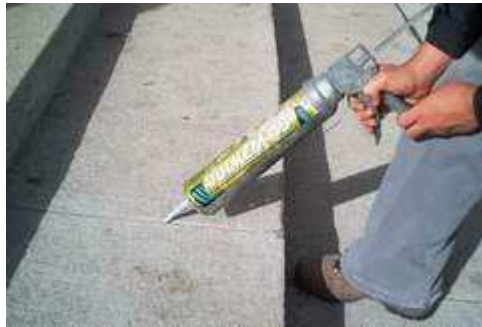
Figura 92. Sellado de juntas de dilatación.
