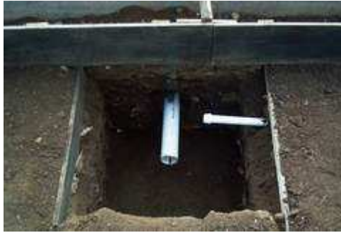
Figura 18. Excavación para poso de succión de la moto-bomba
