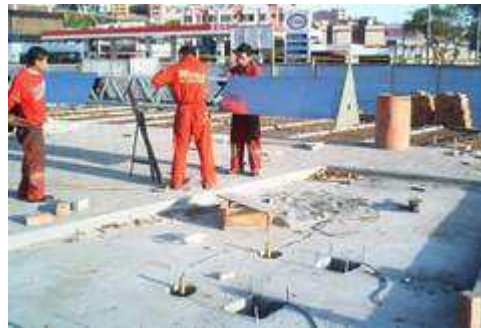
Figura 53. Instalación de módulos en acero inoxidable para mástil de iluminación.
