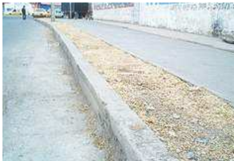
Figura 129. Sardinel fundido en sitio y anclado h=0,45m .
