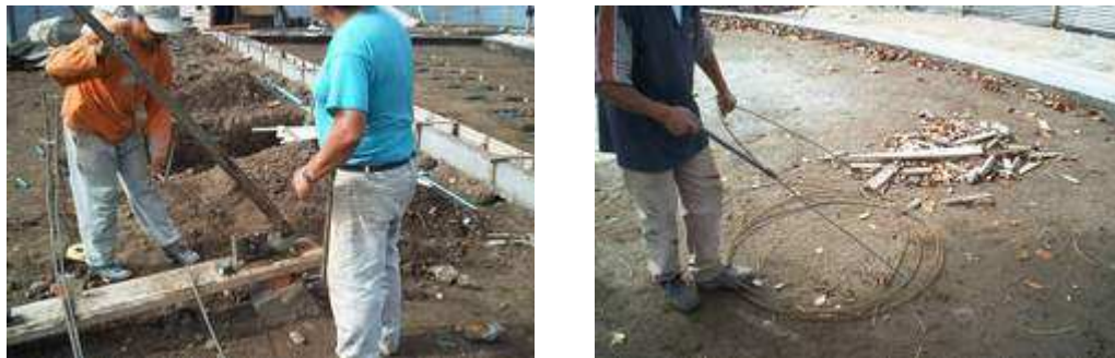
Figura 35. Instalación acero de refuerzo para muros y base de la fuente
