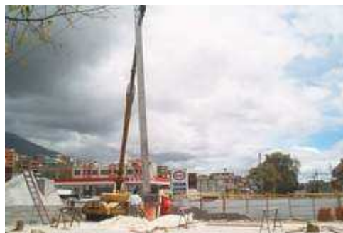
Figura 56. Instalación mástil de iluminación con ayuda de maquina montacargas
