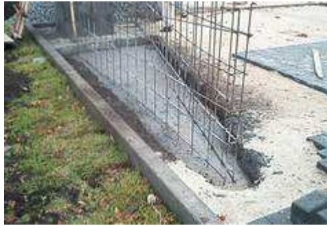
Figura 84. Fundición zapata para pedestal
