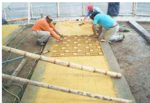
Figura 42. Estampado del concreto con plantillas metálicas
