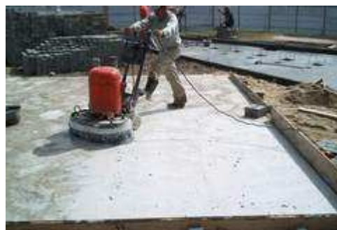
Figura 31. Acabado de granito con pulidora eléctrica de piedras gruesas
