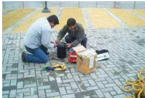
Figura 120. Instalación reflector dispersivo.
