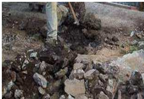
Figura 126. Demolición de andenes en concreto
