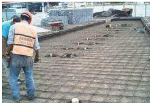
Figura 35. Instalación acero de refuerzo para muros y base de la fuente
