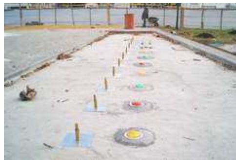
Figura 101. Instalación reflectores acuáticos.
