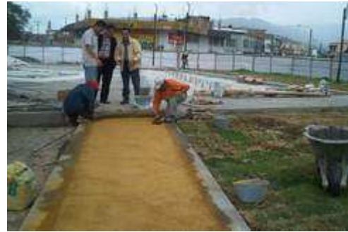
Figura 42. Estampado del concreto con plantillas metálicas
