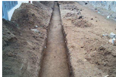
Figura 135. Excavación a mano material conglomerado
