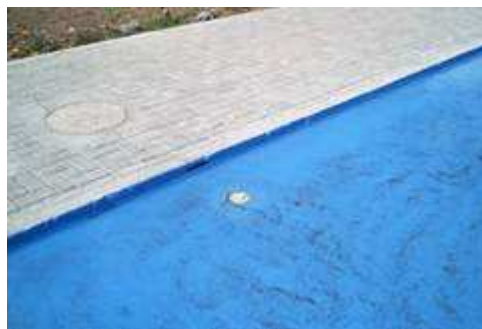
Figura 89. Mediacaña en mortero para fuente.
