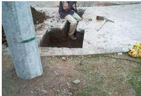
Figura 113. Excavación caja de inspección de 0,70m x 0,70m x 0,90m.
