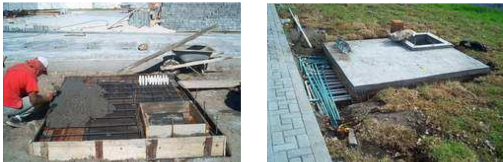
Figura. 69. Fundición losa para cuarto de máquinas
