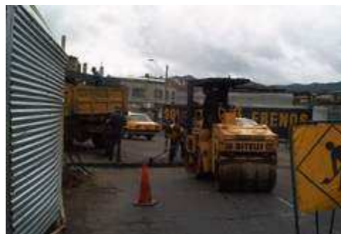
Figura 111. Pavimentación zanja en asfalto.
