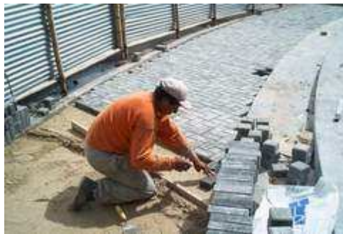
Figura 74. Instalación adoquín
