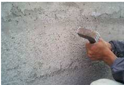
Figura 38. Abusardado de muros de pedestal
