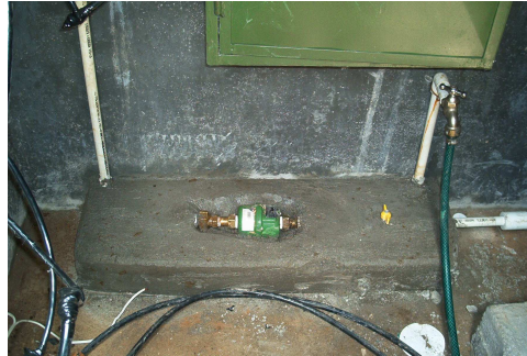
Figura 66. Instalación medidor de agua.
