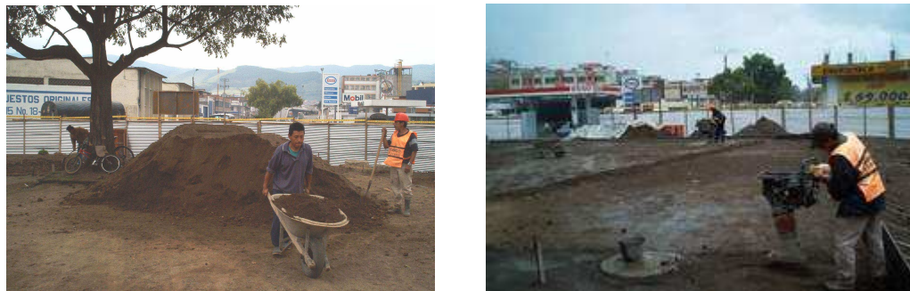
Figura 25. Compactación base en recebo
