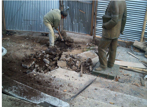
Figura 10 Demolición manual de bordillos
