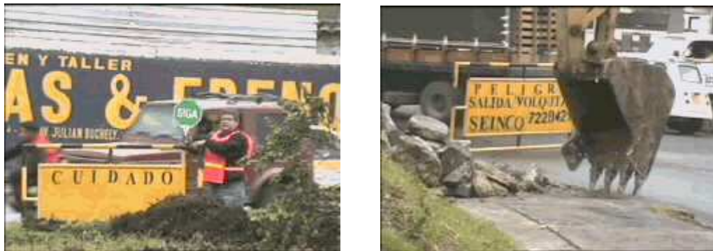
Figura 9. Demolición de bordillos a máquina y señalización preventiva
