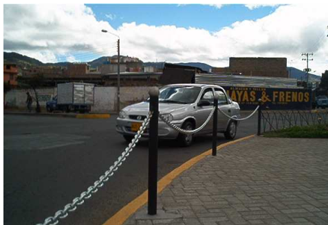
Figura 122. Separador en tubo de ½” estructural y cadena, anclada y pintada.
