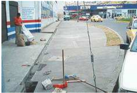
Figura 130. Placa de concreto de 2500psi e=0,06m.
