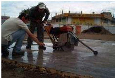
Figura 28. Corte de juntas de dilatación en placa de concreto
