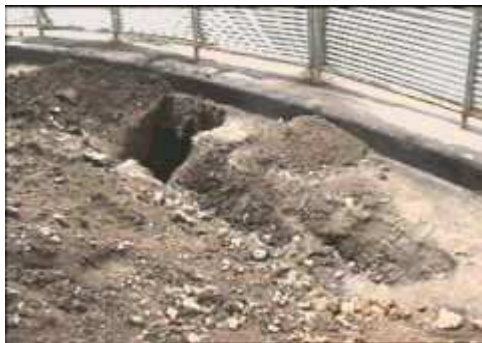
Figura 14. Excavación zanja para acometida hidráulica
