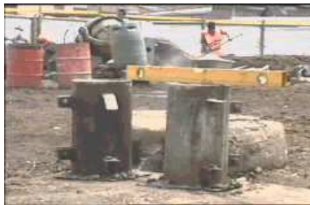
Figura 48. Toma de cilindros del concreto de 2500psi para sardinel h=0,45m
