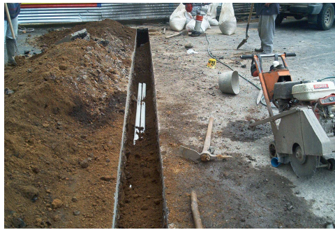
Figura 109. Instalación ductos en PVC 2" (2 unidades).
