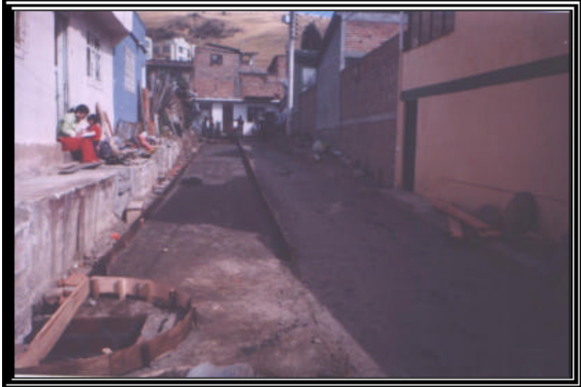
Foto 55 FUNDICIÓN DE PLACA
