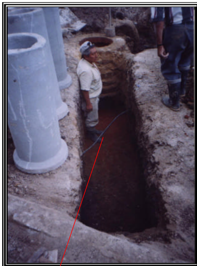
Figura 5. Limpieza zona de instalación de tubería
