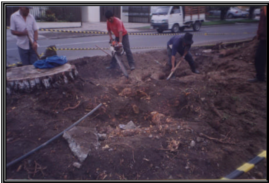
Figura 60. Proceso de desenraizado
