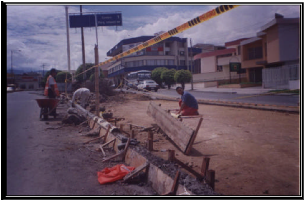
Figura 65. Construcción sardinel
