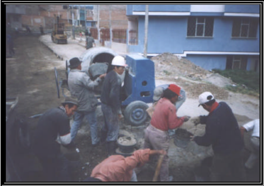
Foto 44 FUNDICIÓN DE PLACA
