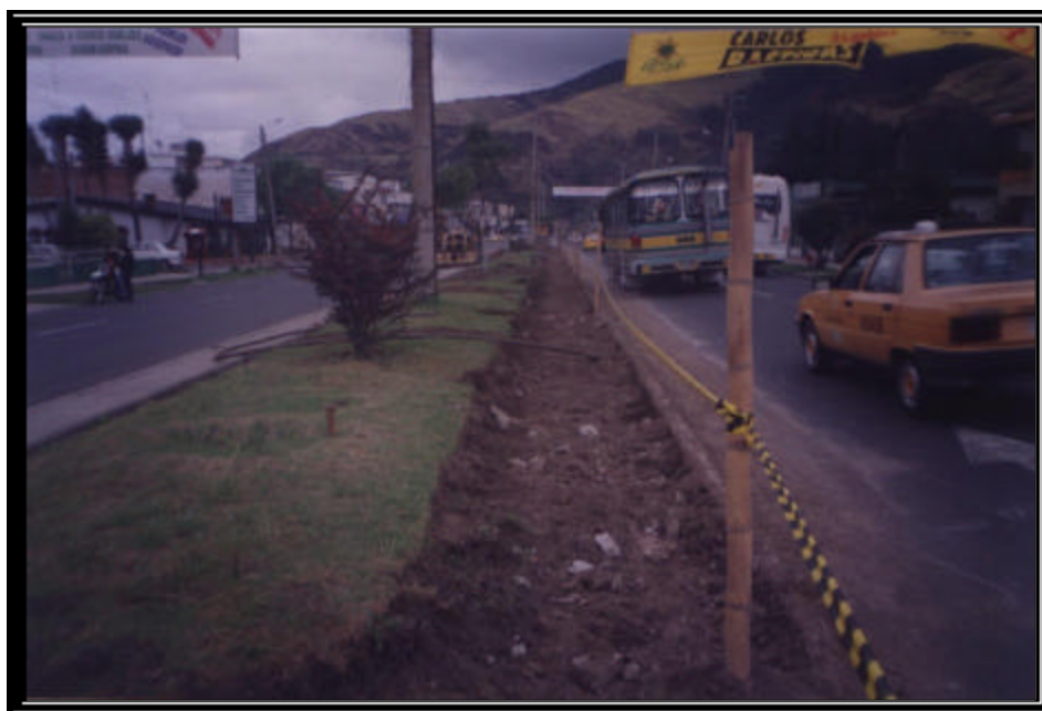
Figura 58. Vista árboles existentes
