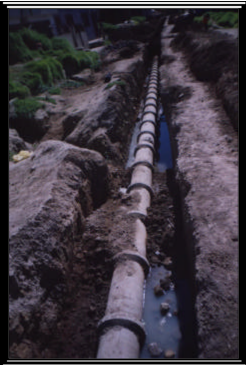
Foto 11 TRAMO INSTALADO TOTALMENTE CON TUBERÍA
