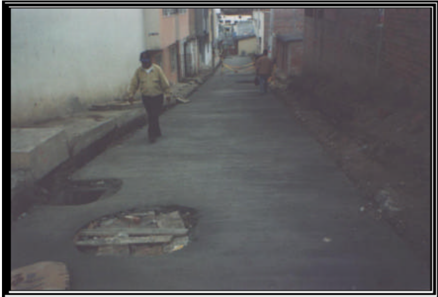
Foto 63 FUNDICIÓN DE PLACA
