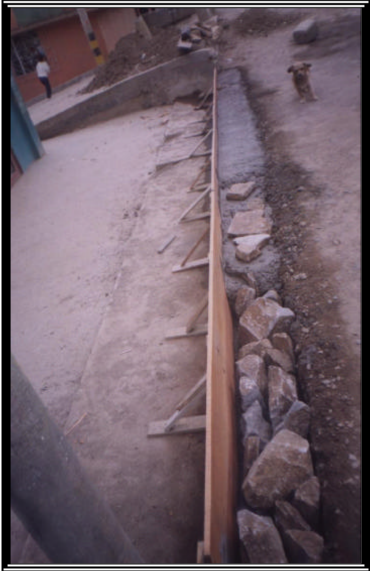
Foto 34 FUNDICIÓN DE MURO DE SOPORTE DE ANDÉN
