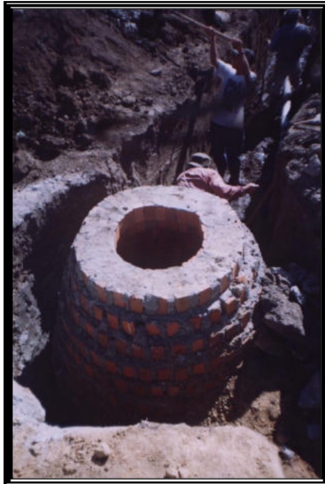
Figura 4. Construcción cámara 1.80 < H < 2.80 mt.
