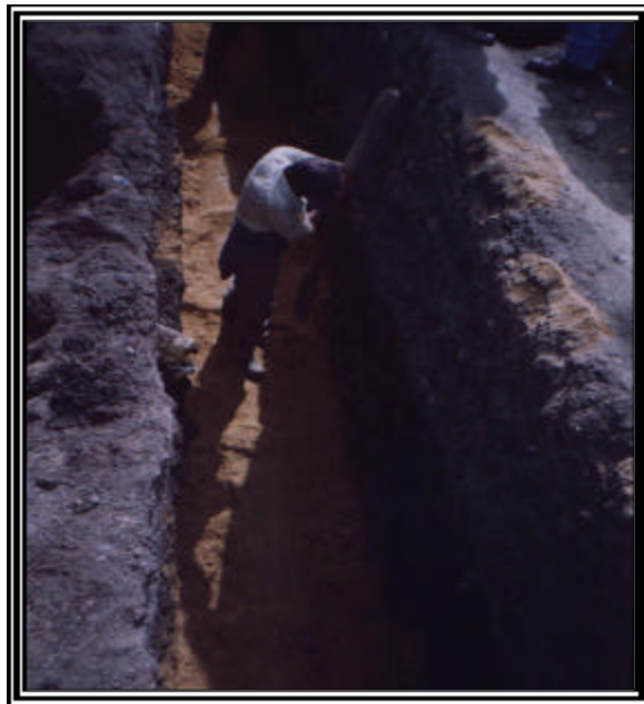
Figura 12. Compactación manual con pisón
