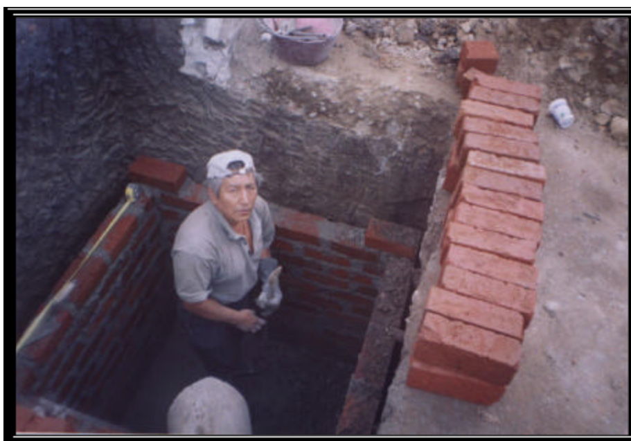
Figura 26. Construcción de sumideros
