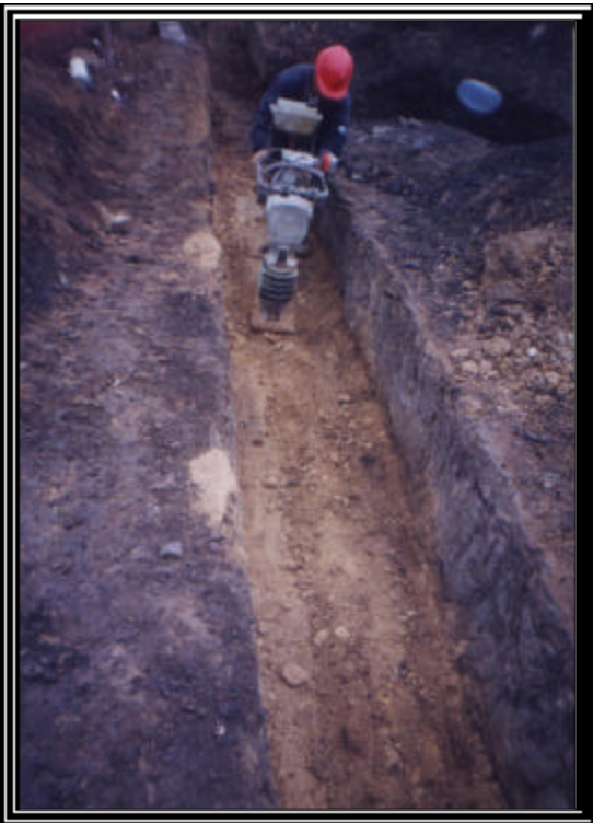
Foto 15 RELLENO COMPACTADO CON SALTARÍN
