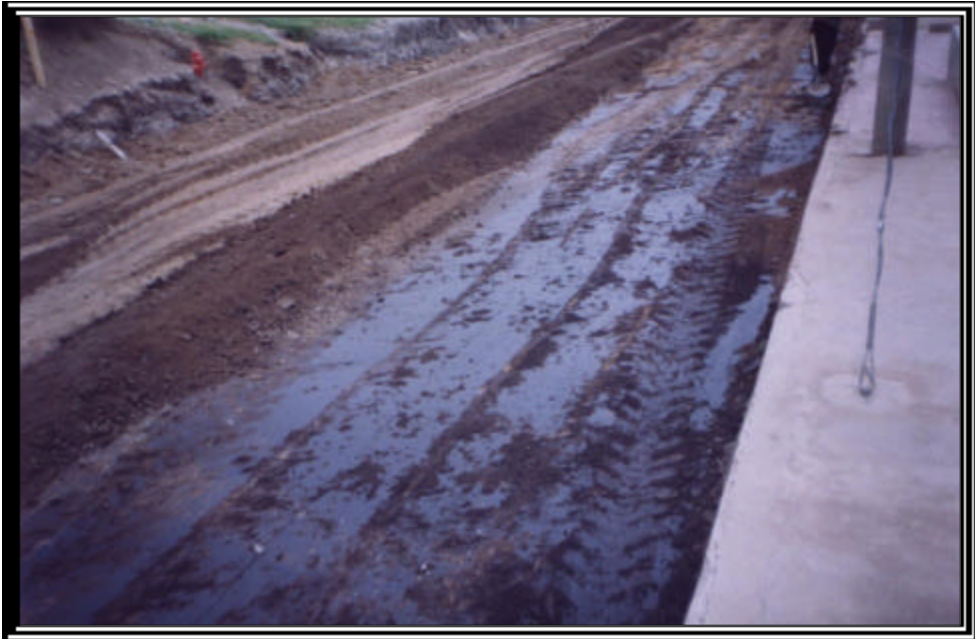
Foto 20 PERFILADO DE SUB – RASANTE
