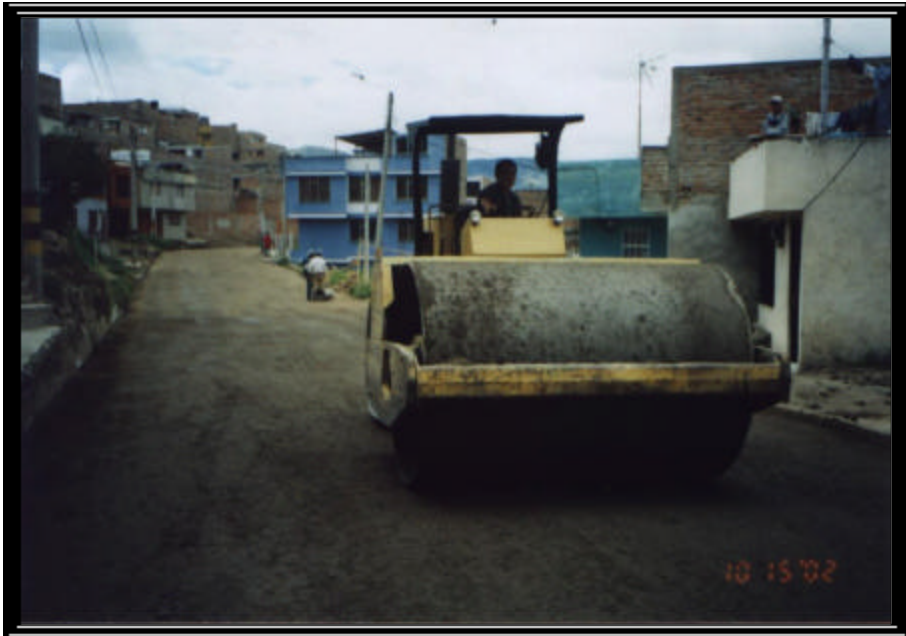
Foto 27 COMPACTACIÓN DE BASE
