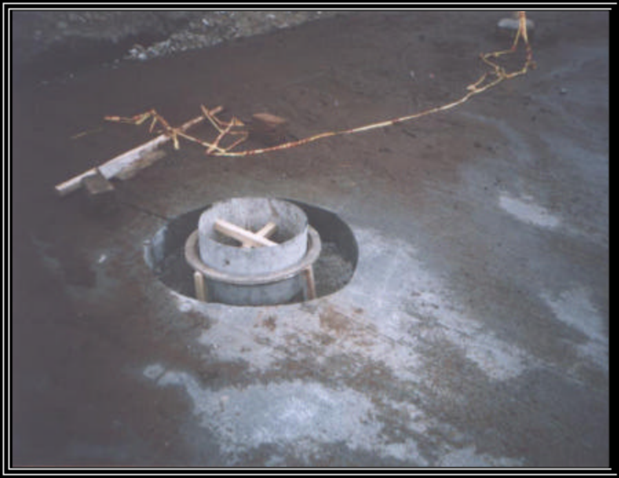
Foto 45 FUNDICIÓN DE ARO
