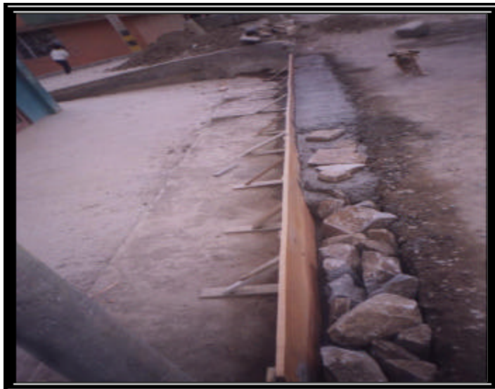
Figura 29. Reparación de andenes
