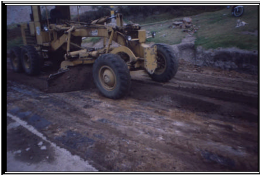
Figura 18. Escarificado y perfilado
