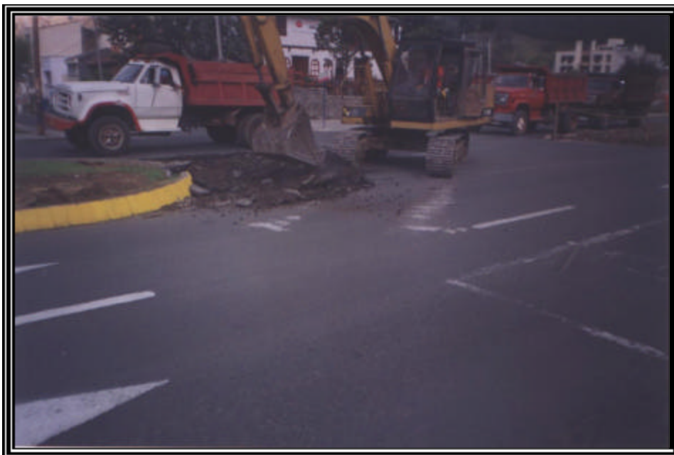
Figura 57. Demolición carpeta retorno
