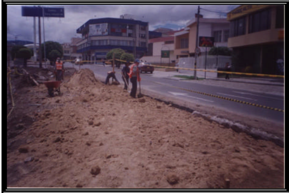
Foto 93 EXTENSIÓN DE MATERIAL DE BASE
