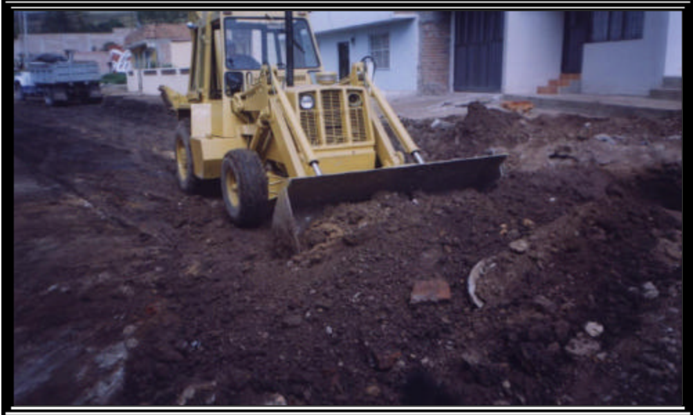
Figura 16. Transporte de material de desalojo
