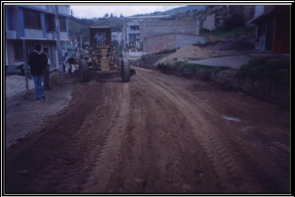
Foto 26 EXTENDIDO DE BASE
