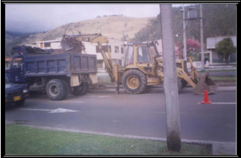
Foto 91 DESALOJO DE ESCOMBROS
