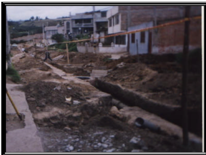
Figura 2. Material de excavación
