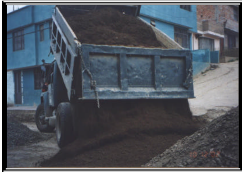
Figura 39. Acopio de arena
