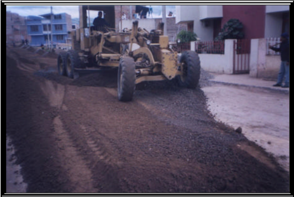
Foto 24 EXTENDIDO DE MATERIAL CON MOTO NIVELADORA
