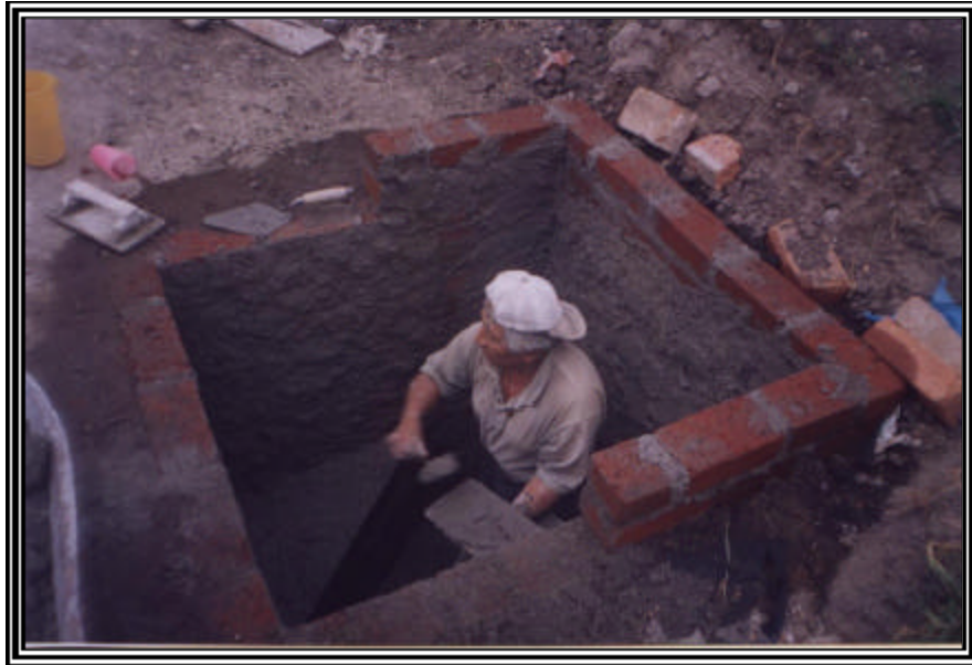
Figura 27. Construcción de sumideros Repello y Terminado
