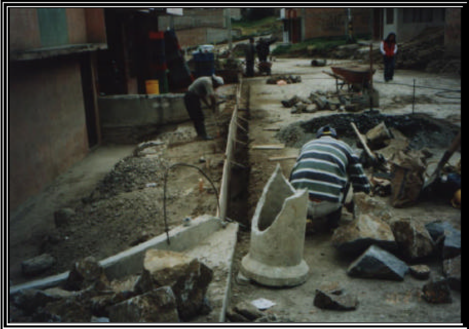
Foto 33 FORMALETEO REPOSICIÓN DE ANDÉN
