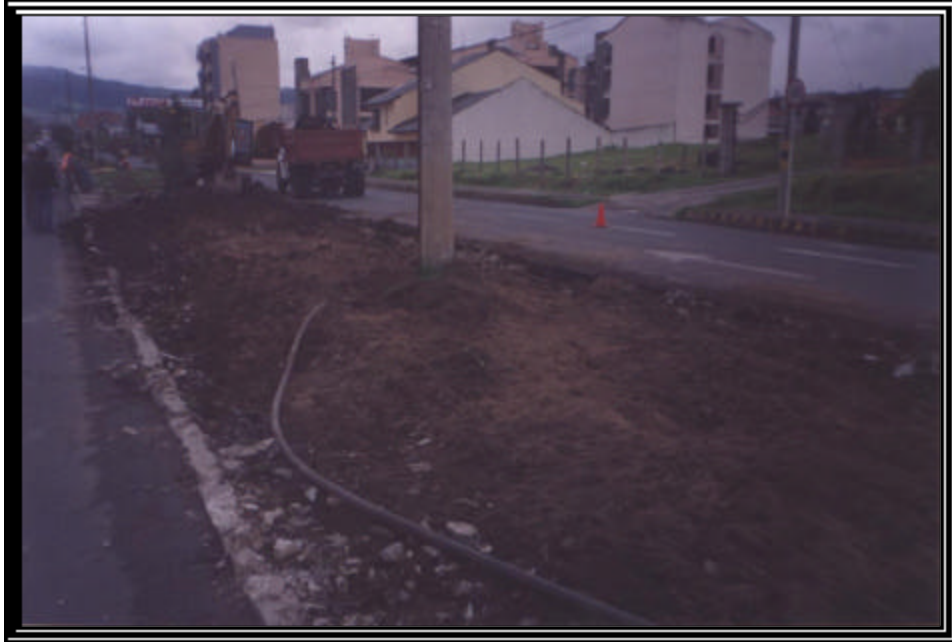
Figura 54. Excavación con retroexcavadora
