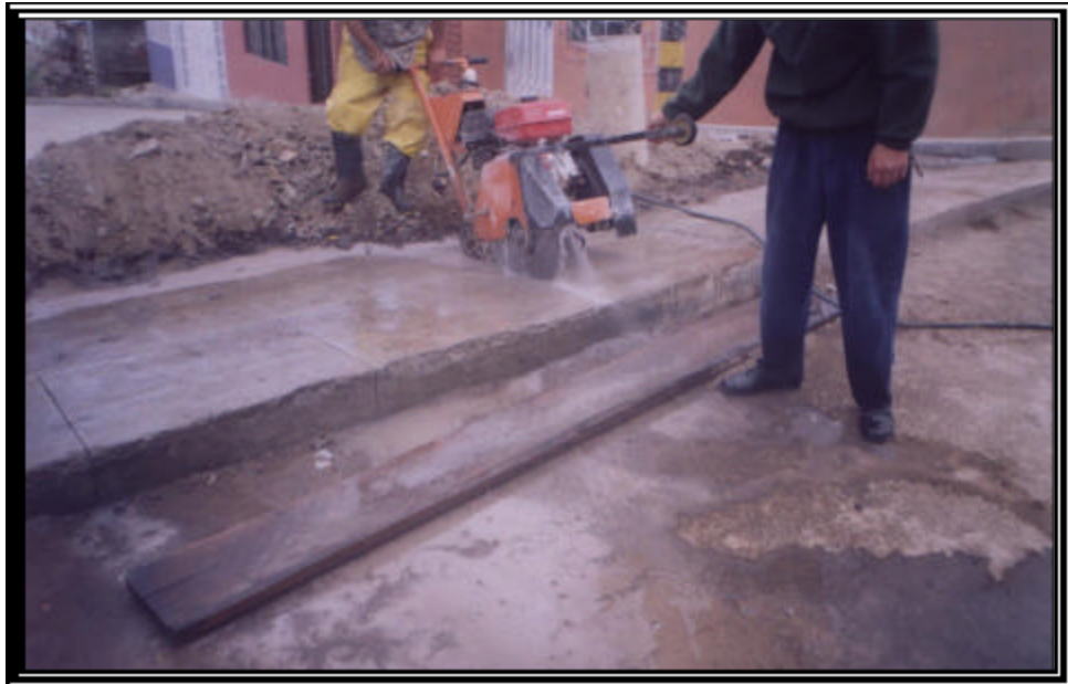
Figura 30. Corte en pavimento para demolición
