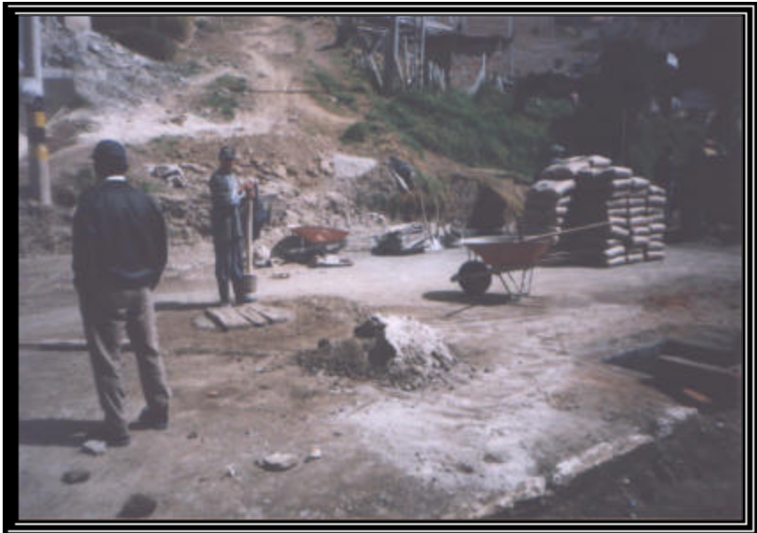
Foto 31 PROTECCIÓN DE CÁMARA - PREVIA FUNDICIÓN
