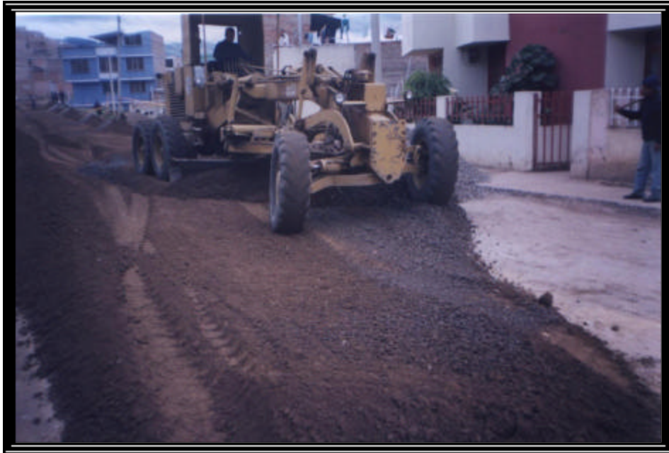
Figura 22. Mezclado de triturado y recebo
