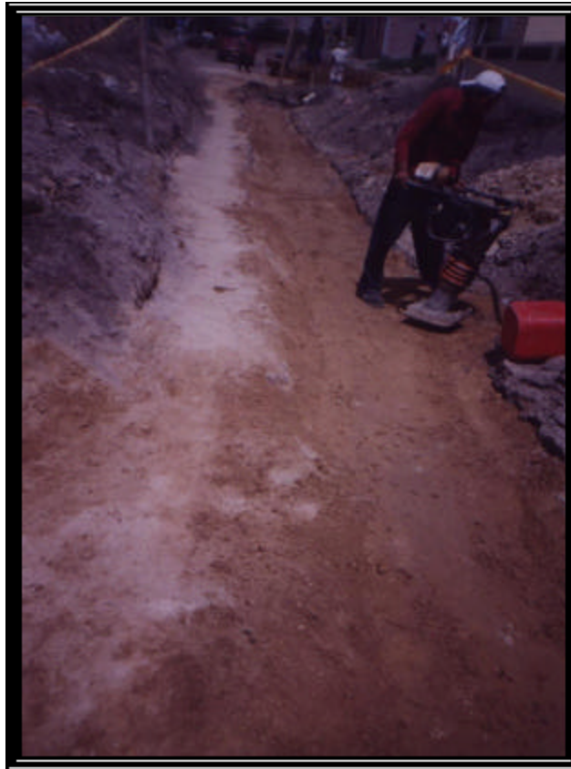
Figura 14. Terminación de la compactación
