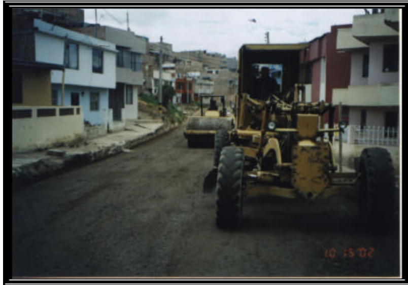
Figura 19. Compactación sub-rasante
