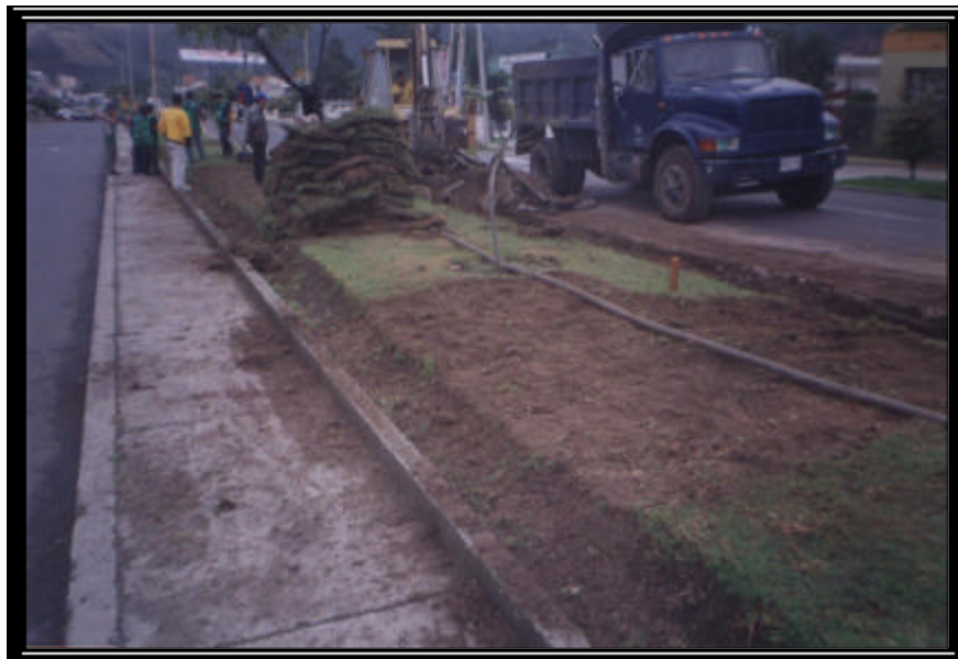
Foto 82 EXCAVACIÓN – CORTE DE CÉSPED
