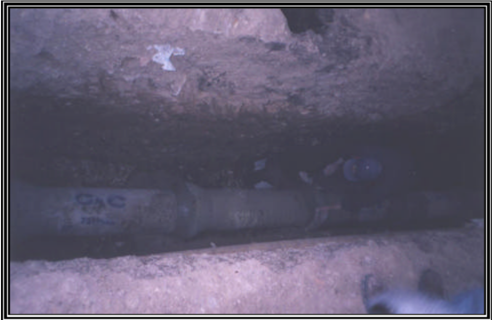
Foto 09 PROCESO DE EMBOQUILLADO
