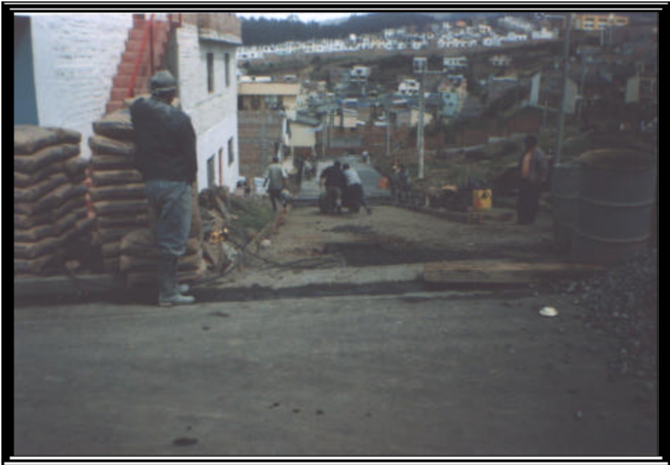
Foto 70 FUNDICIÓN DE PLACA VISTA SUPERIOR
