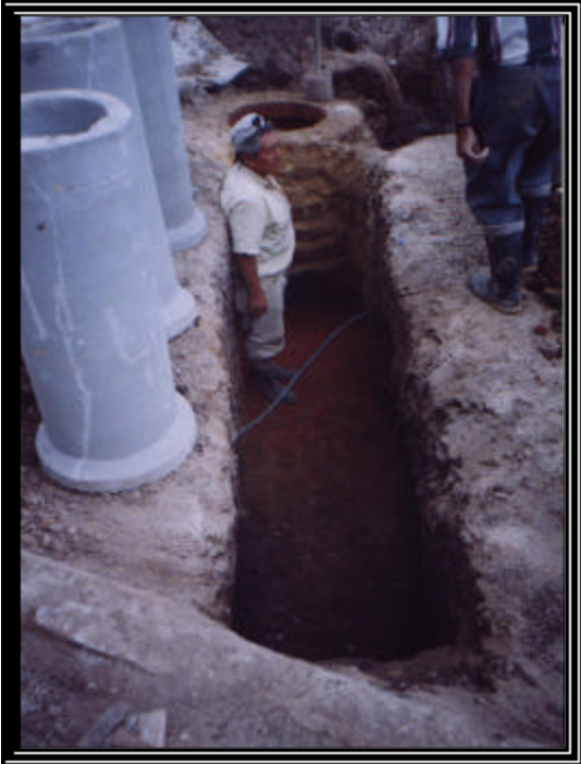
Foto 10 TRAMO PERFILADO DISPUESTO PARA UBICAR TUBERÍA
