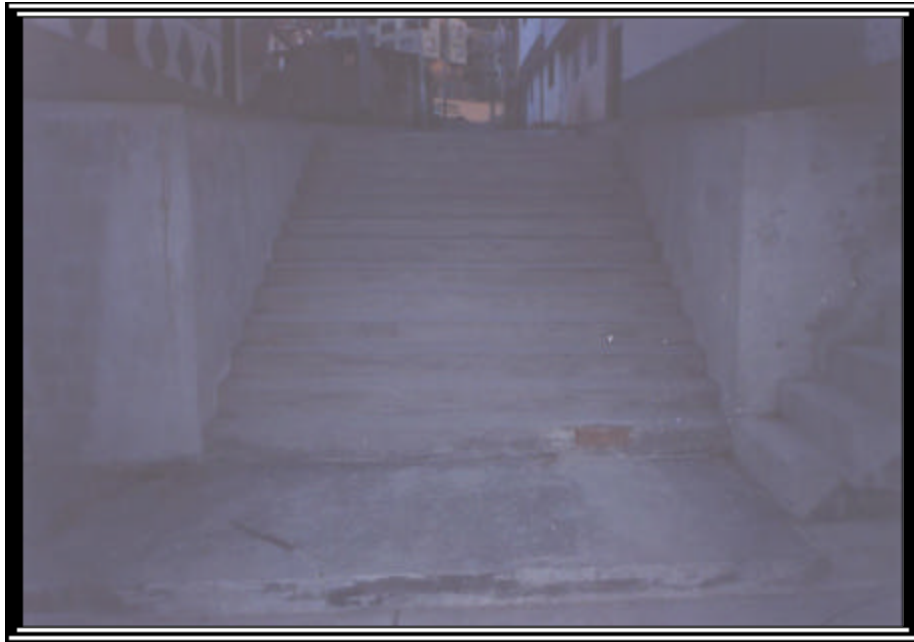
Figura 43. Gradería y muro
