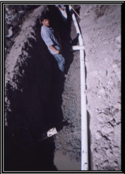
Foto 06 INSTALACIÓN DE TUBERÍA SANITARIA PROVISIONAL
