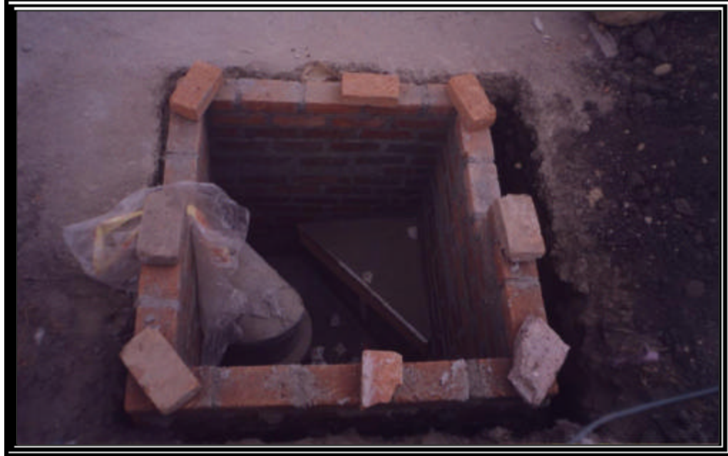
Figura 44. Construcción sumidero
