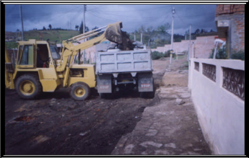
Figura 17. Carga de material de desalojo
