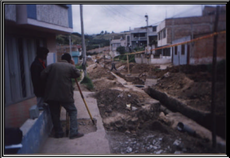
Foto 03 CHEQUEO DE NIVELACIÓN DE TUBERÍA
