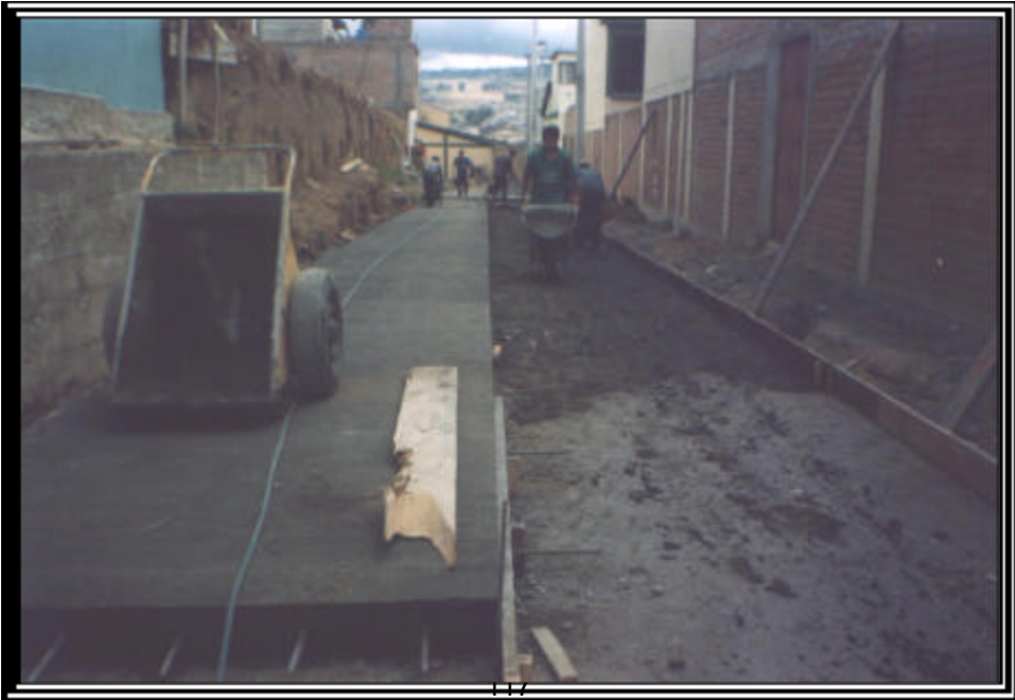
Foto 75 FUNDICIÓN DE PLACA
