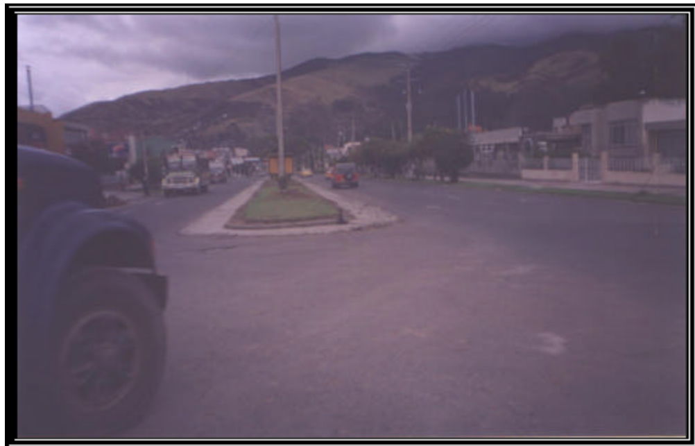
Figura 52. Estado inicial del separador
