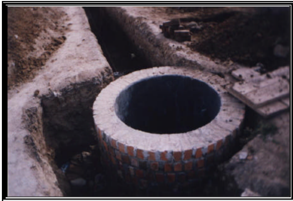
Figura 3. Construcción cámara H < 1.80 mt
