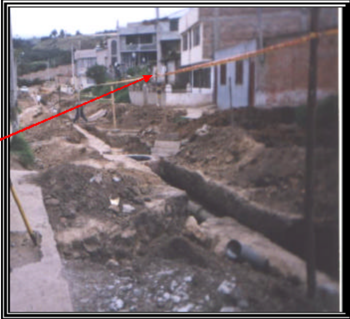
Foto 04 SEÑALIZACIÓN DE LA EXCAVACIÓN
