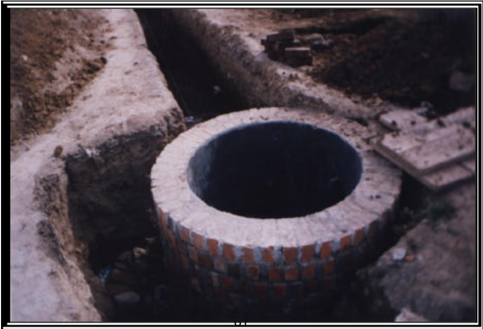
Foto 05 CÁMARA DE INSPECCIÓN
