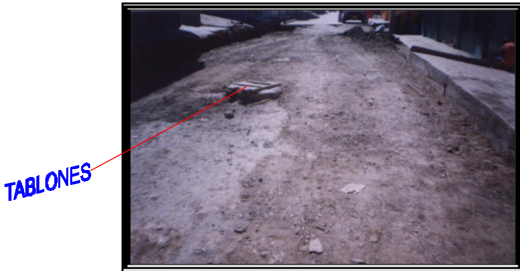
Figura 21. Cubrimiento de cámaras
