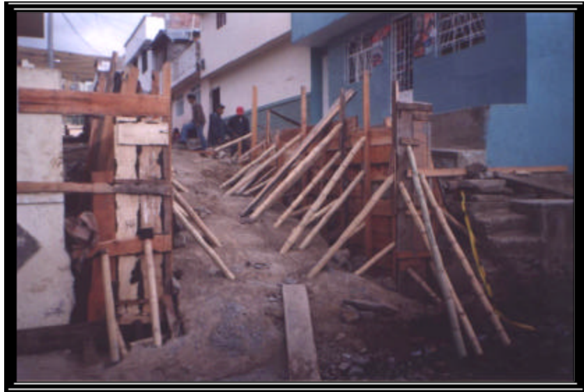
Foto 58 FORMALETEO MURO CONTENCIÓN
