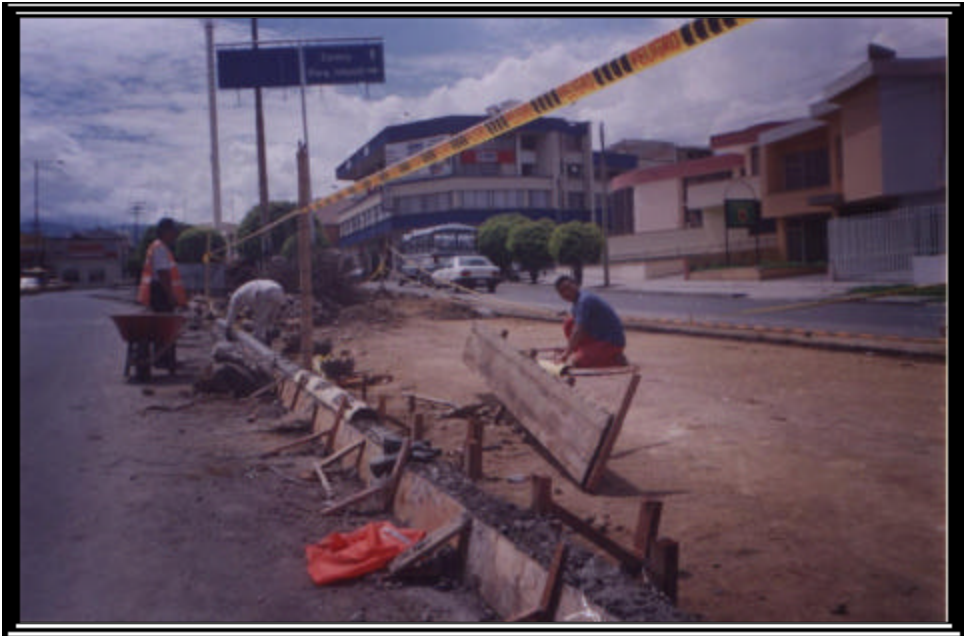
Foto 96 FUNDICIÓN DE SARDINEL
