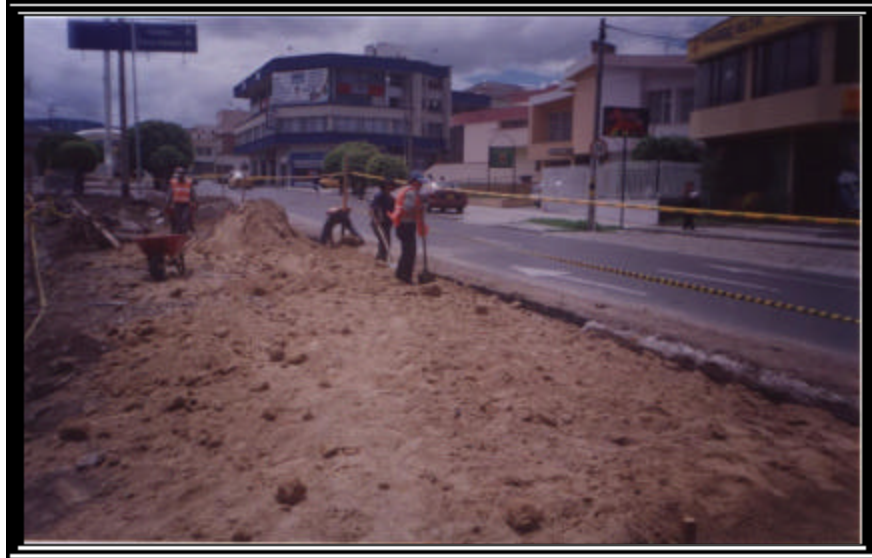
Figura 62. Extendido de material de préstamo
