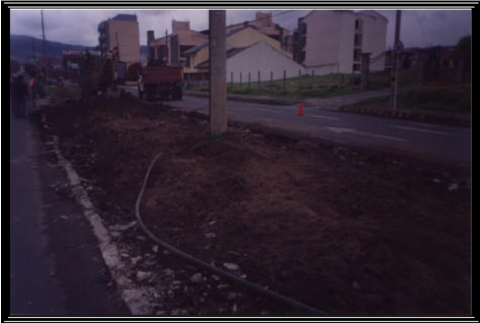
Foto 84 DEMOLICIÓN DE SEPARADOR
