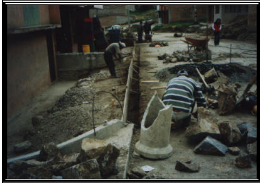
Figura 28. Demolición de andenes
