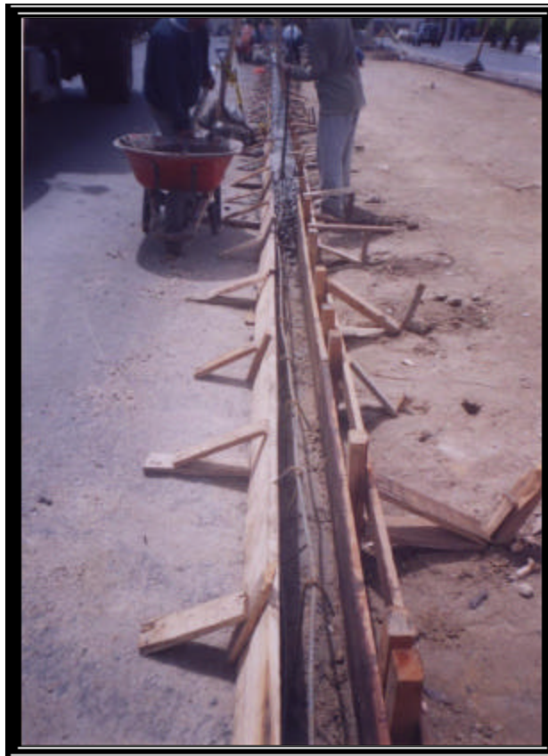
Figura 64. Formaleta sardinel - fundición
