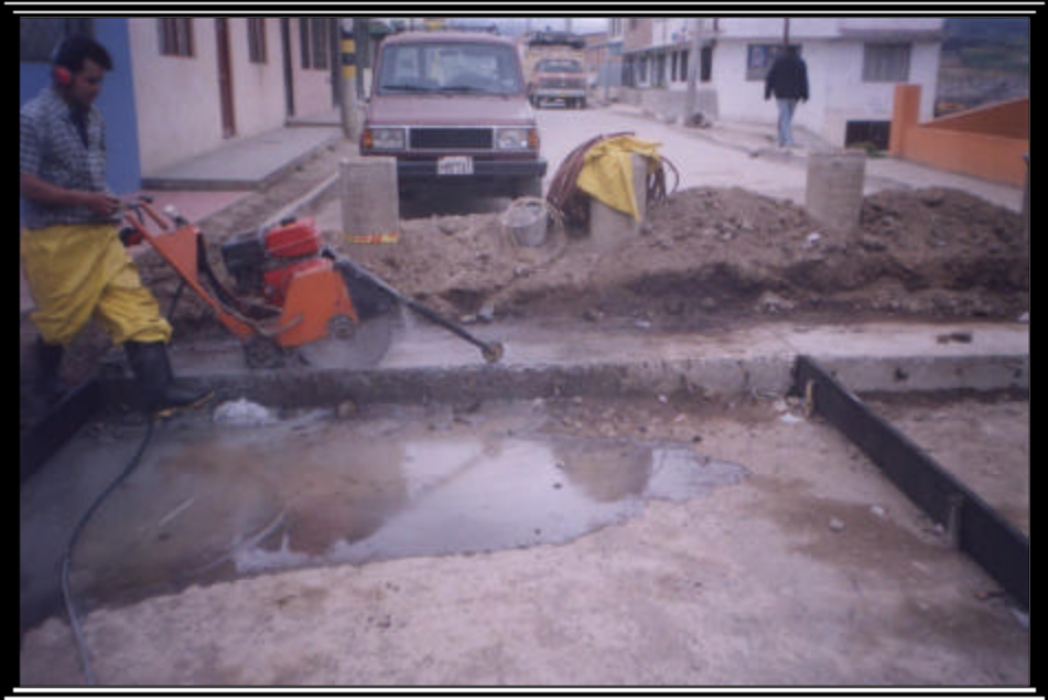
Foto 37 CORTE DE PAVIMENTO EXISTENTE
