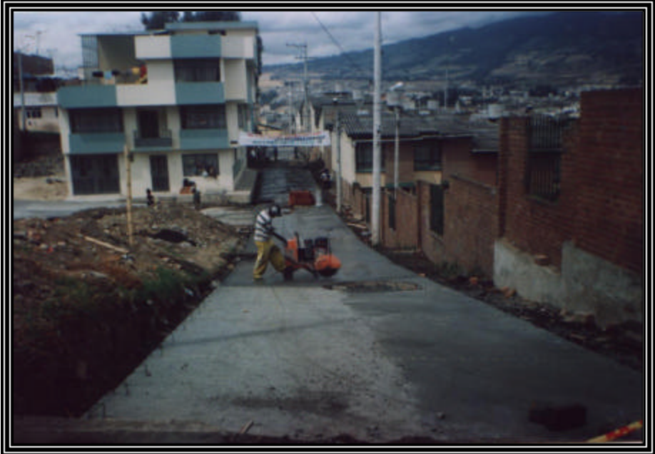
Foto 78 CORTE DE JUNTAS
