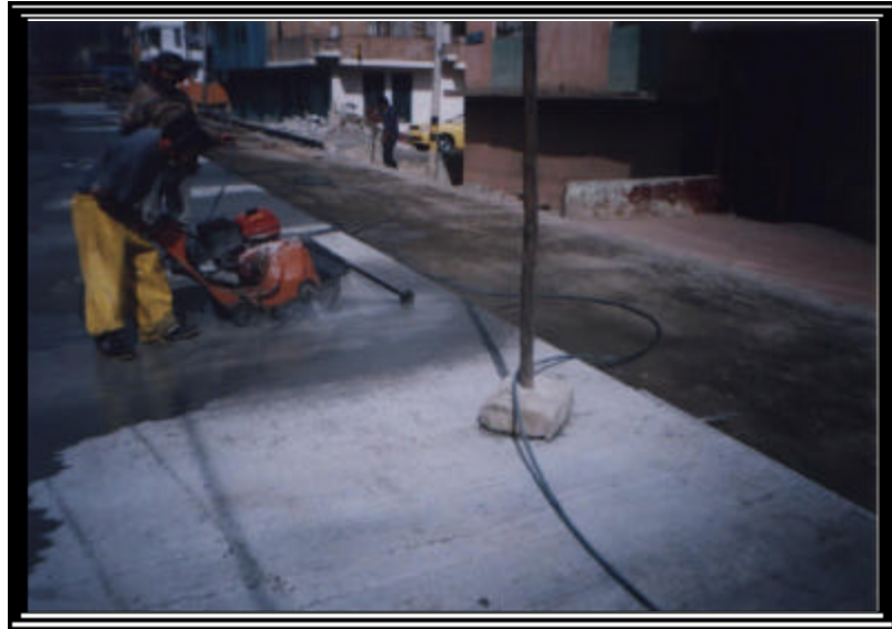
Figura 34. Corte de juntas
