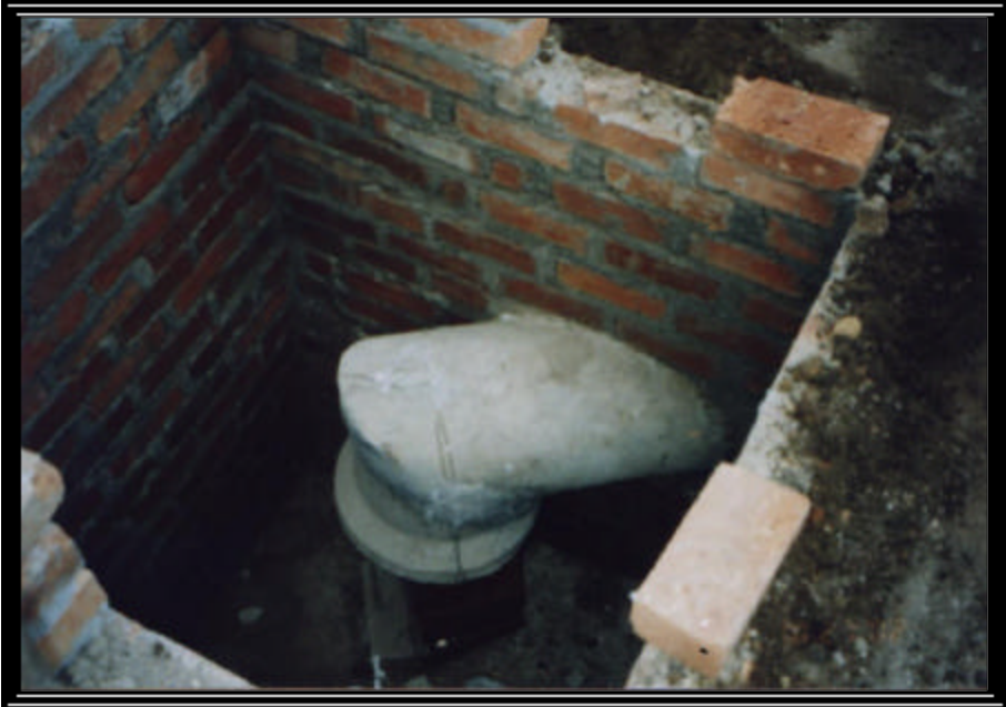
Foto 39 DETALLE CODO SUMIDERO
