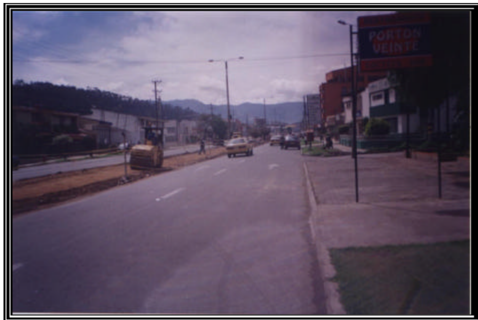
Foto 94 COMPACTACIÓN DE MATERIAL DE BASE
