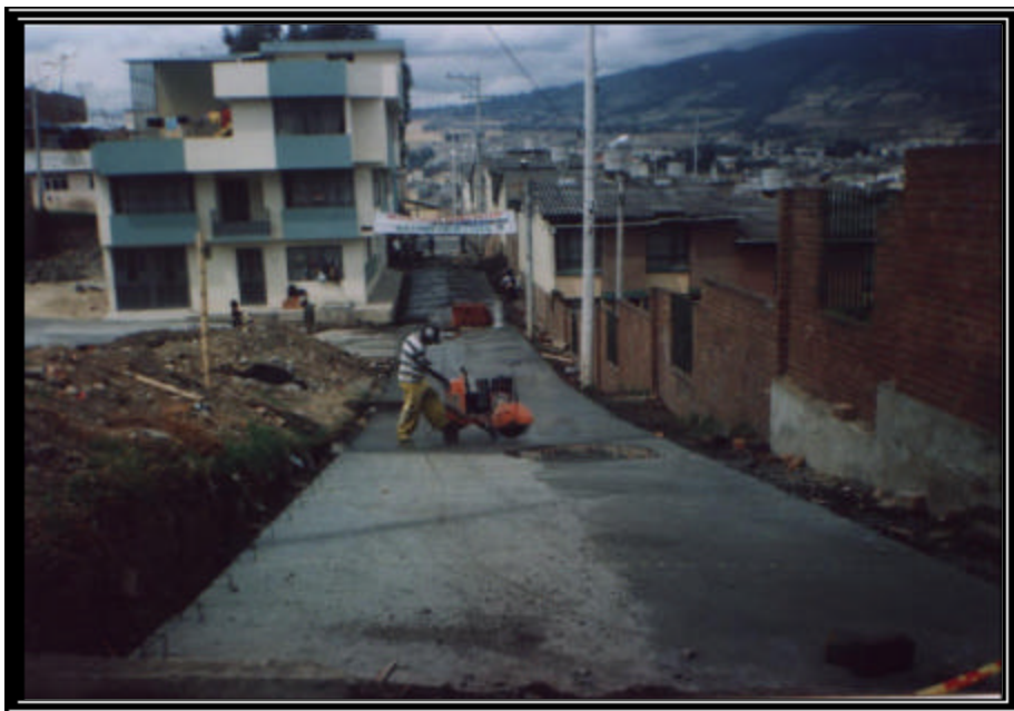
Figura 51. Corte de juntas
