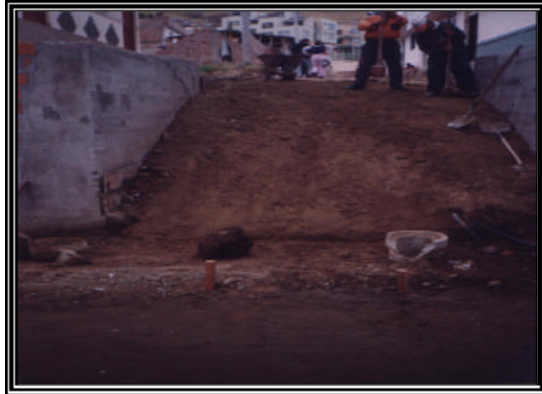
Figura 41. Compactación manual gradería
