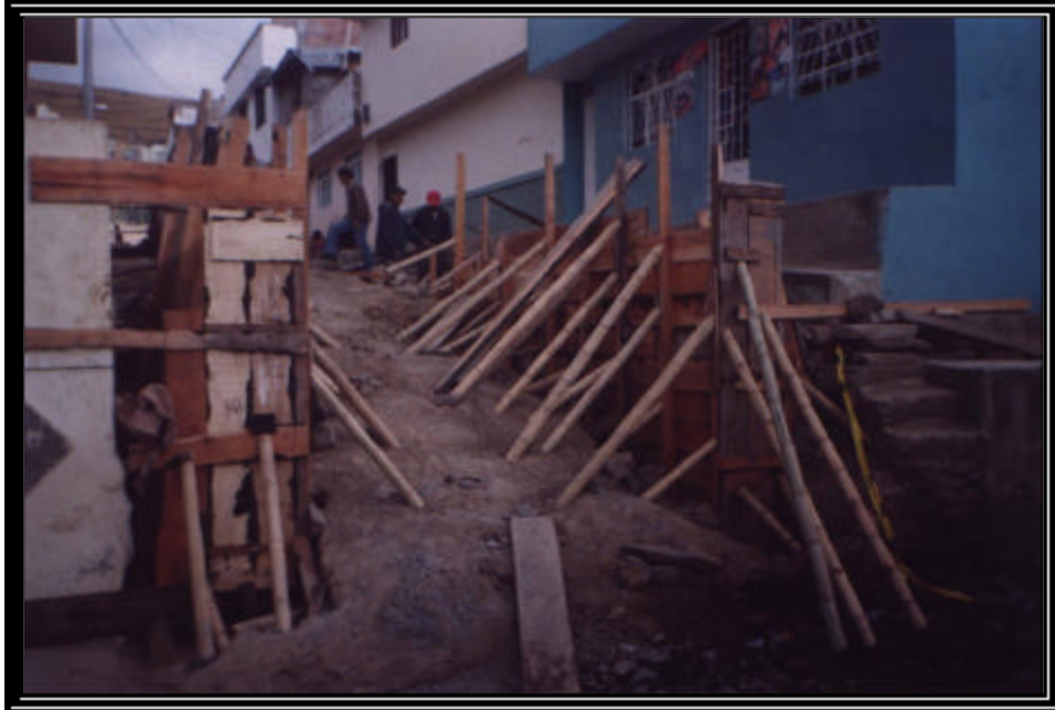
Figura 42. Formaleta muro de contención
