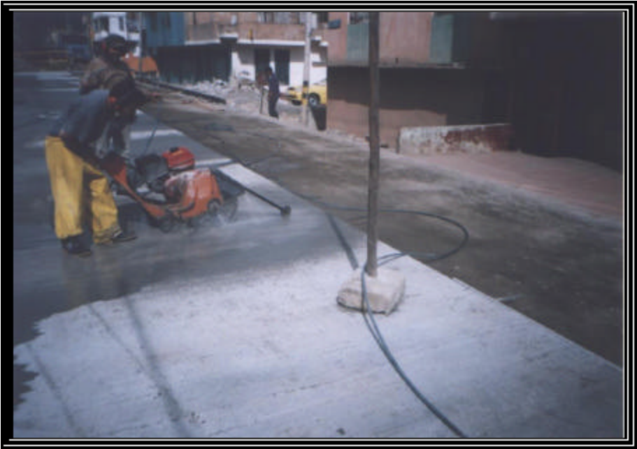
Foto 50 PROCESO DE CURADO DE PLACA
