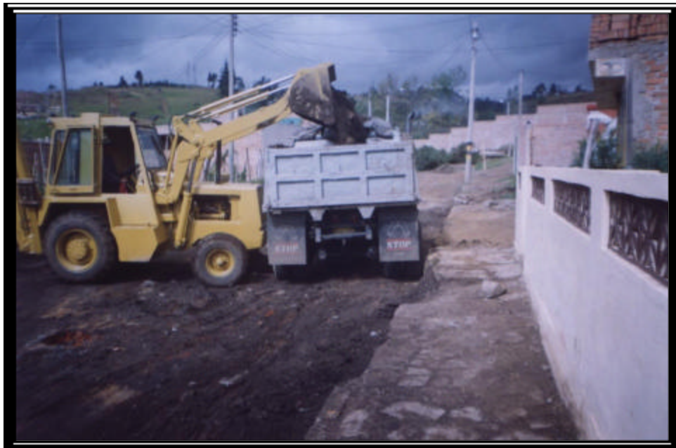
Foto 19 CARGUE DE MATERIAL SOBRENTE
