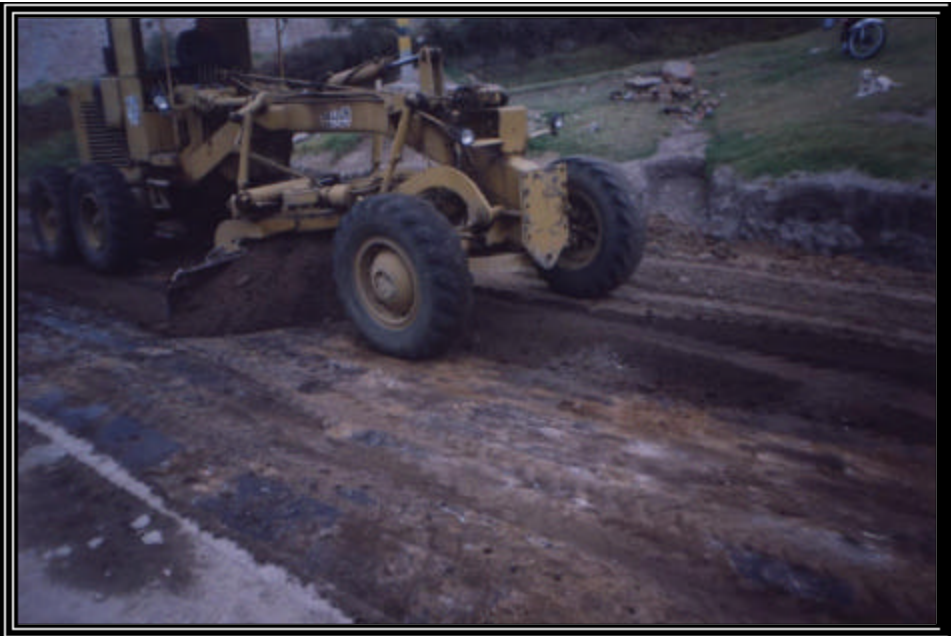
Foto 21 PERFILADO DE SUB - RASANTE
