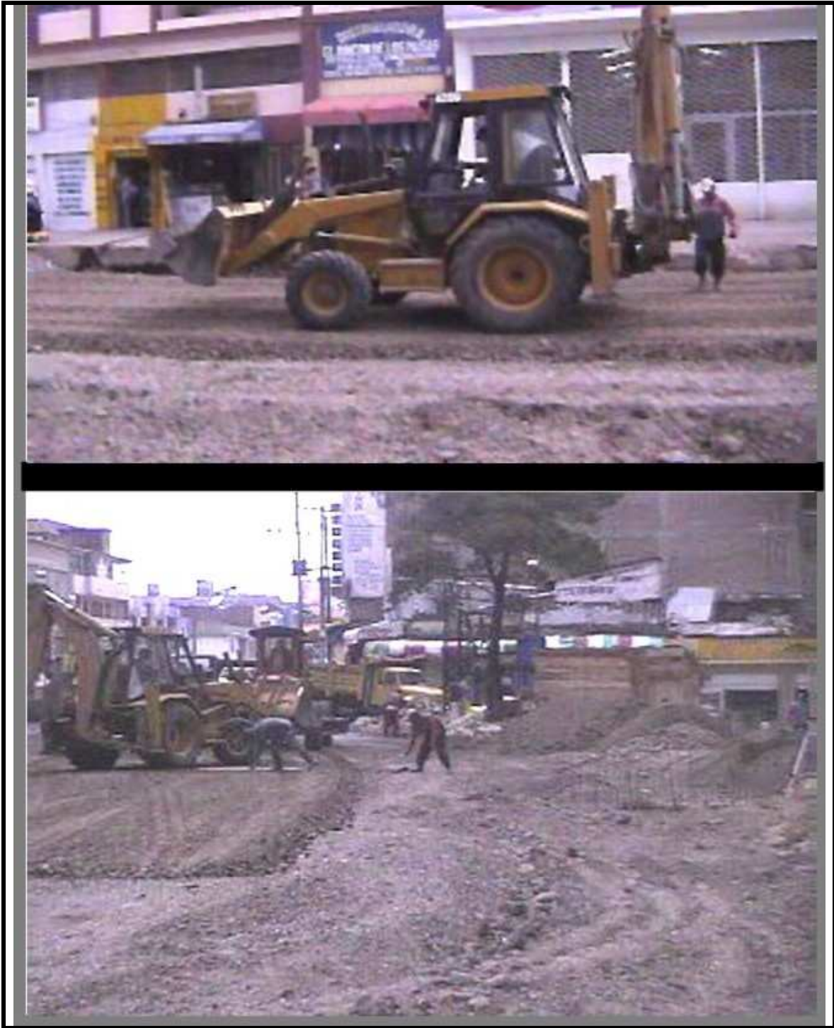
Figura 24. Distribución de material de base
