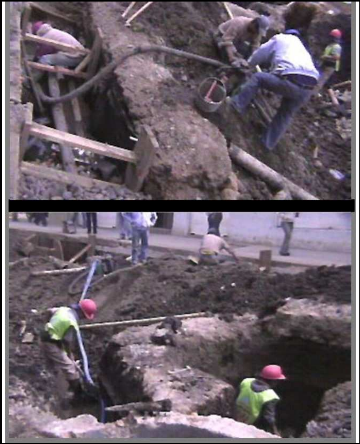
Figura 21. Extracción de agua en zona de falla
