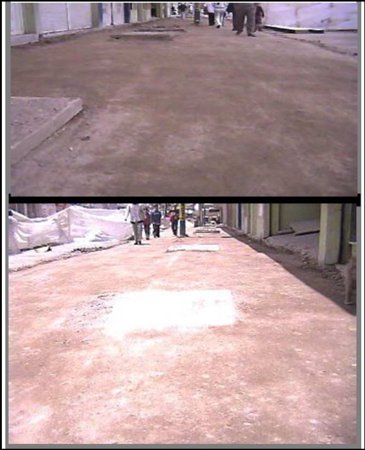
Figura 38. Base en recebo compactado anden derecho
