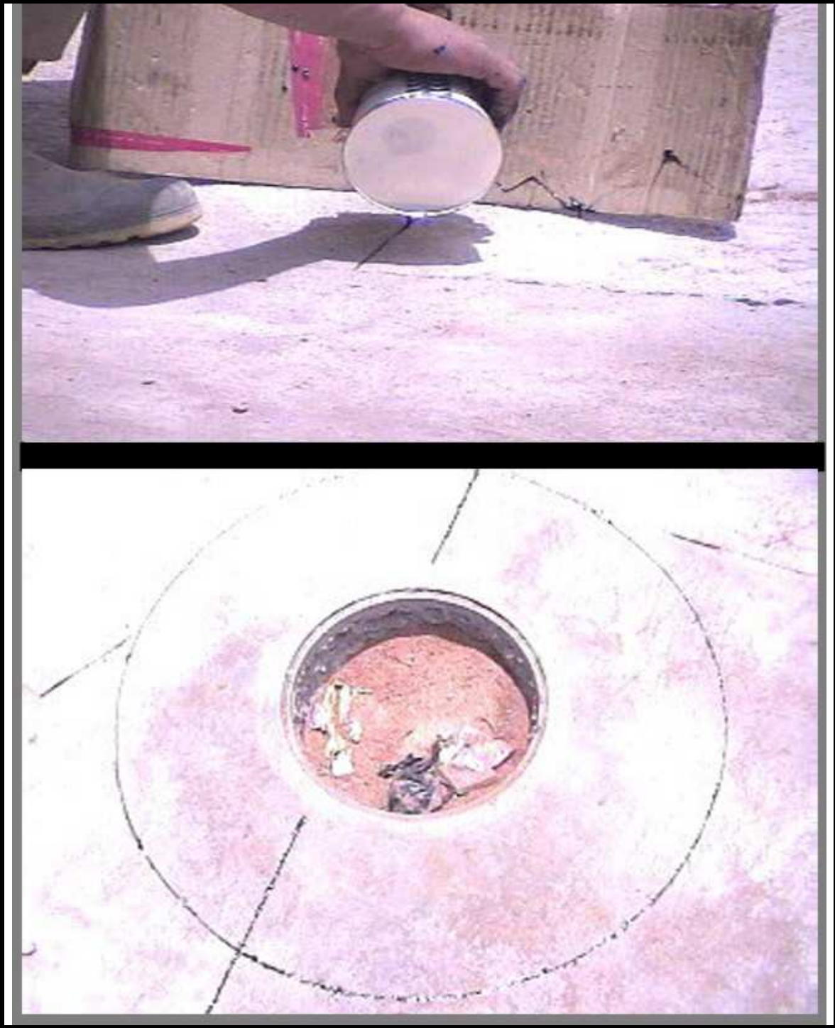
Figura. 56 Sellado de juntas de tapa de caja
