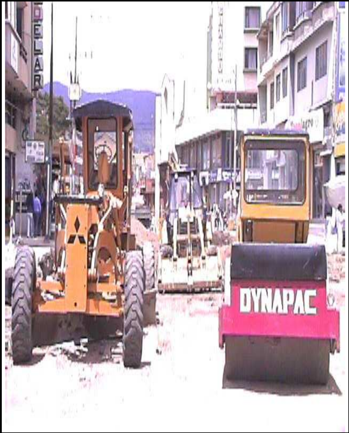
Figura 6. Motoniveladora y Vibrocompactador
