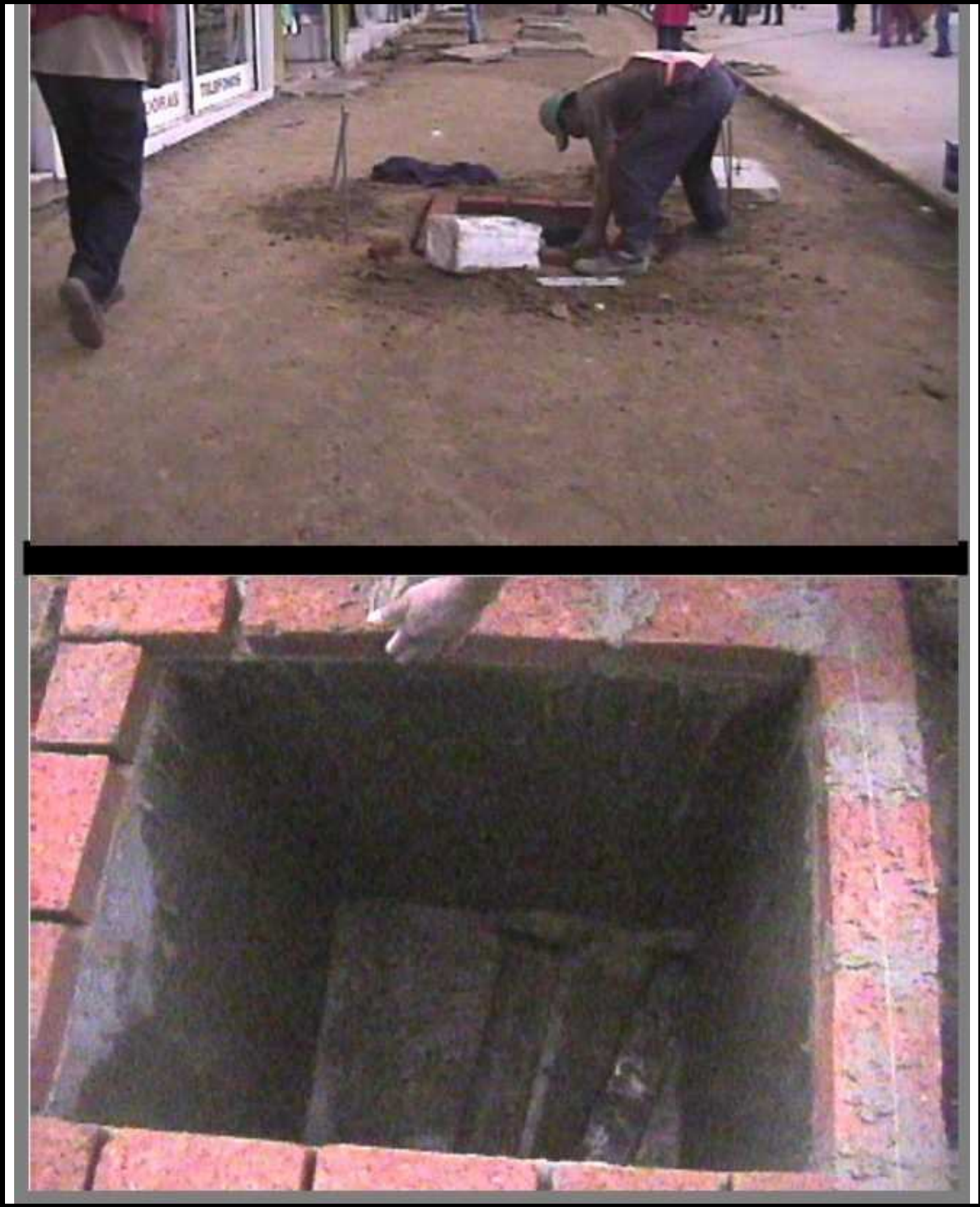
Figura 25. Construcción de caja para protección de árbol
