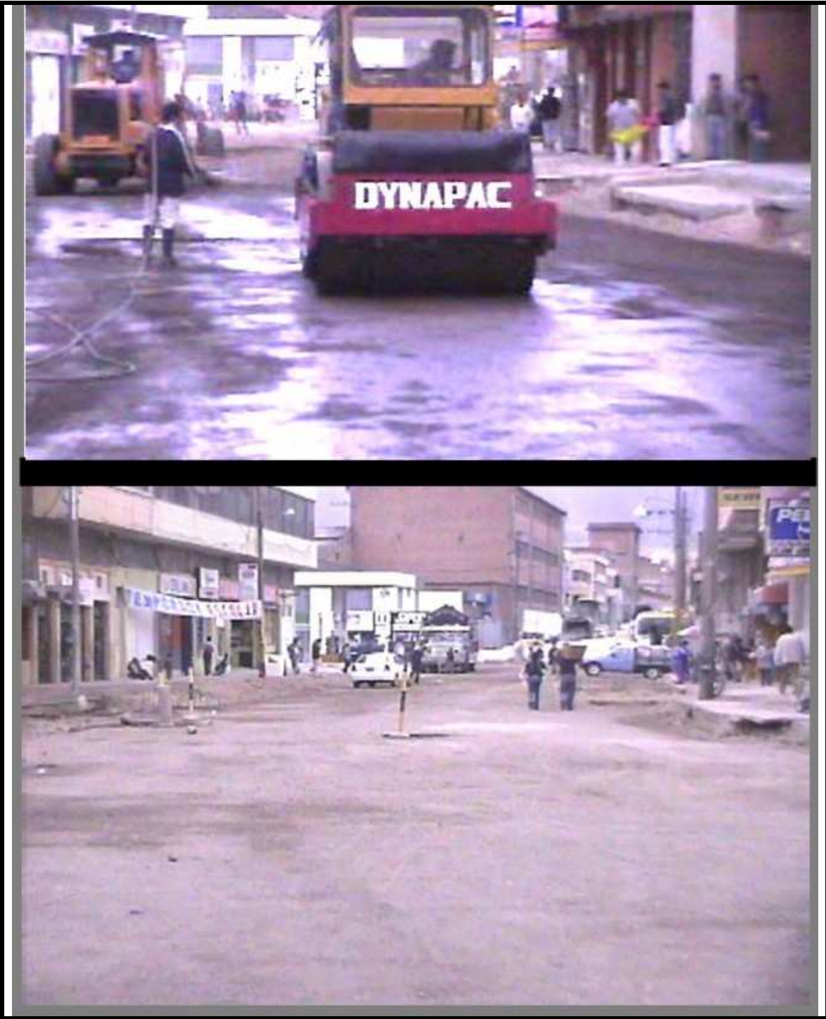
Figura 30. Compactación óptima de base
