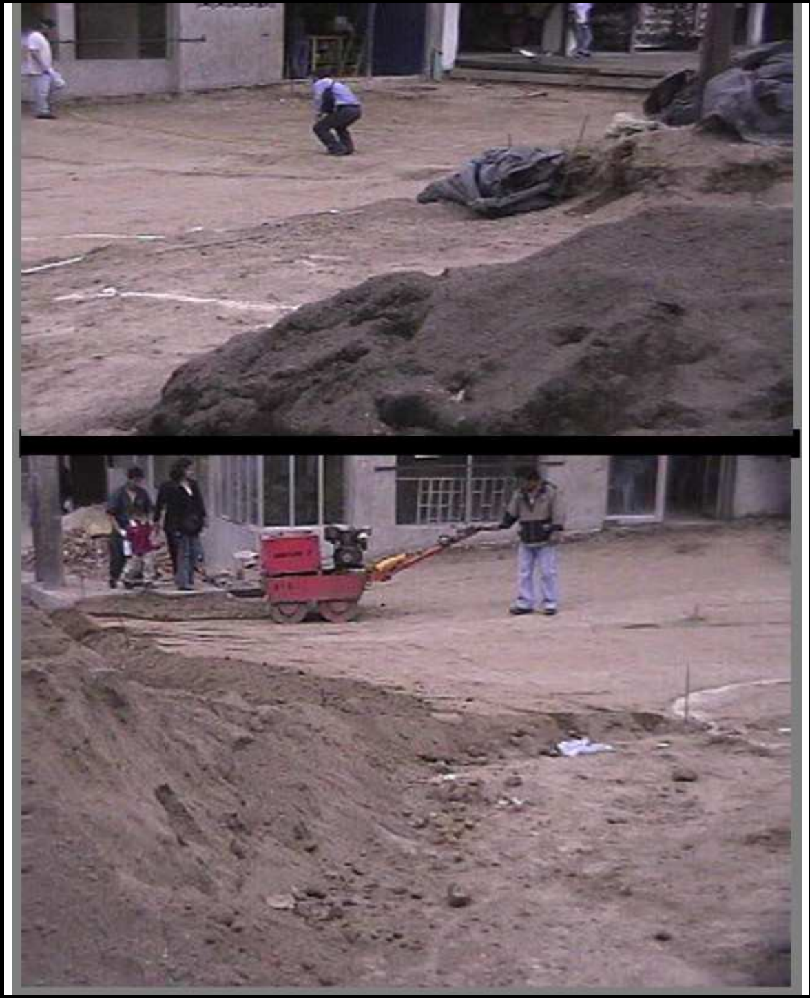
Figura 45. Base compactada andén izquierdo
