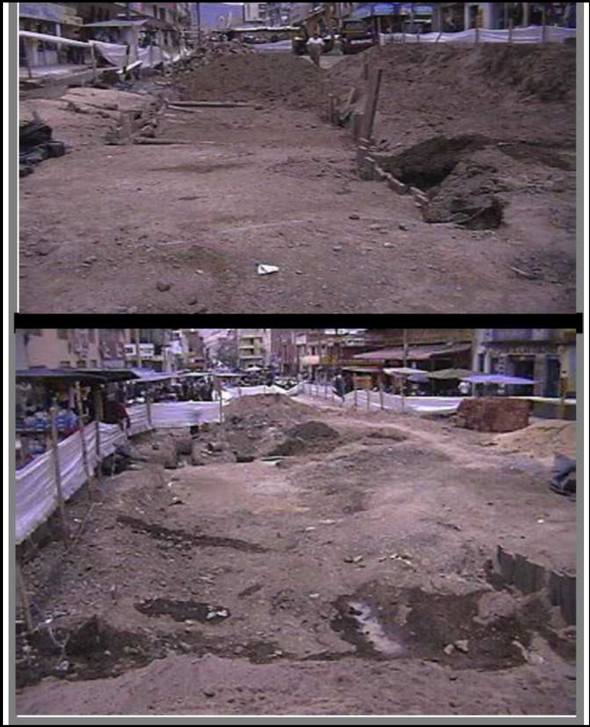
Figura 40. Relleno zona de falla
