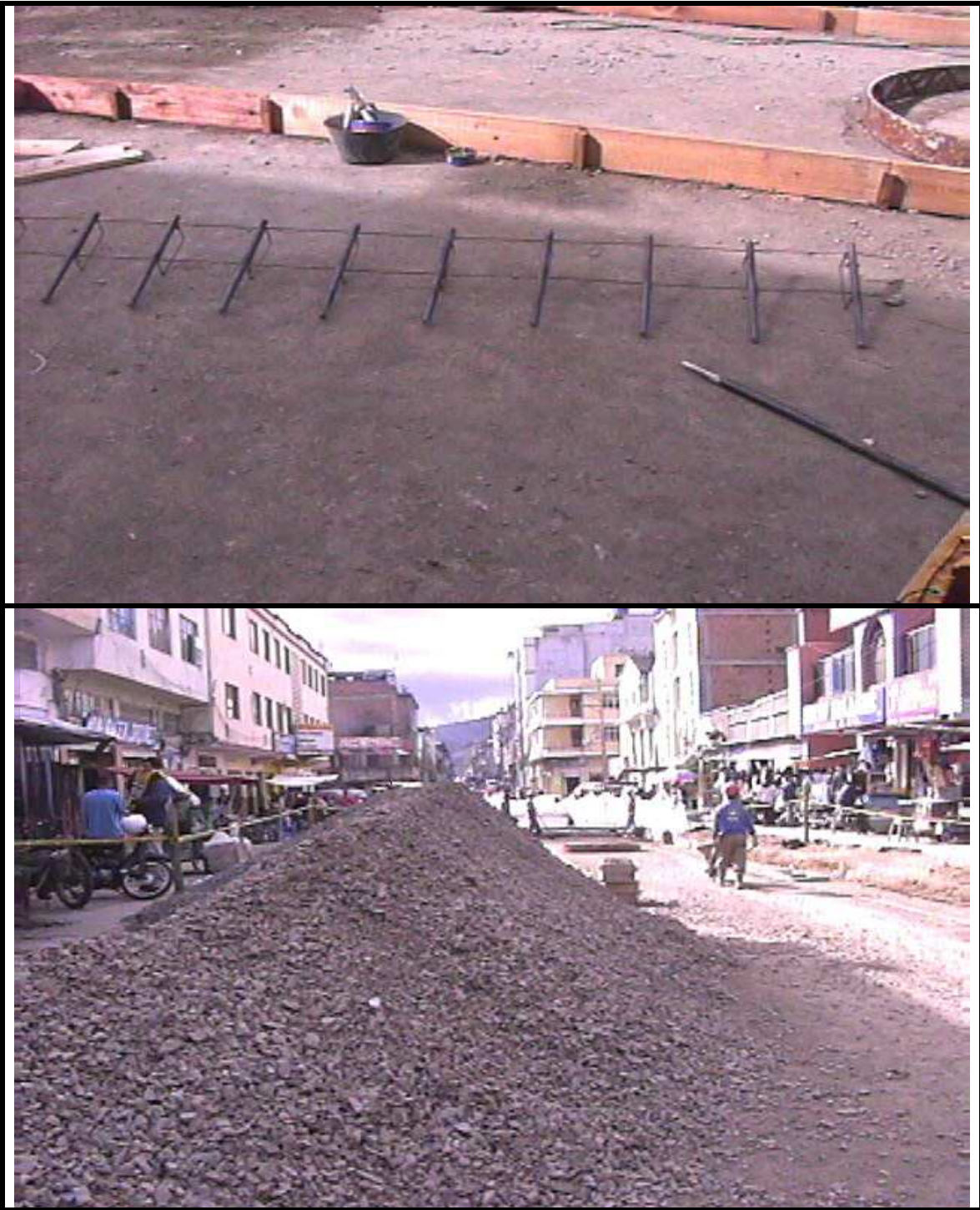
Figura 12. Camilla de pasadores de carga y material para concreto
