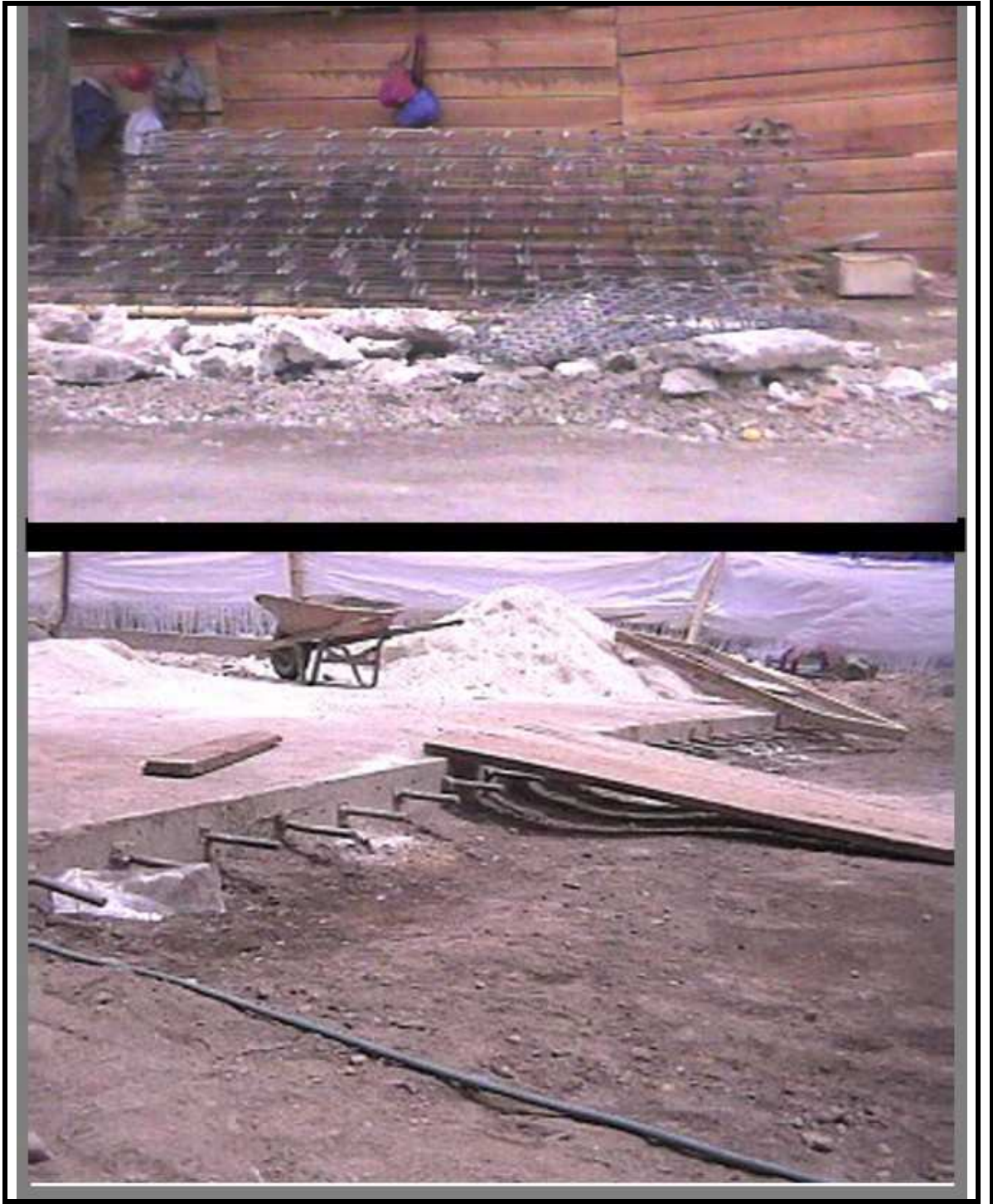
Figura 52. Camillas de transmisores de carga
