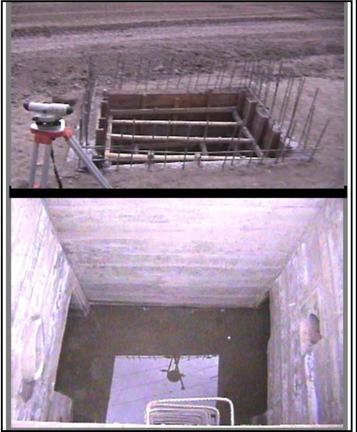
Figura 51. Cámara de inspección del box
