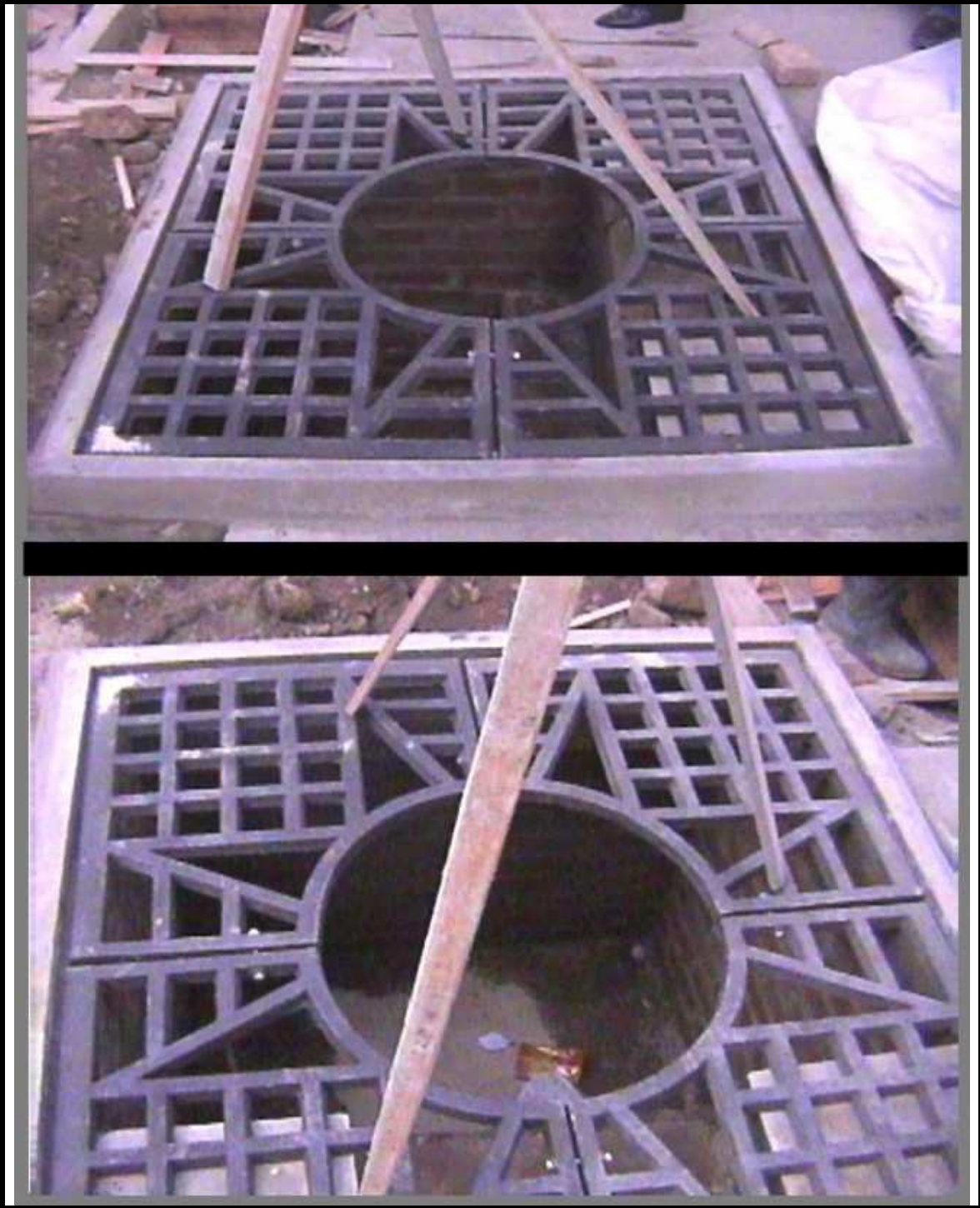
Figura 34. Colocación de tapa de protección de árbol K0 + 087
