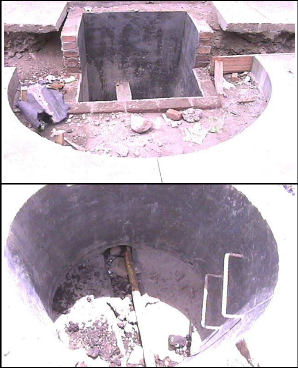
Figura 9. Alcantarilla Profundidad de Poso de Inspección
