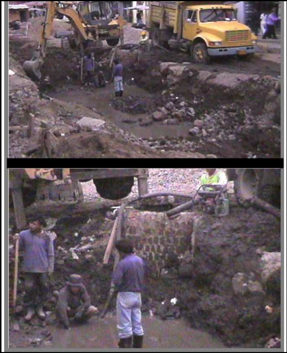
Figura 23. Excavación de suelo orgánico en zona de falla
