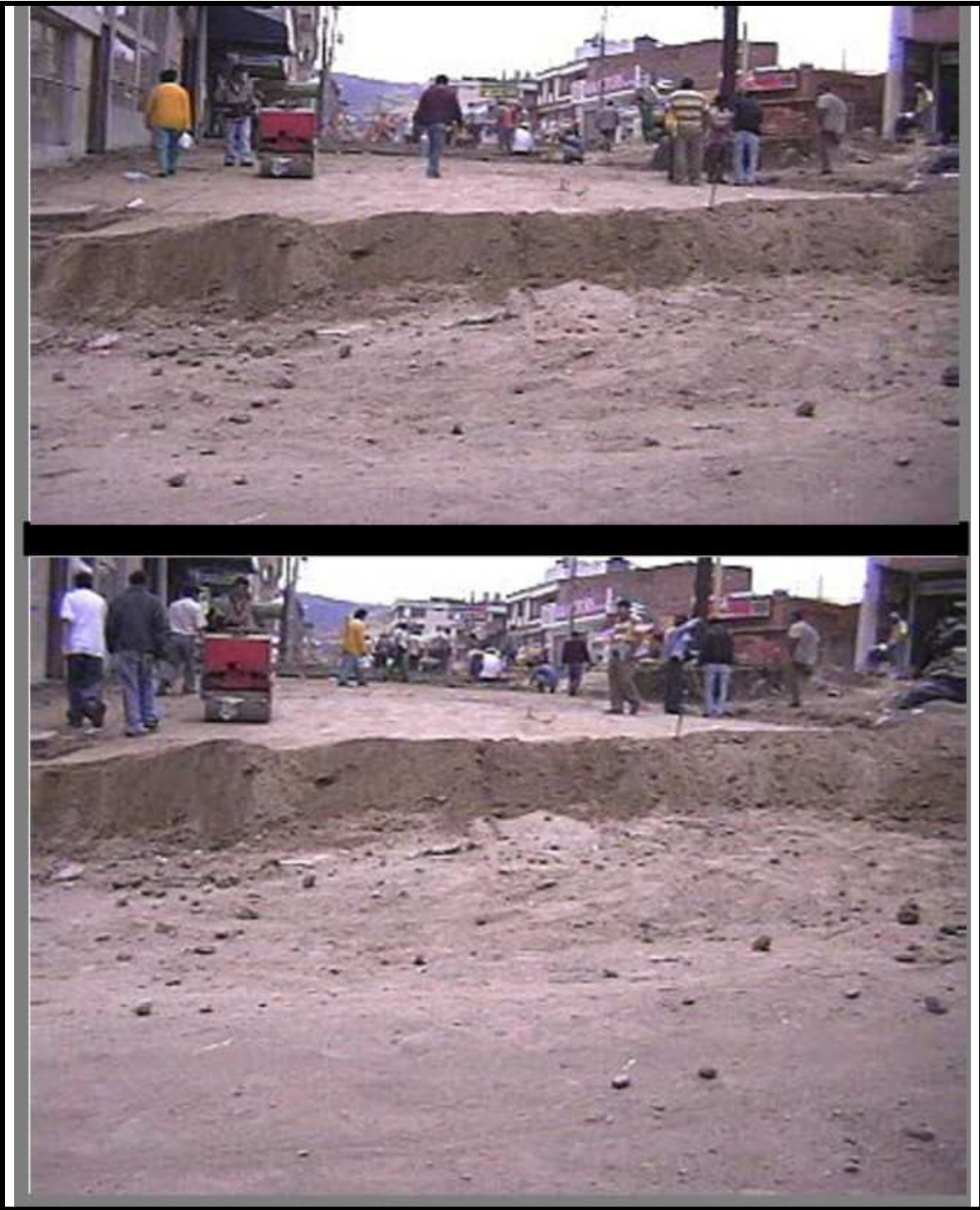
Figura 42. Andén izquierdo, relleno y compactación
