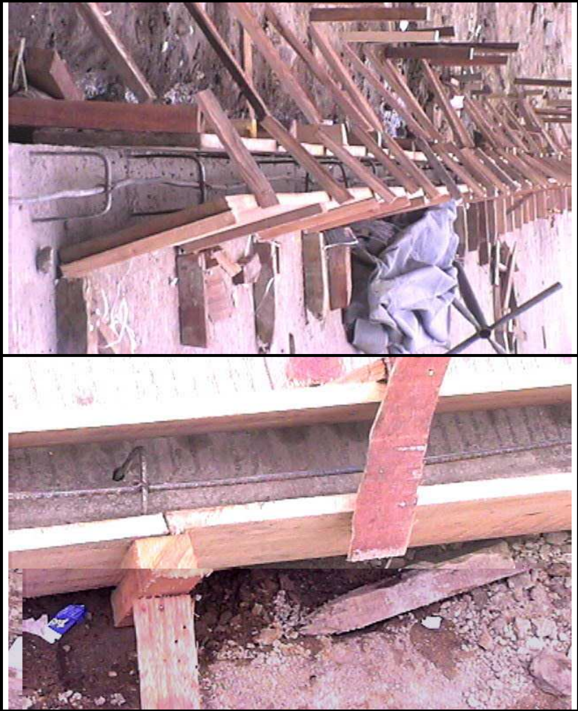
Figura 19. Elaboración de formaleta del bordillo
