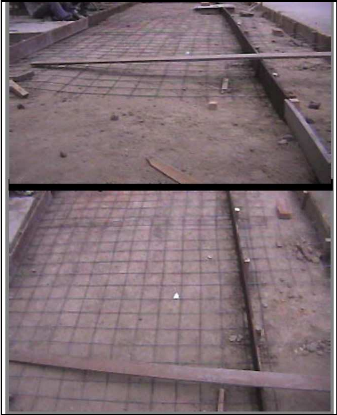
Figura 37. Colocación malla de hierro en andén derecho de K0 + 200 a K0 + 300
