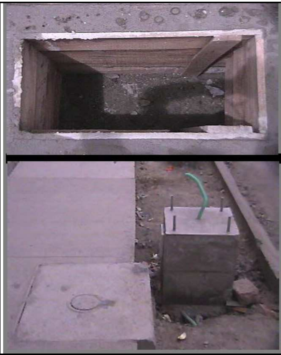
Figura 53. Formaleta para pedestal de poste de luz
