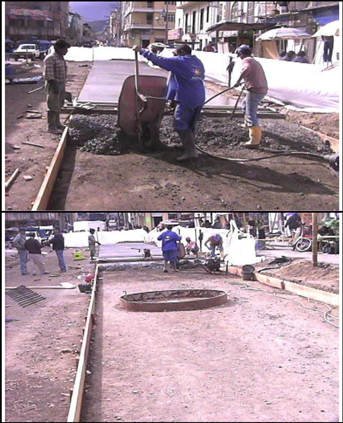
Figura 16. Vaciado de concreto
