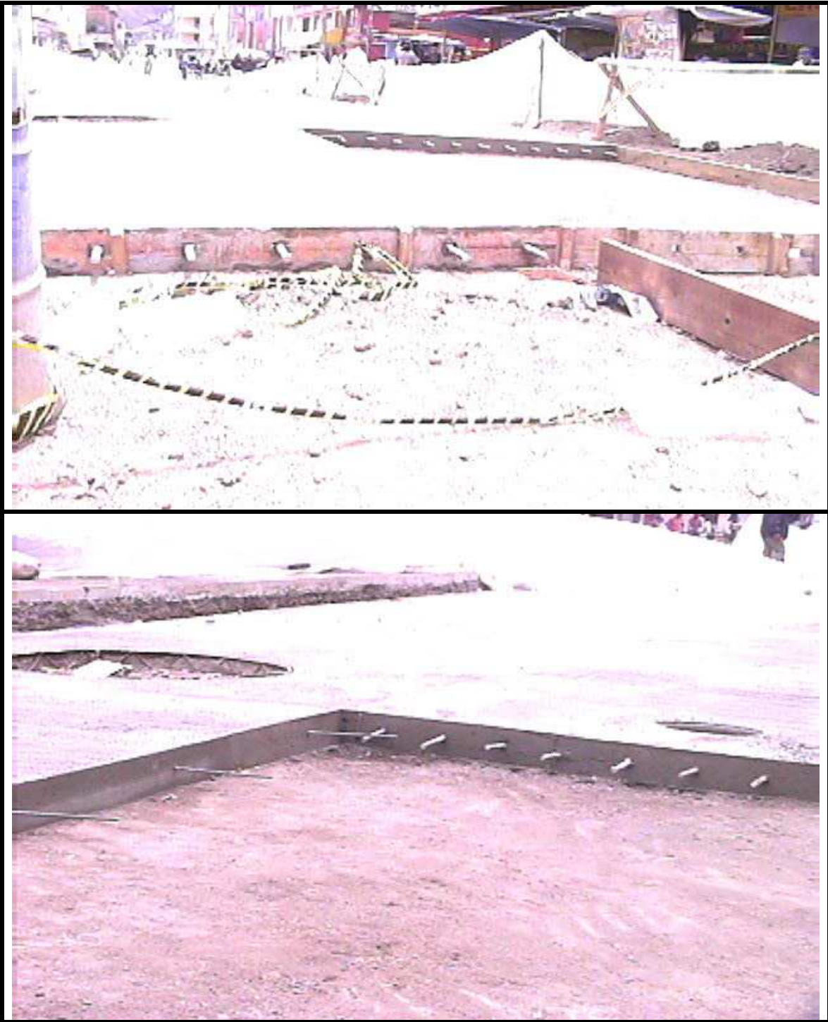
Figura 15. Pasadores de transmisión de carga, junta transversal
