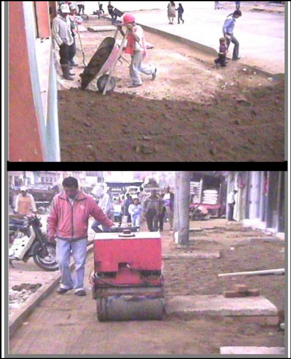
Figura 27. Distribución y compactación de base de recebo en andén
