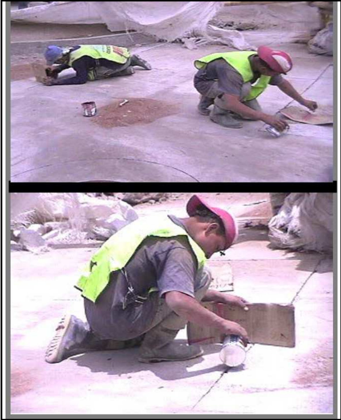
Figura 55. Sellado de juntas
