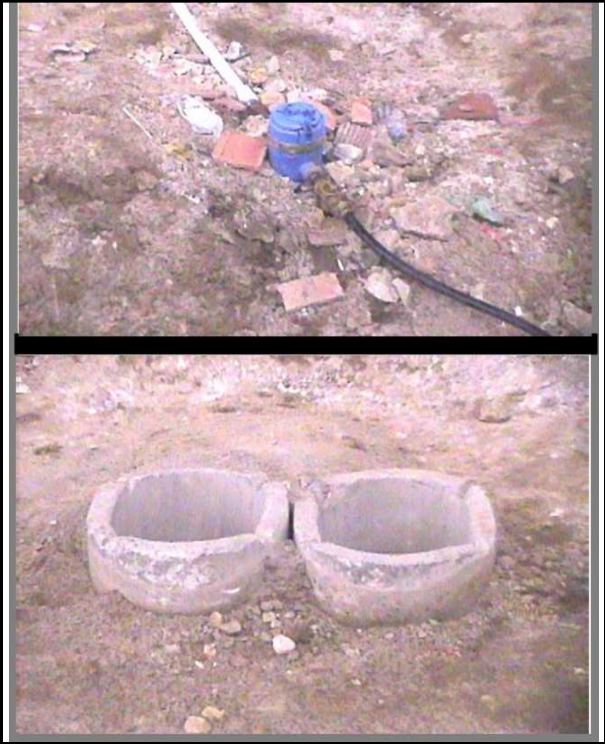
Figura 26. Instalación de cajas y redes de acueducto
