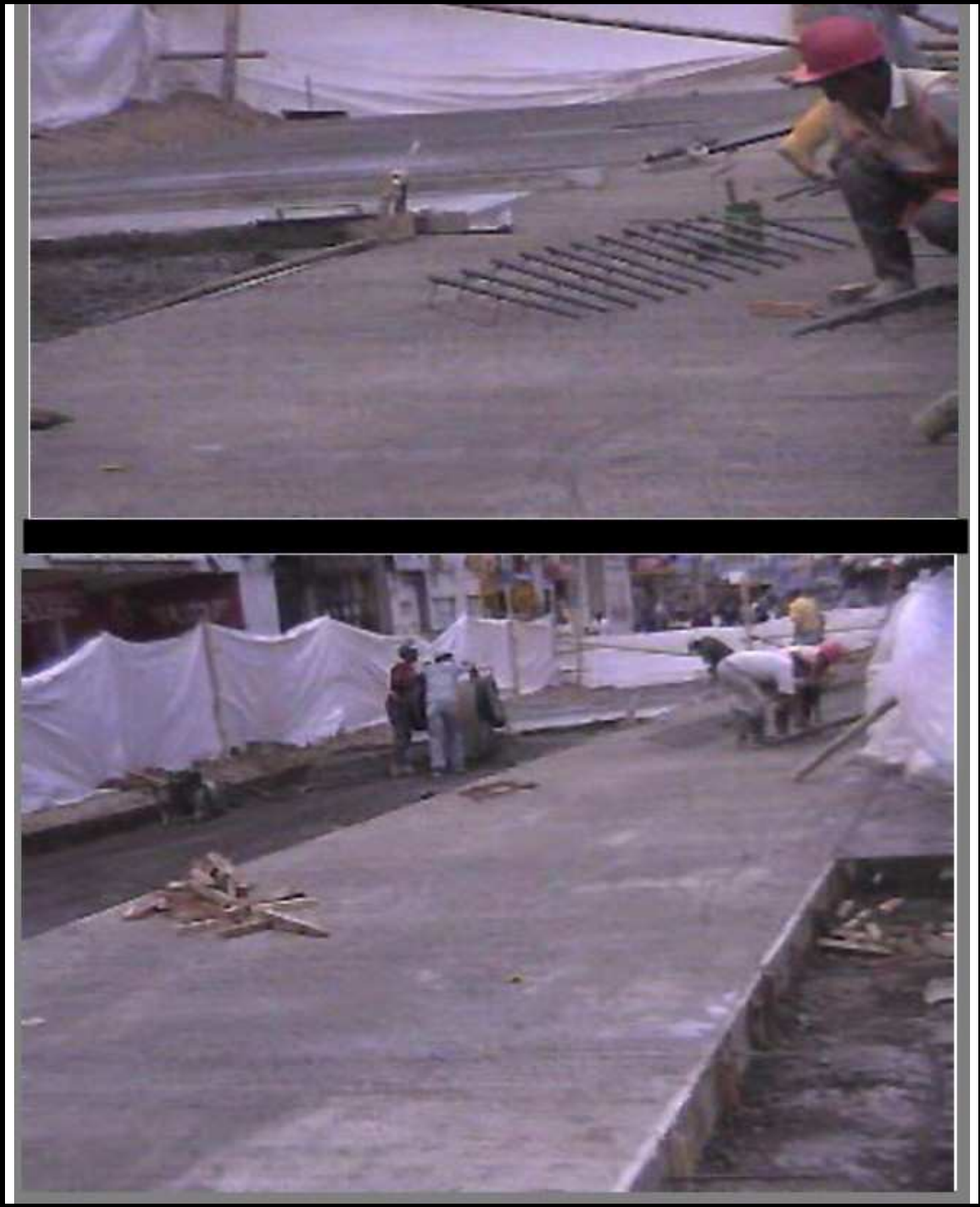
Figura 39. Fundición camilla para carril izquierdo
