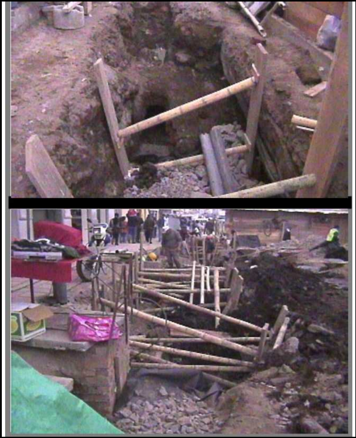
Figura 35. Relleno y apuntalamiento sector de falla izquierdo
