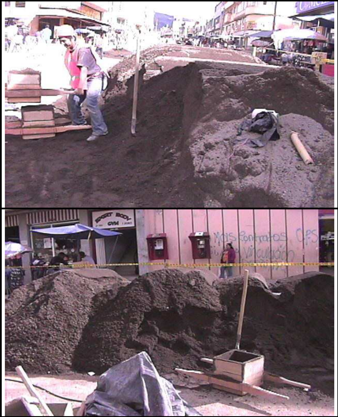
Figura 13. Arena negra para concreto y Cajones para dosificación
