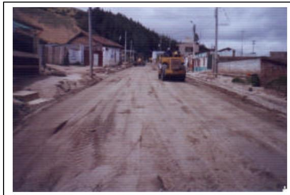
Los equipos para la ejecución de los trabajos comprende: moto niveladora, compactador vibratorio, compactador manual (saltarín – rana) y volquetas.
