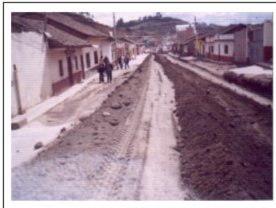
Efectuando la distribución se controla su uniformidad midiendo los espesores de material. Además se hace la nivelación cada 10mts y también se comprueba el ancho de la calzada.
