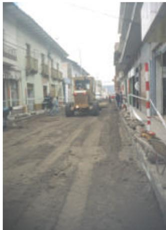
?? Conformación del material. Con base en las especificaciones de diseño y de acuerdo a la sección transversal especificada para cada punto de toda la longitud vial, se realiza una nivelación cada 10 metros para controlar el espesor uniforme de la capa de base y parámetros geométricos como curvas verticales y transiciones de peralte.
