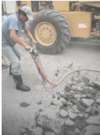
Figura 39. Demolición y retiro de la carpeta asfáltica deteriorada. Carrera 11
