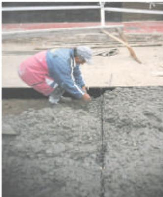
Figura 19. Terminación de jornada, indica aceros de transferencia de cargas longitudinales y transversales
