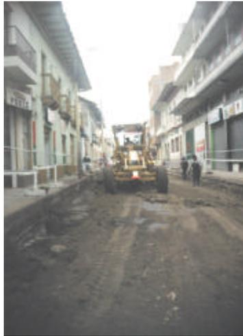
?? Compactación. Una vez que el material tenga la humedad apropiada y esté conformado debidamente, se compacta con el equipo aprobado hasta lograr la densidad especificada.
