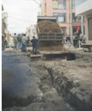
Figura 13. Perfilado y compactación de base granular, calle 10
