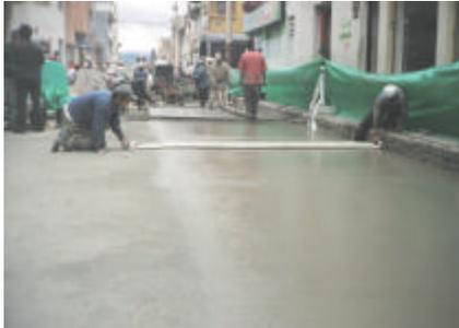
Figura 21. Retiro de platina de la losa de concreto
