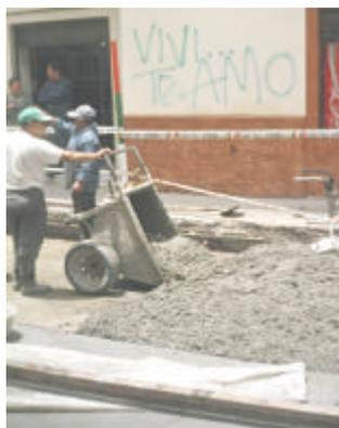
☞ Compactación. Al colocar la mezcla, burbujas de aire quedan dentro de ella, estas hacen que el concreto al secarse tenga cavernas conformando zonas de falla, factor ampliamente perjudicial para la resistencia del concreto. Por ello la compactación debe llevarse a cabo mediante vibración interna
