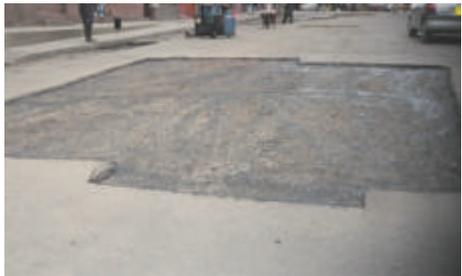
Figura 33. Nivelación del concreto asfáltico, Carrera 10 entre calle 13 y 14
