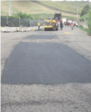
Figura 43. Cajeo, limpieza y retiro de carpeta asfáltica deteriorada, Hospital civil de Ipiales
