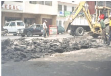
Figura 40. Cajeo y Nivelación del concreto asfáltico, Calle 14 a
