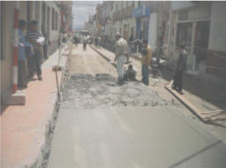
Figura 17. Vibrado del concreto
