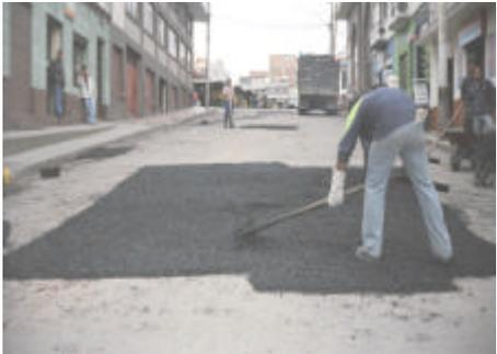
Figura 34. Compactación del concreto asfáltico, carrera 10 entre calle 13 y 14
