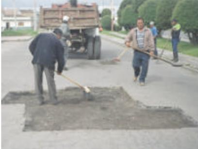
Figura 44. Compactación de concreto asfáltico, Hospital civil de Ipiales
