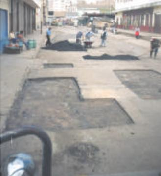
Figura 41. Colocación y nivelación de concreto asfáltico, Barrio Álamos Norte
