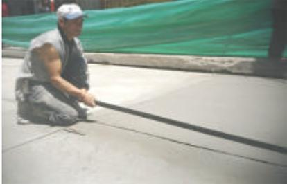
Figura 22. Sellamiento de las juntas de dilatación con material ligante
