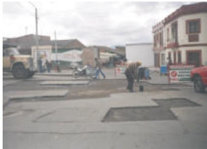
Figura 36. Colocación de concreto asfáltico, intersección carrera 11 con calle 13 esquina
