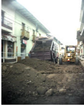
Figura 6. Mezcla de material granular, Calle 10
