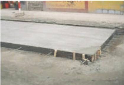
Figura 20. Texturizado de la losa de concreto
