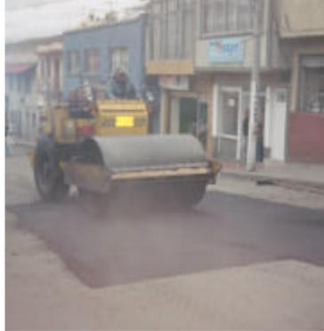
Figura 35. Cajeo y riego de liga, intersección carrera 11 con calle 13 esquina
