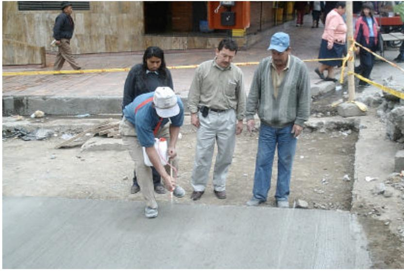
Figura 38. Curado placa de concreto (2)
