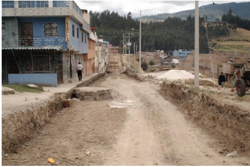
Figura 62. Excavación sub-rasante (2)
