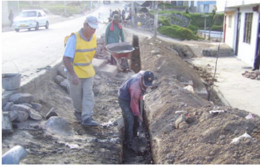
Figura 157. Fundición concreto ciclópeo (2)
