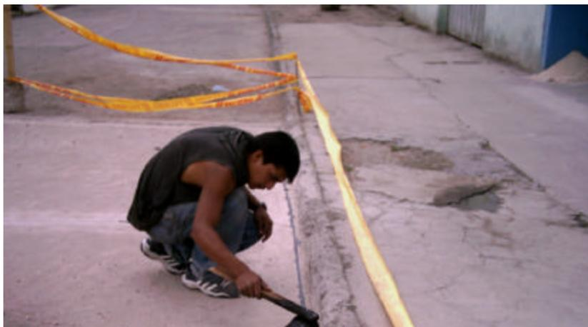
Figura 115. Sellado juntas de dilatación (2)
