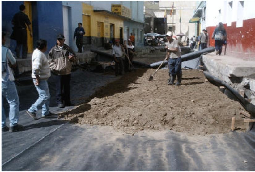
Figura 24. Colocación geotextil (2)
