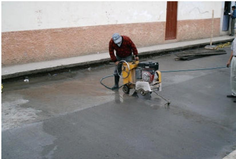
Figura 81. Corte juntas de dilatación (2)
