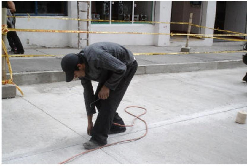
Figura 45. Sellado juntas de dilatación
