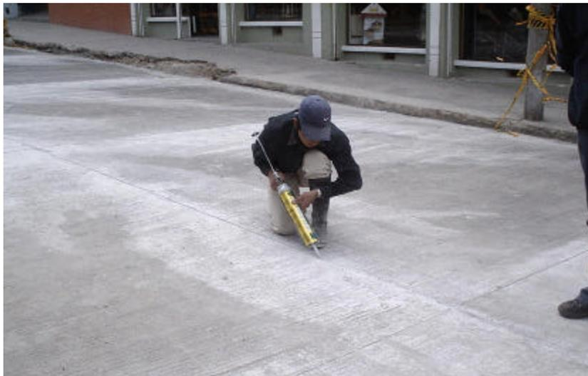
Figura 18. Sellado juntas de dilatación (2)
