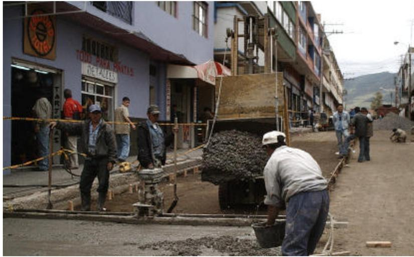
Figura 14. Fundición placa de concreto (2)
