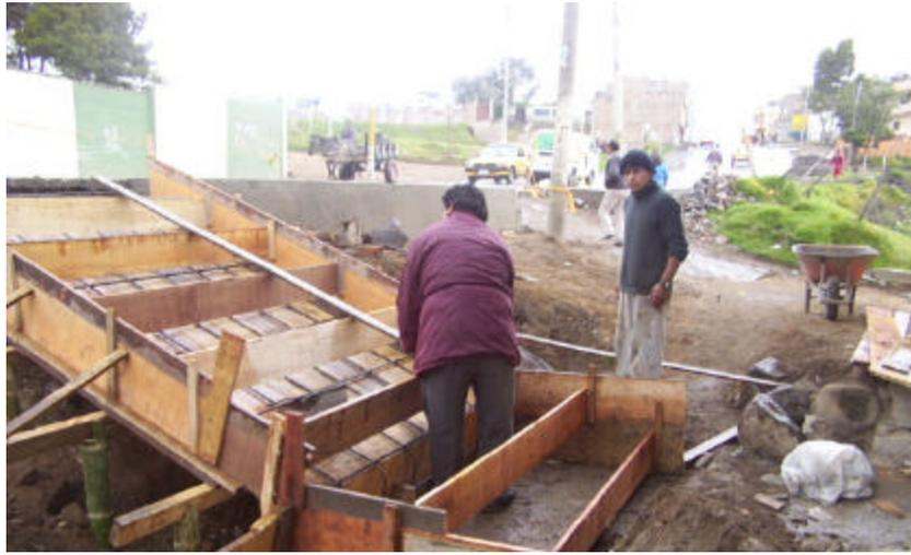
Figura 161. Armado de gradas sector C.C.P (2)
