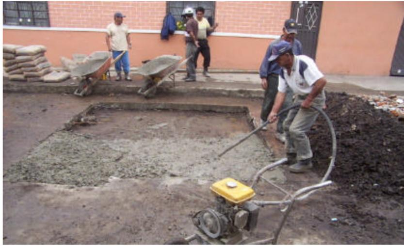
Figura 107. Vibrado de concreto (2)
