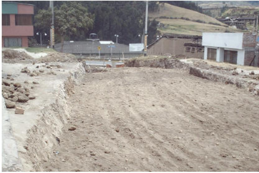
Figura 68. Conformación sub-base (2)
