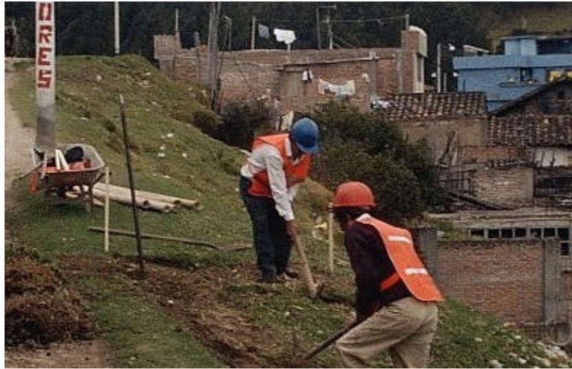
Figura 50. Excavación muro de contención (2)
