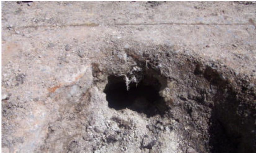
Figura 87. Socavación (2)
