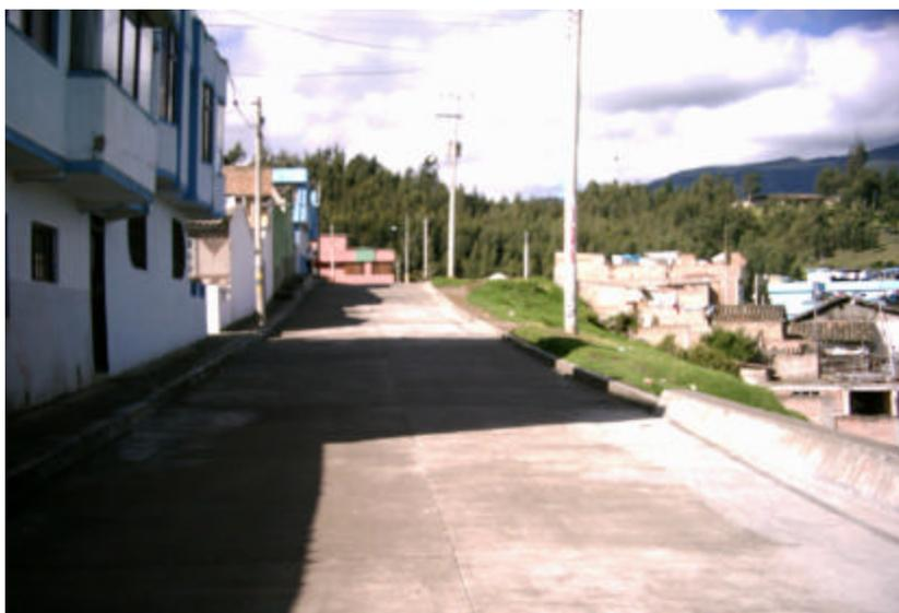
**OBRA: PAVIMENTACIÓN EN CONCRETO RIGIDO DE LA CARRERA 3B
