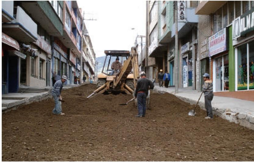
Figura 3. Conformación base (2)
