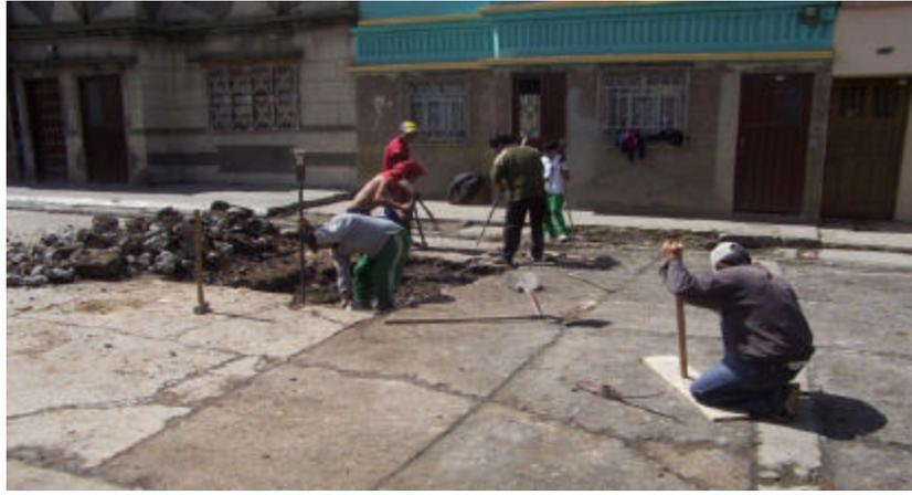
Figura 85. Demolición placa de concreto (2)
