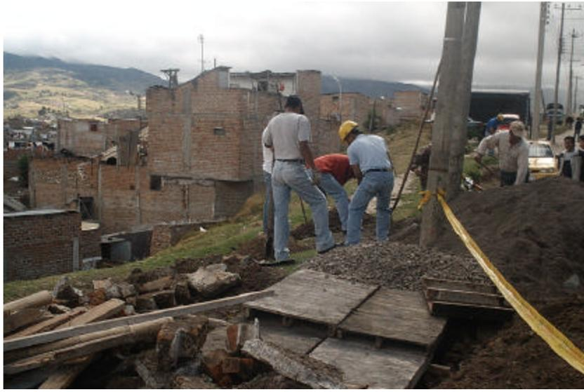
Figura 59. Excavación cambio de postes de energía (2)
