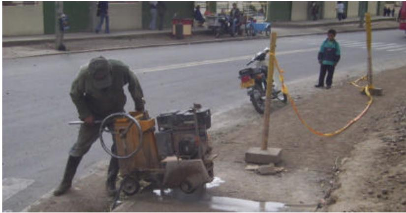
Figura 147. Corte juntas de dilatación (2)
