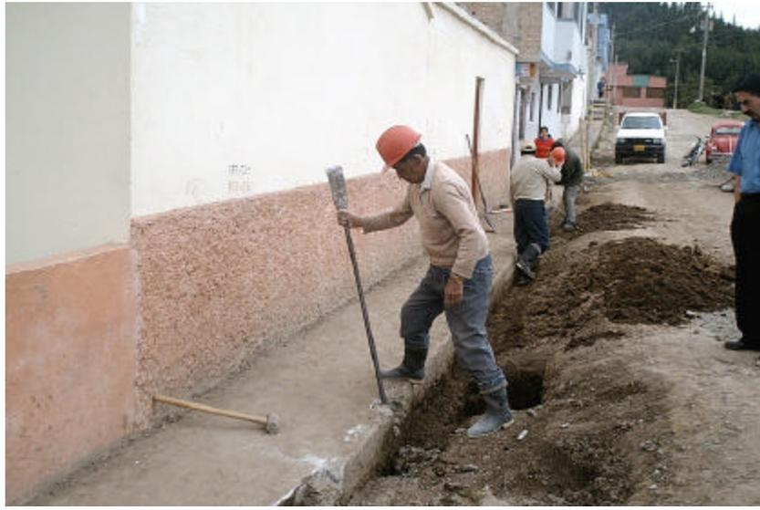
Figura 57. Demolición andenes (2)
