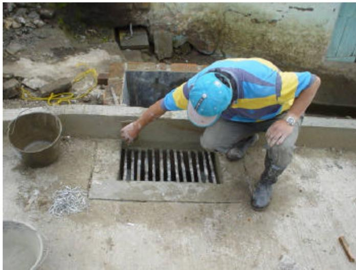
**Figura 58. Terminado de las cámaras de inspección.**
