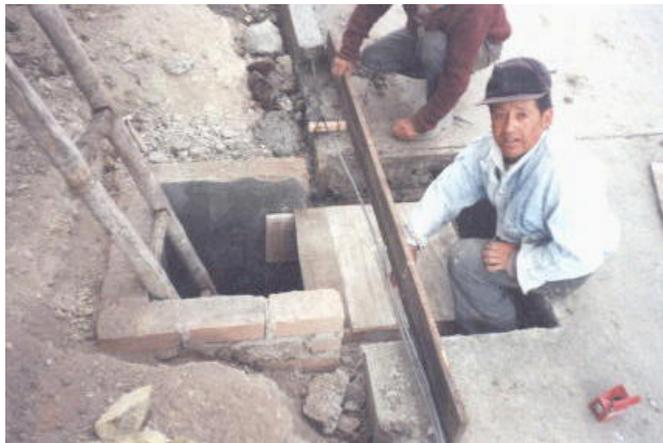
**Figura 28. Terminado de las cámaras de inspección**
