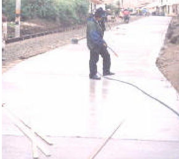
· **Construcción de juntas.** La construcción de las juntas se lleva a cabo estando el concreto fresco, las juntas transversales son elaboradas por medio de la colocación de platinas de acero de 6 a 8 mm de espesor y con un ancho aproximado de  $\frac{1}{3}$  del espesor de la losa, estas se aseguran por medio de estacas para evitar su flexión, las platinas se untan de aceite para facilitar su retiro evitando se fracturen los bordes de la junta.
