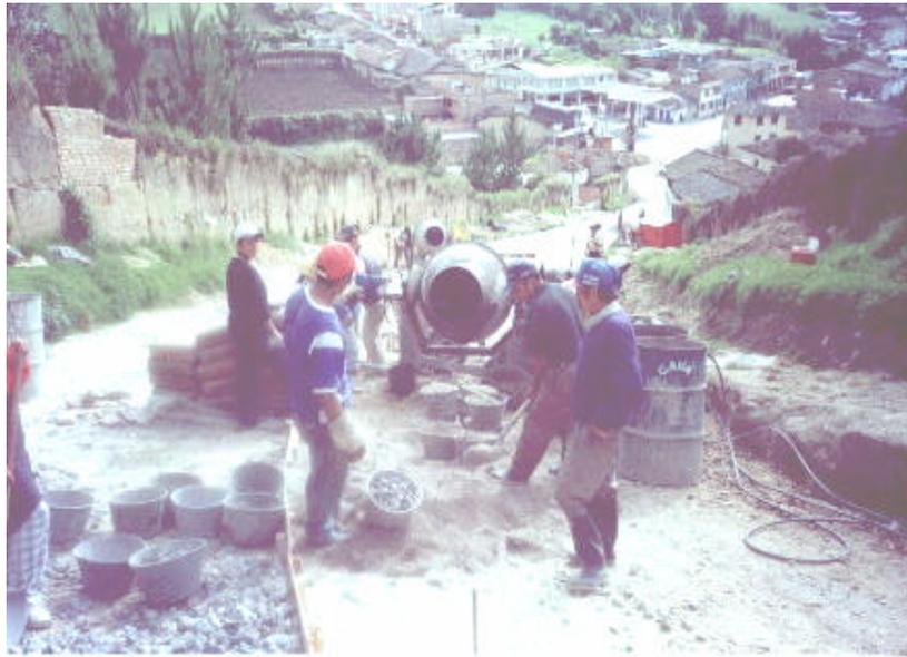
**Figura 98. Colocación y extensión del concreto**
