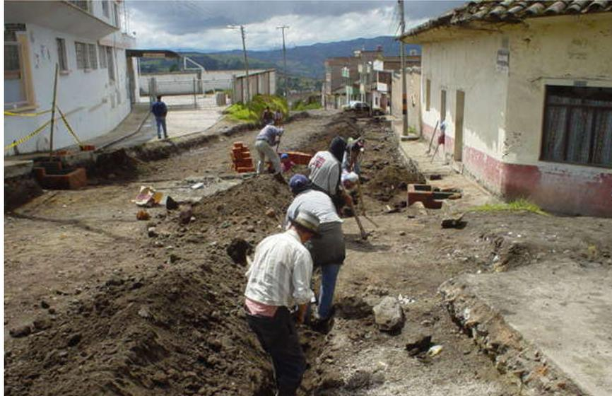
**7.2.4 Obras de drenaje.** Para la evacuación de las aguas lluvias que corre por la superficie del pavimento, cunetas y bordillos se construyeron cuatro sumideros con capacidad y condiciones adecuadas para un buen funcionamiento, los cuales reciben el agua y la entregan a un conducto que la lleva a la red de alcantarillado. Como obra adicional al proyecto se construyó una cámara de inspección para la conexión de los conductos de los sumideros.
