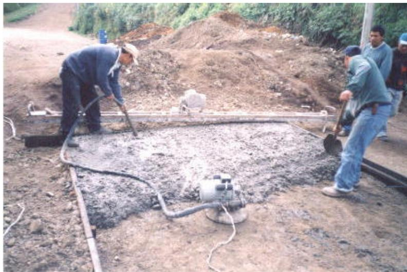
**Figura 48. Vibración externa.**
