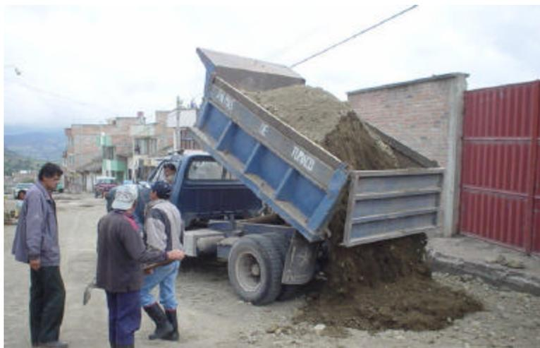
**Figura 129. Extendido y aireación del material de base**
