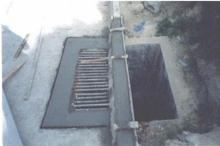
**Figura 108. Terminado de las cámaras de inspección**
