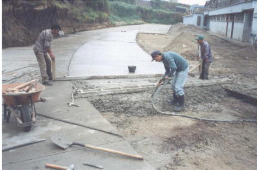
**Figura 76. Vibración externa.**
