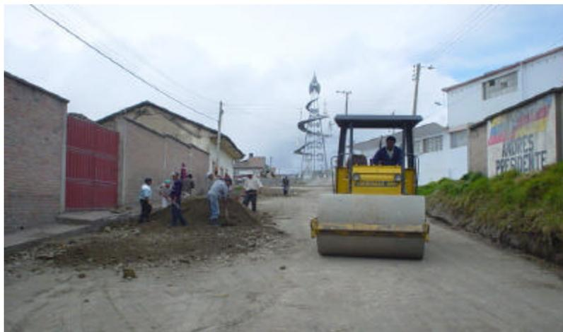
**7.3.3 Control de la obra.** Después de compactada la base, se chequearon niveles, se realizaron los ensayos de densidad in situ con el aparato del cono y arena, y la toma de humedad en la obra, entre otras actividades.
