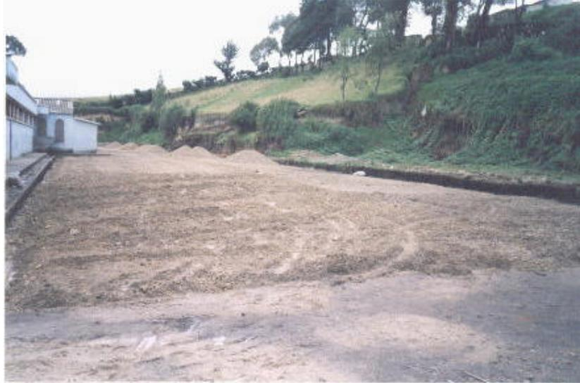
**Figura 64. Levantamiento y secado de material saturado.**
