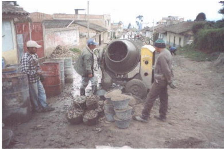
**Figura 46. Colocación del concreto.**
