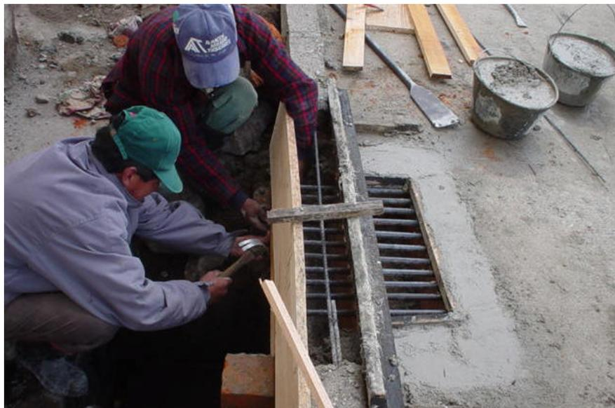
**Figura 156. Terminado de las cámaras de inspección**
