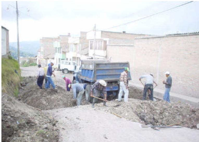
**7.2.3 Excavación y cambio de tubería.** La excavación y cambio de tubería de la red de acueducto se realizó por medio de mano de obra no calificada y herramienta menor.
