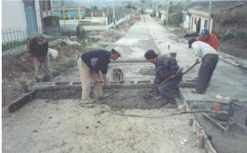
**Figura 18. Vibración externa.**
