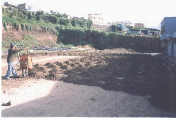
**Figura 62. Extendido y aireación del material de base.**
