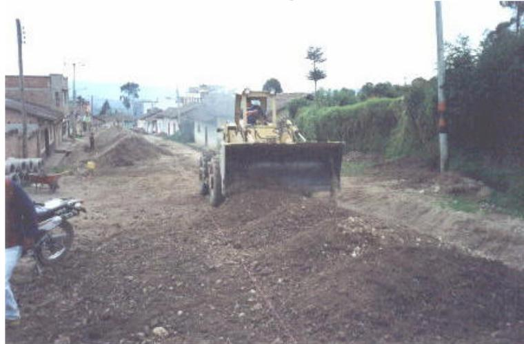
**Figura 37. Extendido y aireación del material de base.**
