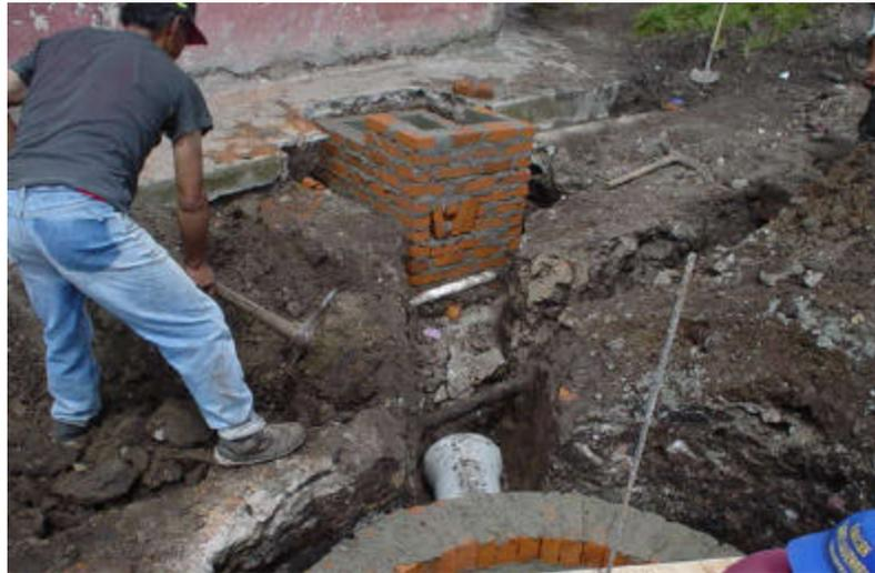
**Figura 118. Construcción cámara de inspección**
