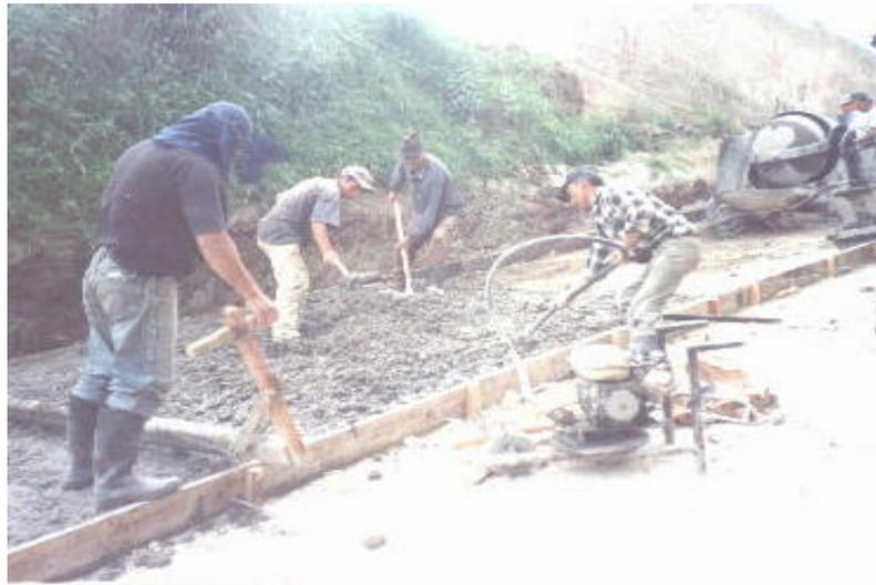
**Figura 100. Vibración externa**
