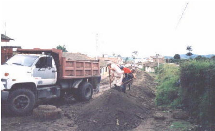
**4.1.1 Obras de Drenaje.** Para la evacuación de las aguas lluvias que corre por la superficie del pavimento y por las cunetas o bordillos se construyeron sumideros con capacidad y condiciones adecuadas para un buen funcionamiento, los cuales reciben el agua y la entregan a un conducto que la lleva a la red de alcantarillado.
