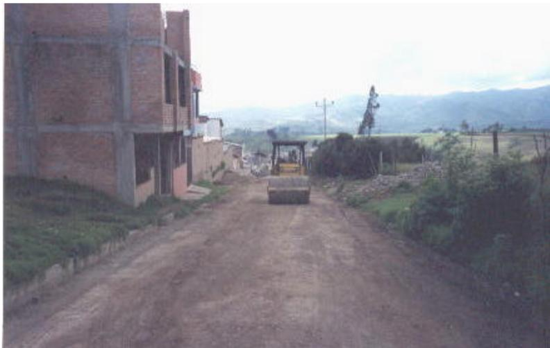
La conformación de la subrasante tuvo lugar mediante la utilización de mano de obra no calificada.
