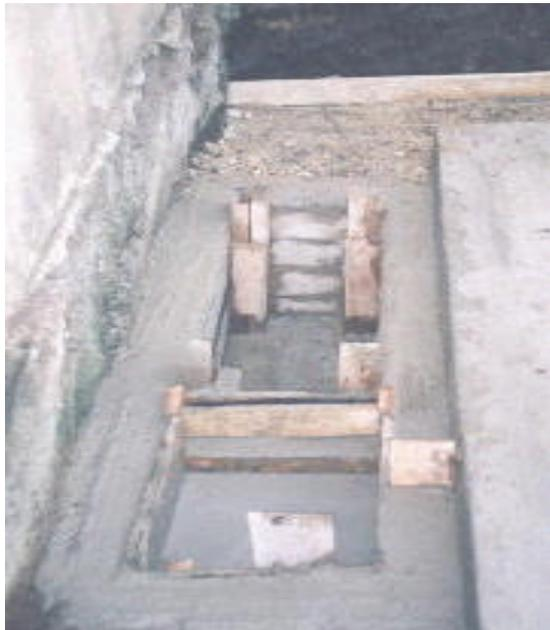
**Figura 86. Construcción cunetas.**
