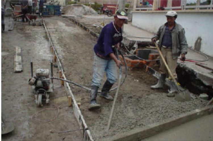
**Figura 145. Vibración externa**
