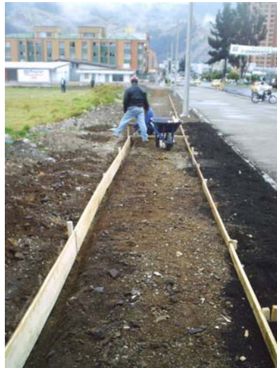
Figura 47. Instalación formaleta anden.
