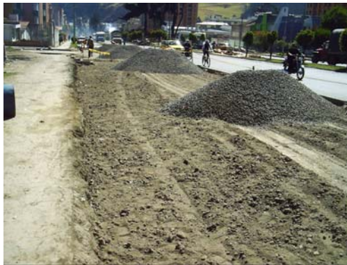
Figura 42. Mejoramiento material de sub-base con grava.
