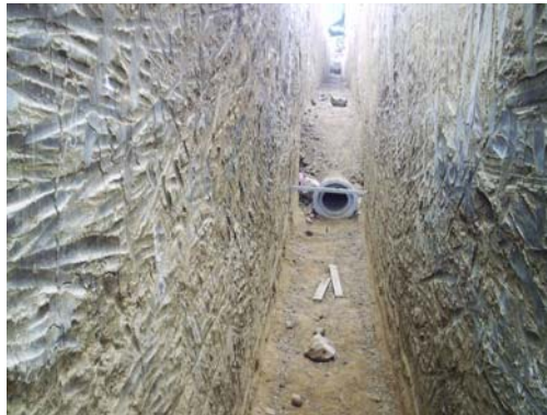
Figura 11. Instalación tubería 10".
