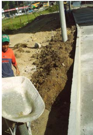
Figura 24. Relleno con material del sitio.
