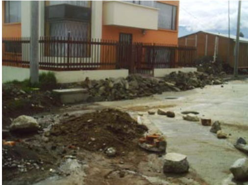
Figura 27. Material sobrante para desalojar.
