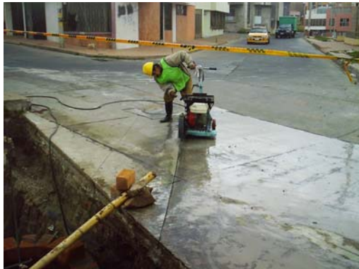
Figura 6. Corte en concreto rígido.
