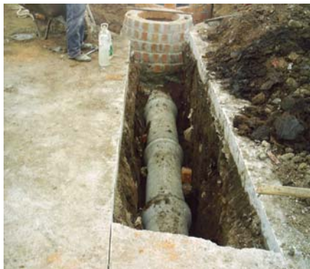
Figura 12. Instalación tubería de 16”.
