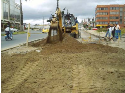
Figura 43. Mezcla material sub-base.
