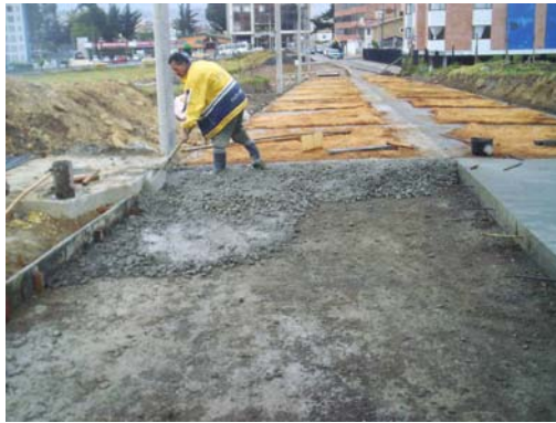
Figura 20. Construcción placa en concreto rígido.
