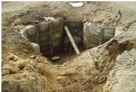
Figura 15. Realce cámara teléfono.
