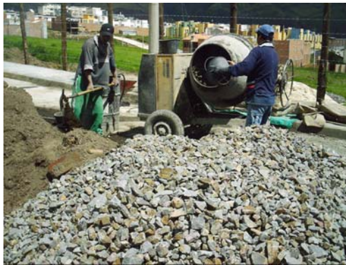
Figura 28. Mezcla concreto.
