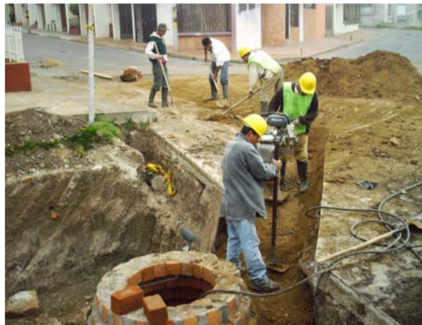
Figura 8. Relleno con material seleccionado compactación con saltarín.
