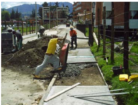
Figura 30. Conformación placa anden.
