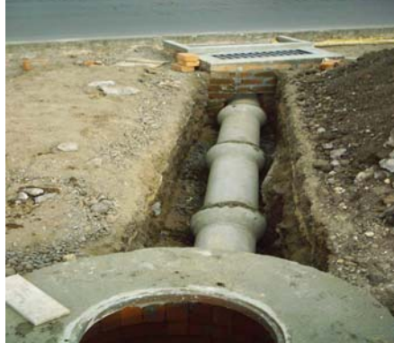
Figura 40. Conexión sumidero.
