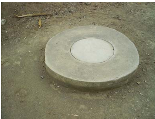
Figura 37. Realce cámara alcantarillado.
