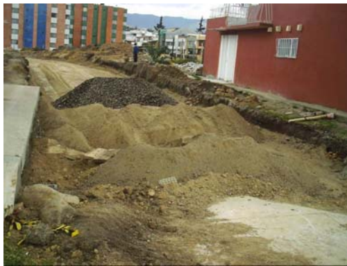
Figura 16. Acordonamiento material sub – base.
