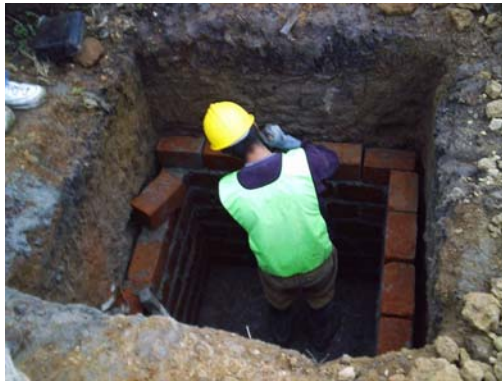
Figura 14. Construcción sumidero.
