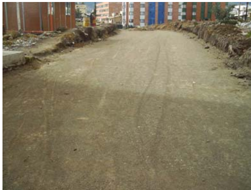
Figura 19. Sub-base granular compacta.
