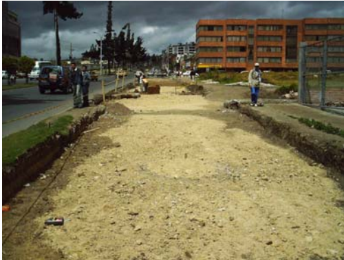
Figura 36. Relleno material seleccionado.
