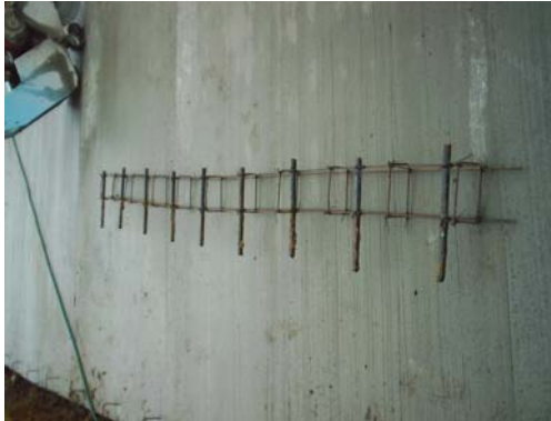
Figura 21. Juntas transversales.
