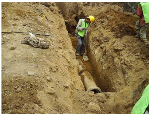
Figura 7. Relleno con material seleccionado compactado manualmente.
