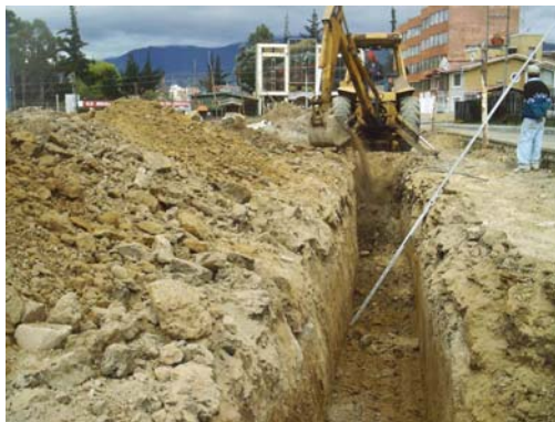
Figura 5. Excavación a máquina.
