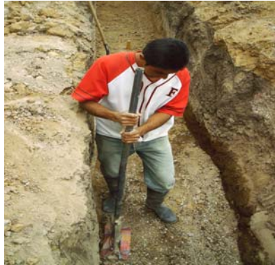
Figura 9. Relleno con material del sitio compactación manual.
