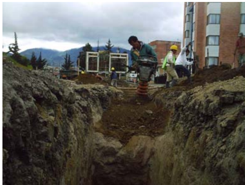
Figura 10. Relleno con material del sitio compactación con saltarín.
