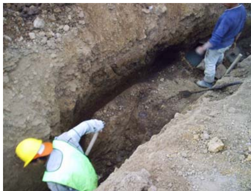
Figura 4. Excavación a mano.
