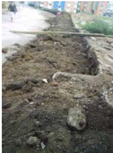
Figura 26. Viga para demolición.
