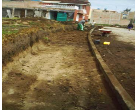
Figura 25. Excavación a mano.
