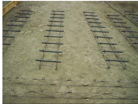
Figura 45. Camilla prefabricada para refuerzo transversal.
