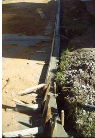
Figura 23. Sardineles integrados a placa.
