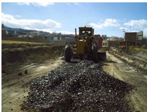
Figura 17. Mezcla material de sub-base.
