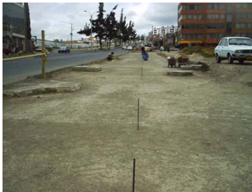
Figura 44. Sub-base granular compacta.
