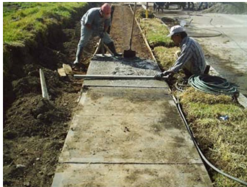
Figura 49. Conformación placa andén.
