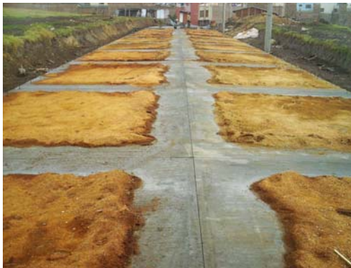
Figura 22. Curado concreto.
