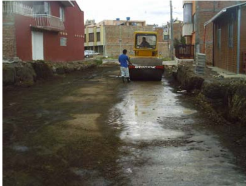
Figura 18. Compactación sub-base.
