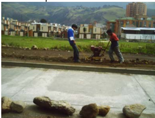
Figura 29. Compactación material base anden.
