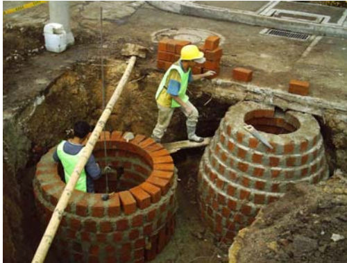
Figura 13. Construcción cámara de alcantarillado.
