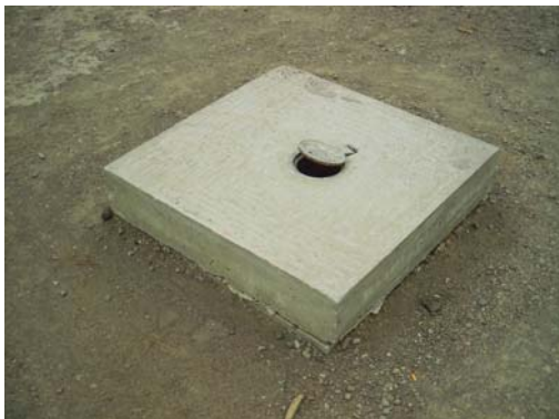
Figura 38. Realce caja Válvula.
