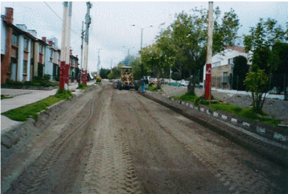
Figura 42. Nivelación y perfilado transversal de la vía. Etapa 2.
