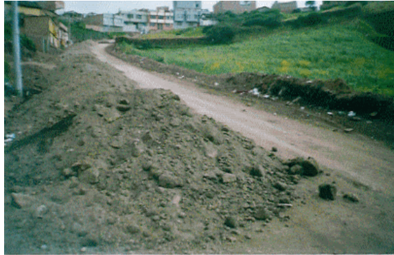
Figura 29. Acopio de Material.
