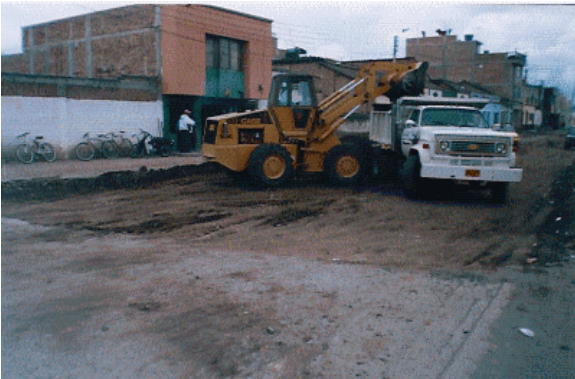
Figura 53. Demolición parcial de cámara de inspección de alcantarillado.
