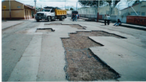
Figura 62. Riego de liga. Carrera 7 entre calles 24 y 24B.
