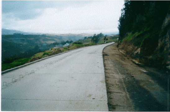
Figura 13. Concreto hidráulico whitetopping. Abscisa K 2 + 250.00.
