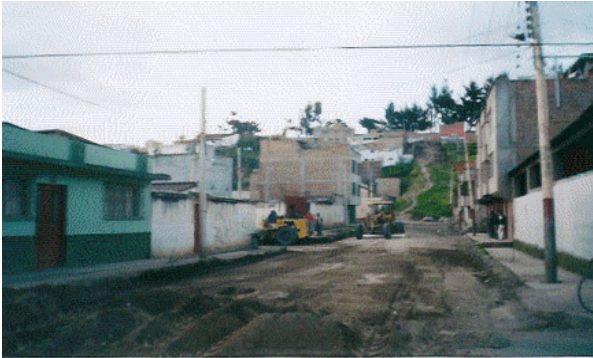
Figura 15. Perfilado y compactación de base granular. Calle 10.
