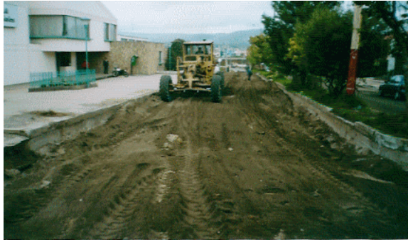
Figura 45. Perfilado final de la capa de base granular. Etapa 3.
