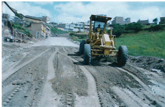
Figura 31. Riego y extensión de material para base. Abscisa K0 + 230.00.
