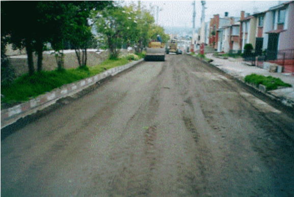
Figura 43. Compactación de base granular. Etapa 2.
