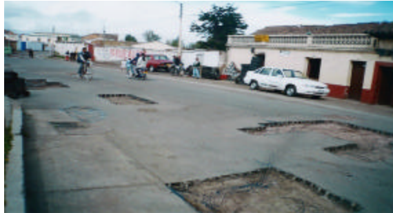
Figura 66. Riego de liga. Carrera 7 entre calles 23 y 24.
