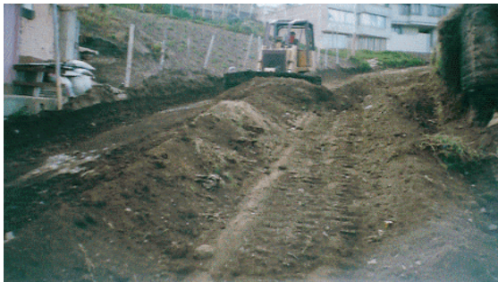
Figura 24. Desmonte y limpieza.
