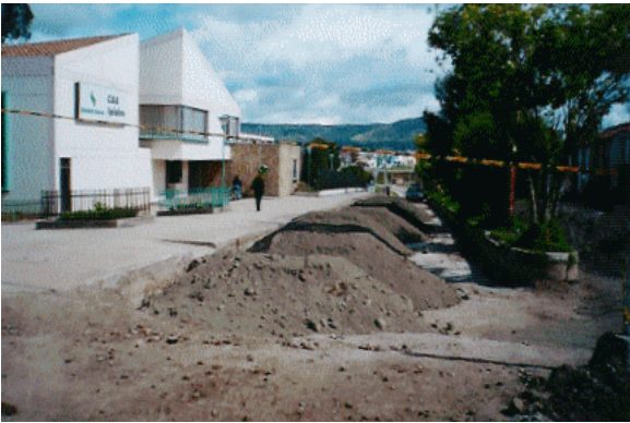
Figura 45. Acopio de material. Etapa 3.
