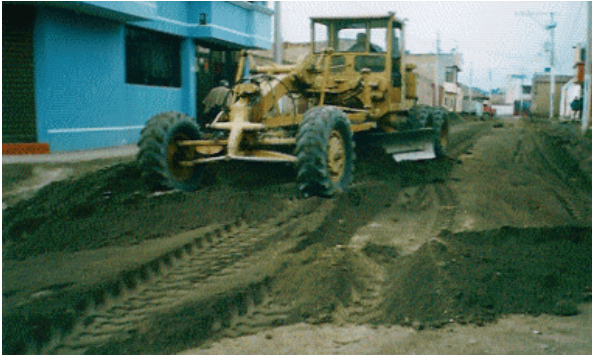
Figura 20. Extensión de material granular. Carrera 2A.
