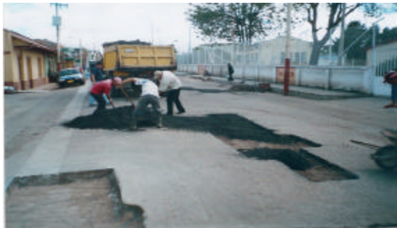
Figura 63. Colocación del concreto asfáltico. Cra. 7 entre calles 24 y 24B.
