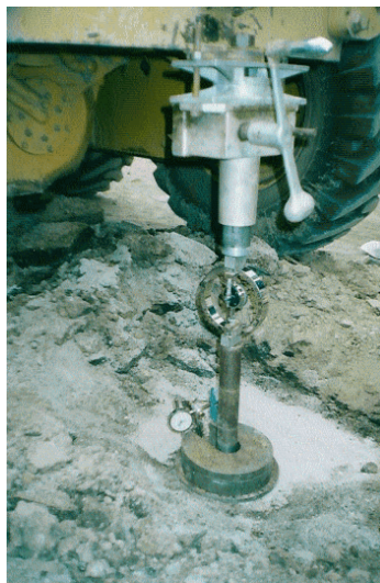
Figura 4. Ensayo de capacidad de soporte de subrasante C.B.R.
