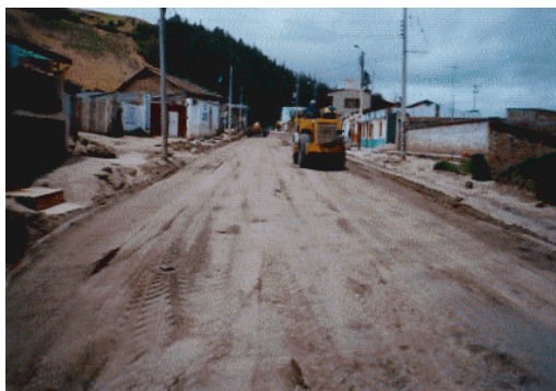
Figura 10. Compactación del material granular.
