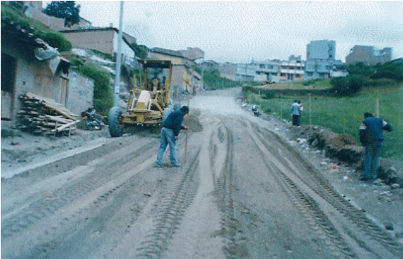
Figura 32. Nivelación y perfilado del material para base.
