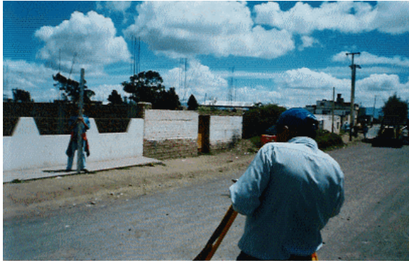
Figura 49. Nivelación del eje vial y sección transversal.
