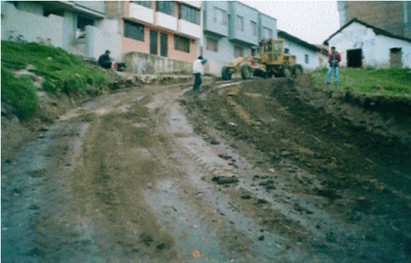
Figura 25. Nivelación y perfilado de la subrasante.
