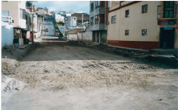
Figura 18. Perfilado final de base granular. Calle 10
