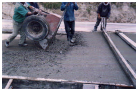
Figura 11. Colocación del concreto.
