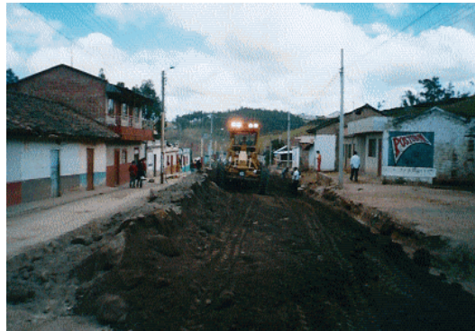
Figura 8. Mezcla de material granular.
