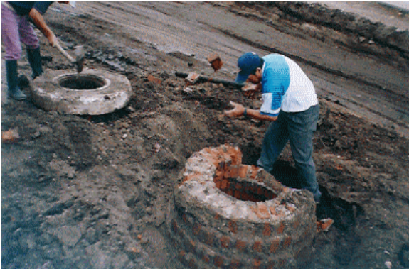
Figura 53. Demolición parcial de cámara de inspección de alcantarillado.
