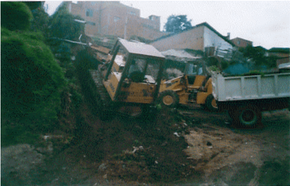
Figura 25. Nivelación y perfilado de la subrasante.
