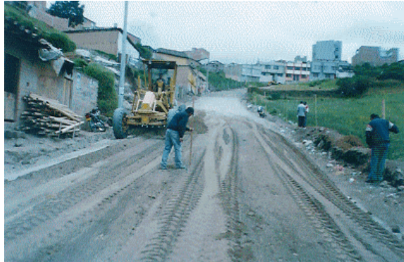
Figura 31. Riego y extensión de material para base. Abscisa K0 + 230.00.
