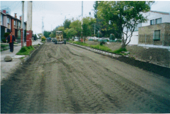
Figura 42. Nivelación y perfilado transversal de la vía. Etapa 2.
