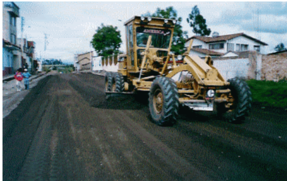
Figura 56. Riego y extensión de material granular.
