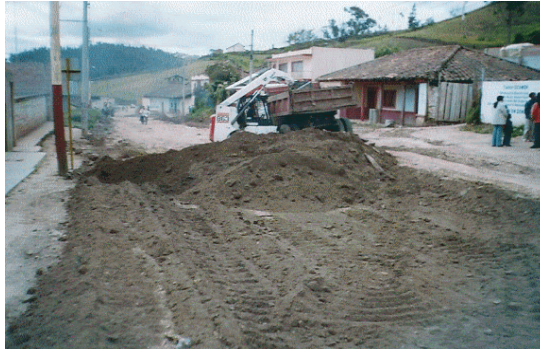
Figura 1. Excavación y retiro de material.
