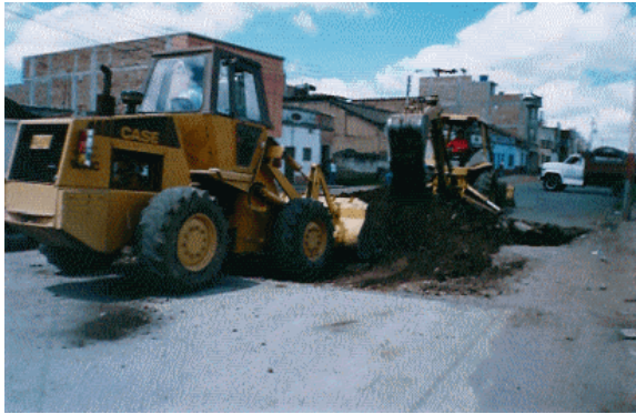
Figura 50. Excavaciones y cortes. Abscisa K 0 + 0.00
