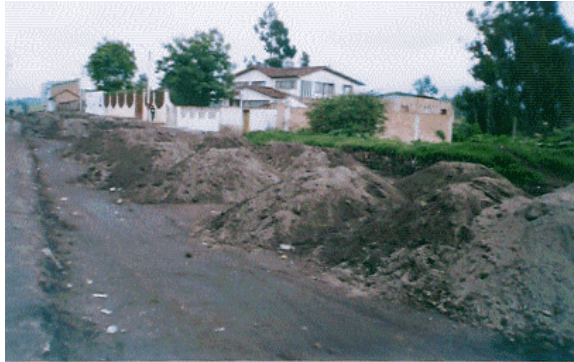
Figura 55. Acopio de material granular para conformación de base.
