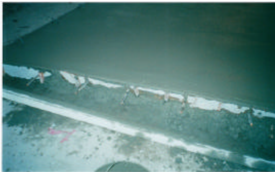
Figura 36. Colocación de acero de transferencia de carga.
