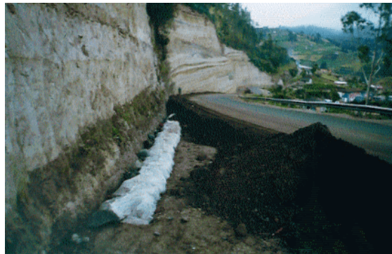
Figura 14. Subdrenaje: construcción de filtros.
