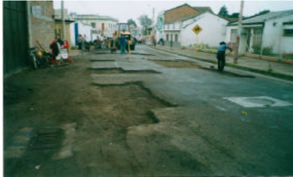
Figura 65. Cajeo. Carrera 7 entre calles 23 y 24.
