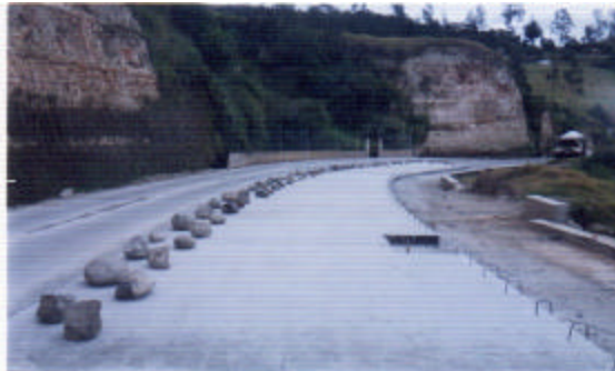
Figura 14. Concreto hidráulico whitetopping. Abscisa K 6 + 220.00
