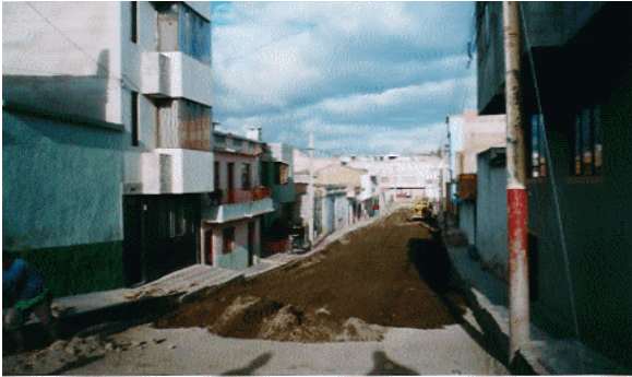
Figura 21. Mezcla de material granular. Carrera 2A.
