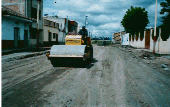
Figura 58. Compactación de la base granular.
