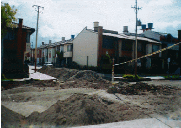
Figura 35. Acopio de material. Etapa 1
