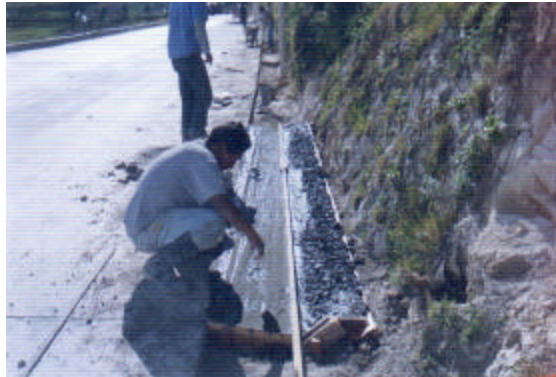
Figura 15. Drenaje longitudinal: construcción de cunetas.
