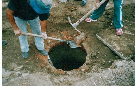
Figura 4. Demolición parcial de cámara de inspección de alcantarillado
