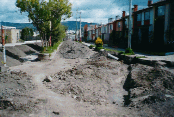
Figura 40. Acopio de material. Etapa 2.
