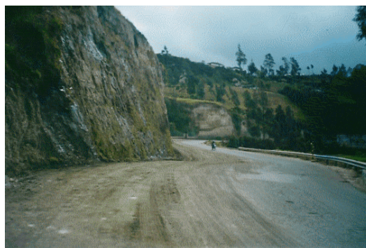
Figura 3. Corte de talud K 5+ 311.00 a K6 + 221.00
