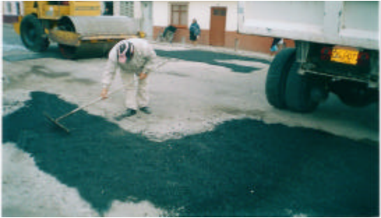
Figura 72. Nivelación y compactación. Barrio Centenario.
