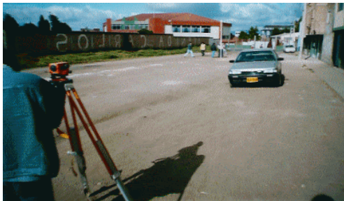
Figura 60. Nivelación del eje vial y sección transversal.
