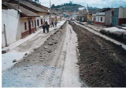
Figura 7. Extensión de material granular.
