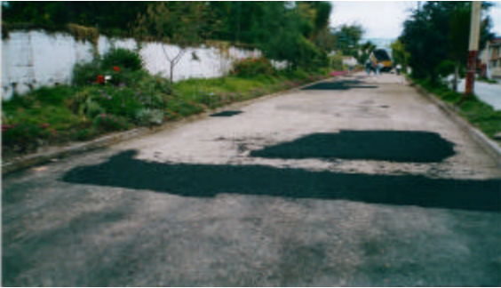
Figura 69. Colocación de concreto asfáltico. Calle 24 entre carreras 8 y 9 calzada oriental Urbanización La Castellana.
