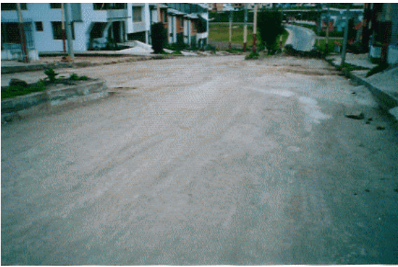
Figura 44. Perfilado final. Etapa 2.
