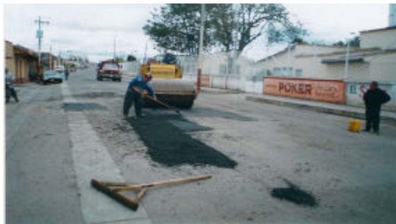
Figura 64. Nivelación y compactación. Cra. 7 entre calles 24 y 24B.
