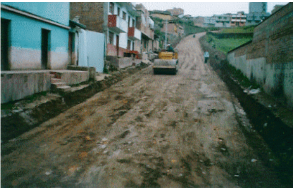
Figura 28. Compactación de la subrasante.
