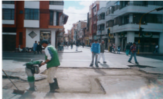
Figura 74. Colocación y compactación de capa de material granular para base. Cra 6. entre calles 8 y 9.
