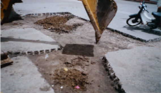
Figura 73. Cajeo y retiro de material indeseable. Cra 6. entre calles 8 y 9.
