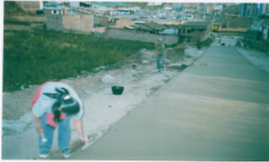
Figura 36. Colocación de acero de transferencia de carga.
