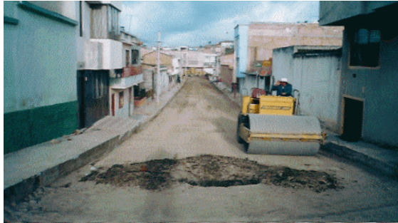
Figura 23. Compactación de base granular. Carrera 2A.
