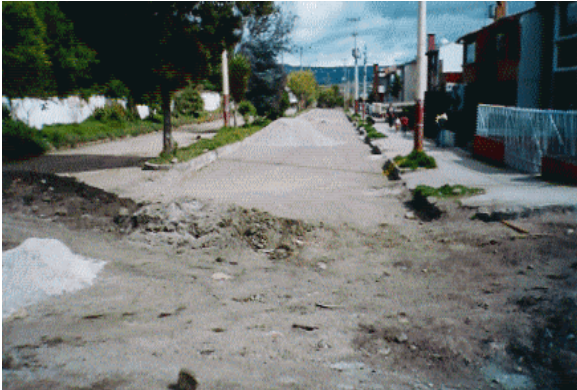
Figura 39. Perfilado final. Etapa 1.
