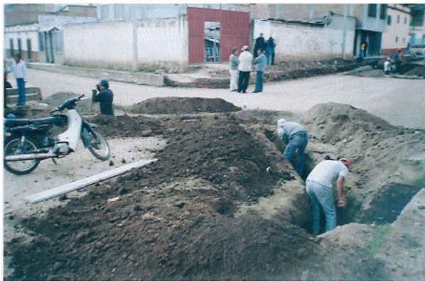
Figura 19. Excavación de zanjas para sumideros. Calle 10.
