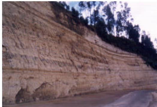
Figura 2. Corte de Talud K5 + 271.00 a K5 + 141.00.
