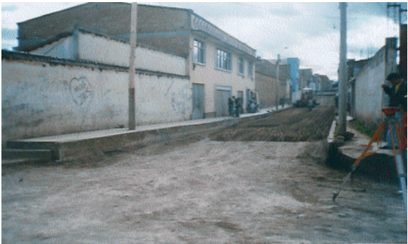
Figura 22. Nivelación transversal y perfilado. Carrera 2A.
