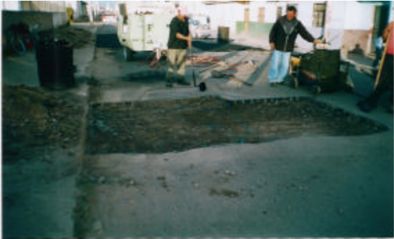
Figura 71. Riego de liga. Barrio Centenario.
