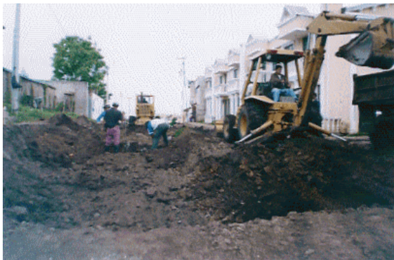
Figura 51. Excavaciones y cortes. Abscisa K 0 + 125.00
