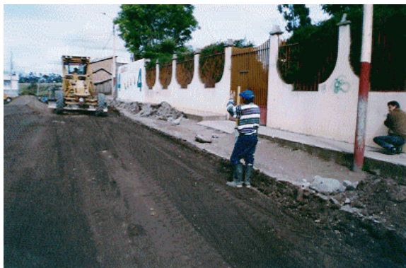
Figura 55. Nivelación y perfilado transversal de la vía.
