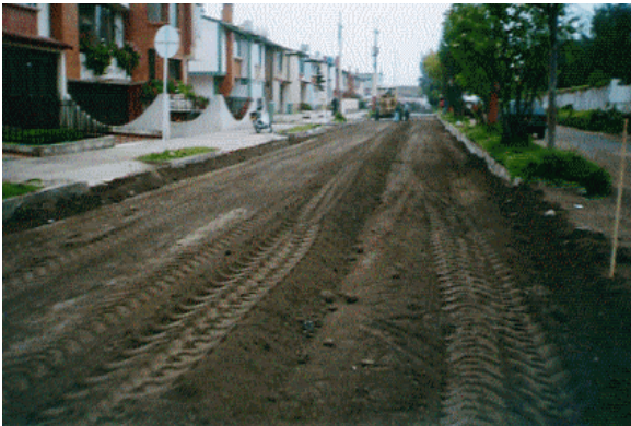
Figura 39. Perfilado final. Etapa 1.
