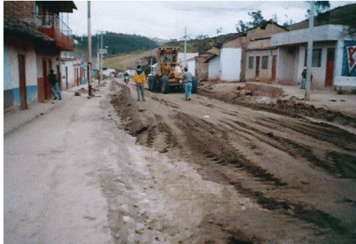
Figura 9. Conformación del material.
