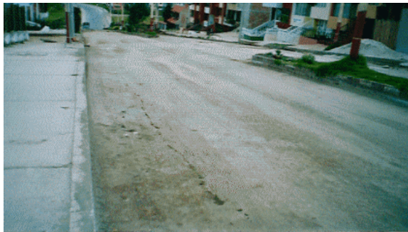
Figura 45. Perfilado final de la capa de base granular. Etapa 3.
