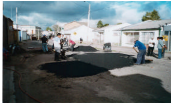
Figura 65. Nivelación del concreto asfáltico. Cra. 7 entre calles 23 y 24.
