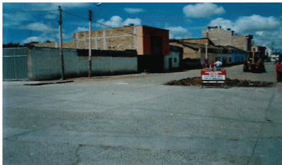
Figura 48. Estado inicial de la vía.
