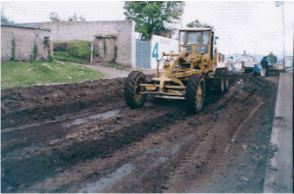
Figura 54. Nivelación y perfilado transversal de la subrasante.
